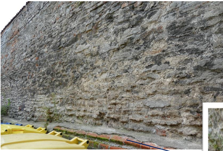
8. Wtórnie wykonana odsadzka z cegieł.
