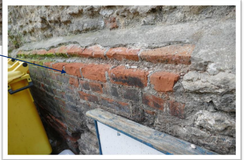
8. Wtórnie wykonana odsadzka z cegieł.
