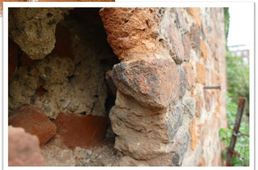
15. Wnętrze oryginalnego otworu maculcowego – południowa część wschodniej elewacji dłuższego muru.
