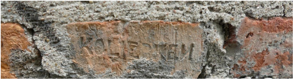
12 i 13. Różne rodzaje cegieł wtórnie wmurowanych.
