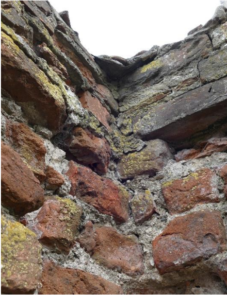
9. Historycznie przemurowane naroże wewnątrz skrzydeł muru.
