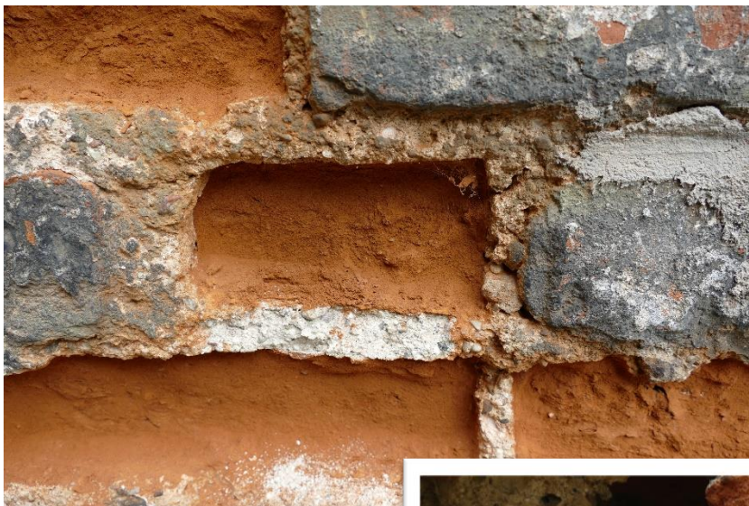
14. Zniszczenia oryginalnych cegieł z pozostawieniem historycznych spoin.
