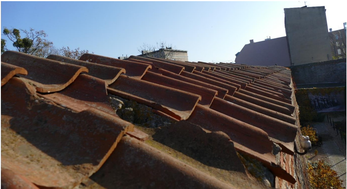
19 i 20. Zniszczona, współczesna nakrywa muru wpływająca na destrukcję korony muru.
