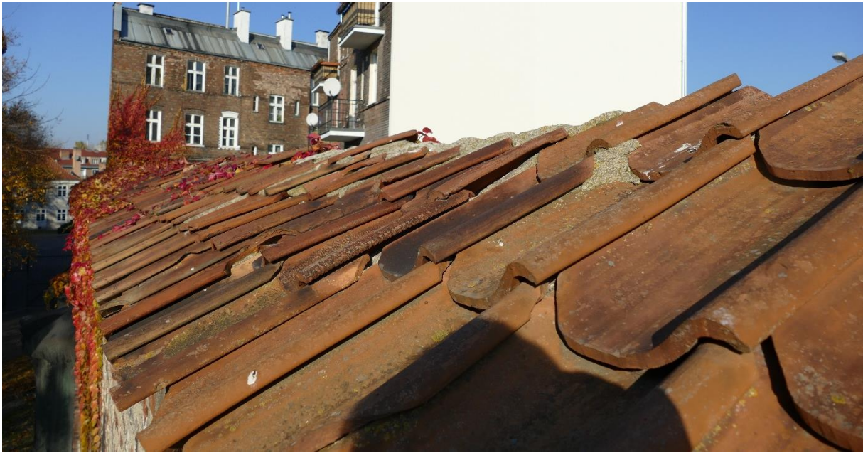
19 i 20. Zniszczona, współczesna nakrywa muru wpływająca na destrukcję korony muru.
