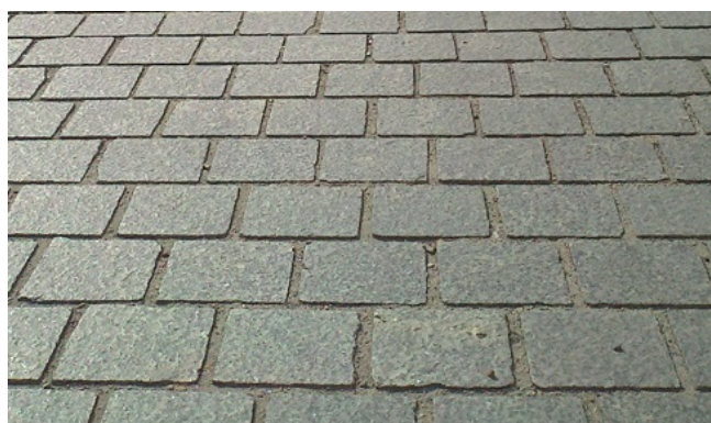
Fot. nr 7. Nawierzchnia z kostki kamiennej cięto-łupanej(łomieniowana) 9/11 cm
