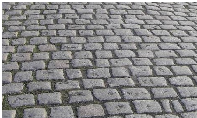
Fot. nr 4. Istniejąca kostka kamienna rzędowa typu starobruk 14÷16cm
