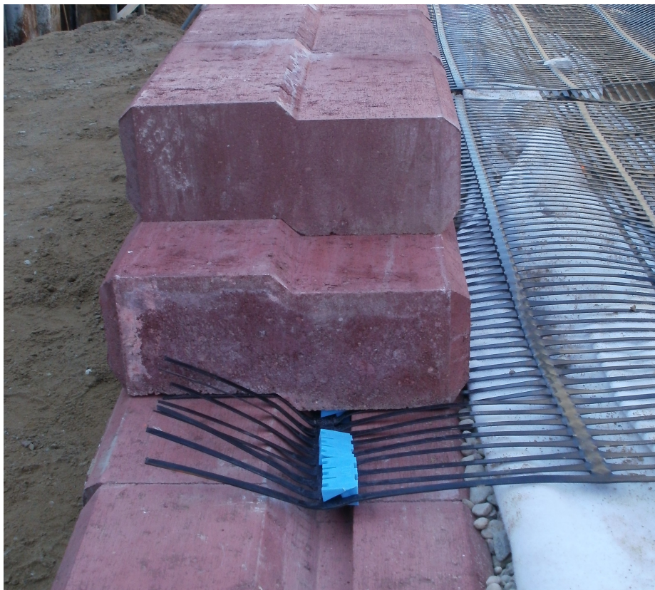
Rysunek 3 Mocowanie georusztu i łącznika typu connector
