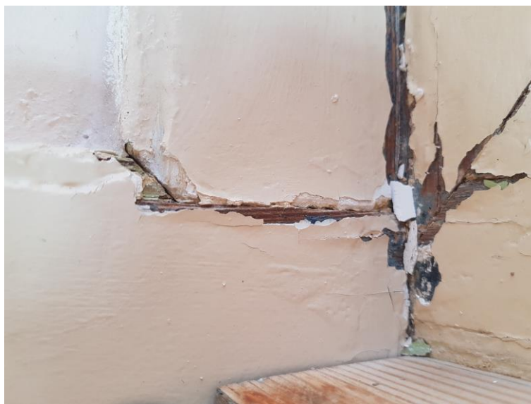
Fot. 27. Spękania na styku elementów konstrukcji (fot. Anna Zaręba).
