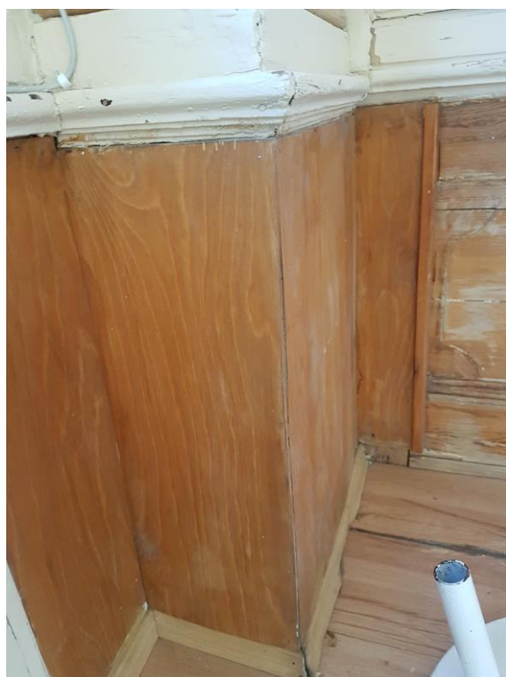
Fot. 19, 20. Sklejka zastępująca deskowanie drewniane, gwoździe i śrubki w strukturze drewna (fot. Anna Zaręba).
