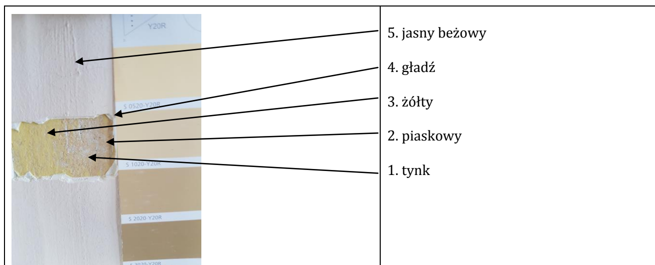
Odkrywka nr 7. Aula, ściana przy drzwiach, tynki.
