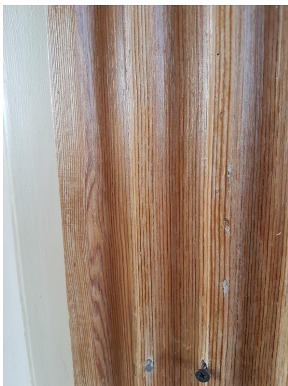
Fot. 19, 20. Sklejka zastępująca deskowanie drewniane, gwoździe i śrubki w strukturze drewna (fot. Anna Zaręba).
