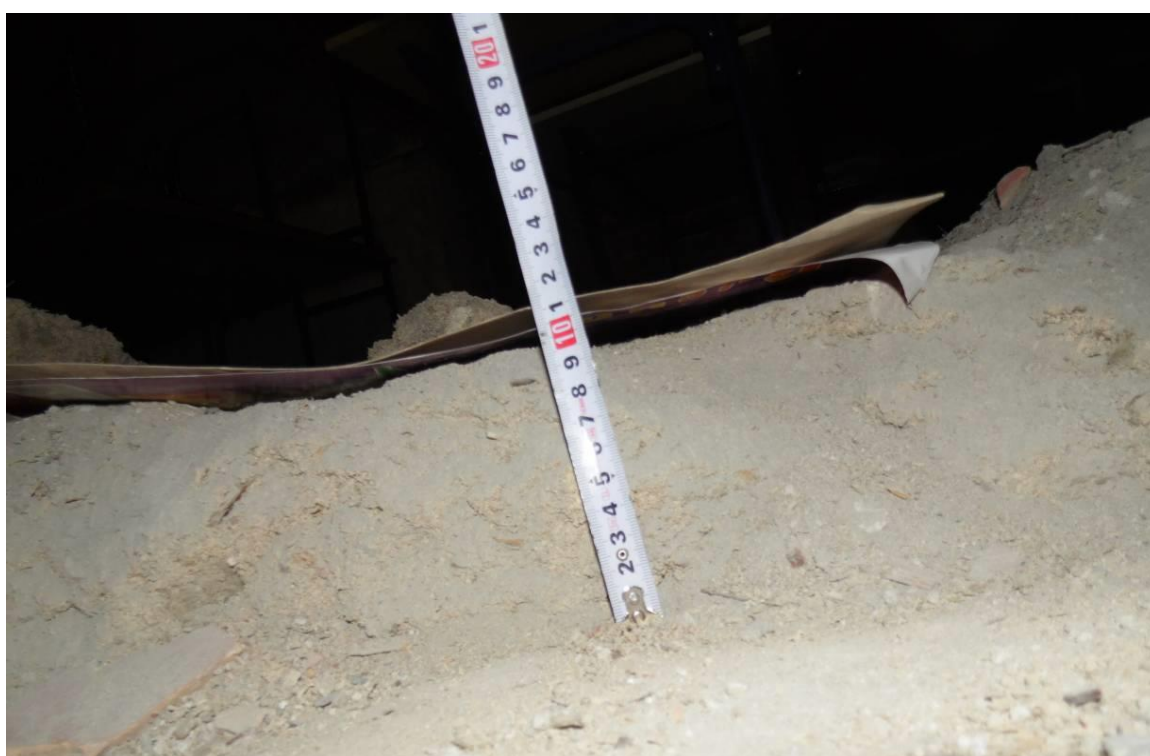
Widoczna polepa wraz z fragmentami wylewki.
