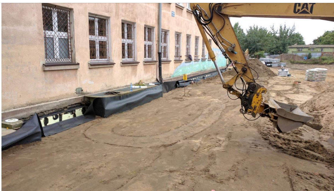
Widoczne izolacje poniżej poziomu terenu elewacji wschodniej.
