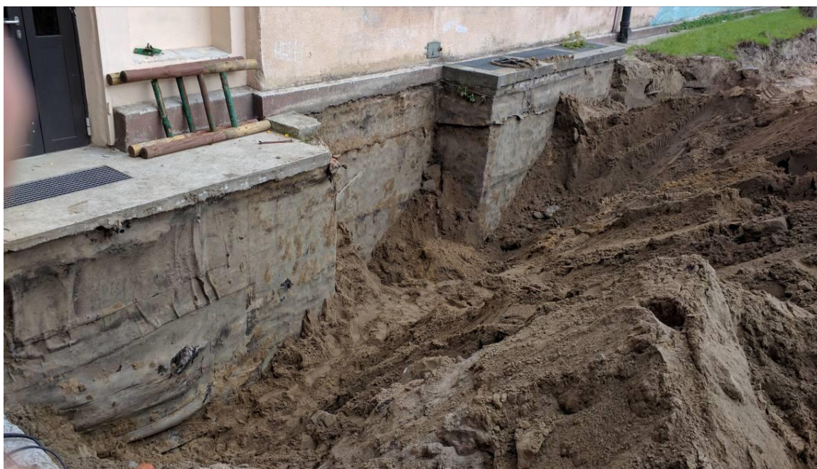
Widoczne odkrywki fundamentów przed przystąpieniem do wykonania izolacji poniżej poziomu terenu (elewacja wschodnia).
