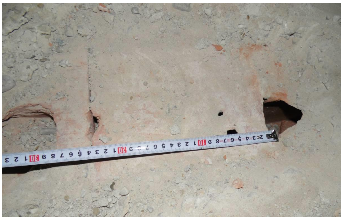
Widok na elementy ceramiczne stropu po usunięciu 6 cm wylewki na stropie poddasza.
