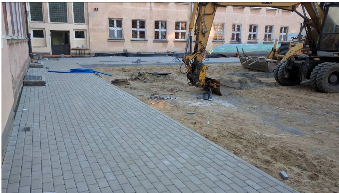
Widoczne izolacje poniżej poziomu terenu elewacji wschodniej wraz z wykończeniem kostką betonową chodnika biegnącego dookoła obiketu.
