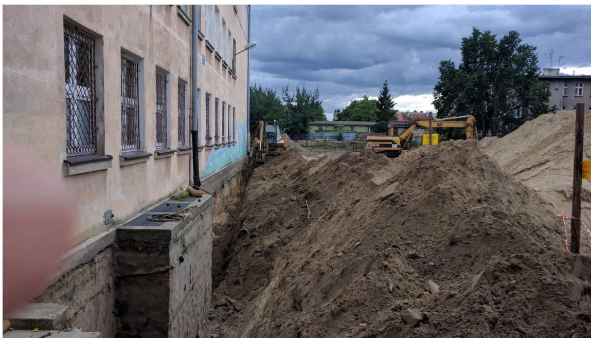
Widoczne odkrywki fundamentów przed przystąpieniem do wykonania izolacji poniżej poziomu terenu (elewacja wschodnia) – widok odkrytych studzienek piwnicznych.
