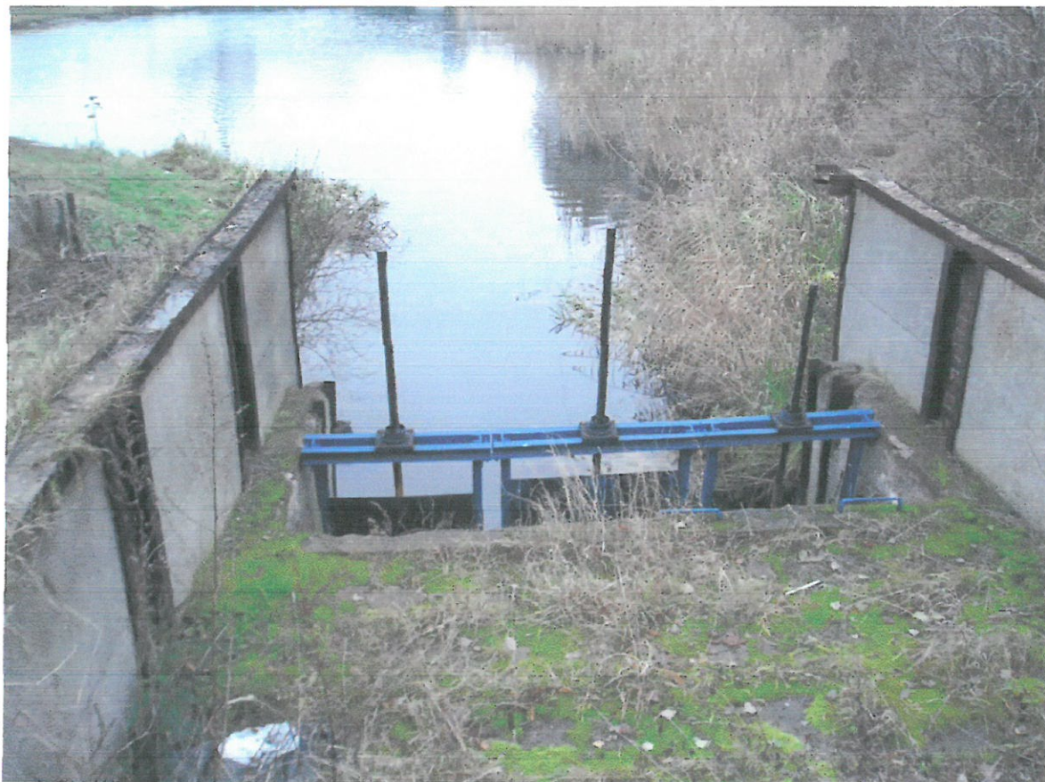
Zasuwy budowli wylotowej Kanału Rudnickiego
