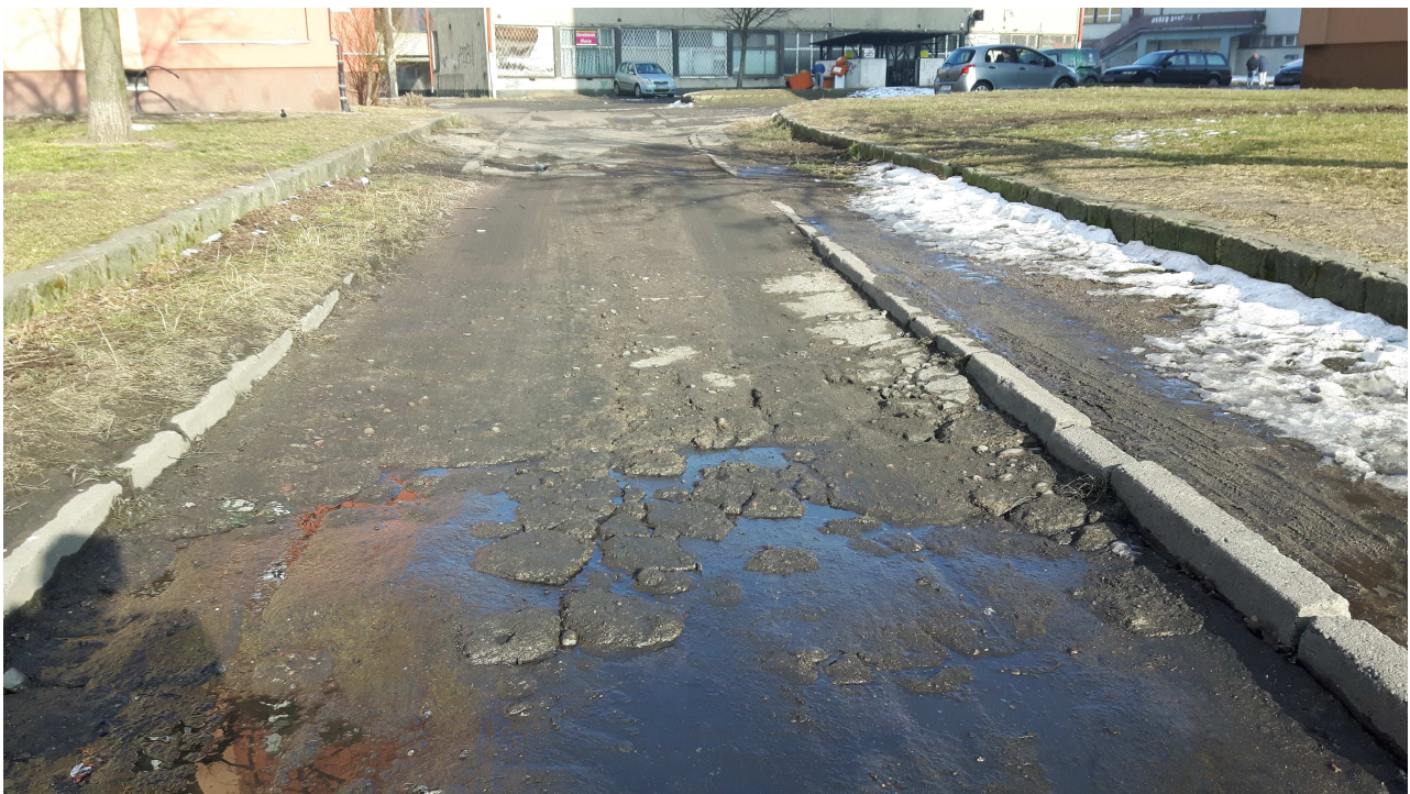
Fot. Nr 3. Widok na fatalny stan nawierzchni drogi wewnętrznej i otaczających ją krawężników.
