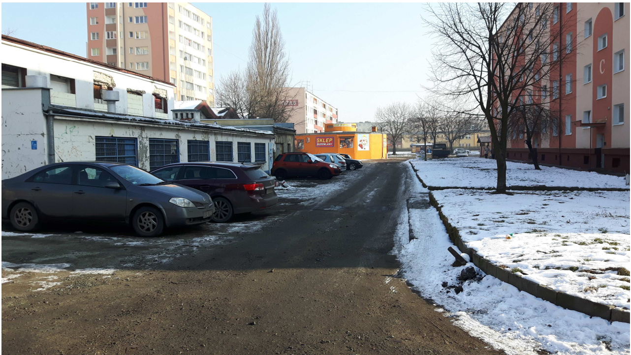
Fot. Nr 2. Widok wewnętrznej drogi dojazdowej szer. 3,0 m z opaską z płyt beton. (str. prawa)
