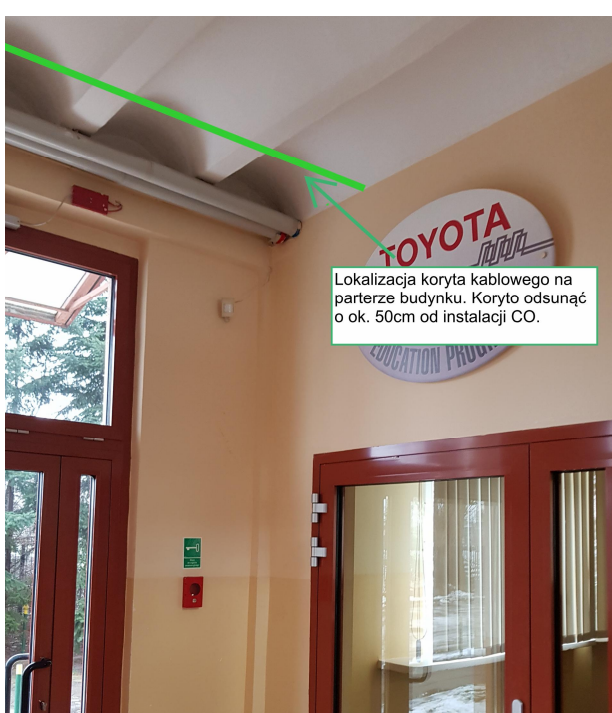
Fot.7 lok. koryta kablowego parter
