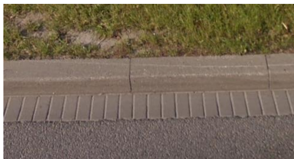
Fot. 8 Sposób ułożenia ścieku wzdłuż jezdni z kostki betonowej 20x10 cm
