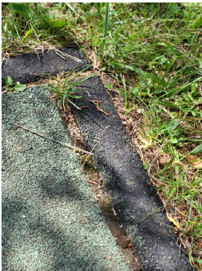
Fot. 19 Istniejąca nawierzchnia i obrzeże EPDM na placu zabaw.
