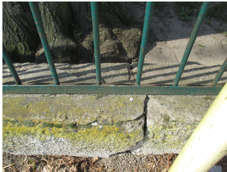
Fot. 10. Przęsło P2 – uszkodzenia podwaliny
