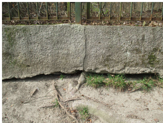
Fot.19. Korzenie drzew przerastające podwalinę
