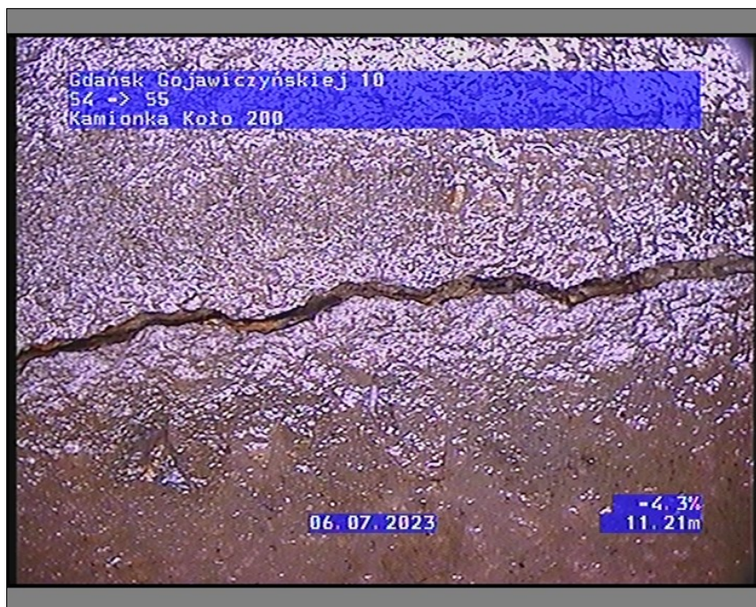
Zdjęcie: 4_6B 11,21m, Obwodowe pęknięcie ciany przewodu, od 8 do 4 godz.
