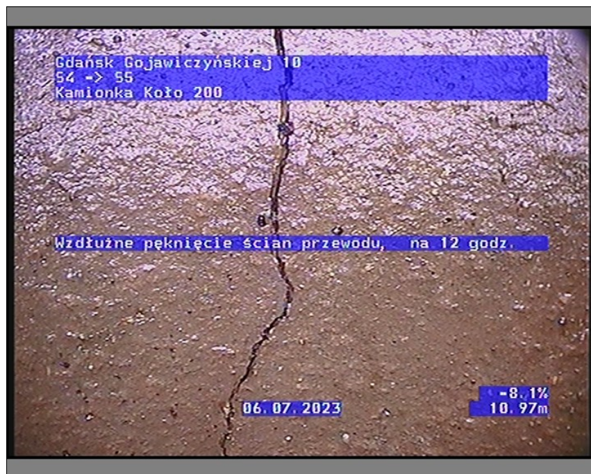
Zdjęcie: 4_5A 10,96m, Wzdłużne pęknięcie ścian przewodu, na 12 godz.
