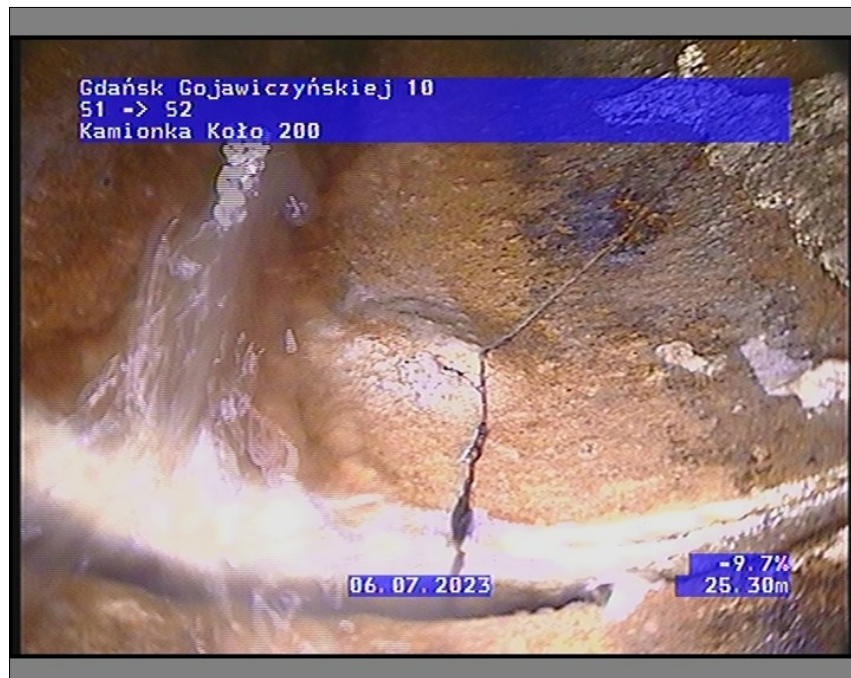
Zdjęcie: 1_6B 25,03m, Wzdłużne pęknięcie ścian przewodu, na 5 godz.
