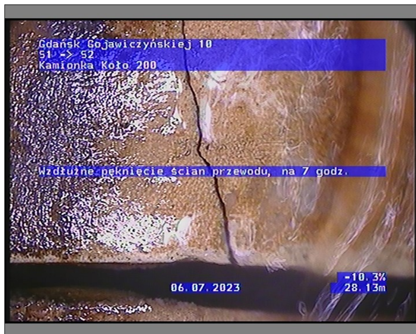
Zdjęcie: 1_7A 28,12m, Wzdłużne pęknięcie ścian przewodu, na 7 godz.
