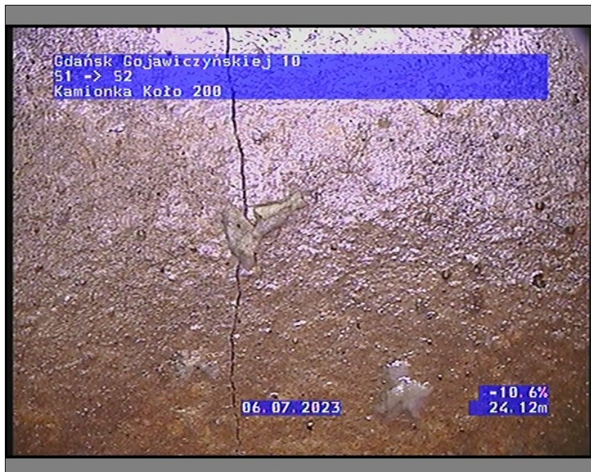
Zdjęcie: 1_5A 24,09m, Wzdłużnie po kierunku przewodu, na 12 godz.
