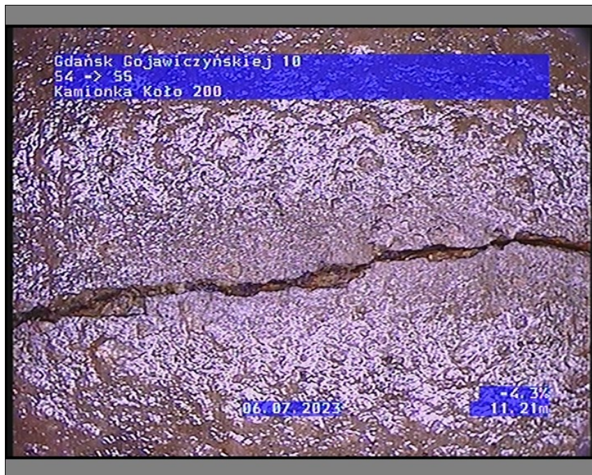
Zdjęcie: 4_6A 11,21m, Obwodowe pęknięcie ciany przewodu, od 8 do 4 godz.
