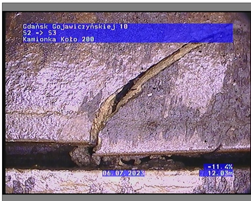
Zdjęcie: 2_3A 12,03m, Obwodowe pęknięcie otwarte cian przewodu, 3 mm, od 6 do 8 godz.
