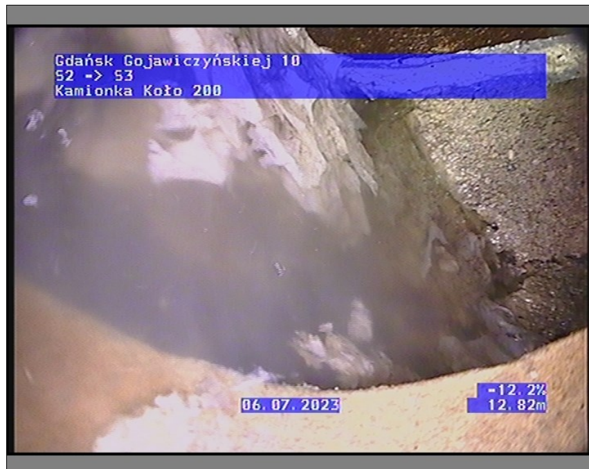
Zdjęcie: 2_5A 13,13m, Rezygnacja z inspekcji, Przeszkoda
