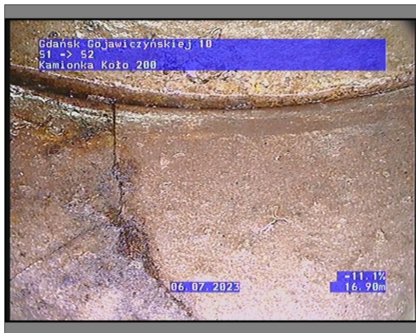
Zdjęcie: 1_3A 16,9m, Obwodowe pęknięcie ciany przewodu, od 11 do 4 godz.
