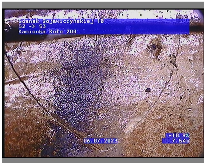
Zdjęcie: 2_2A 7,4m, Obwodowe pęknięcie cian przewodu, od 7 do 8 godz.
