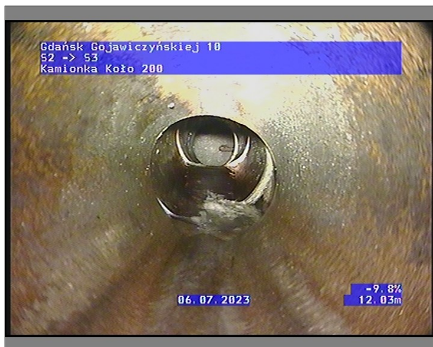
Zdjęcie: 2_5B 13,13m, Rezygnacja z inspekcji, Przeszkoda
