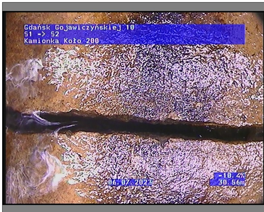
Zdjęcie: 1_8A 30,56m, Obwodowe pęknięcie otwarte cian przewodu, od 12 do 12 godz.
