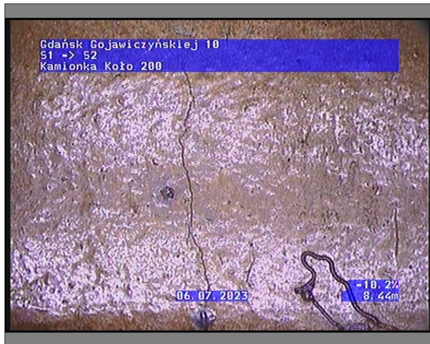
Zdjęcie: 1_2A 8,44m, Wzdłużne pęknięcie ciany przewodu, na 2 godz.
