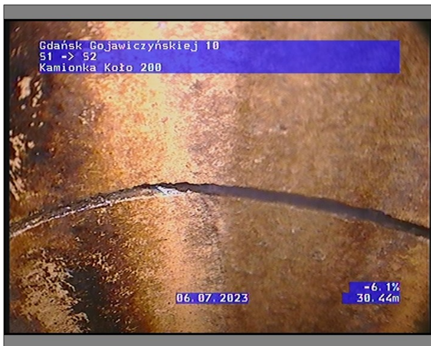
Zdjęcie: 1_8B 30,56m, Obwodowe pęknięcie otwarte cian przewodu, od 12 do 12 godz.
