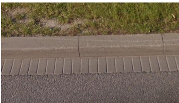
Fot. 7 Sposób ułożenia ścieku wzdłuż jezdni z kostki betonowej 20x10 cm
