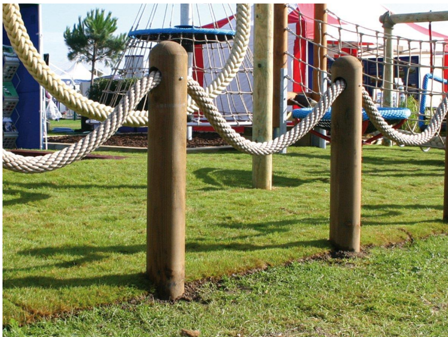
Fot. nr 1 Propozycja mocowania lin w słupkach
