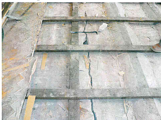
Foto 2. Widoczna rysa w stropie po zdjęciu warstw posadzki drewnianej. Na stropie, ułożone krzyżowo drewniane legary podłogi sprężystej
