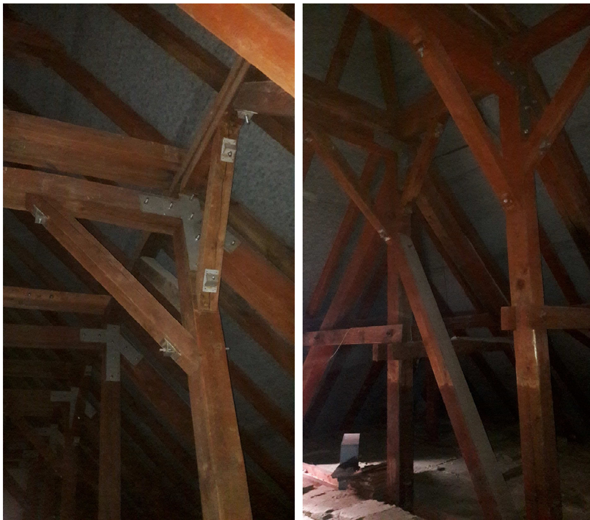
Rys. 3.7. Widok ogólny konstrukcji drewnianej więźby dachowej oraz wzmocnień stalowych połączeń
