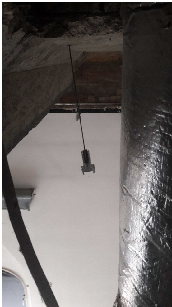
Rys. 3.3. Wieszak noniuszowy pozostawiony w stropie – widok montażu
