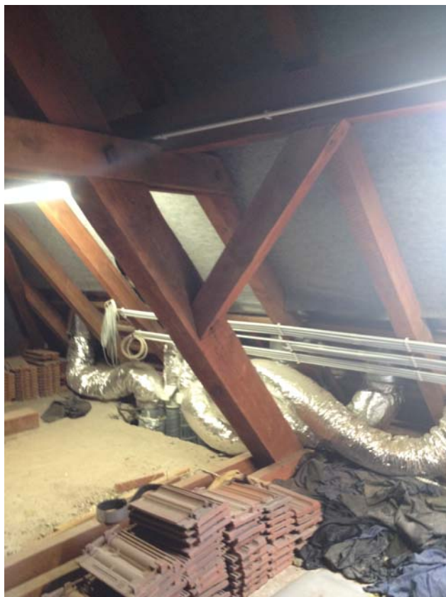
MIEJSCE PRZEJŚCIA KANAŁÓW WENTYLACYJNYCH NA DACH
