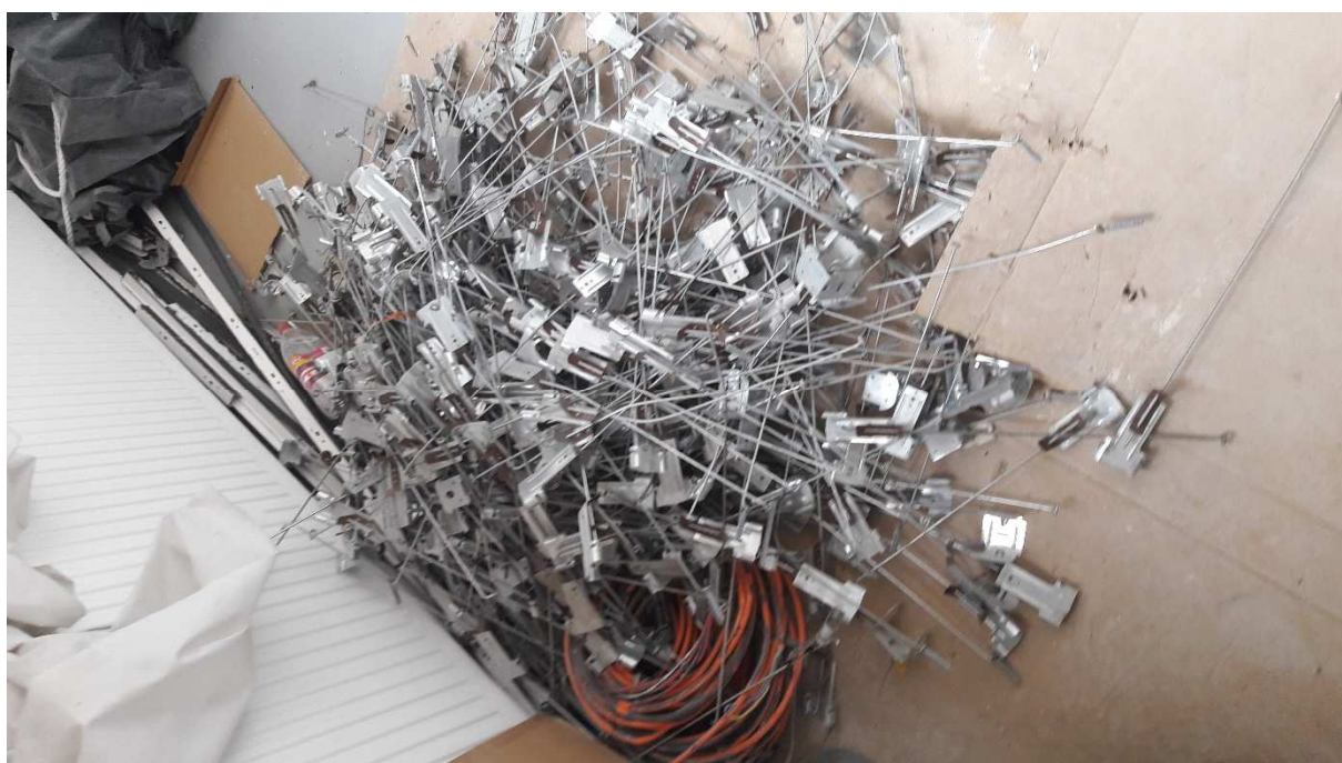
Rys. 3.2. Pozostałości wieszaków noniuszowych po demontażu sufitu podwieszanego
