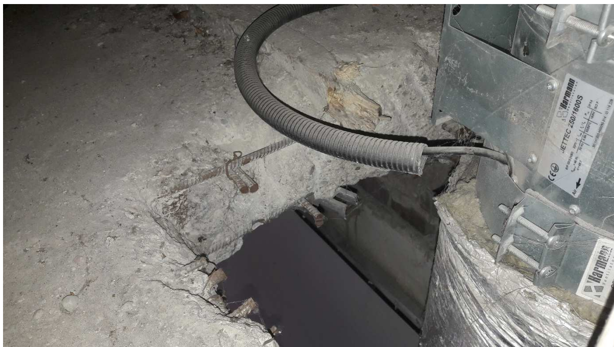
Rys. 3.5. Stan konstrukcji żelbetowej stropu w obrębie otworów wykonanych na potrzeby przeprowadzenia przewodów wentylacyjnych
