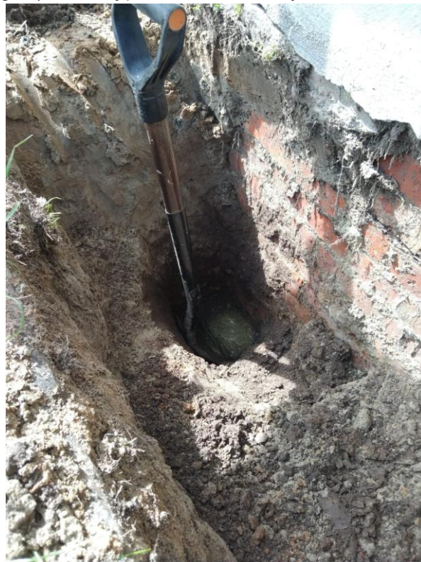
Odkrywka nr 2 pod częścią 1 kondygnacyjną widoczna poduszka z chudego betonu
