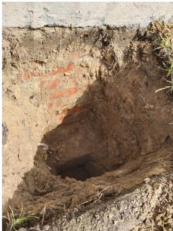
Odkrywka nr 1 pod częścią 2 kondygnacyjną Widoczny bankiet ławy fundamentowej wys. 35 cm
