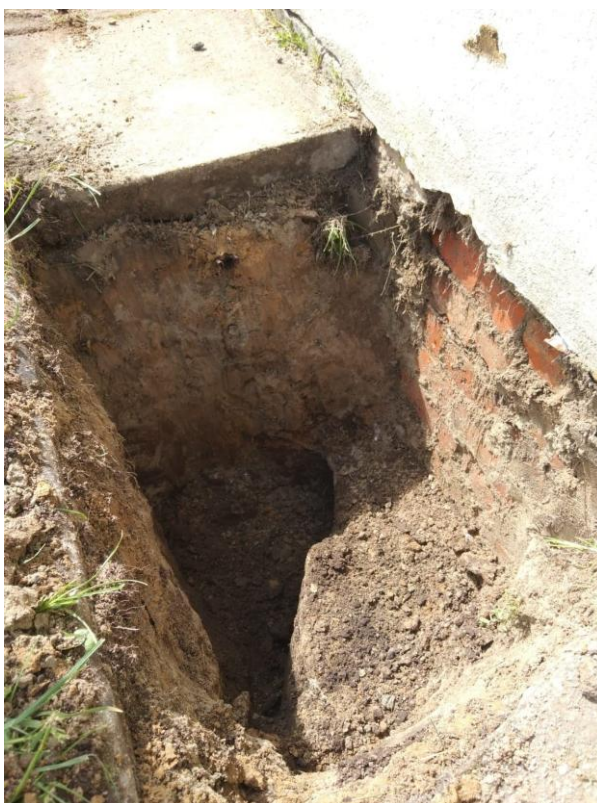
Odkrywka nr 2 pod częścią 1 kondygnacyjną widoczna poduszka z chudego betonu (oraz gruz) na której posadowiono ścianę fundamentową
