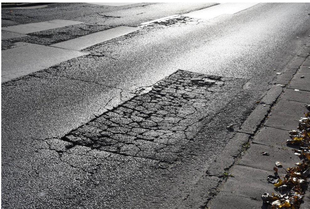
Fot. 18. Przykład przeprowadzonej nieskutecznej naprawy – spękana łata z betonu asfaltowego
