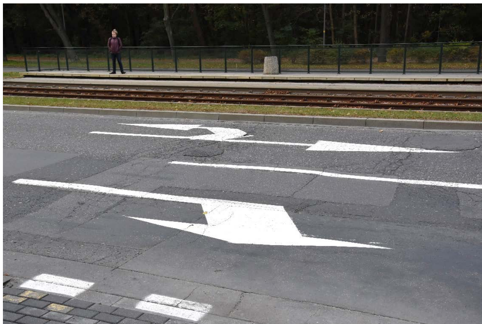
Fot. 7. Przykład spękań poprzecznych i licznych napraw w postaci łat
