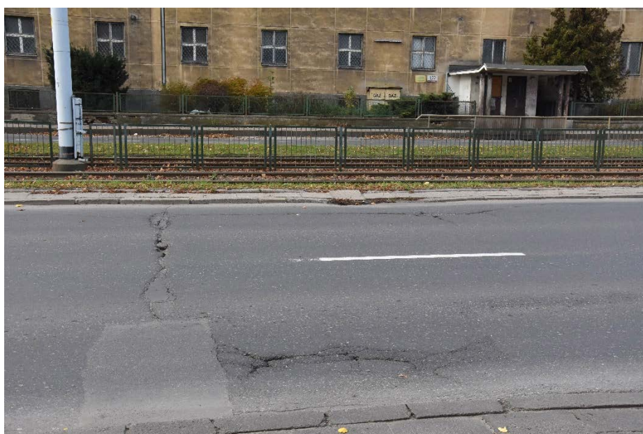
Fot. 3. Przykład spękań zarówno spękań poprzecznych na całą szerokość jezdni, jak i spękań naprawianych częściowo na prawym pasie ruchu
