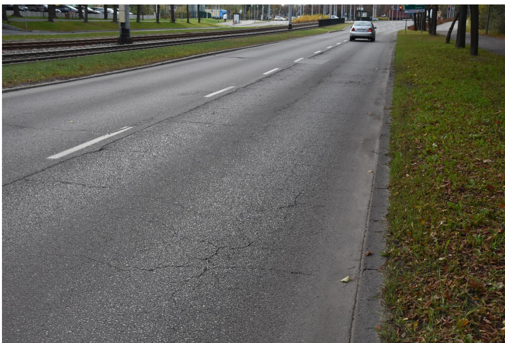
Fot. 15. Przykład spękań zmęczeniowych występujących głównie na prawym pasie ruchu pomiędzy skrzyżowaniami z ul. Dworską i Al. Płazyńskiego
