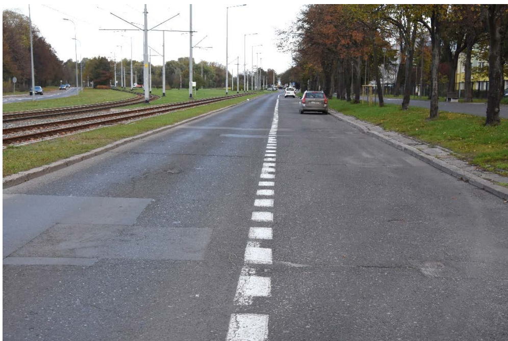
Fot. 8. Przykład licznych spękań poprzecznych
