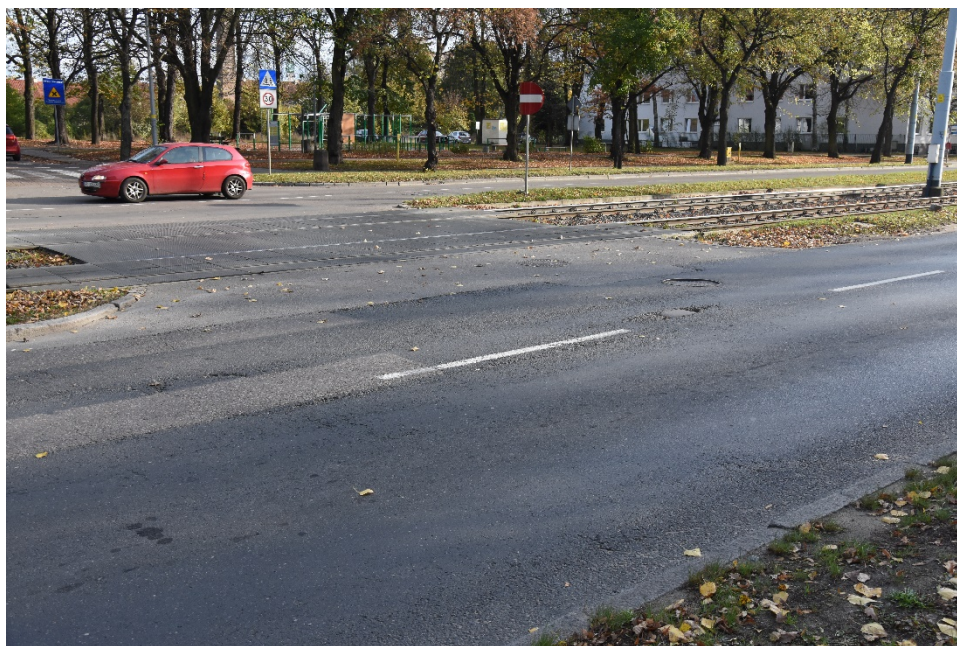
Fot. 26. Przykład uszkodzeń na lewym pasie ruchu na wysokości przejazdu przez torowisko
