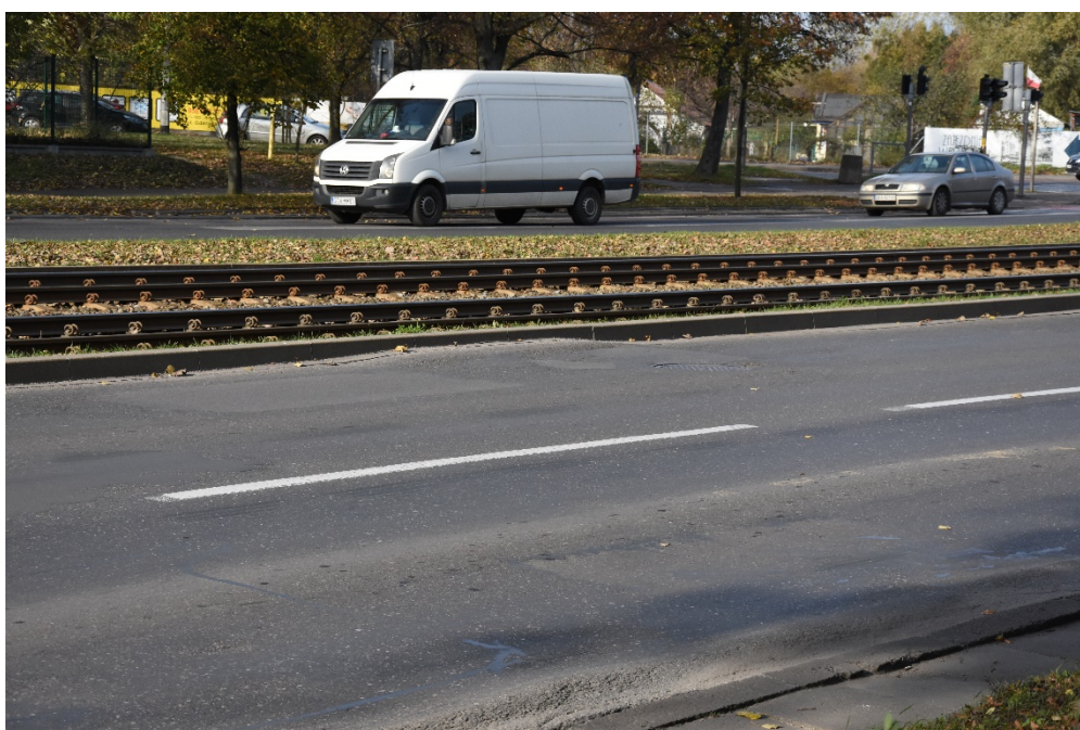
Fot. 5. Przykład zapadnięć w okolicy studni kanalizacyjnej na lewym pasie ruchu
