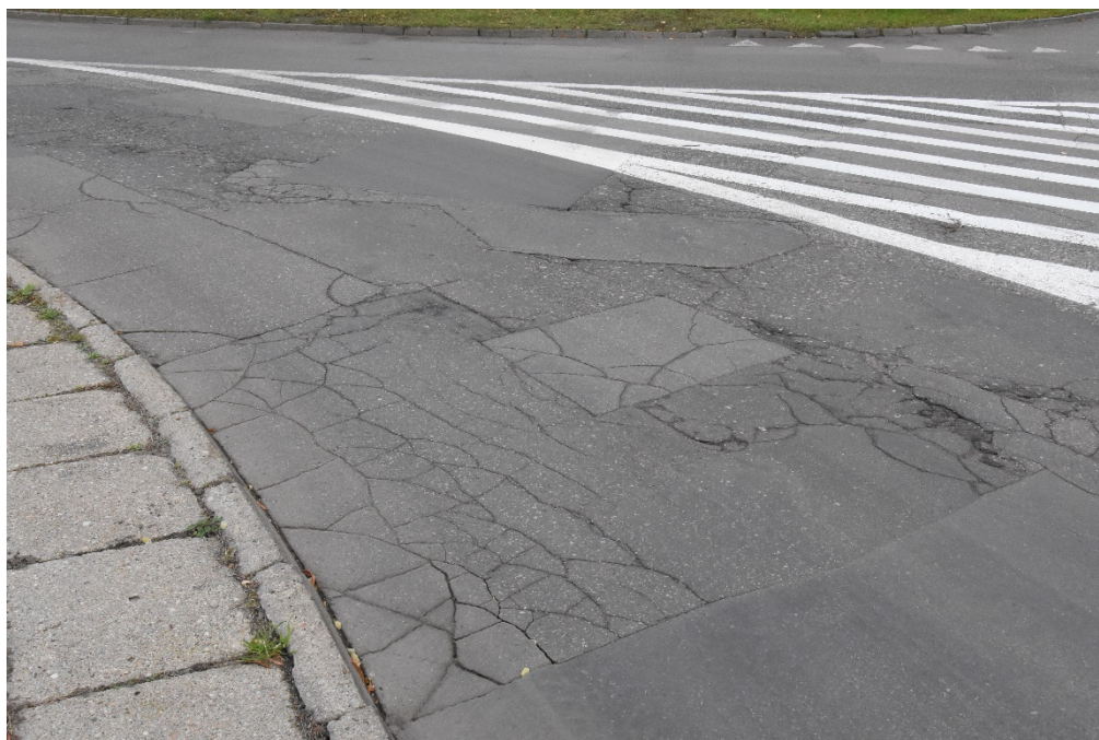
Fot. 12. Przykład spękań zmęczeniowych w początkowej części odcinka
