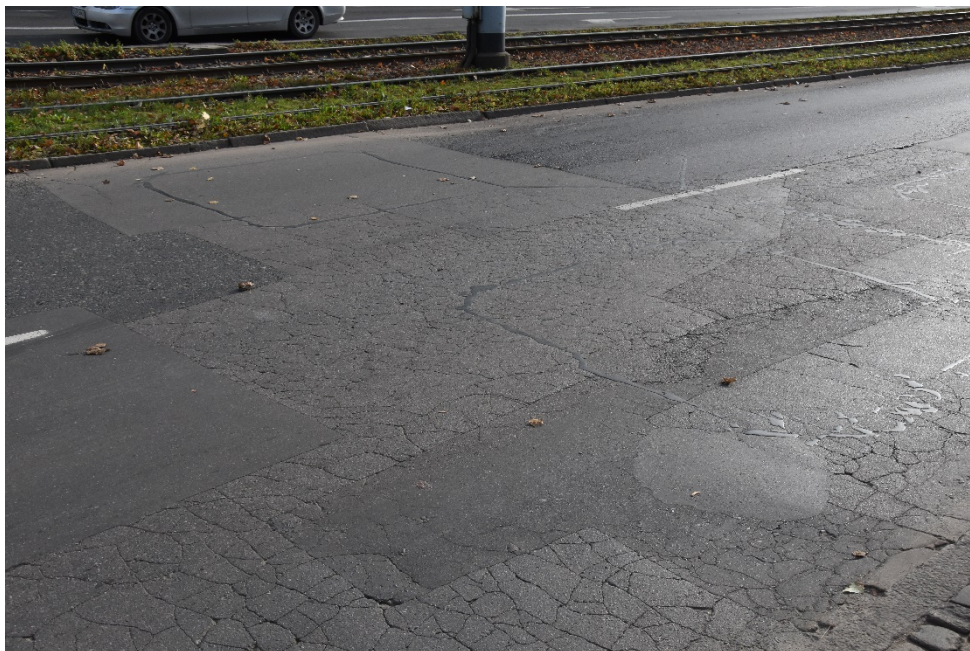
Fot. 21. Przykład spękań na całej powierzchni nawierzchni o charakterze spękań związanych ze starzeniem warstw asfaltowych (tzw. alligator cracking)
