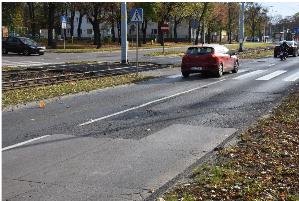
Fot. 25. Przykład występujących łat z betonu asfaltowego
