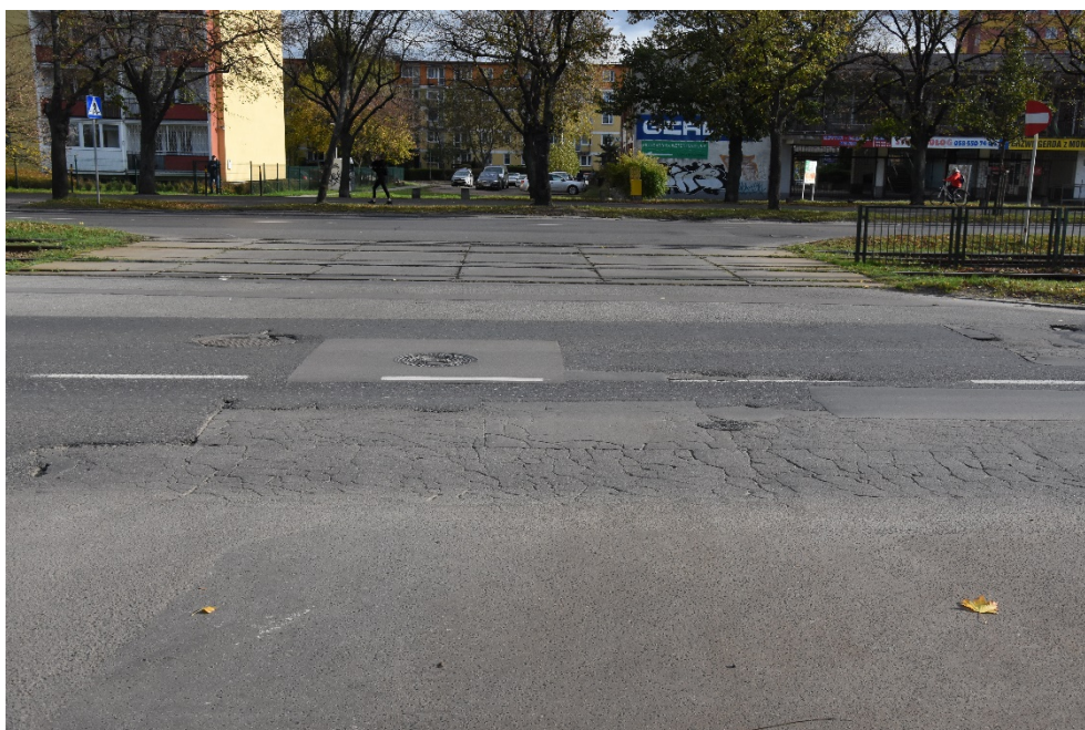
Fot. 20. Przykład spękań zmęczeniowych na prawym pasie ruchu na wysokości przejazdu przez torowisko tramwajowe
