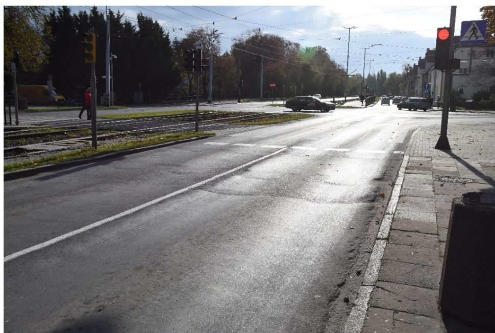
Fot. 22. Przykład dużych deformacji plastycznych w strefach przed skrzyżowaniami
