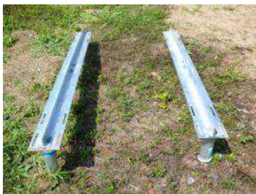
26. Ułożenie i zamocowanie belek stalowych
