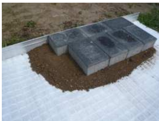
30. Ułożenie nawierzchni na podsypce cementowo-piaskowej
