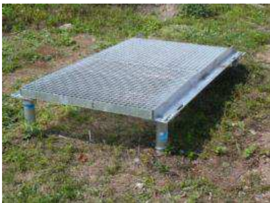
27. Ułożenie modułów kratowych i zamocowanie ich do belek
