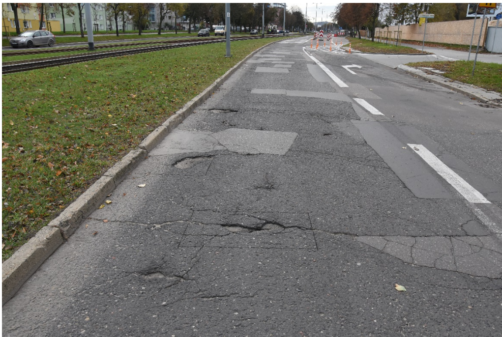
Fot. 14. Przykład degradacji nawierzchni w postaci wybojów
