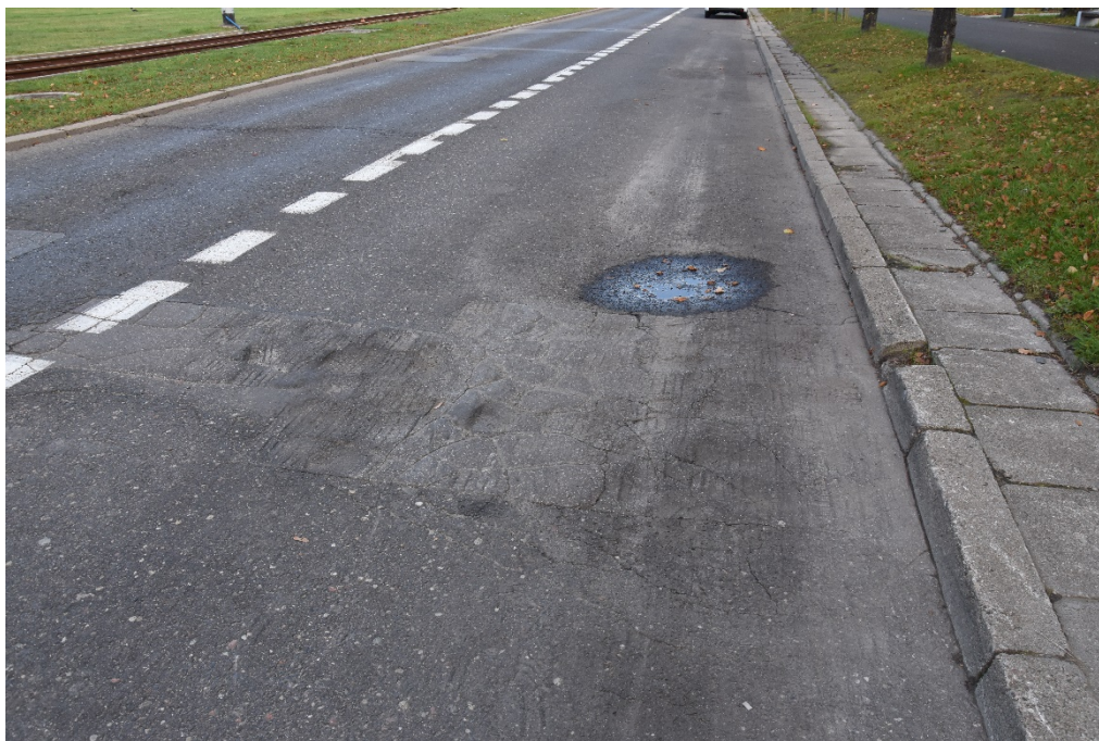
Fot. 9. Przykład odcisków i deformacji istniejących warstw bitumicznych na pasie prawym z wydzielonymi miejscami postojowymi
