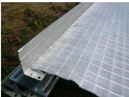
29. Ułożenie zbrojonej włókniny filtracyjnej
