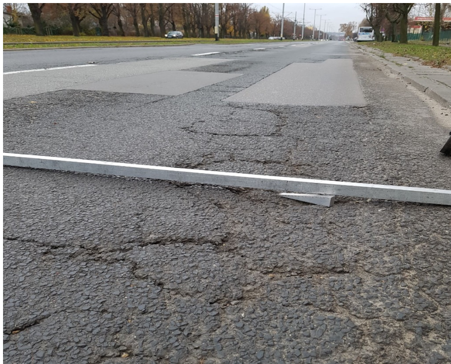
Fot. 27. Przykład stwierdzonych deformacji istniejących warstw bitumicznych na Al. Hallera, odc. od Al. Płazyńskiego, do ul. Mickiewicza, jezdni w kier. Wrzeszcza, pas prawy (km 0+569) – stwierdzona głębokość koleiny: 27 mm
