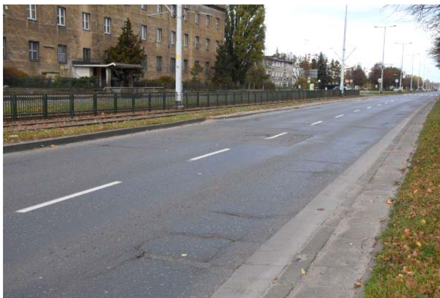
Fot. 1. Ogólny widok odcinka z widocznymi, licznymi spękaniami poprzecznymi
