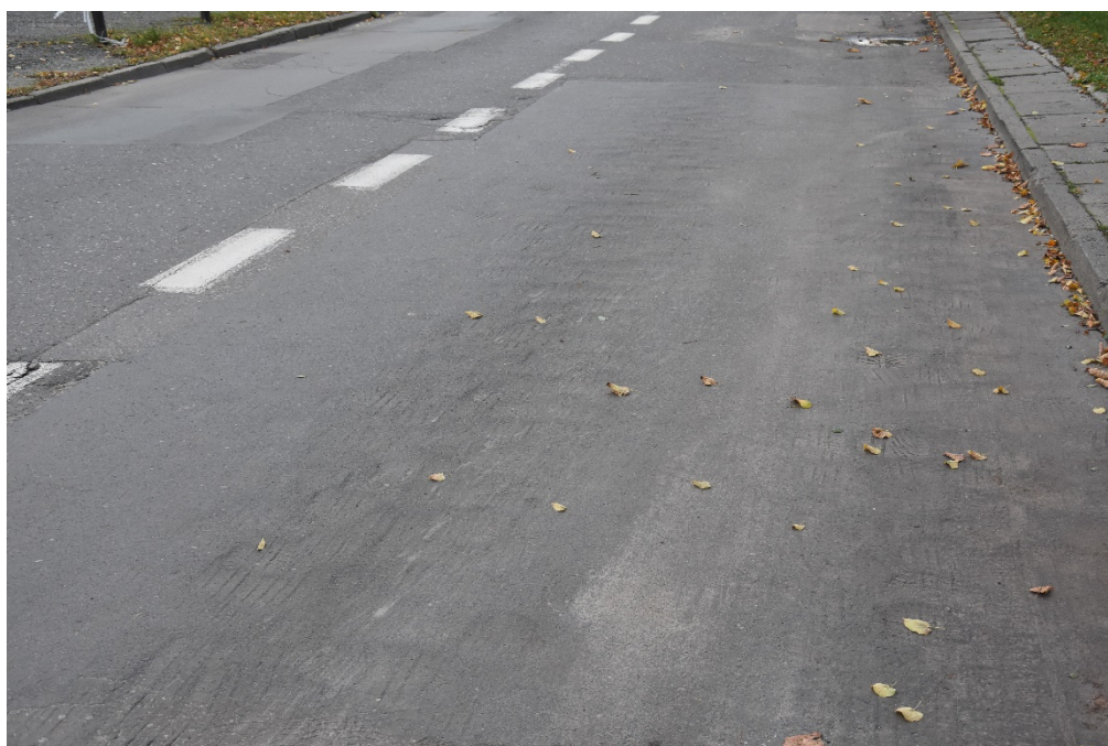
Fot. 13. Przykład odcisków i deformacji istniejących warstw bitumicznych na pasie prawym z wydzielonymi miejscami postojowymi
