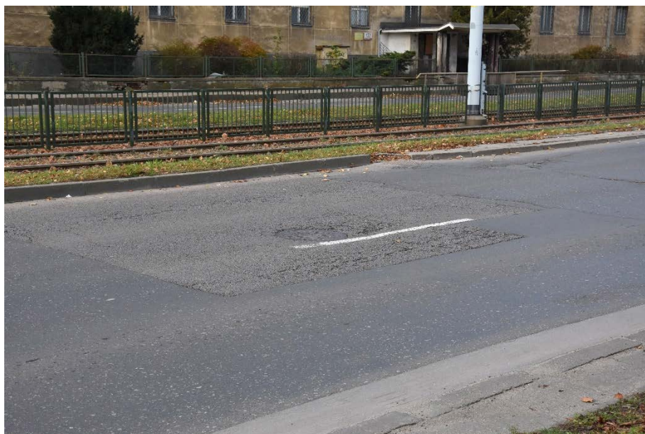
Fot. 2. Przykład spękań zmęczeniowych występujących na wykonanej łacie w okolicy studni kanalizacyjnej
