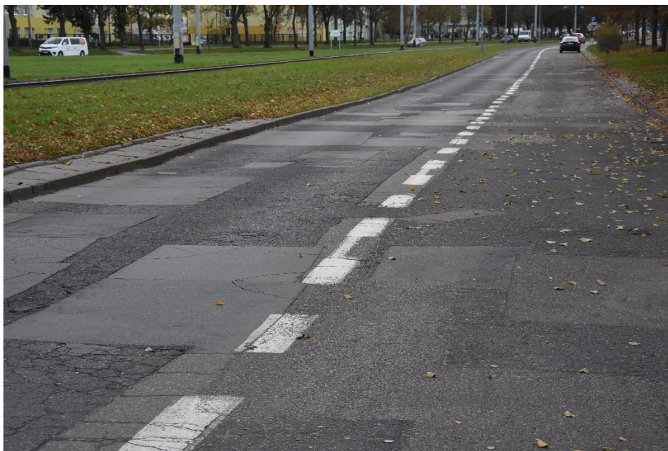
Fot. 11. Ogólny widok odcinka z licznymi spękaniami i naprawami w postaci łat
