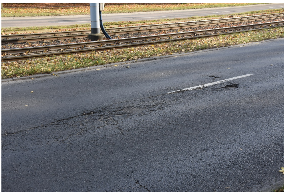
Fot. 24. Przykład występujących spękań zmęczeniowych oraz wybojów w nawierzchni
