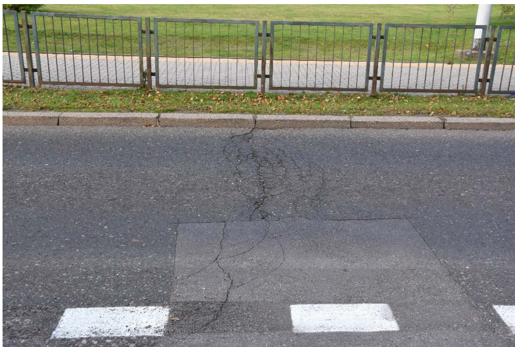
Fot. 10. Przykład postępującej degradacji nawierzchni w obrębie powstałego spękania poprzecznego
