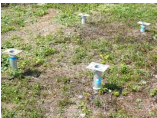
25. Montaż śrub kotwiących w gruncie
