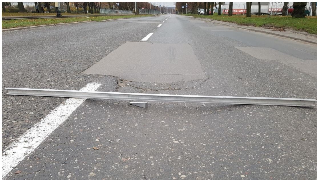
Fot. 28. Przykład stwierdzonych deformacji istniejących warstw bitumicznych na Al. Hallera, odc. od Al. Płazyńskiego, do ul. Mickiewicza, jezdni w kier. Wrzeszcza, pas prawy (km 0+810 wysokość stacji benzynowej) – stwierdzona głębokość koleiny: 34 mm
