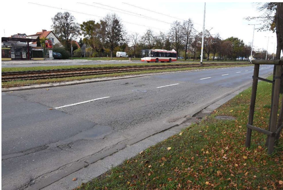
Fot. 4. Przykład intensywnych spękań zmęczeniowych na prawym pasie ruchu
