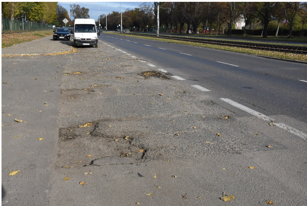
Fot. 19. Przykład uszkodzeń i wybojów na pasach wyłączania i prawoskrętach
