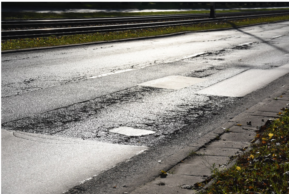
Fot. 17. Przykład występujących spękań zmęczeniowych oraz przeprowadzonych napraw tych uszkodzeń w postaci łat
