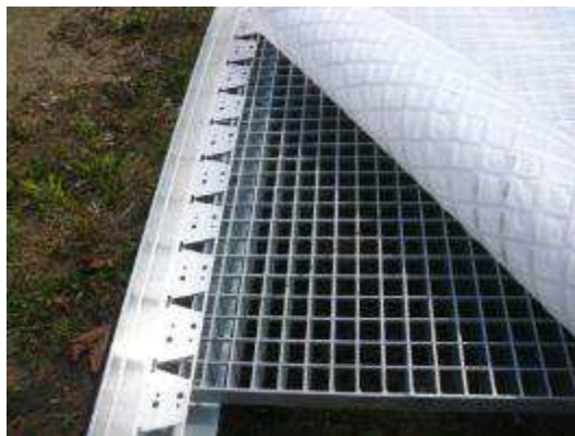
28. Montaż systemowych obrzeży stalowych
