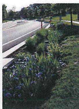
Utworzenie w zagłębieniu suchej rzeki - obsadzonej bylinami i krzewami znoszącymi tymczasowe zalewanie.
