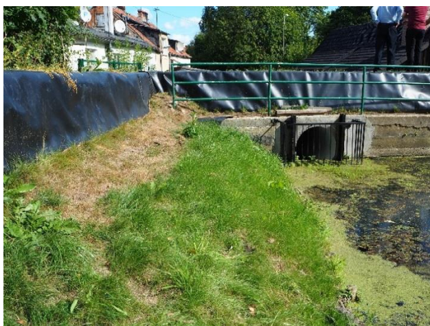
Zdjęcie 5. Zapora czołowa od strony zachodniej – widok tymczasowego zabezpieczenia p.pow.
