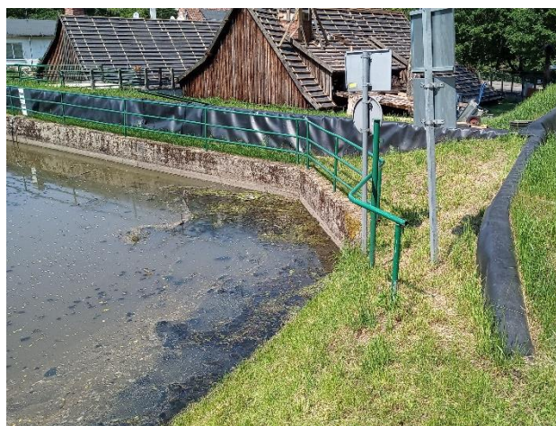
Zdjęcie 6. Zapora czołowa od strony wschodniej – widok tymczasowego zabezpieczenia p.pow.
