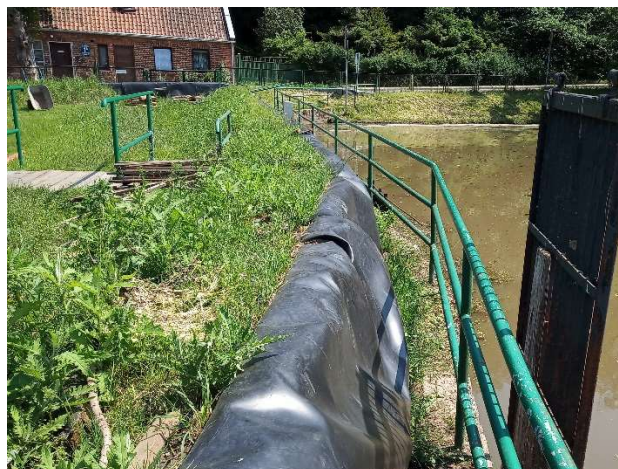
Zdjęcie 4. Zapora czołowa od strony wschodniej – widok tymczasowego zabezpieczenia p.pow.
