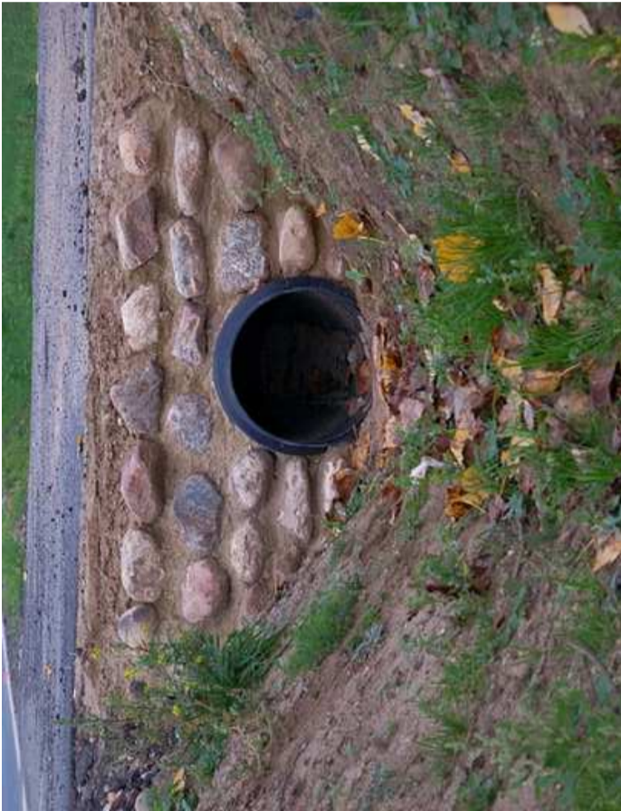
Przykład umocnienia skarpy kamieniem brukowym na zaprawie
