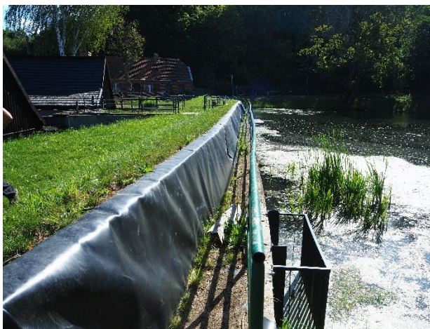
Zdjęcie 3. Zapora czołowa od strony zachodniej – widok tymczasowego zabezpieczenia p.pow.
