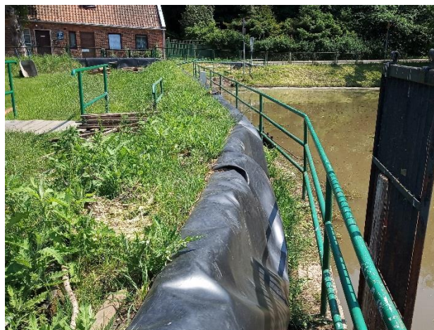
Zdjęcie 4. Zapora czołowa od strony wschodniej – widok tymczasowego zabezpieczenia p.pow.
