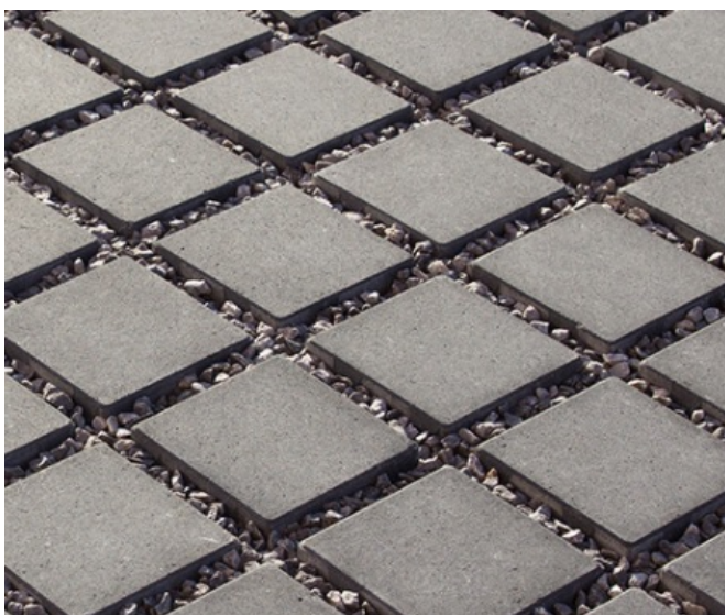
Zdjęcie 4 Nawierzchnia z kostki 18,5x18,5 cm
