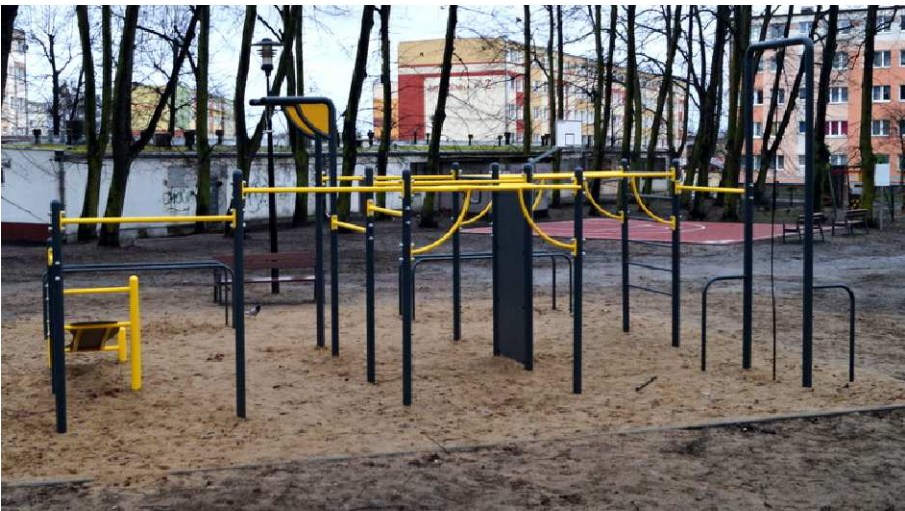
Zdjęcie poglądowe zastosowania kątnych wzmocnień konstrukcji pomiędzy słupkami a poprzeczkami (przykładowa realizacja w parku przy ulicy Związkowej w Gdańsku)
