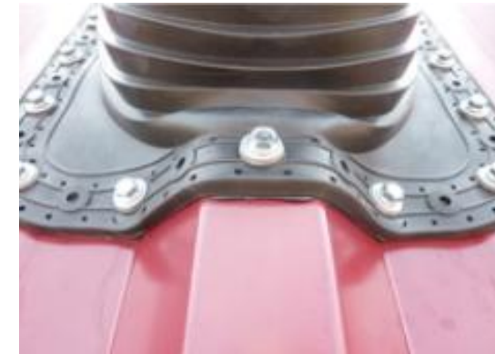
Szczelny montaż kołnierza kominka wentyl. mocowany na blasze trapezowej
