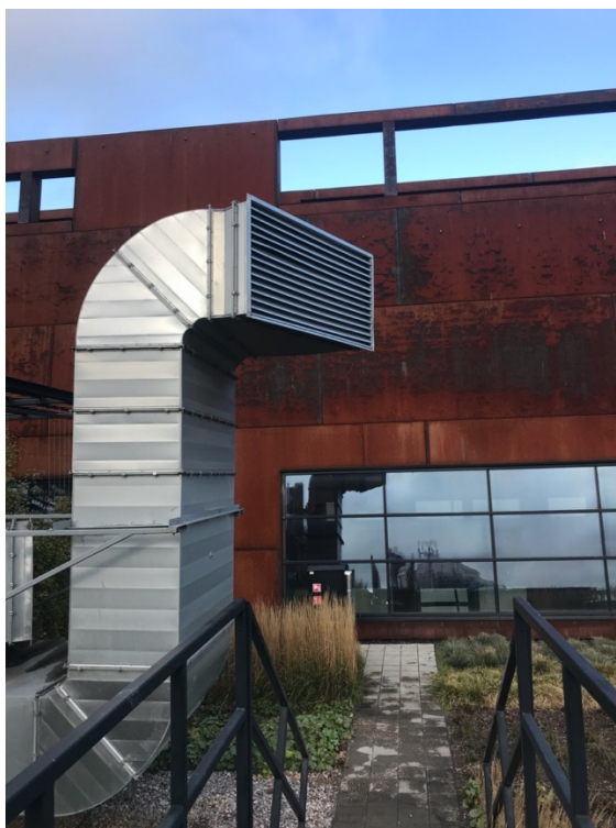
Zdjęcie 10. Przestający komin instalacji wentylacji do podłączenia z instalacją.
