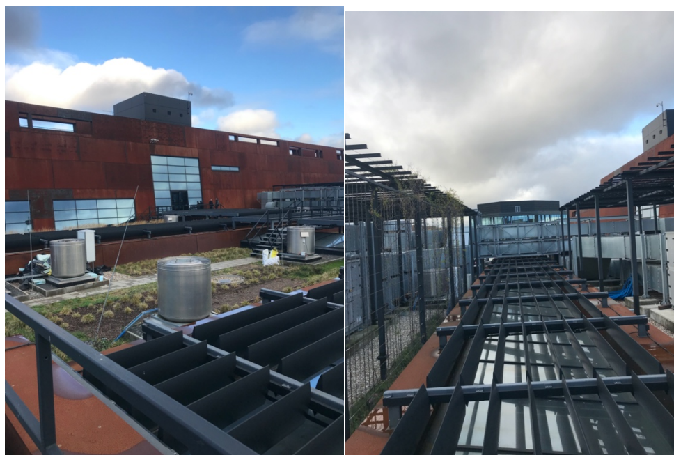
Zdjęcie 9. Konstrukcja stalowa na dachu.
