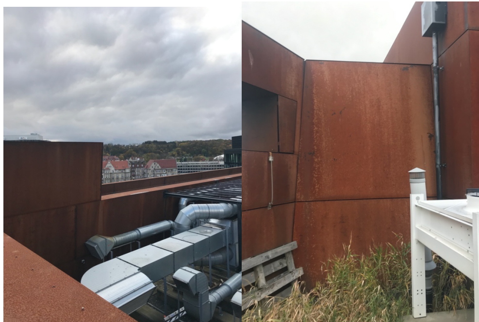
Zdjęcie 6. Miejsca łączenia blach Cor-Ten pomiędzy sobą (5 piętro).
