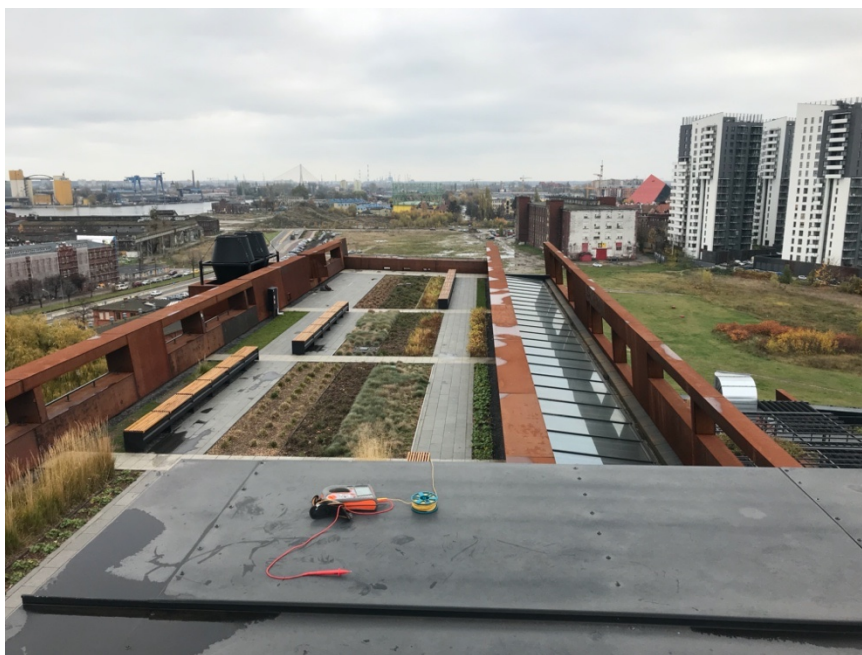
Zdjęcie 3. Teren zielony w którym należy ułożyć zwody poziome (6 piętro).
