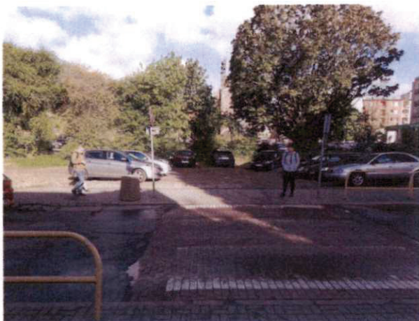
Zdjęcie 13. Wyeksplotowane wyniesione przejście dla pieszych przed głównym wejściem do szkoły oraz nieczytelne oznakowanie poziome
