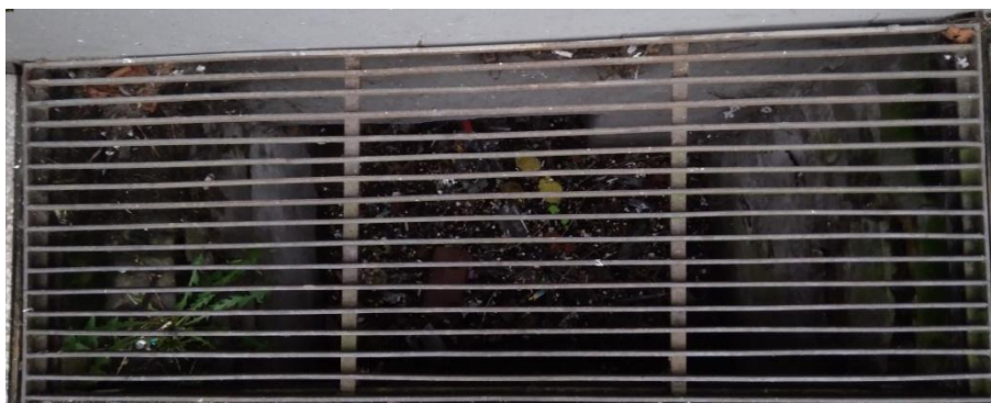
Fot. 12. Typ kraty na murkach naświetli
