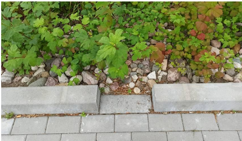
Fot. 8 Lokalne zastąpienie krawężnika opornikiem bez wysunięcia, umożliwiające spływ wody.
