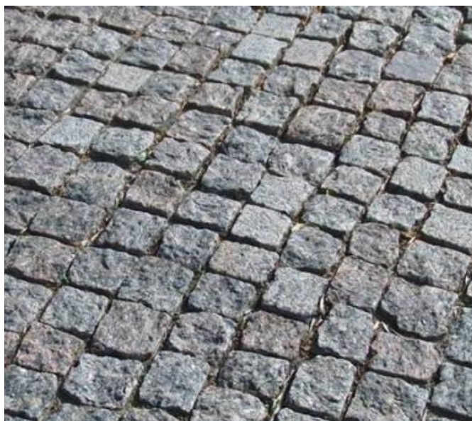
Fot. 8. Kostka granitowa o bokach i górze łupanej 4/6 cm
