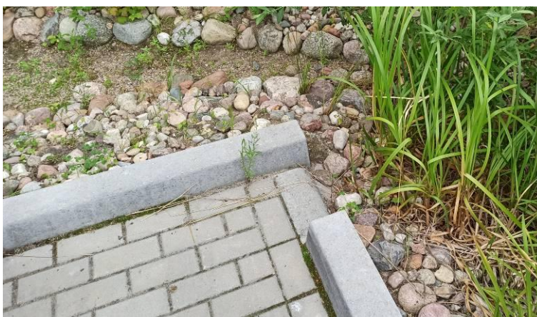
Fot. 9 Lokalne zastąpienie krawężnika opornikiem bez wysunięcia, umożliwiające spływ wody.
