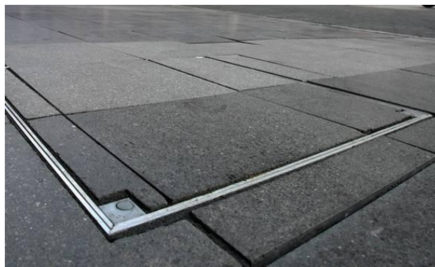
Fot. 15. Pokrywa z wypełnieniem z płytki chodnikowej
