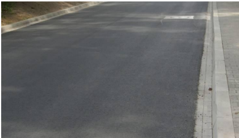
Fot. 5 Nawierzchnia z betonu asfaltowego w kolorze czarnym.
