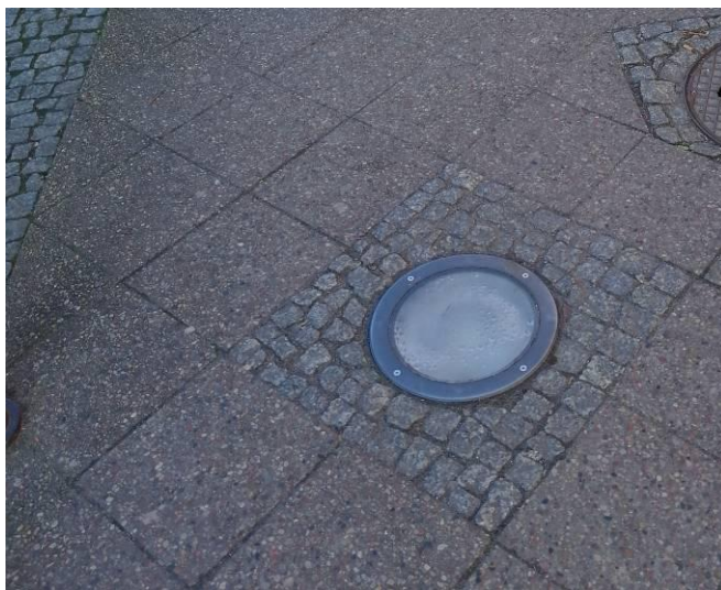
Fot. 9. Nawierzchnia z płytek betonowych o powierzchni płukanej 30x30 cm.
