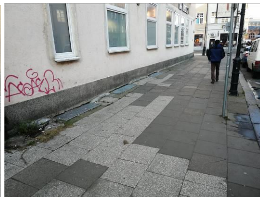
Fot. 4. Nawierzchnia chodnika z płyt betonowych w stanie złym
