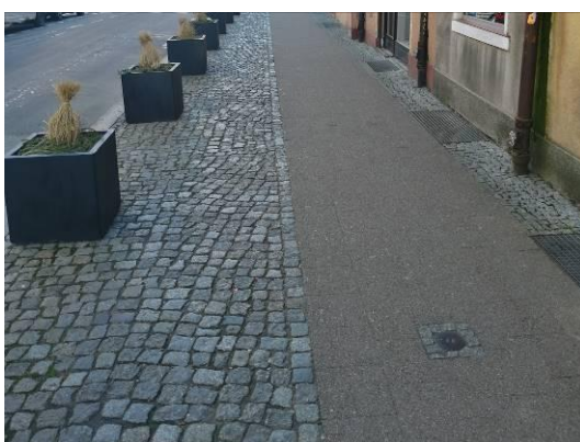
Fot. 3. Nawierzchnia chodnika z płytek chodnikowych płukanych i kostki kamiennej - w stanie dobrym
