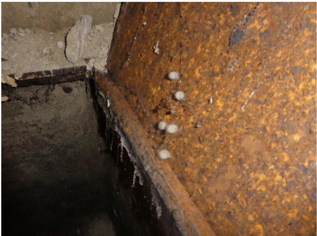
Fot. Grzybnia grzyba domowego na włączu do kanału
