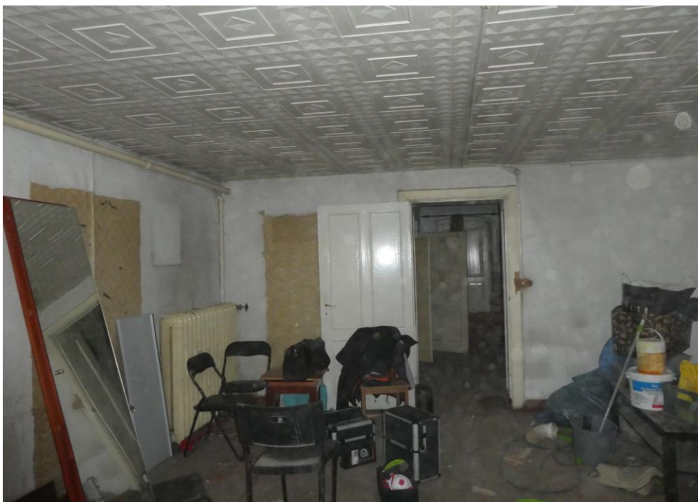
Fot. Ściany w pom. 5/A_0 obłożone tapetą (z kartonem) na ruszcie, sufit kasetonami styropianowymi
