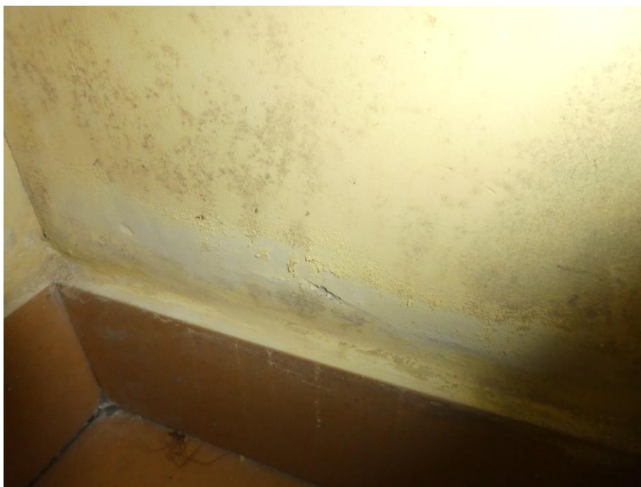
Fot. kolonie grzybów pleśniowych, sypiące farby, gładzie pom. 3/B_0
