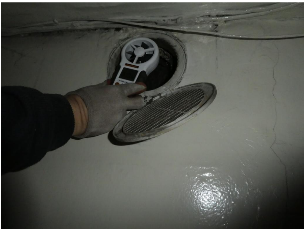
Fot. Po zdemontowaniu kratki wentylacja działała
