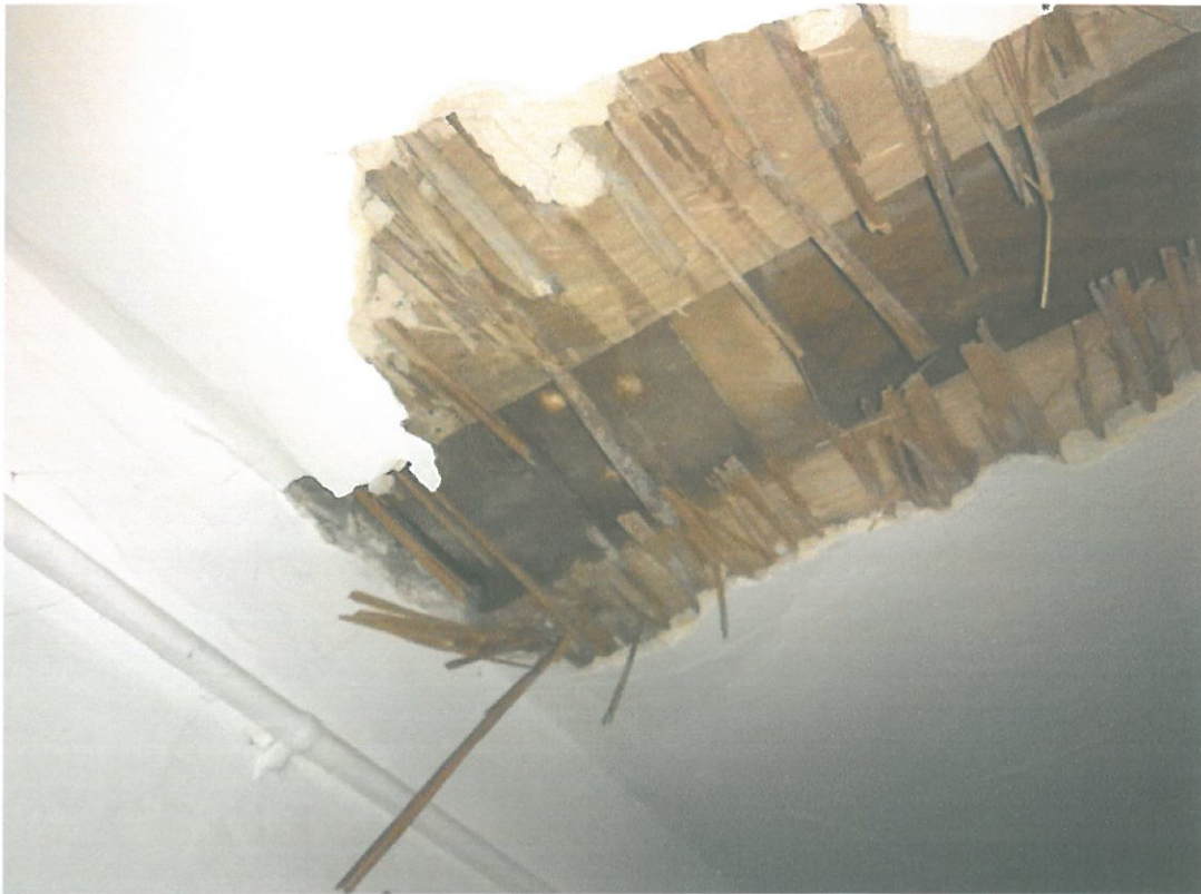
Zdj.2. Odkrywka stropu nad piwnicą
