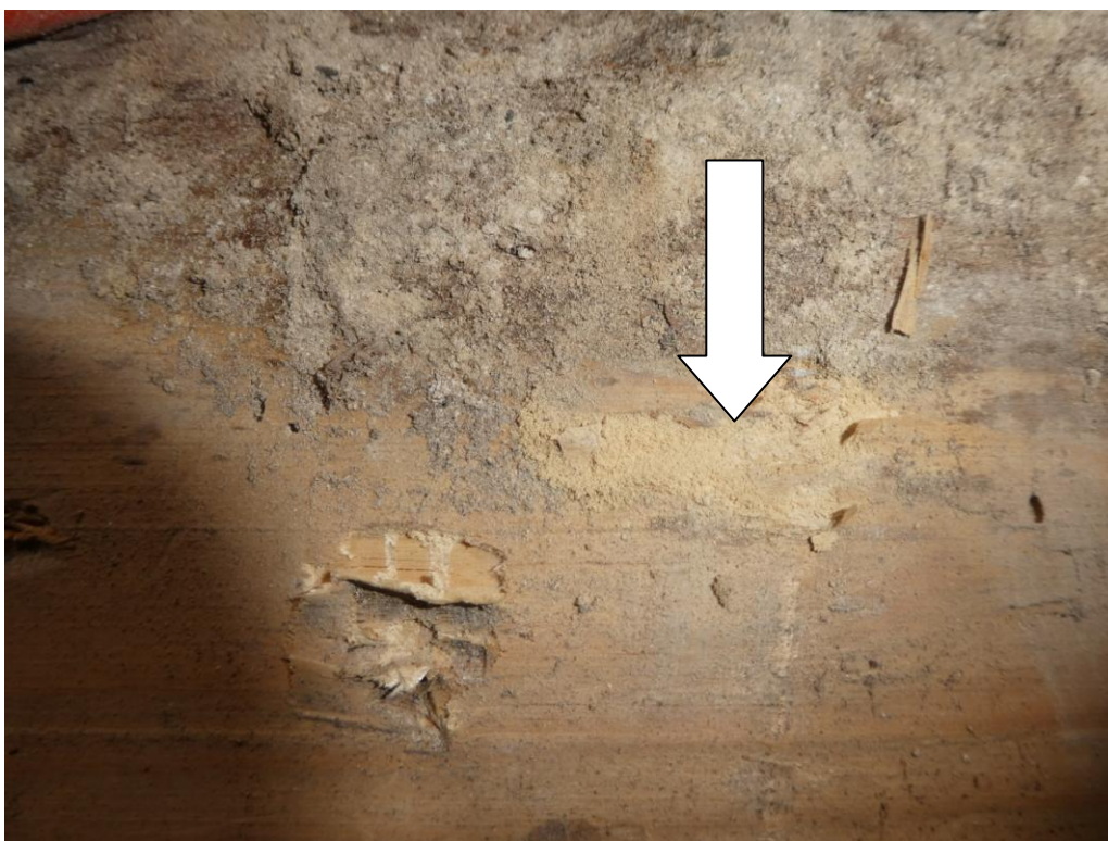
Fot. Żerowisko ksylofagów na listwie podłogowej (sypiąca mączka drzewna z odchodami)
