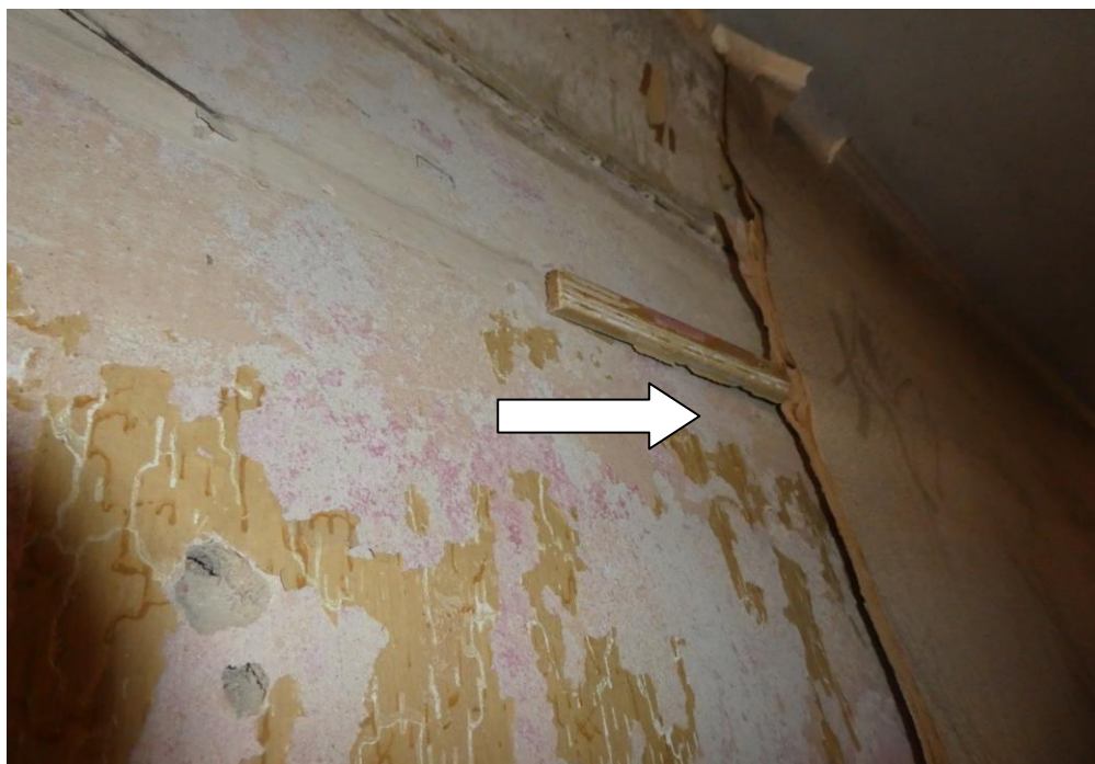
Fot. Tapety na kartonie, na ruszcie drewnianym (ściana wewnętrzna)
