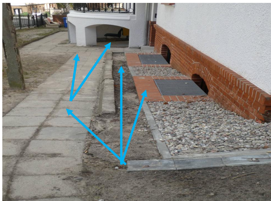
Fot. Kierunki spływu wody z rynny betonowej
