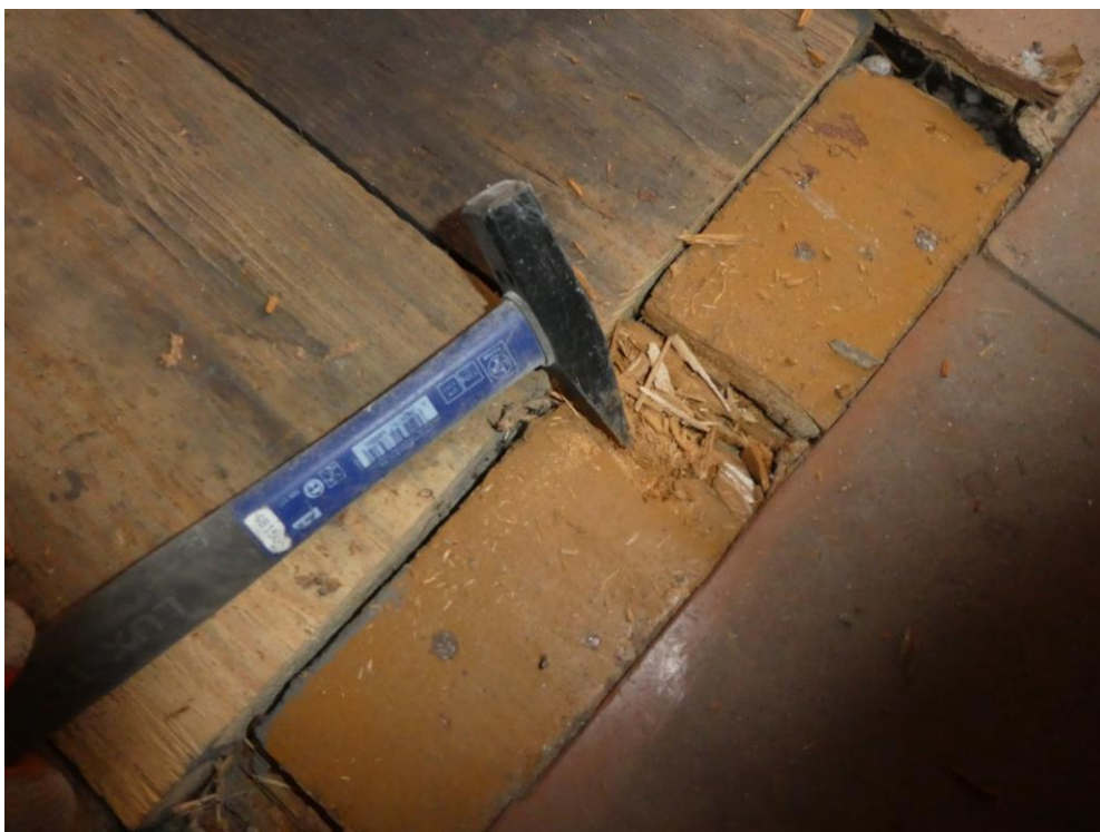
Fot. Zbliżenie, przegniła sypiąca deska podłogowa – pom. 5/A_0
