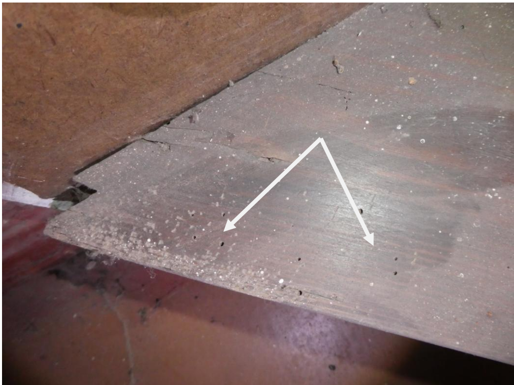
Fot. Otwory wylotowe owadów technicznych szkodników drewna na desce szafki w pom. 5/A_0
