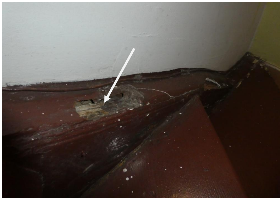
Fot. Zniszczenia elementu schodów drewnianych spowodowane korozją biologiczną
