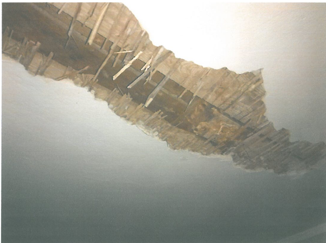
Zdj.3. Odkrywka stropu nad piwnicą
