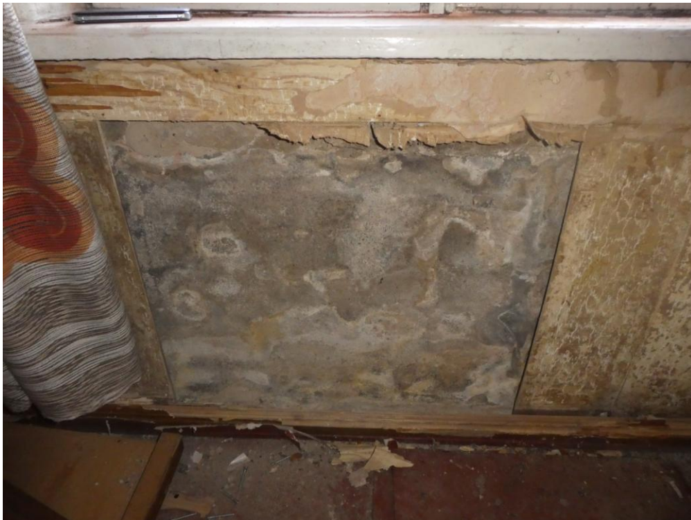
Fot. Mokra, zagrzybiona z wysoleniami odkryta część ściany zewnętrznej pod oknem pom. 2/A_0
