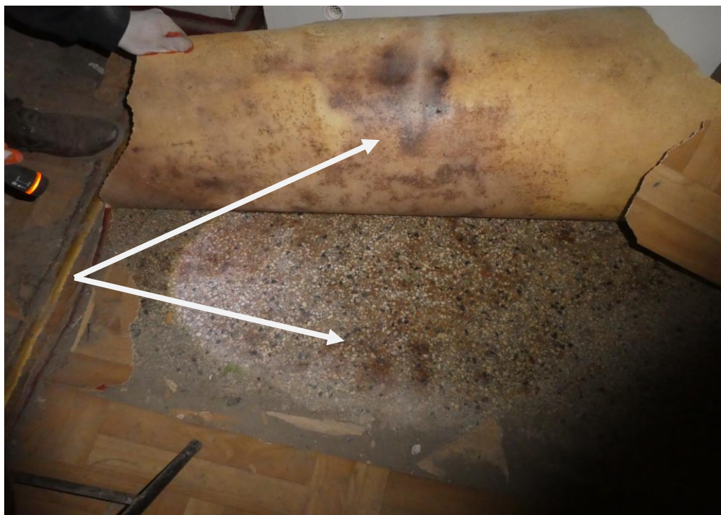
Fot. Mokre zagrzybione lastriko i wykładzina – posadzka pom. 4/A_0
