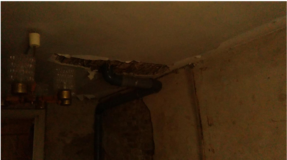
Widoczne odspojenie tynków na ścianie sutereny oraz na suficie.
