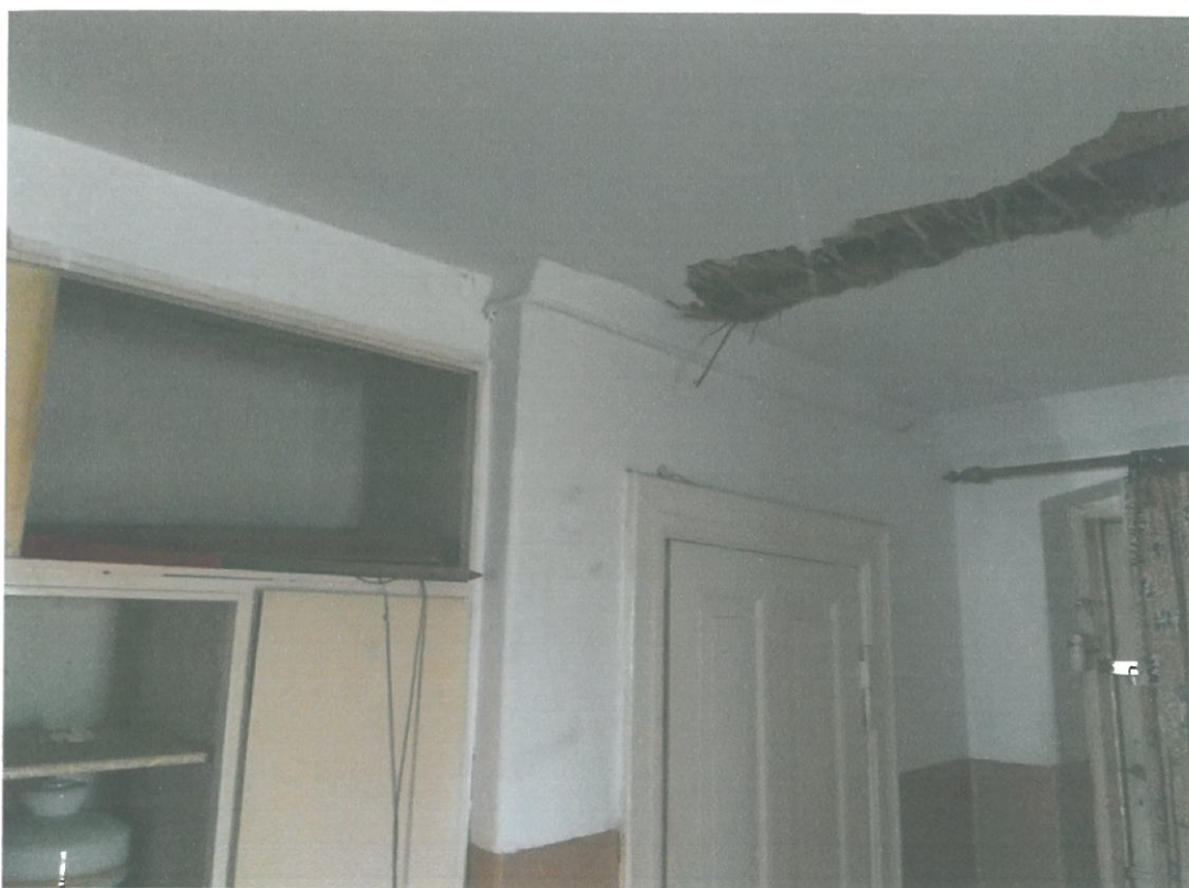
Zdj.4. Odkrywka stropu nad piwnicą
