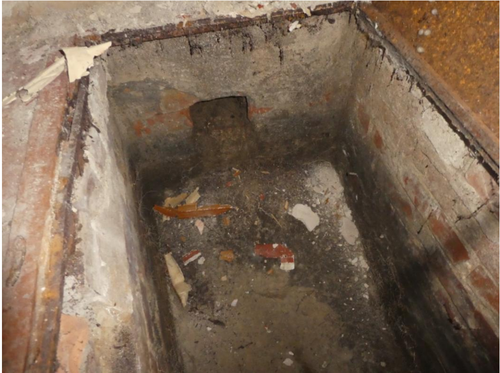
Fot. Mokre, zagrzybione ściany, przedziewały ruszt metalowy w kanale przy oknie w pomieszczeniu 2/A_0
