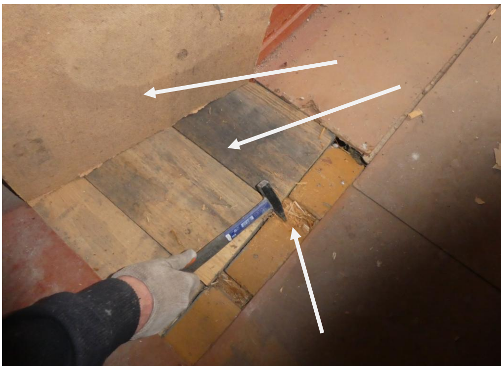
Fot. zawilgocona płyta pilśniowa przykrywająca podłogę z desek. Na deskach grzyby pleśniowe. Deski przy ostukiwaniu młotkiem kruszyły się. Pom. 5/A_0
