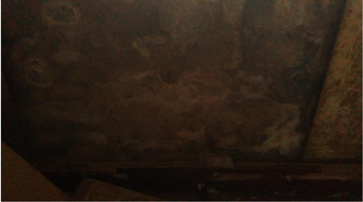
Widoczne zawilgocenia i wykwity solne na ścianie wewnętrznej sutereny
