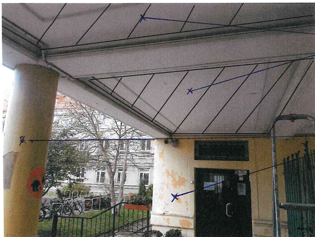
Miejsce planowanego docieplenia (przestrzeń między podciągami stropu)
