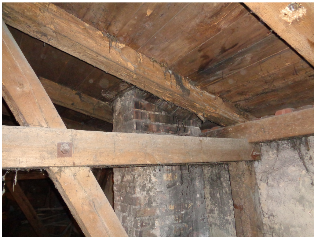
więźba dachowa budynku warsztatowego „D4” - widoczne uszkodzenia drewna
