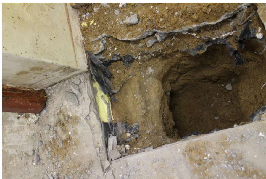
Fot. 9. Odkrywka 7 – ława fundamentowa ściany wewnętrznej Sali sportowej
