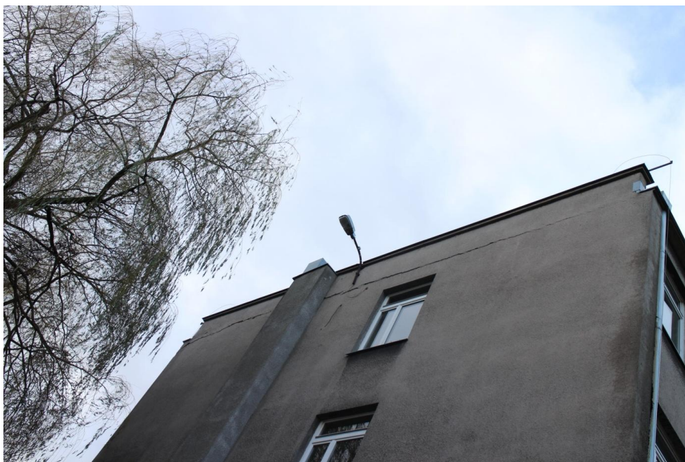
Fot. 28. Ściana szczytowa wschodnia. Widoczne pęknięcie attyki murowanej.
