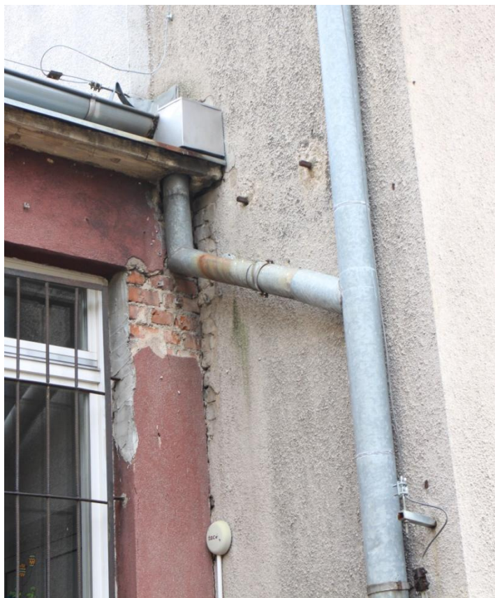
Fot. 22. Styk ścian łącznika i sali sportowej - pionowe zarysowanie między dwiema częściami budynku w skutek braku rozwiązania szczeliny dylatacyjnej. Widoczne ubytki wypraw tynkarskich, ślady korozji na rurach spustowych i drobne zacieki na gzymsie i ścianach.
