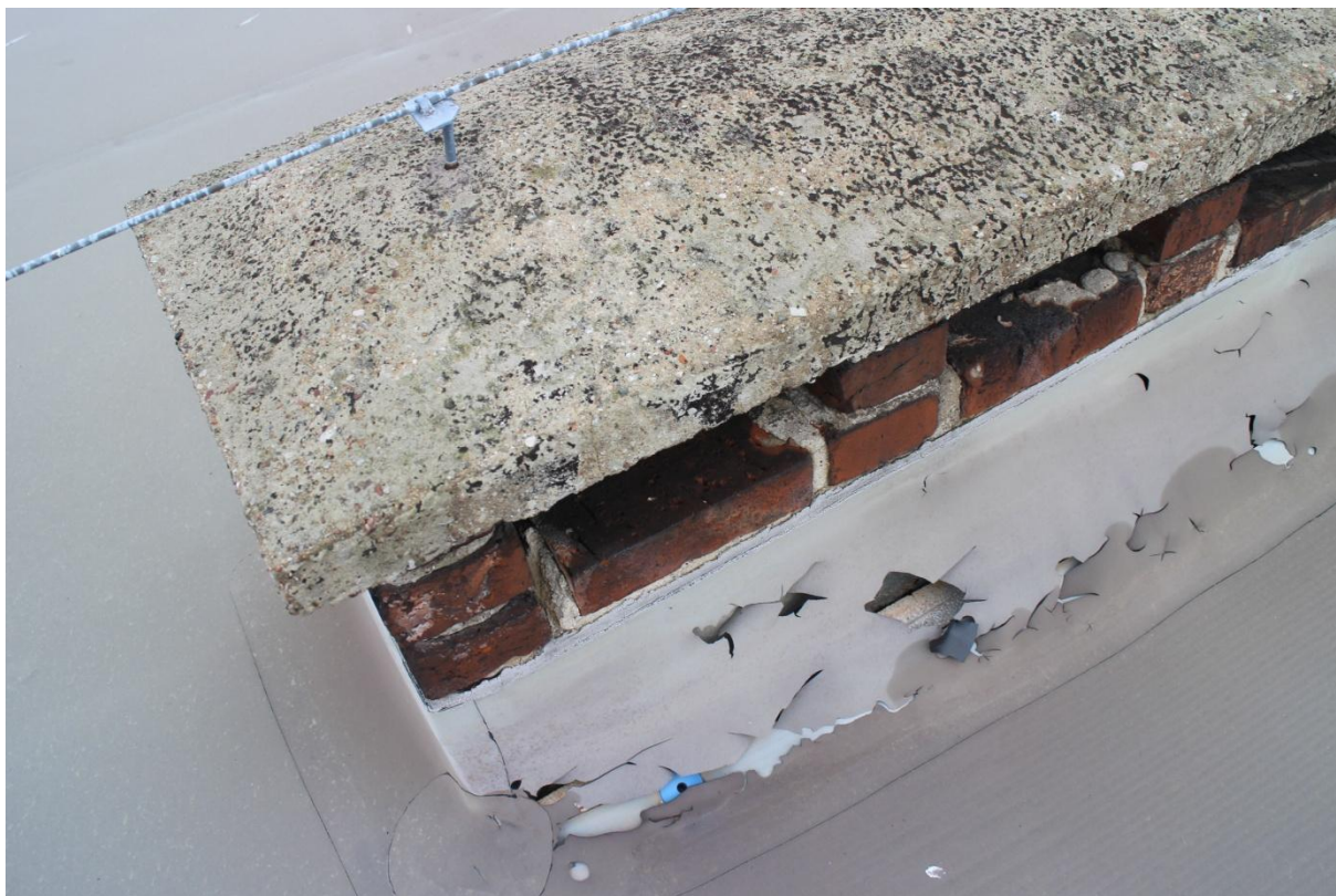
Fot. 20. Stropodach budynku szkoły. Widoczne uszkodzenia membrany wywiniętej na komin bez zastosowania fasety
