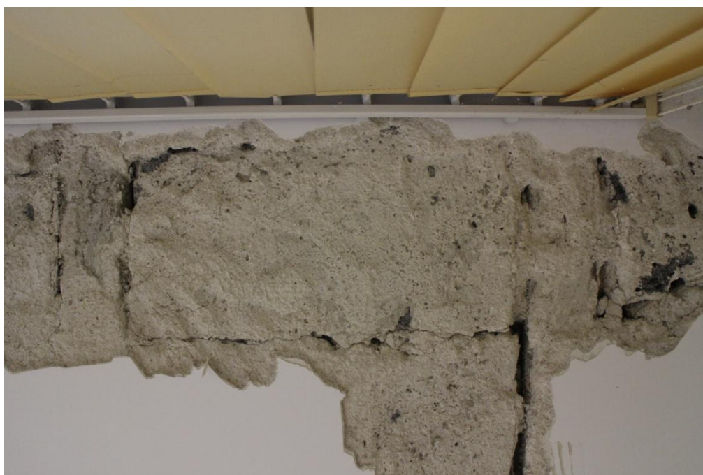
Fot. 15. Odkrywka 10 – strop nad piwnicą w sali sportowej. Widoczny układ żeber i pustaków stropu DMS.
