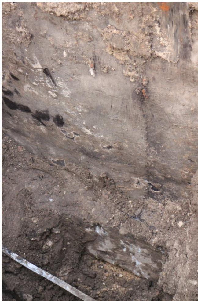
Fot. 4. Odkrywka 3 – ława fundamentowa ściany podłużnej południowej.
