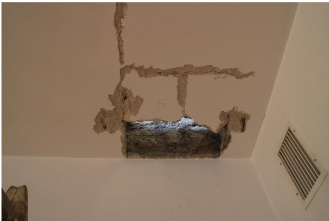
Fot. 11. Odkrywka 8 - strop nad piwnicą w budynku szkoły
