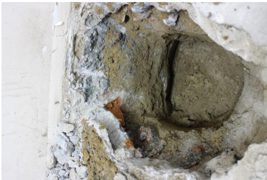
Fot. 8. Odkrywka 6 – ława fundamentowa ściany zewnętrznej sali sportowej
