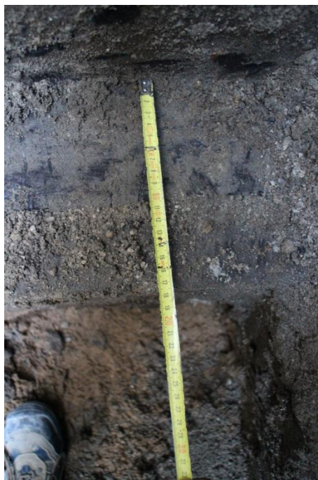
Fot. 2. Odkrywka 1 - ława fundamentowa ściany podłużnej budynku szkoły.
