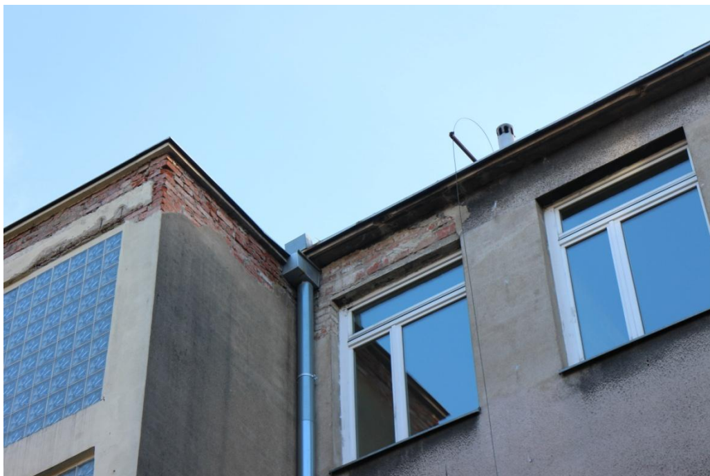
Fot. 26. Ubytki tynku na szczycie ścian klatki schodowej. Widoczne ubytki gzymsu okapowego.
