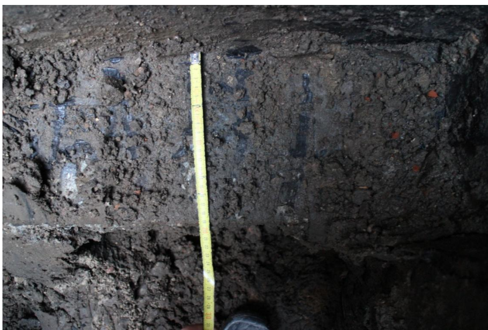
Fot. 3. Odkrywka 2 - łąwa fundamentowa ściany szczytowej.
