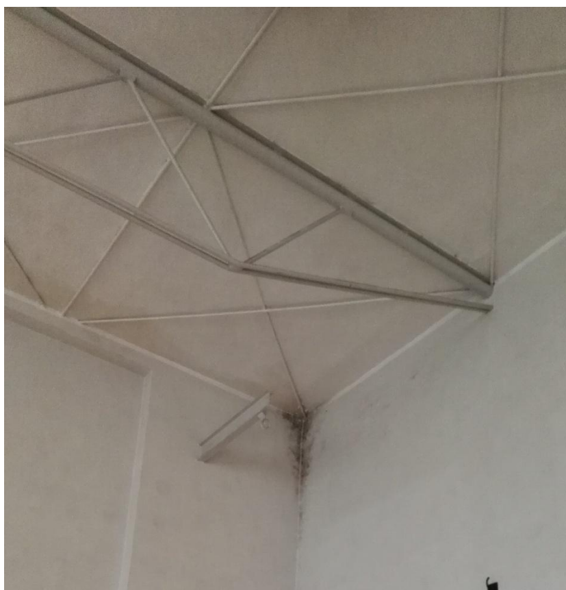
Fot. 30. Narożnik sali sportowej. Widoczne zagrzybienie tynku.
