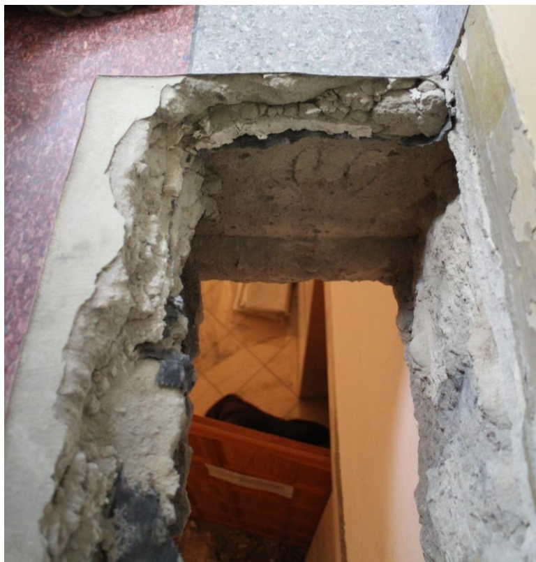
Fot. 10. Odkrywka 8 - strop nad piwnicą w budynku szkoły
