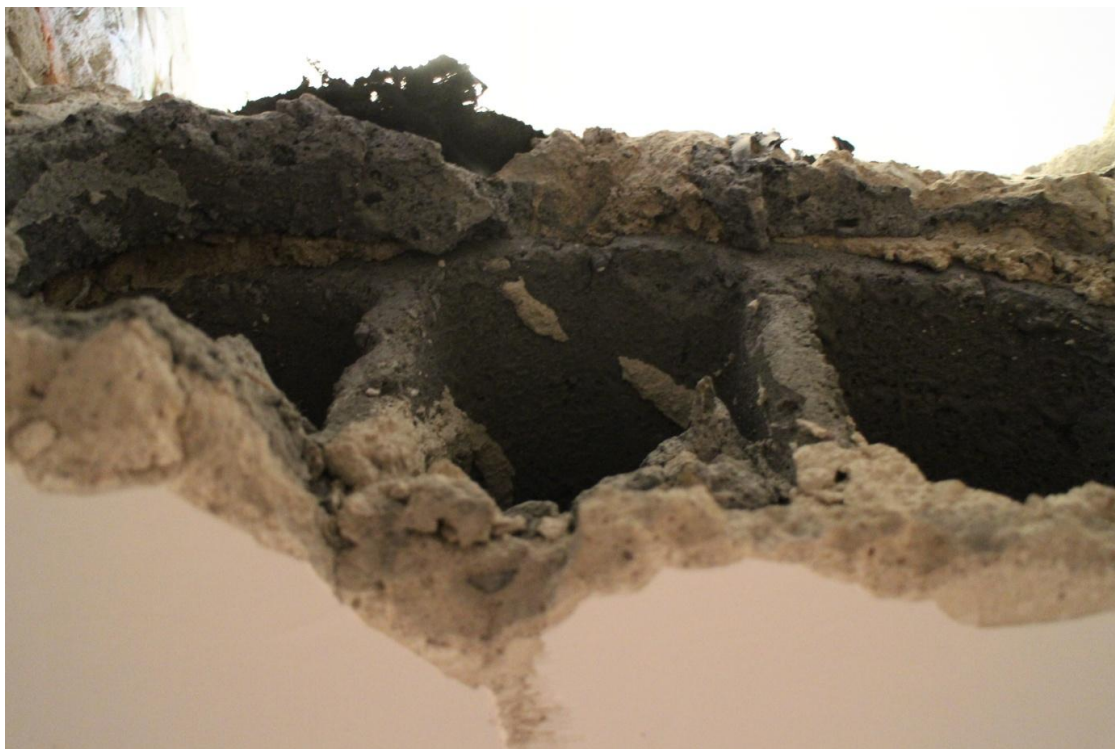
Fot. 12. Odkrywka 8 - strop nad piwnicą w budynku szkoły. Widoczny pustak stropu.
