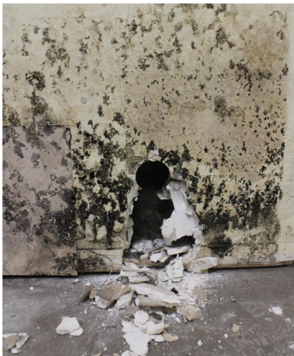
Fot. 29. Przedścianka GK w piwnicy pod salą sportową. Widoczne zagrzybienie okładziny.
