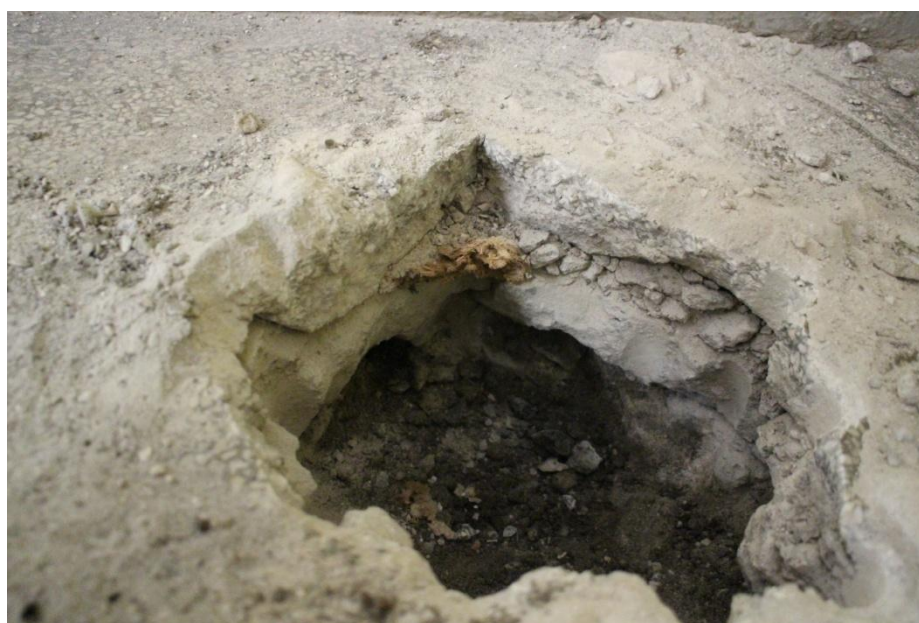
Fot. 7. Odkrywka 5 – warstwy posadzki na gruncie w pomieszczeniu szatni
