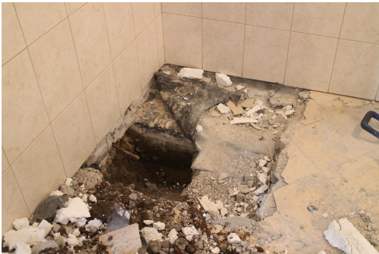
Fot. 6. Odkrywka 4 – ława fundamentowa wewnętrzna budynku szkoły
