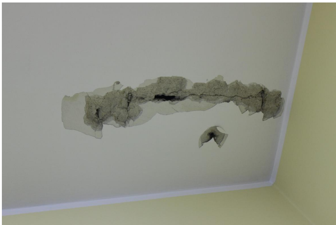
Fot. 13. Strop nad 1 piętrem. Widoczny układ żeber i pustaka stropu DMS.
