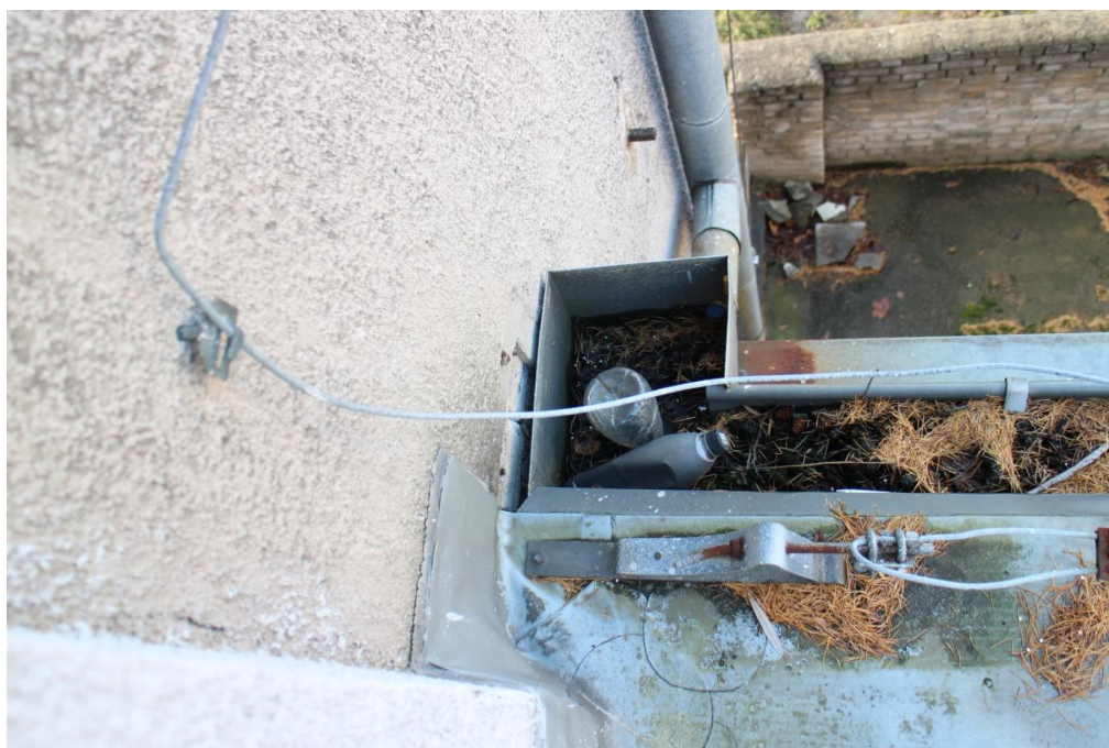
Fot. 23. Dach łącznika. Widoczny zapchany odpływ rynny, ślady korozji opierzenia.
