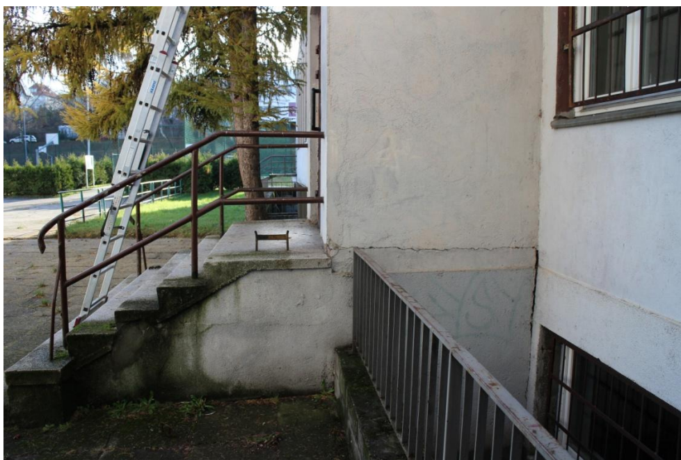
Fot. 25. Schody wejściowe do łącznika. Widoczne spękania poziome i pionowe.
