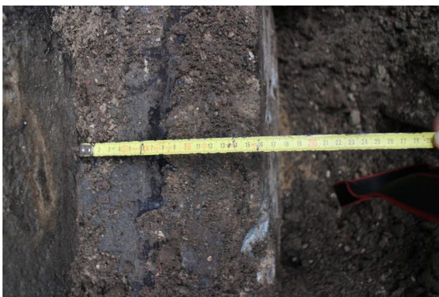
Fot. 5. Odkrywka 3 – ława fundamentowa ściany podłużnej południowej.
