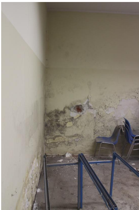
Fot. 18. Ślady zalania w piwnicach pod salą sportową. Widoczne łuszczące się powłoki, grzyb i wykwity.
