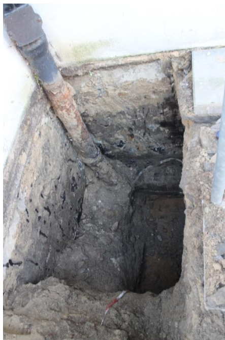
Fot. 1. Odkrywka 1 - ława fundamentowa ściany podłużnej budynku szkoły.
