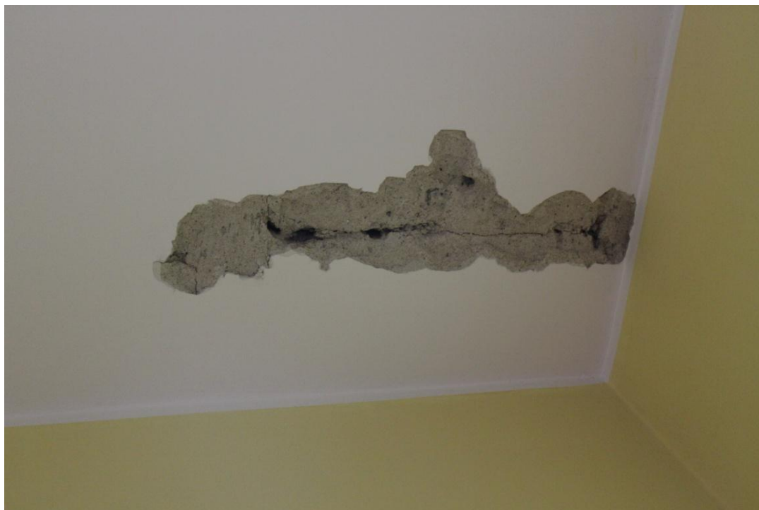
Fot. 14. Strop nad 2 piętrem (stropodach). Widoczny układ żeber i pustaków stropu DMS
