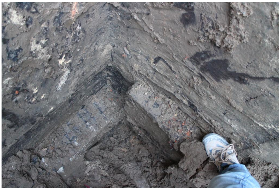
Fot. 2. Odkrywka 2 - łąwa fundamentowa ściany szczytowej budynku szkoły
