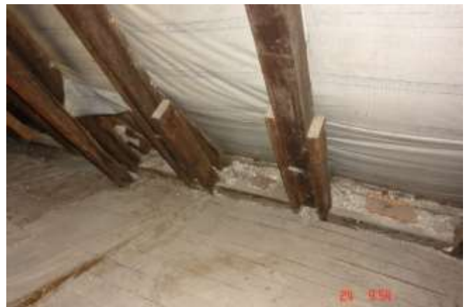
125. Skrócenie krokwi i zastąpienie jej dwustronnymi nakładkami połączonymi gwoździami. Brak śladów deformacji złącza.
