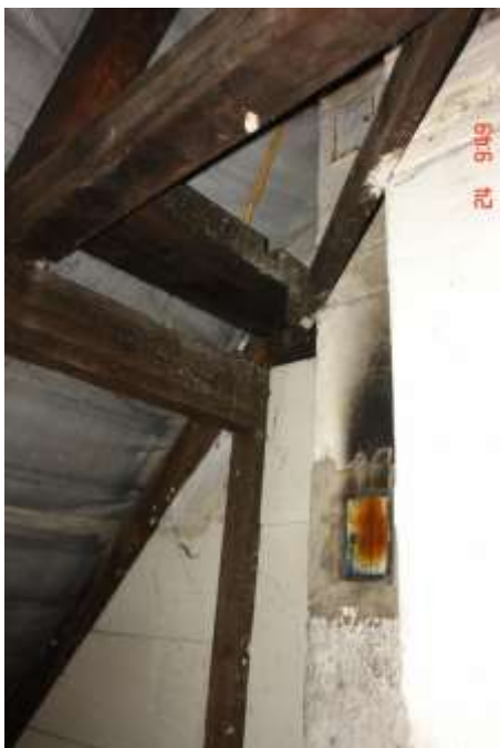
112. Elementy drewnianej więzby dachowej zbyt blisko komina spalinyowego. Nie jest spełniony warunek zachowania bezpieczeństwa ppoż zgodnie z §265.4 Rozp. Min. Z dn 12.04.2002 w sprawie warunków technicznych, jakim powinny odpowiadać budynki i ich usytuowanie. Odległość winna wynosić 0,3 m, gdyż tynk nie jest zbrojony siatką stalową, która pozwala na zmniejszenie odległości do 0,15 m
