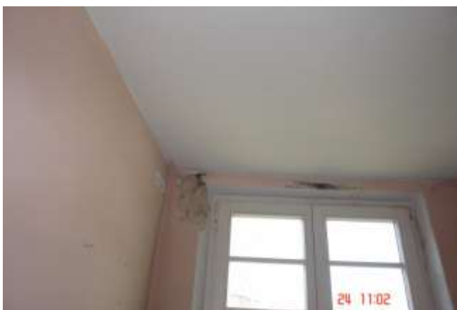
100. Pokryte pleśnią drewniane nadproże z bala o grubości ~5 cm. Wadliwe oparcie nadproża na domurowanej warstwie cegieł
