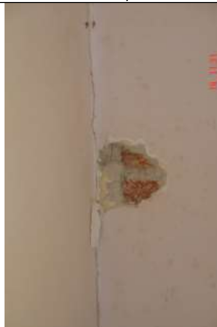
239. Odkrywka styku murów Brak ich wzajemnego przewiązania
