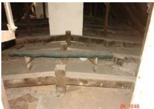
166. Konstrukcja dźwigarów stropowych wstarszej części budynku. Pasy górne z 2x8/18 lub 16,5/18. Wieszak z bala 16,5/18 cm . Pas dolny z bala .....
