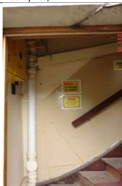
419. Wyłożenie ściany klatki schodowej płytami g-k. Pion kanalizacji sanitarnej wykonanmo z rur żeliwnych
