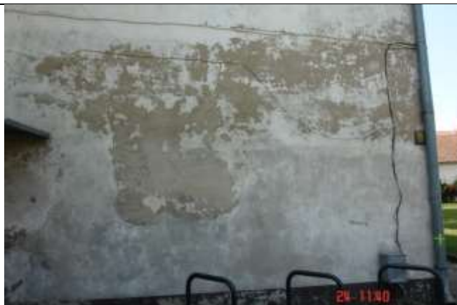
555. Rysy ukośne i pionowe ściany wschodniej dobudówki
