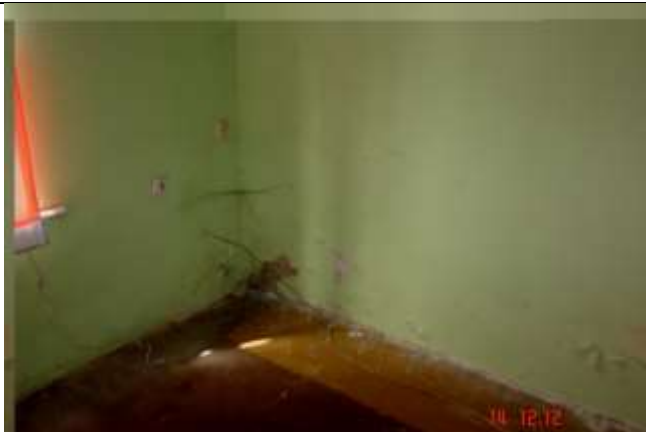
294. Ospojenie farby emulsyjnej od podłoża wraz z tynkiem wskutek ciśnienia pary wodnej z nawodnionej ściany w pasie przypodłogowym
