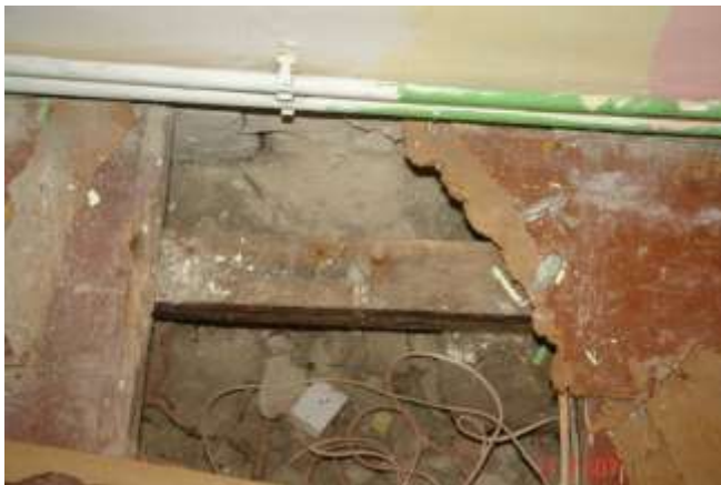
53. Odkrywka w pomieszczeniu nr 9/5. Pod warstwą płyt pilśniowych, twardych gr ` 6 mm ułożono deski sosnowe o gr ~28 mm, mocowane do drewnianych legarów o przekroju 8/10 cm opartych na cłach ułożonych na płask bezpośrednio na gruncie.
