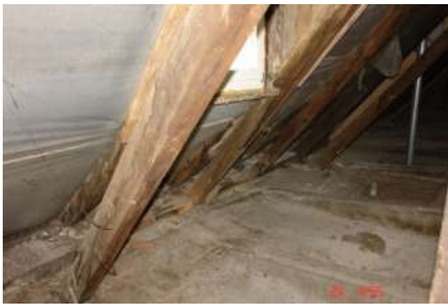
128. Liczne ślady zacieków na elementach konstrukcji więzby w strefie przyokapowej. Nie ma to istotnego wpływu na stan elementów nośnych.
