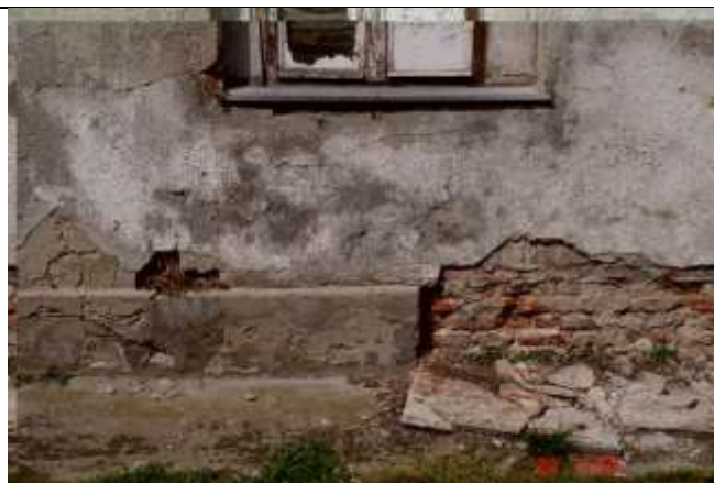
487. Zniszczona okładzina cokołu poniżej warstwy hydroizolacyjnej i ślady zawilgocenia ściany powyżej wskutek jej nieskuteczności.
