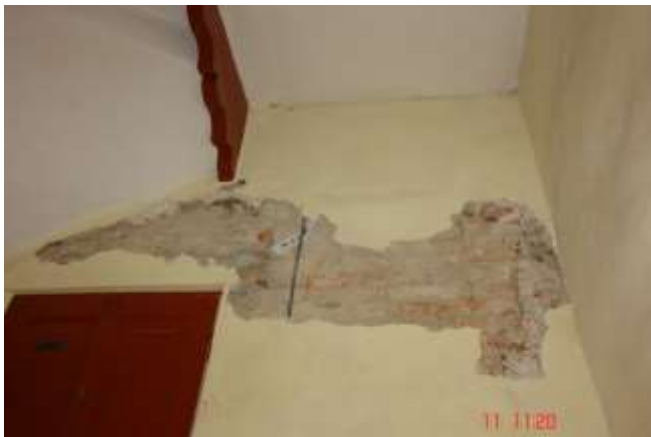
62. Brak przewiązania fragmentu muru. W styku szczelina o rozwarości do 6mm
