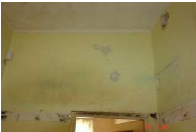
246. Rysy skośne na styku ściany działowej z otworem drzwiowym. Ich kierunek i ułożenie wskazuje na osiadanie ściany. Z lewej rury pionowe
