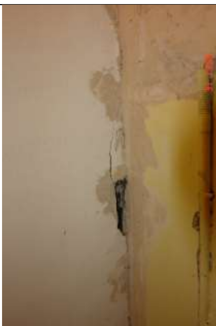
418. Brak należytego przewiązania poomędzy ścianą zewnętrzną a wewnętrznąnnnn. Rysa pionowa na styku ścian.
