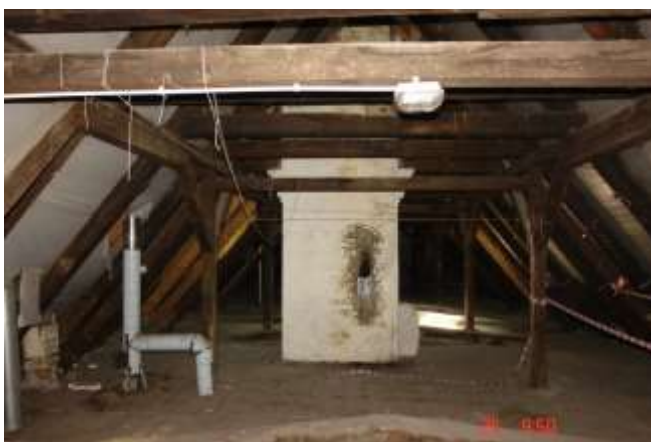
116. Wadliwe odprowadzenie przewodu spalinkowego piecyka gazowego ukłki drewnianej stropu zgodnie z wymogami opisanymi do fot nr 112. Wykraplanie się pary wodnej na elementach stalowych przewodu i liczne ślady wycieków ze skraplacza
