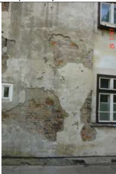
525. Brak przewiązania wstęgu muru w miejscu wypełniania otworów, wysokie podciąganie kapilarne wody gruntowej jak i zalewania wodą opadową przelewająca się przez rynnę.
