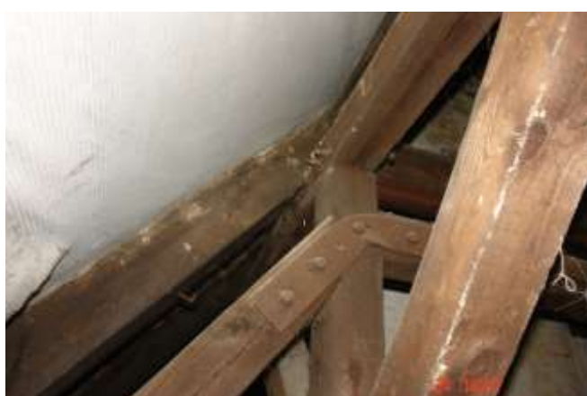
154. Górna płaszczyzna krokwiiporażona grzybem, prawdopodobnie zgorzelą brunatną lokalnie na głębokość ~1 cm.
