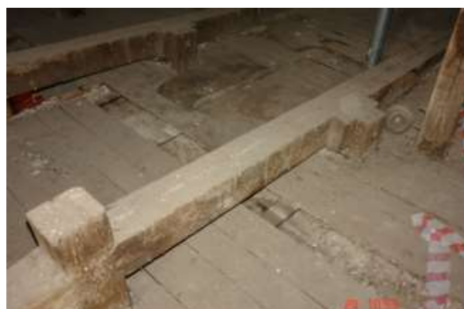
201. Widok belek stropowych ułożonych pomiędzy dźwigarami.
