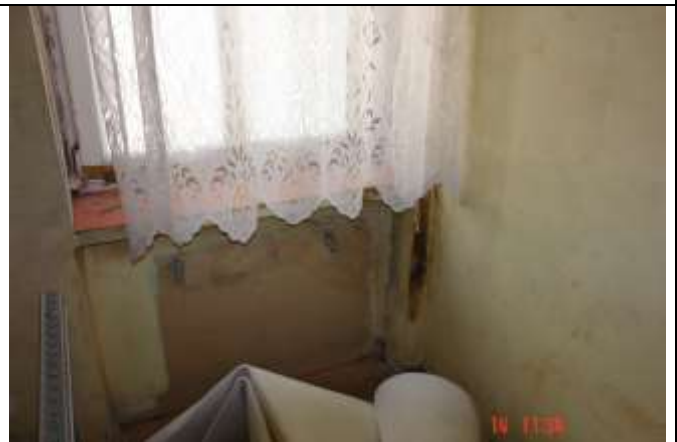
245. Występowanie pleśni na powierzchni tynku. Podciąganie wilgoci w strefie przypodłogowej.
