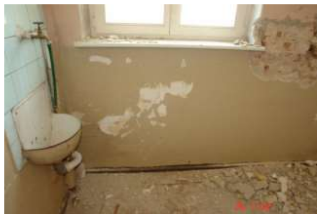
101. Ukośna rysa muru podokiennego, ubytki cegieł w styku filara m/okiennego z murem podokieannym.
