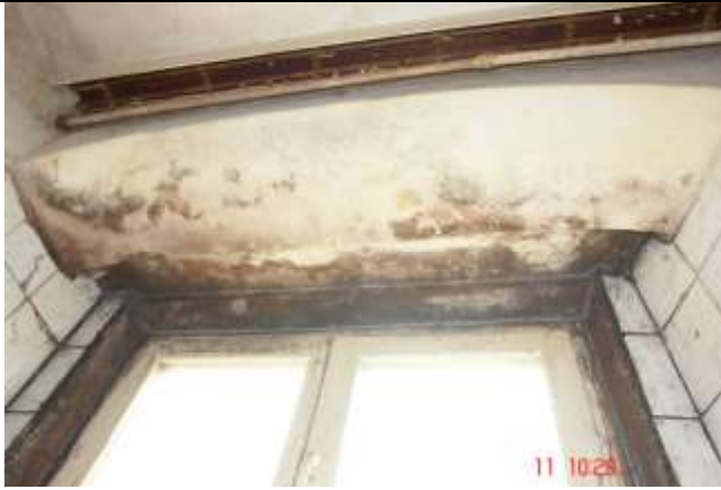
5. Pom nr 8/1, Nadproże ceramiczne, odcinkowe. Na szerokości węgaraka nadproże z bala drewnianego gr. ~5 cm. Część drewniana otynkowana, z wykwitami pleśni.
