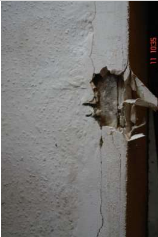
7. Odkrywka przy lewym ościeżu. W większy otwór drzwiowy wmontowano futrynę mniejszego pozostawiając starą drewnianą. Na styku futryn powstały rysy reologiczne
