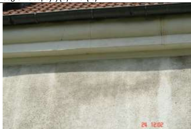
474. Ślady przecieków i nieszczelności obróbek blacharskich okapu. Rysy ukośne gzymsu mające swoją kontynuację na ścianie pochodzące od nierównomiernego osiadania fundamentów oraz pionowe pochodzenia termicznego.
