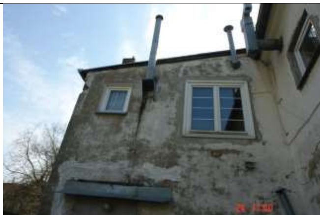
557. Rysy i złuszczenia tynki ściany północnej dobudowanej do dobudówki części budynku
