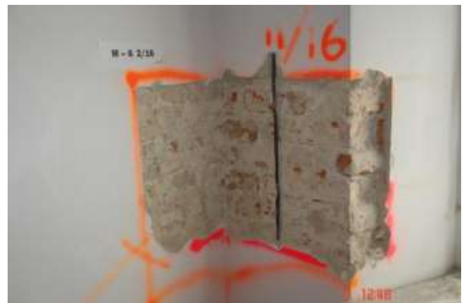
90. Odkrywka naroża ścian podłużnej zewnętrznej i wewnętrznej poprzecznej. Ściana podłużna wykonana z cegły gotyckiej, zaś poprzeczna z „holenderki”. Ściany wzajemnie przewiązane. Stan techniczny bardzo dobry
