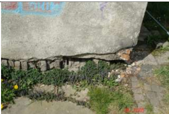
455. Znaczne ubytki muru w styku z betonową opaską-chodnikiem. W narożu ubytki na głębokość do 0,27 m, co zagraża konstrukcji naroża budynku. Ten stan grozi awarią i zagraża za bezpieczeństwem mienia i życia osób przebywających w pobliżu ściany. Stan ten jest skutkiem wpływu podciąganej kapilarnie wody jak i wody opadowej oraz wpływu wysadzin mrozowych.
