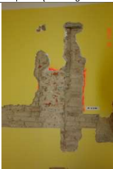
278. Wypełnienie byłego otworu w murze bez przewiązania cegieł w wątku.
