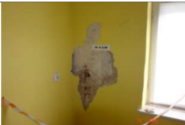
274. Odkrywka ściany zewnętrznej z wypełnieniem otworu bez przewiązania.
