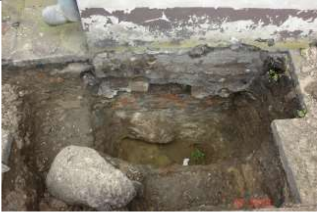
1. Jak wykop sondażowy W2 wg [21]. Kamienna ława z murowanym z cegły ceramicznej cokołem. W podłożu grunty nasypowe z dodatkiem humusu
