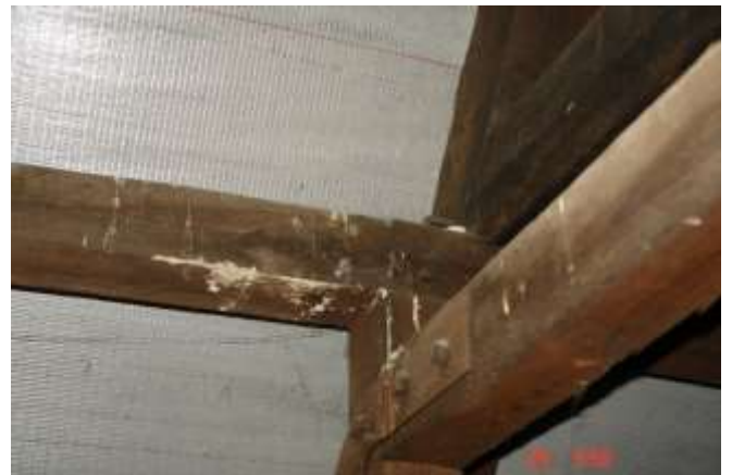
131. Oparcie odcinków płatwi na wieszaku-stolcu. Łączenie na wpust z kołkami dębowymi.
