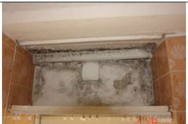
323. Pleśń na tynku i suficie wnęki pozbawionej skutecznej wentylacji.
