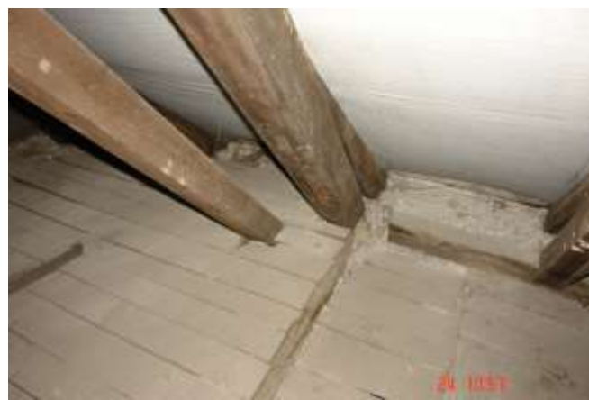
221. Brak ciągłości murbelki
