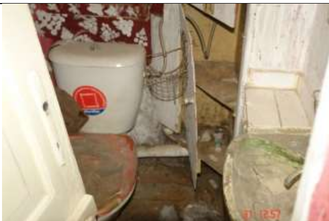
374. Wilgoć i pleśnie w pomieszczeniu sanitarnym
