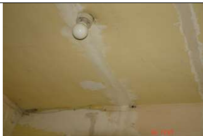
261. Liczne rysy biegnące ukośnie w stosunku do ścian oddanego zmiennym warunkom pracy związanej z różnicą temperatur i wilgotności oraz technicznym zużycie elementów konstrukcyjnych jak i podłoża pod tynkiem.
