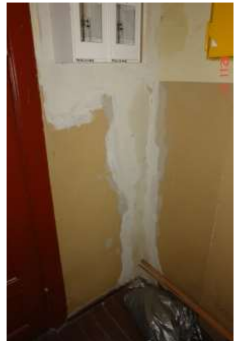
68. Rysa w styku ściany zewnętrznej podłużnej i poprzecznej. Zapewne z powodu braku poprawnego przewiązania muru.
