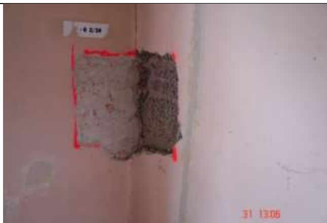
390. Brak przewiązania ścian.
