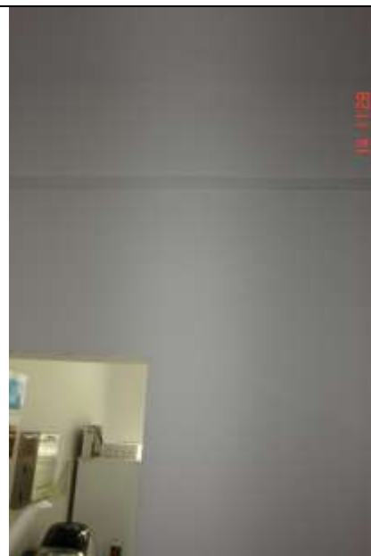
233. Rysa pionowa obok otworu przejścia do drugiego pomieszczenia.
