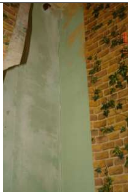
12. Szczelina na styku ściany działowej i nośnej.
