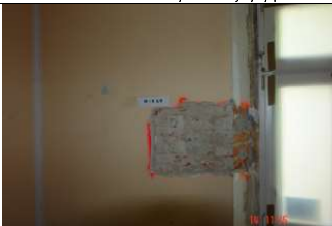
248. Wątek przewiązany w dobrym stanie technicznym
