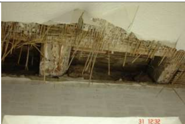
336. Odkrywka stropu . Wilgoć i pleśnie wewnątrz stropu. Deski ślepego [pułapu plesnią i grzybem
