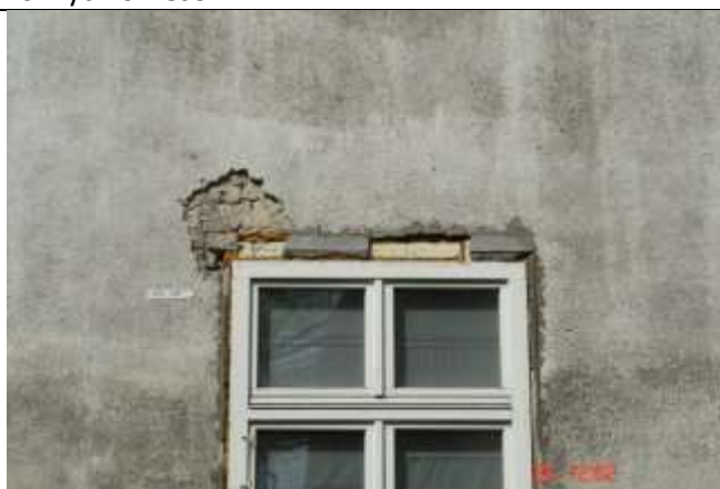
473. Nadprożem ceramicznym a ramą okienną oraz brak podparcia nadproża na murze. Brak odpowiedniego osiatkowania i otynkowania oraz osłony pianki PU i styropianu przed promieniowaniem UV doprowadził do stopniowego utleniania się obu. Uszkodzenie fragmentu muru na długości oparcia nadproża. Cegły są luźne a rysy w spoinach przy podporze świadczą o przekroczeniu wartości granicznej spoiny na ścinanie.
