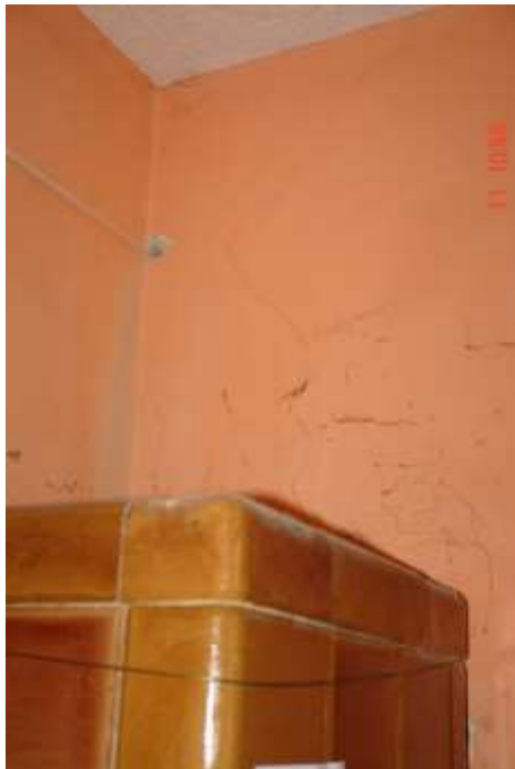
21. Rysy o rozwarości do 1,5 mm na ścianie kominowej. Ponadto liczne rysy o mniejszej rozwarości. Wszystkie pochodzenia termicznego świadczące o występowaniu znacznych temperatur w przewodzie kominowym nad wlotem czopucha. Występuje to często i przy stosowaniu paliw stałych wysokoenergetycznych np. koksu.
