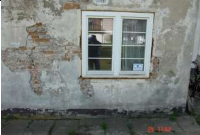
547. Liczne szczeliny w nierównomiernie osiadających ścianach i brak przewiązania w murze
