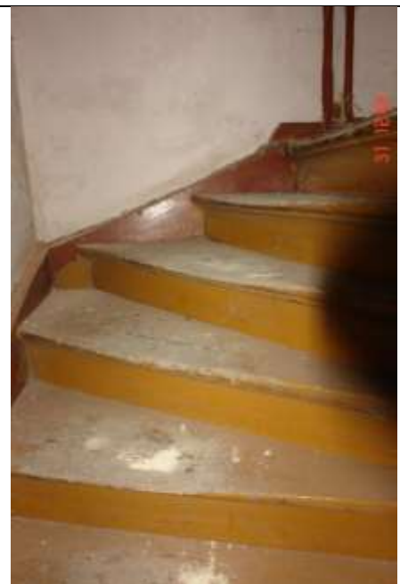
355. Znacznie zniszczone stopnice schodów.
