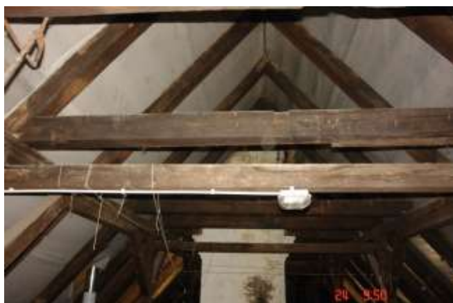
108. Widok jętki i rozpóra Stan techniczny dobry.
