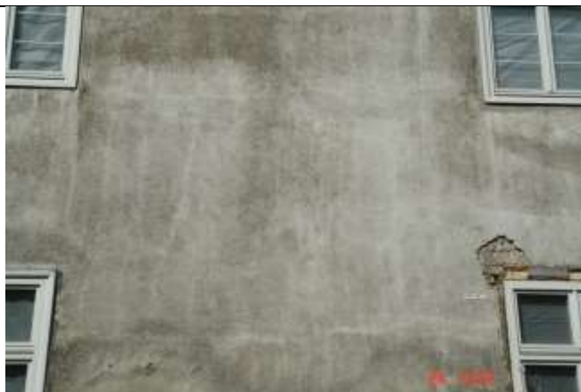
475. Rysy ukośne na całej wysokości ściany.
