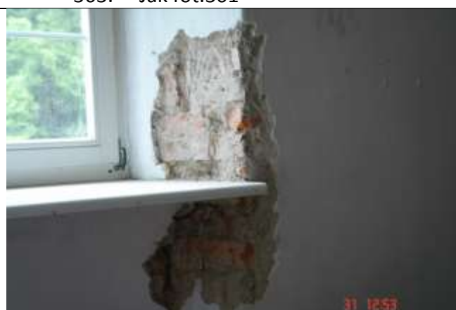
365. Wadliwie wymurowany fragment ościeża
