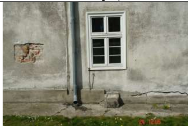
460. Rysa ukośna na tynku i szeroka szczelina w murze pod tynkiem. Rysa wskazuje na osiadanie fundamentu budynku. Osiadanie okładziny cokołu, który oderwał się od reszty muru
