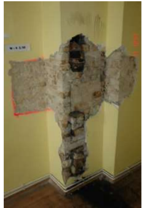
96. Widok ściany kominowej z dużą ilością szczelin. Wyraźne ślady jego nieszczelności.
