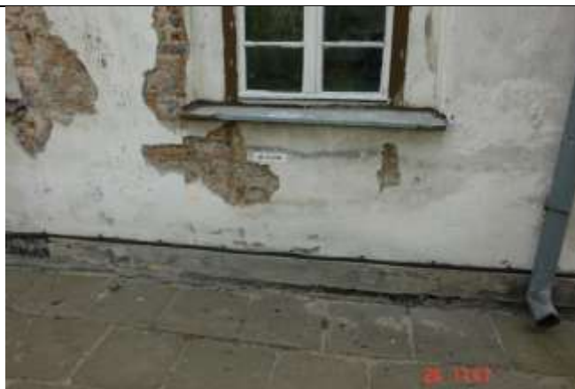
522. Brak przewiązania cegieł w wypełnieniach murem otworów
