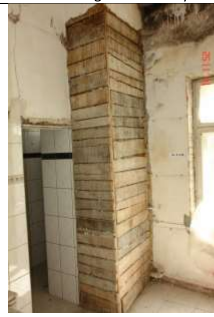
265. Widok ściany działowej wykonanej z bloczków gazobetonowych
