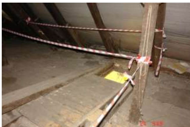
106. Widok odkrywki stropu pomiędzy dźwigarami stropowymi przy ścianie zewnętrznej południowej. Część dźwigarów wykonano z rozsunięciem elementów krokwi a część z elementami na styk.
