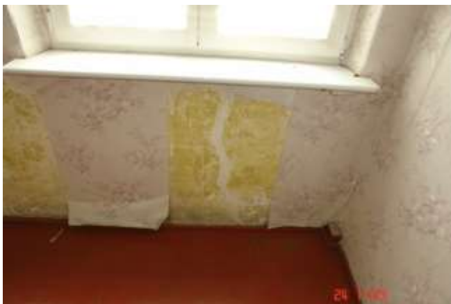
98. Rysa pionowa ściany podokiennej
