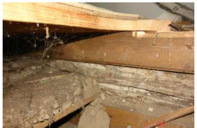
70. Widok odkrywki z fot 69. Konstrukcja stropu typu „ślepy pułap”. Rozstaw belek od 55-100 cm. Belki o przekroju 28/34 cm
