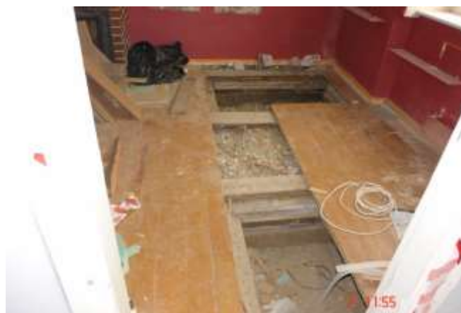
72. Odkrywka strpu w pom nr 10/6. Konstrukcja drewniana, „ślepy pułap”. Rozstaw od 100-116 cm. Belki o przekroju 28/34 cm
