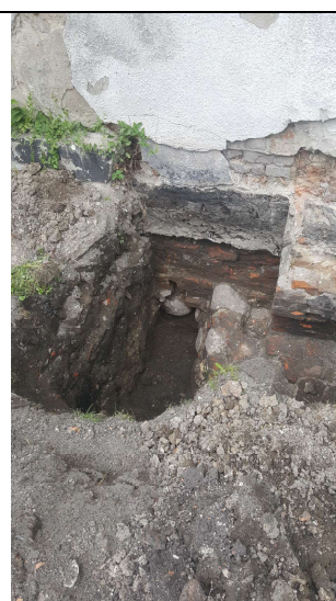
Fot. Odkrywka fundamentu w PD części budynku głównego na styku z dawną zakrystią
