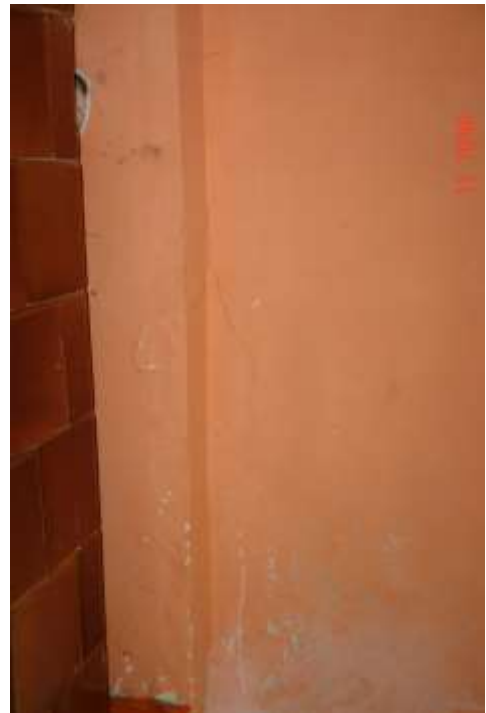
22. Rysa pionowa biegnąca wzdłuż pilastra komina. Przyczyna jak poprzednich fotografiach.
