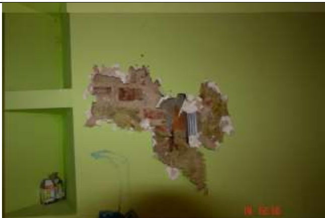
300. Mur pokryty płytami g-k. Pod płytami silnie nawodniony mur. Wełna mineralna pod łytami silnie zawilgocona. Przestrzeń pomiędzy płytami g-k a murem nie jest zwentylowana
