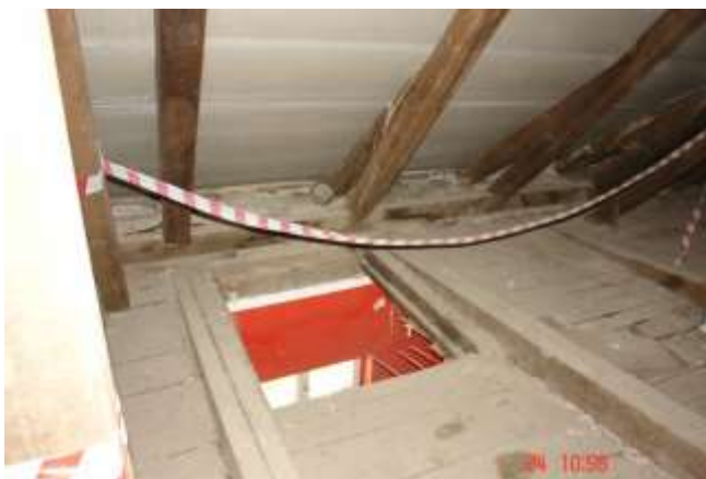
218. Odkrywka stropu przy ścianie zewnętrznej, pomiędzy dźwigarami wieszakowymi stropu poddasza. Widok oparcia krokwki pośrednich na dźwigarze na podporze.
