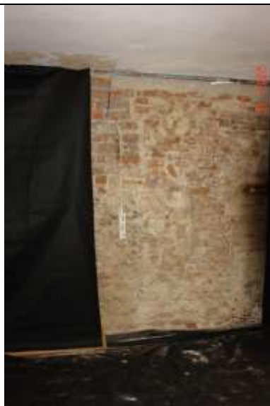
412. Brak przewiązania pomiędzy wypełnieniami wykonanymi w różnych okresach. Nad byłym otworem pozostawiono drewniane nadproże z bala gr ~5 cm
