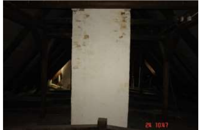
169. Widok murowanego z cegły pełnej komina z przesiąkami skroplonej pary wodnej i wód opadowych.
