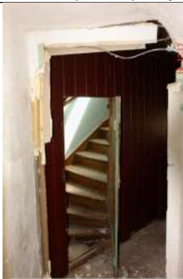
301. Znacznie zużyte stopnice schodów wejściowych na piętro.
