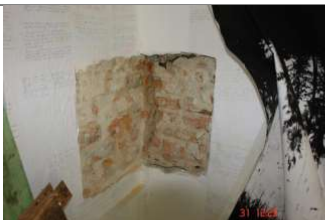
330. Brak przewiązania ścian
