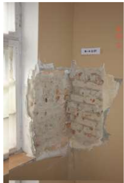
82. Odkrywka styku ścian. Brak należytego przewiązania ścian.
