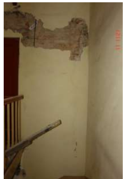
64. Widok skutków braku przewiązania muru i powstałą na styku szczelinę biegnącą przez całą wysokość kondygnacji.
