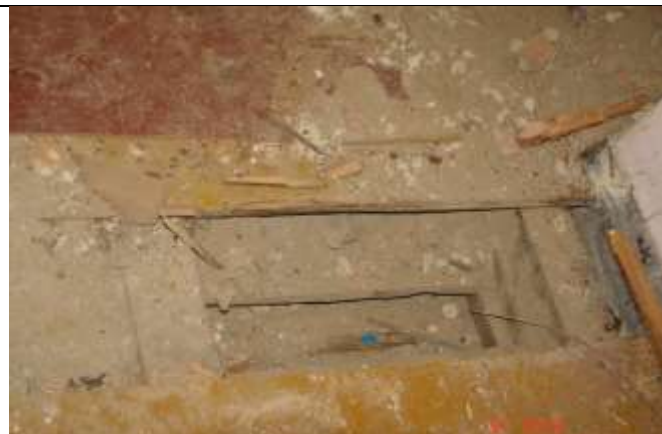
401. Porażone grzybem deski sufitowe pod deskowaniem ślepego pułapu
