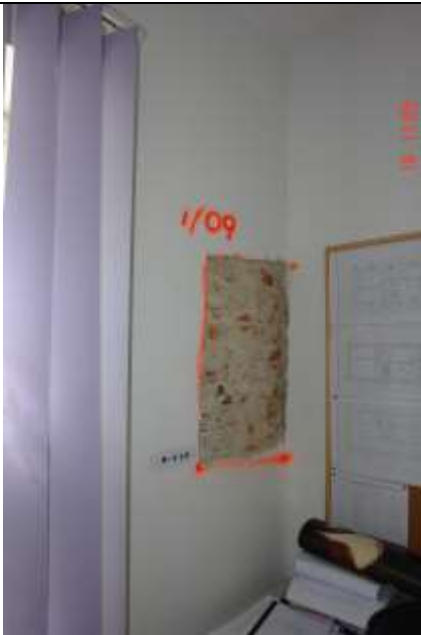
228. Odkrywką wążku muru zewnętrznego i działowej wykonanej z płyt g-k
