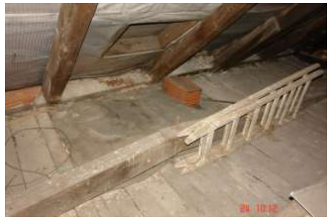
163. Zbyt niskie usytuowanie wylazu dachowego
