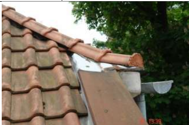
443. Skorodowana i wadliwie wykonan obróbka blacharska. Zbyt krótkie zakłady blach brak prawidłowego fartucha nadrynnowego i obróbki naroża gzymsu
