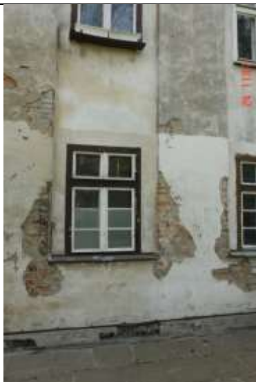
523. Wysoki poziom podciągania wody w murze . Złuszczenia i odpadanie tynku.
