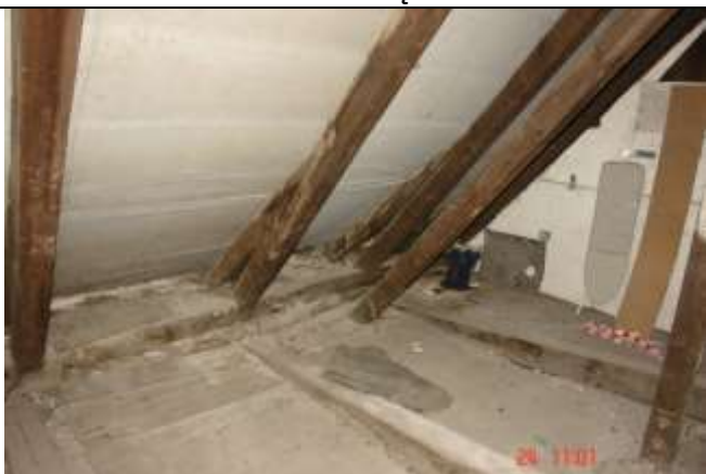
224. Zróżnicowane wymiary przekroju poprzecznego krokwi. Ubytki drewna w miejscu oparcia krokwi na murze
