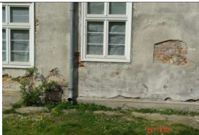
476. Odpadający tynk, wilgoć i złuszczenia lica cegieł.
