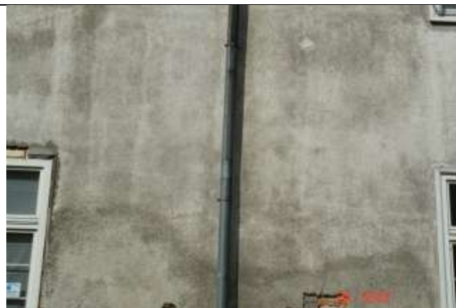
470. Rysa pozioma pomiędzy otworami okiennymi na wysokości nadproży. Rysa pionowa .
