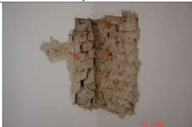
433. Brak przewiązania murów i widoczna różnica ich poziomów na przesuniętych wzajemnie spoinach. I oderwaniu jej dolnej części wskutek różnicy osiadania fundamentów
