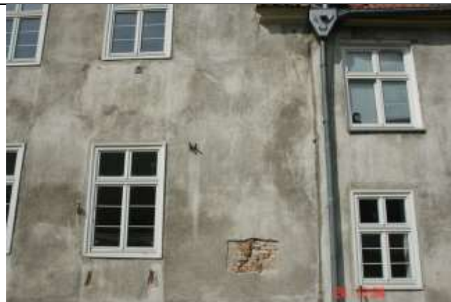
462. Jak fot. 460 . Dodatkowo z lewej rysy pionowe pod oknem i ukośne nad oknem biegnące do spodu otworu okiennego na piętrze
