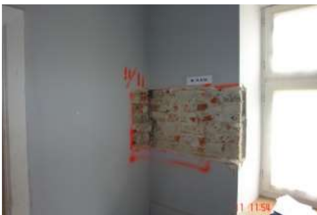
71. Widok wątku muru wraz z narożem ścian zewnętrznej i poprzecznej. Brak wymaganego przewiązania pomiędzy ścianami. Szroka szczelina pomiędzy nimi w styku. Stan muru dość dobry.
