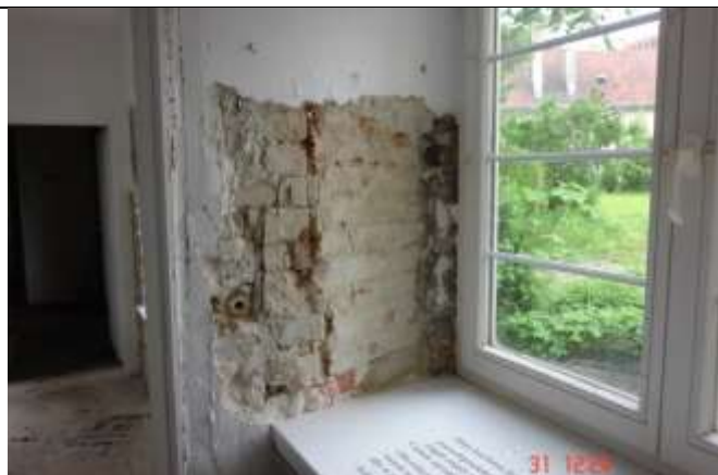
321. Brak należytego przewiązania muru ościeża z filarem międzyokiennym.
