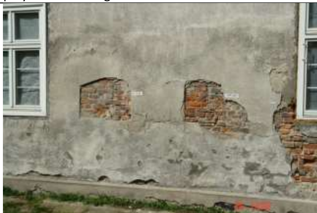
471. Jak fot. 469 oraz liczne ślady przemurowań z różnych okresów
