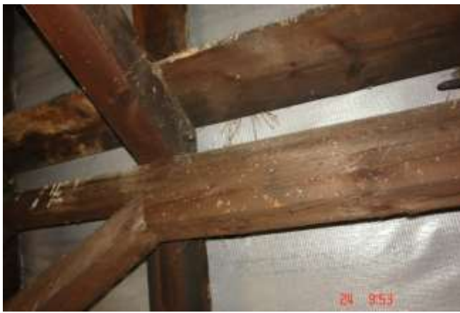
122. Połączenie jętki z krowią pośrednią. Kołek dębowy \sim \phi 20
