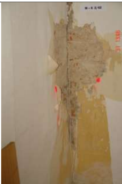
440. Brak przewiązania ścian.
