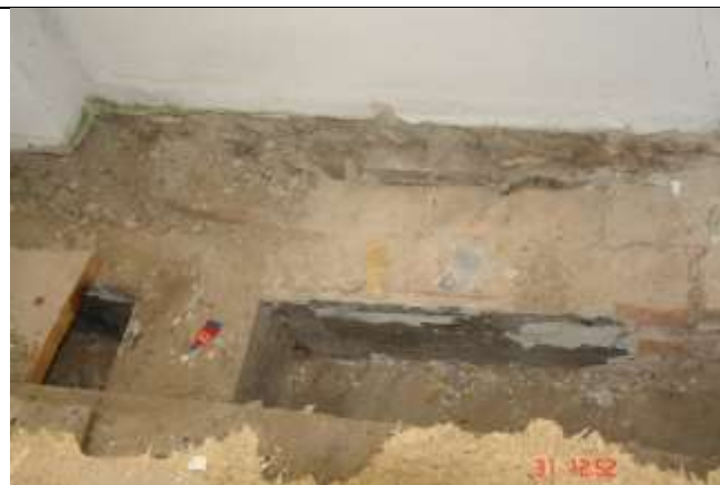
361. Oparcie belek stropowych na murze na głębokość \frac{1}{2} cegły Stan belki dość dobry.
