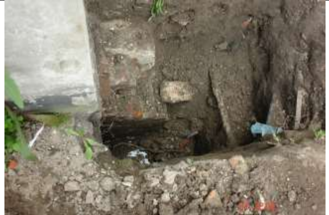
2. Jak wykop W4 wg [21]. Ława z cegły ceramicznej. W podłożu grunty nasypowe z dodatkiem humusu.
