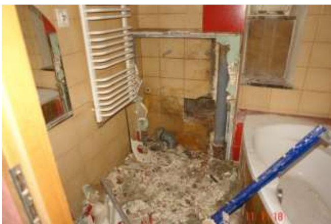
59. Silne zawilgocenie ściany zewnętrznej w strefie przyposadzkowej.
