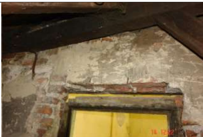
314. Rysy na nadprożu ceramicznym, liczne uszkodzenia ościeża otworu drzwiowego. Ubytki nadproża.
