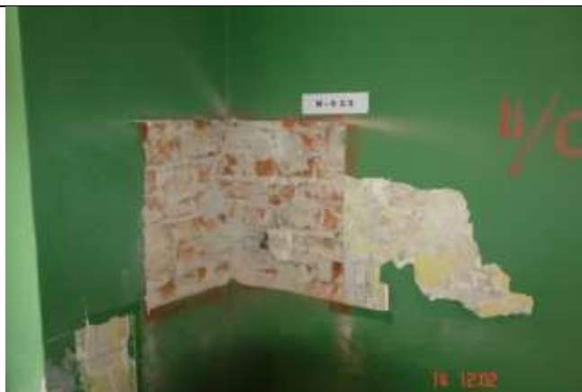
288. Mur w dobrym stanie technicznym. Ściany przewiązane.
