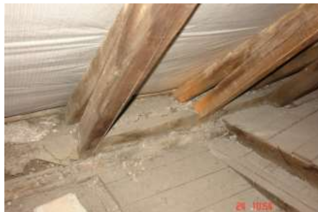
203. Brak prawidłowych zakładów membrany
