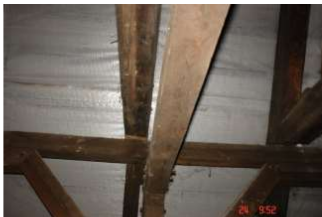
119. Skręcenie krokwi oparcia poprzez zastosowania klina drewnianego
