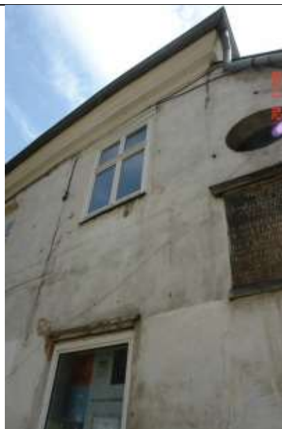
510. Pionowa szczelina pomiędzy dobudówką a budynkiem głównym
