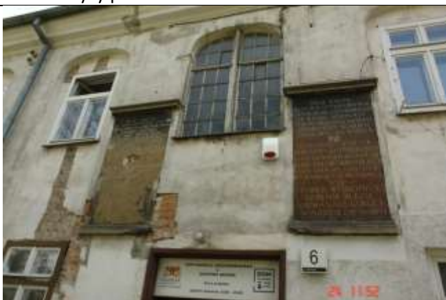
519. Rysy ukośne muru międzyokienne. Sam mur w dość dobrym stanie
