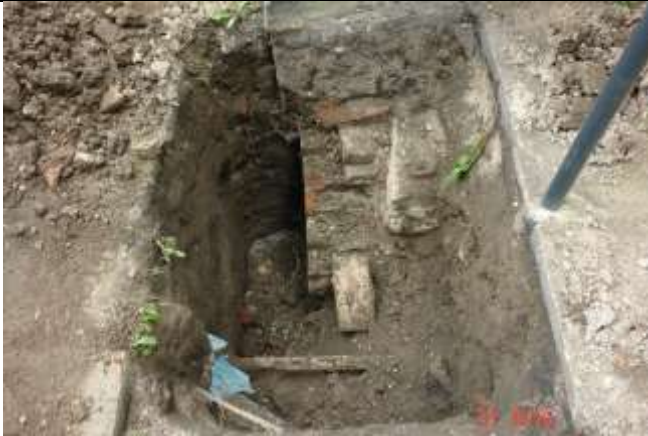
3. Jak wykop W4 wg [21]. Ława z cegły ceramicznej na zaprawie wapiennej. W podstawie grunty nasypowe z zawartością gruntów organicznych. W dnie wykopu zw. wody gruntowej.
