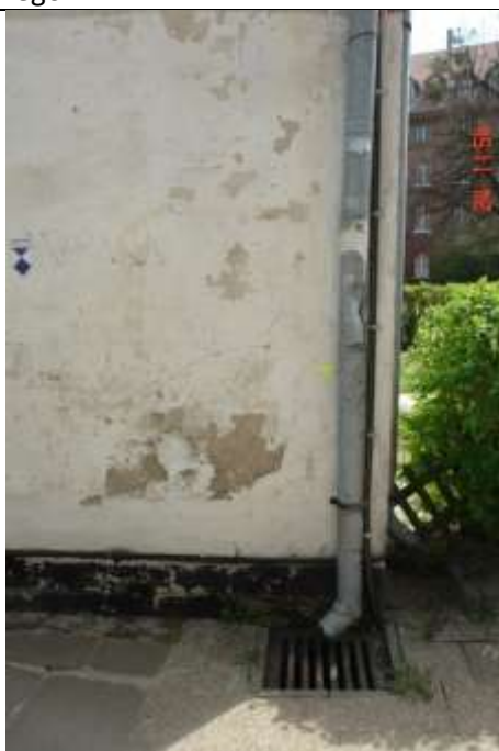
507. Rysa pionowa przy narożu muru przy studzińce spustowej rury z rynny. Istnieje prawdopodobieństwo nieuszczelności studzienki i wypłukiwania okresowego pyłów z podłoża gruntu pod fundamentem, co stopniowo wpływa na obniżenie parametrów i stopniowe osiadanie fundamentu.
