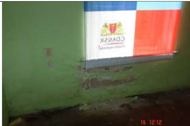
293. Silnie nawodniony mur podokienny wskutek intensywnego podciągania kapilarnego wód opadowych i gruntowych oraz nieszczelności parapetu zewnętrznego
