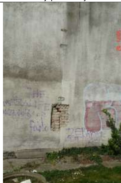
456. Szczelina wzdłuż wadliwie wykonanego styku dylatacyjnego murów wzniesionych w różnym czasie.
