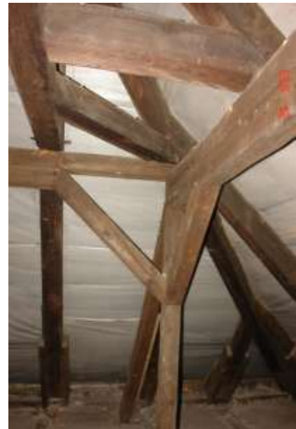
141. Jak fo 135, konstrukcja siodła wraz z mieczem. Stan techniczny dobry
