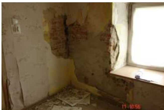
35. Duża szczelina z ubytkami na styku wewnętrznej, poprzecznej ściany konstrukcyjnej i podłużnej ściany zewnętrznej budynku. Brak przewiązania wątków muru. Zawilgocenie i wykwitoty pleśni na murze zewnętrznym w strefie przypodłogowej i styku ościeża z parapetem.
