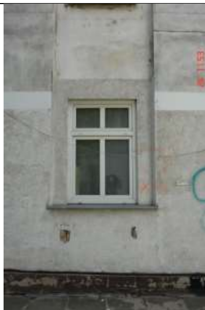
516. Brak przewiązania pomiędzy murem wypełniającym a ościeżem otworu.
