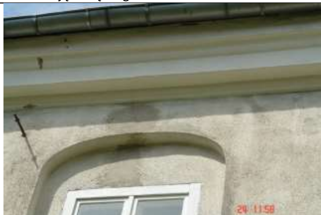
491. Rysa pionowa nad nadprożem okna. Poniżej rysa zarzucona zaprawą cementowo-wapienną
