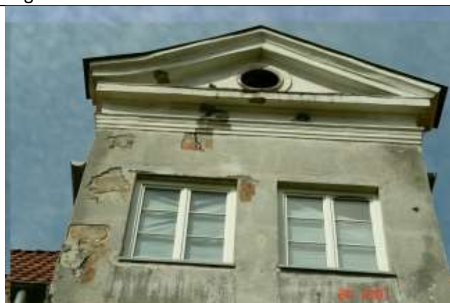
477A. Szczeliny i rysy muru i gzymsów ściany frontonu. Widoczny wpływ czynników atmosferycznych jak i oddziaływania nierównomiernego osiadania fundamentów generującego w konstrukcji więźby dachowej nierównomierny rozkład sił mogący prowadzić do ich lokalnej koncentracji i przyrostu wartości. W tym przypadku sił poziomych. Rysy w poziomie oparcia więźby są wynikiem braku poziomego, ciągłego elementu w koronie muru w postaci np. wieńca .
