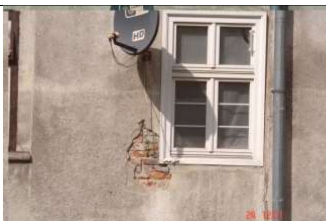
478. Brak należytego przewiązania cegieł poszczególnych warstw muru
