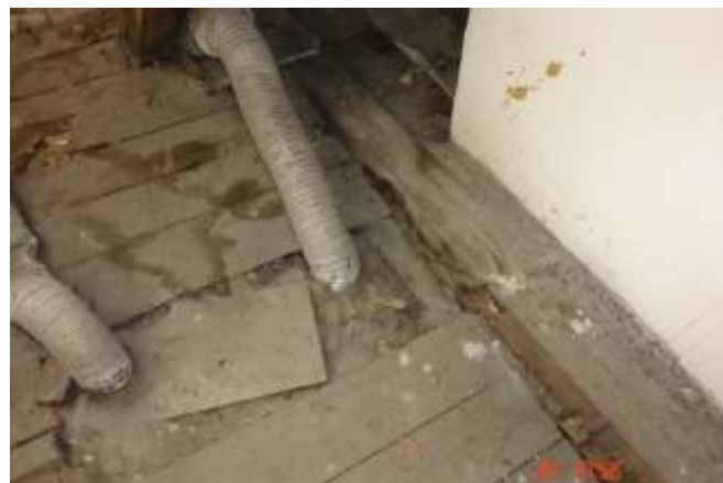
197. Wadliwe przejście kanałem – przewodem przez strop drewniany. Nie są spełnione elementarne wymagania ochrony przed pożarem. Ponadto elementy drewniane porażone grzybem
