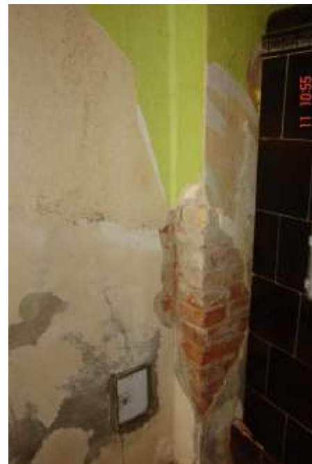
34. Strefa zaniku silnego zawilgocenia ściany konstrukcyjnej i komina. Wysokość podciągania kapilarnej wody wynosi od \sim 0,3-0,8 m. W dolnej części, zawilgoconej, muru lico cegieł w części złuszczone.
