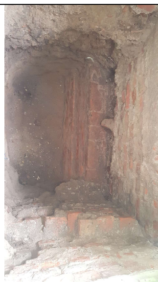
Fot. Odk. fund. śc. wew. z śc. prostop. wew. – wid. wykrec. fund. w str. dawn. kanału Raduni
