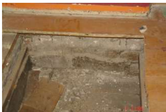
74. Belki stropowe osadzone ciasno w ścianie zewnętrznej
