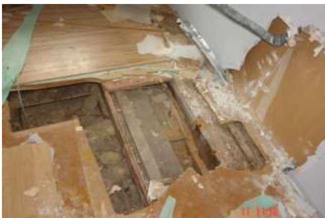
69. Odkrywka stropu w pomieszczeniu nr 10/4. Ślady wyrównywania ugięcia belek stropowych, pod deski podłogowe, poprzez dobicie do belek wypoziomowanej deski.
