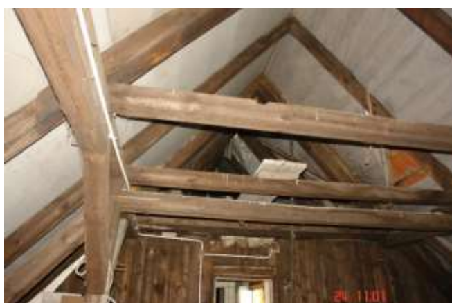
110. Widok górnej części więźby w kierunku drzwi wejściowych. Widok złącza krokwi na podparciu na płatwi.
