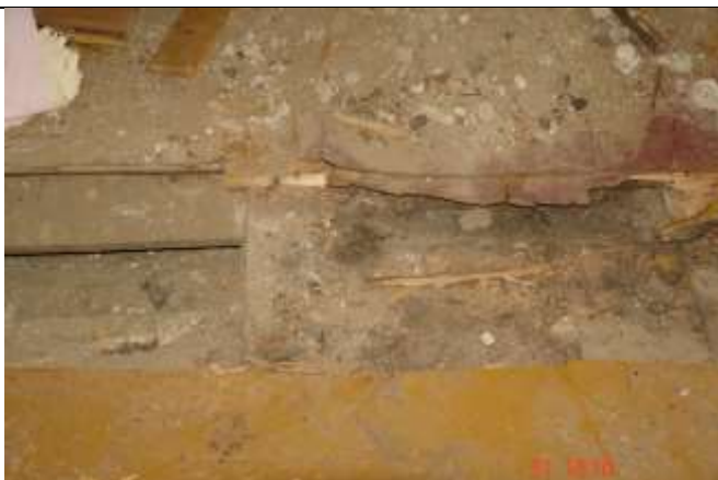
398. Deski podłogowe pod płytami pilśniowymi, twardymi, zbutwiałe w rejoinie urządzeń sanitarnych i kuchennych
