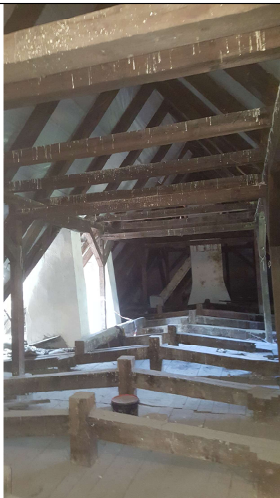
Fot. Belki ustroju wieszakowo -zastrzałowego na poddaszu – strefa zachodnia
