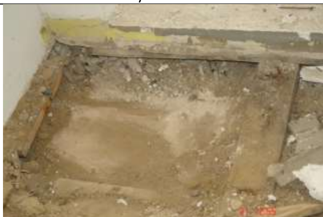
370. Odślonięcie deskowania ślepego pułapu. Zasyпка składa się z gliny , gruzu, piaskicznym stanie technicznym
