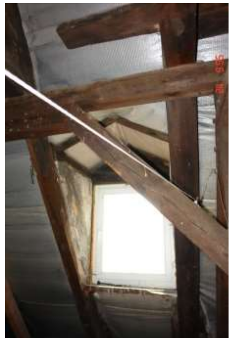
129. Ściany bocznej lukarny ze śladami przemarzania
