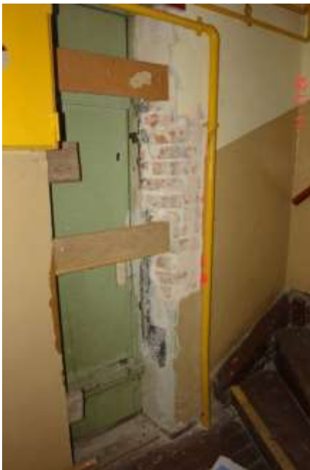
67. Odkryte ościeża otworu drzwiowego. Stan techniczny muru dobry.
