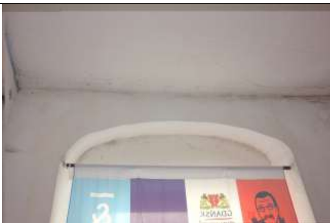
298. Nętrznej. Rysa ;owstała wskutek ugięcia konstrukcji stropu.
