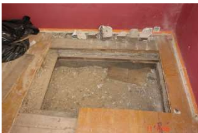
73. Konstrukcja stropu typu „ślepy pułap”. Belki z bala o przekroju 28/34 w rozstawie co \sim 1,1-1,2 m. Na belkach ułożono łaty wyrównawcze co \sim 0,3-0,6 m, na których zamontowano deski podłogowe gr \sim 3 cm. Na pierwszej warstwie desek z drewna iglastego ułożono wierzchnią podłogę z desek o gr \sim 2,5 cm.
