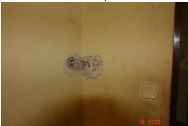
250. Rysa pionowa w styku ścian. Brak przewiązania pomiędzy ścianami
