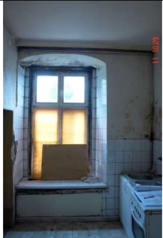
6. Widok ściany z otworem okiennym w po. 8/1. Na tynku występują liczne wykwity pleśni.
