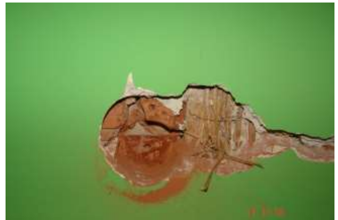
54. Odkrywka ściany działowej oddzielającej klatkę schodową. Ściana o konstrukcji szachulcowej. Słupki z drewna iglastego o przekroju 12/12 cm, rygle 13/13 cm , wypełnienie cegłą pełną ceramiczną na zaprawie wapiennej. Elementy drewniane pokryte przed tynkowaniem matą z trzciny
