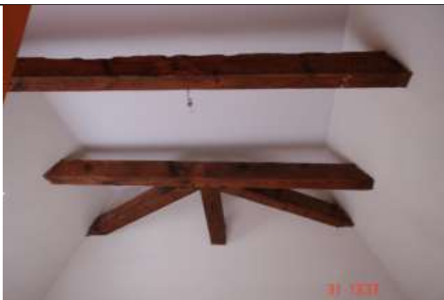
428. Widok fragmentu więby dachowej o ustroju jętkowym z dachem naczółkowym.
