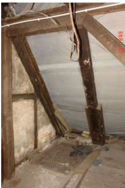
102. Ślady napraw drewnianej konstrukcji więzby dachowej poprzez wymianę końcówek przyokapowych krokwi lub dobiecie deski podpierającej łąty w miejscu uszkodzonej przypustnicy.
