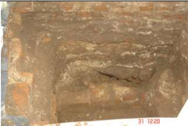
5. Jak wykop W10 wg [21]. Ława z gruzu na zaprawie wapiennej obmurowana cegłą pełną ceramiczną na zaprawie wapiennej. Posadowienia na gruntach nasypowych z dodatkiem gruntów organicznych
