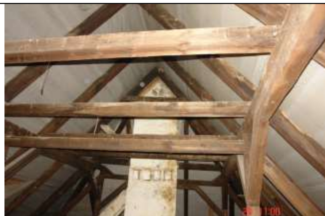
223. Ubytki górnej płaszczyzny krokwi zniszczonej przez owady i grzyb
