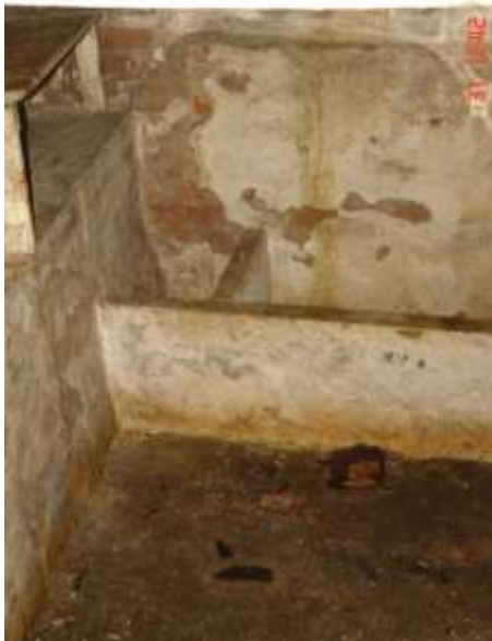
350. Silnie zawilgocone ściany piwnic. Ściany są pozbawione warstw hydroizolacyjnych .
