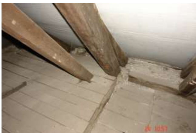
216. Brak ciągłości murbelki
