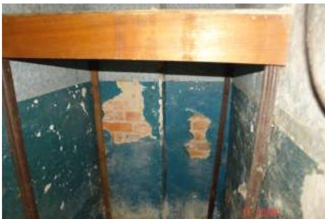
17. Silne zawilgocenie ściany. Pokrycie tynku farbą olejną w znacznym stopniu utrudnia swobodne odparowanie wilgoci. W konsekwencji skutkuje to odpadanie tynku od murowanej z cegły pełnej ceramicznej, ściany konstrukcyjnej.
