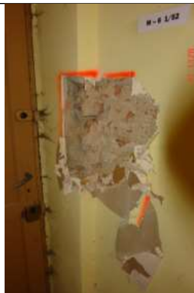
417. Dość dobry stan wątrku muru zewnętrznego i wewnętrznego w odkrywce,
