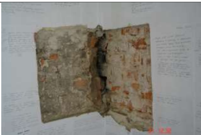
334. Brak przewiązania ścian . Szczelina o znacznej rozwarości
