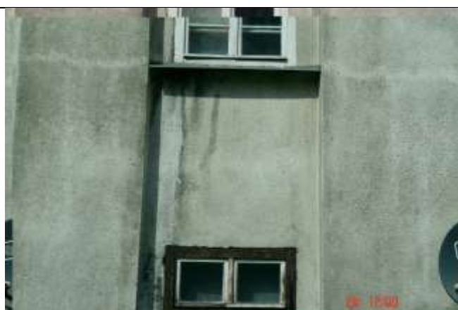
479. Rysa ukośna biegnąca pomiędzy lewym górnym narożnikiem otworu okiennego, do prawego dolnego okna powyżej.
