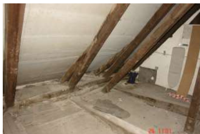
111. Oparcie ktkowi pośredniej na murze i belce zastrzału w stosunku do konstrukcji nośnej
