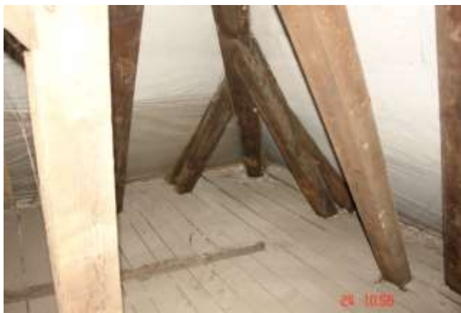
214. Naroże więzby dachowej. Drewno i połączenia w dość dobrym stanie
