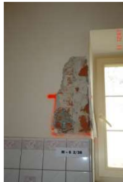
88. Odkrywka muru w pom. nr 11/3. Wiodok domurowanej warstwy cegieł na stojąco zmniejszający światło otworu okiennego.
