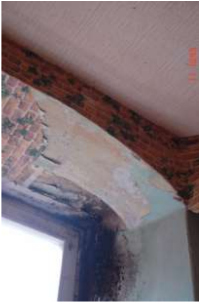
15. Pomiędzy ościeżami otworu okiennego nadproże ceramiczne z cegły pełnej na zaprawie wapiennej, odcinkowe. Nad przestrzenią nadwęgarkową bal drewniany o gr ~5 cm. W narożach silne zawilgocenie muru oraz drewna z wykwitami pleśni.
