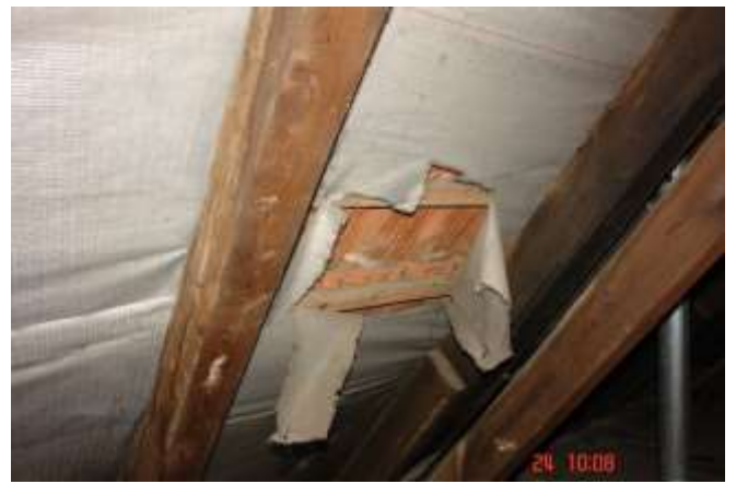
157. Folia przeciwwiatrowa przylega bez[pośrednio do ła, na których ciasno ułożono dachówki. Brak szczeliny wentylacyjnej pomiędzy łatą a folią.
