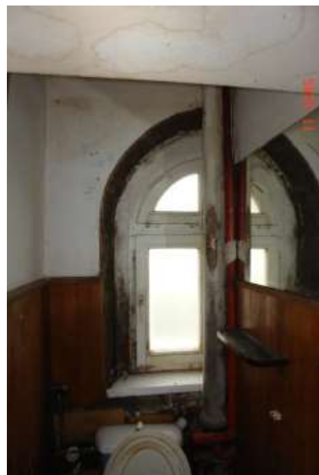
18. Otwór okienny w pomieszczeniu w.c zarówno murowane ościeże jak i drewniana stolarka okienna pokryte pleśnią.
