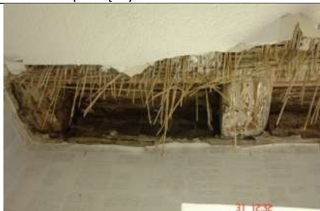
335. Odkrywka stropu . Wilgoć i pleśnie wewnątrz stropu. Deski ślepego [pułapu plesnią i grzybem
