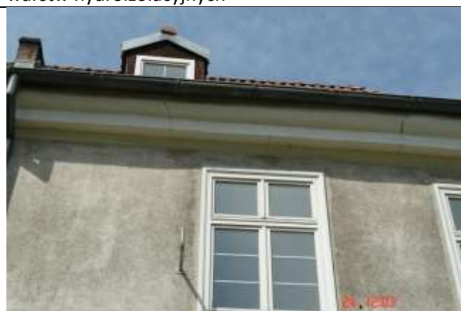
468. Rysy pionowe i ukośne gzymsu i muru nadokiennego.
