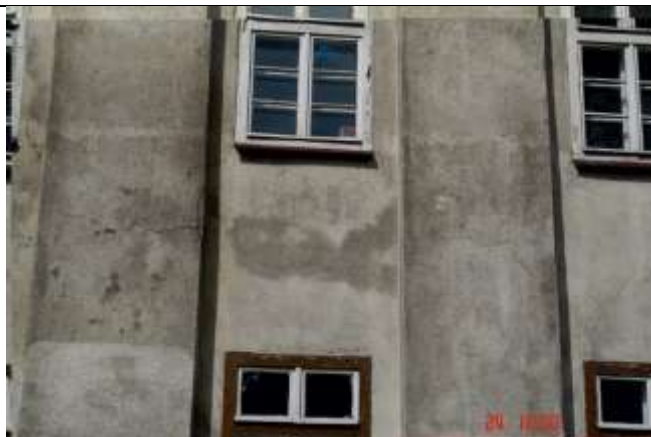
484. Szczeliny poziome na pilastrach międzyokiennych
