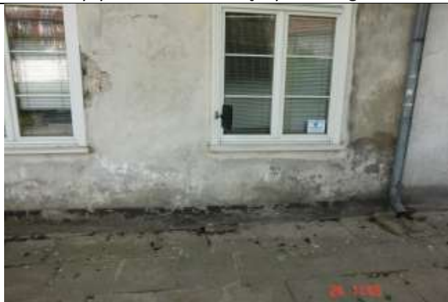
533. Ślady intensywnego podciągania wody gruntowej
