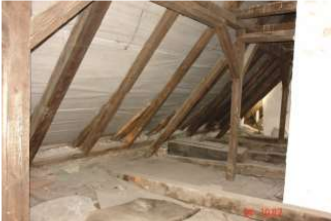
168. Zmiana sposobów połączeń. Brak drewnianych kołków
