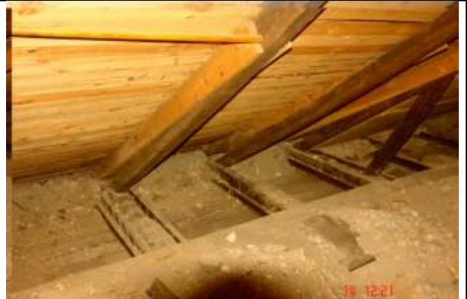
311. Znaczne ubytki w belkach stropowych wskutek ich zagrzybienia. Widoczne ich wzmocnienie poprzez boczne dobicie obustronnie bali o grubości 3 i 5 cm.
