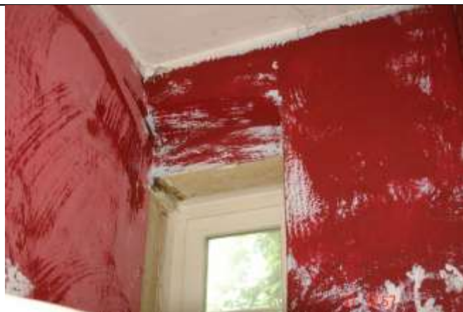
373. Drewniane nadproże z bala w dość dobrym stanie technicznym
