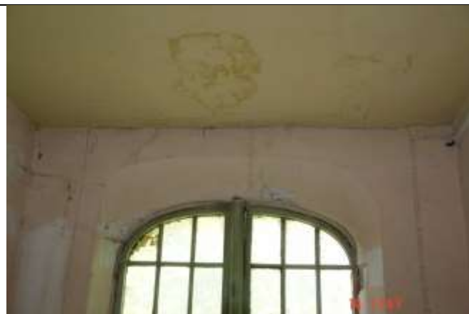
259. Liczne rysy sklepienia nad oknem. Efekt braku wieńca w poziomie stropu poddasza i nierównommiernego osiadania tarczy ściany osłabionej otworami okiennymi.
