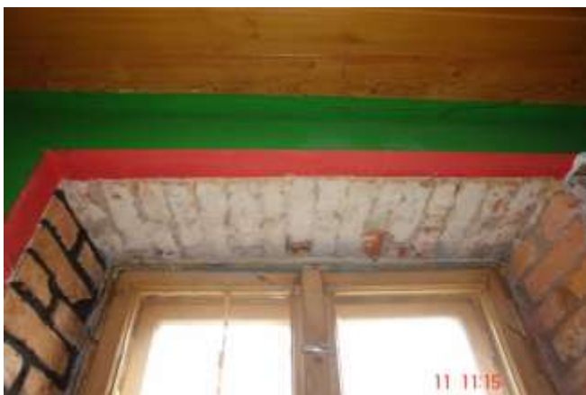
57. Odsłonięte nadproże płaskie z cegły pełnej ceramicznej
