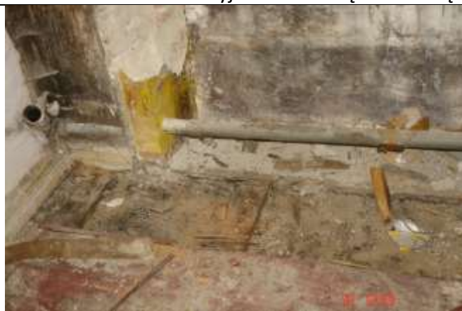
377. Porażopne zgorzelą brunatną deski podłogowe i belki przy podporze. Pleśń na powierzchni ściany
