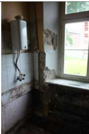
376. Gruba warstwa tynku na ościeżu otworu okiennego.
