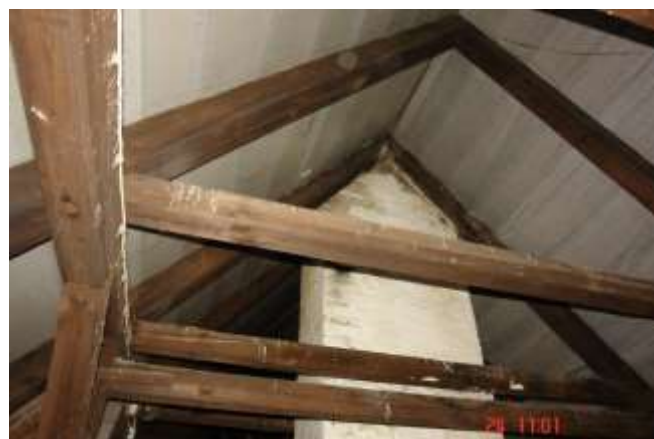
183. Widok krokwi pośredniej opartej na płatwi wraz z jętką. Stan techniczny dobry.
