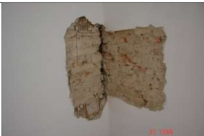
436. Wadliwie wykonana ścianka szachulcowa. Brak słupka skrajnego przy barku przewiązania wypełnienia
