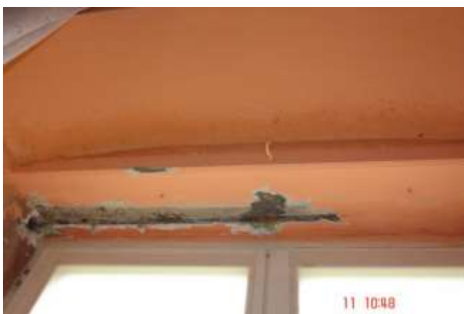
25. Drewniane, bal gr. ~5 cm, nadproże nad przestrzenią międzywęgarkową. Poza węgarkiem nadproże z cegły pełnej ceramicznej, odcinkowe. Drewno częściowo, od strony zewnętrznej ściany zawilgocone.
