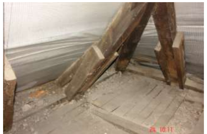
161. Niepoprawne ułożenie membrany dachowej na krokwi narożnej. Zmarszczona powierzchnia membran utrudnia swobodny spływ wody z potencjalnych przecieków.
