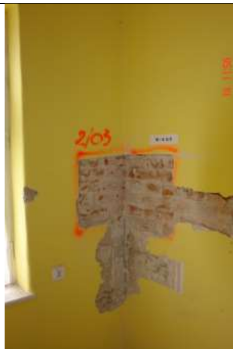
275. Odkrywka wątku ściany podłużnej i szczytowej, ich naroża sprzed wykonania przybudówki. Mury w dobrym stanie technicznym.
