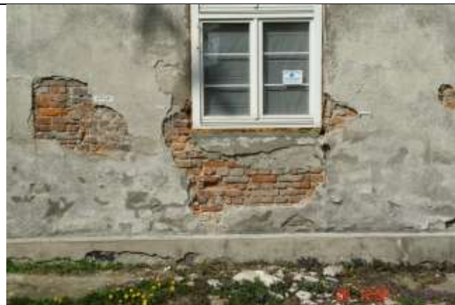
472. Jak fot.469 oraz ubytki pudrowanie lica cegieł. Odsapających się tynk.
