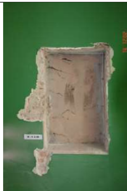
287. Mur wokół wnęki w dobrym stanie technicznym. Nadproże drewniane z bala gr. ~4 cm.
