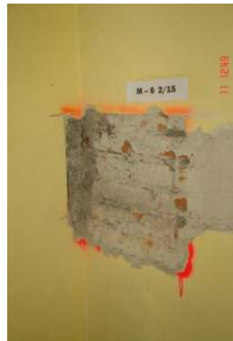
92. Brak poprawnego przewiązania ściany poprzecznej z podłużną zewnętrzną.
