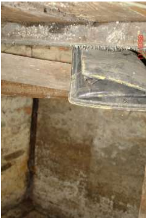
39. Pokryte pleśnią i prawdopodobnie grzybem drewniane elementy konstrukcji stropu Silnie skorog=dowany stalowy podciąg.
