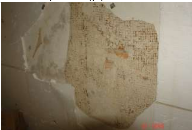
352. Wadliwie wymurowana ściana, zbyt grube spoiny, brak przewiązania , pokryte obustronnie siatką stalową i otynkowana.
