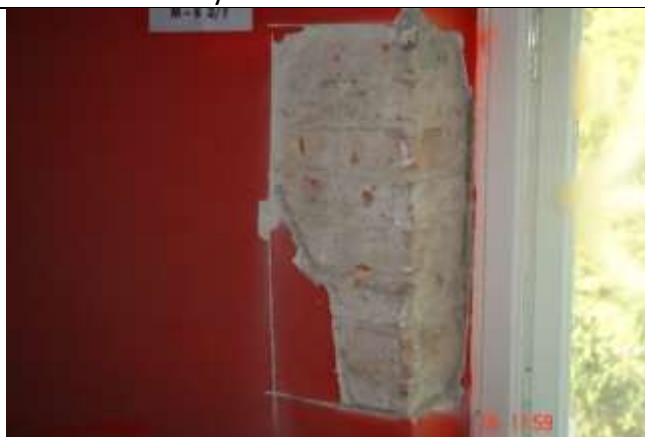
284. Wątek ościeża otworu drzwiowego. Stan dobry.
