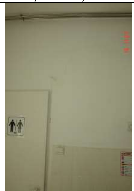
231. Rysa ukośna biegnąca od naroża otworu drzwiowego ku górze.
