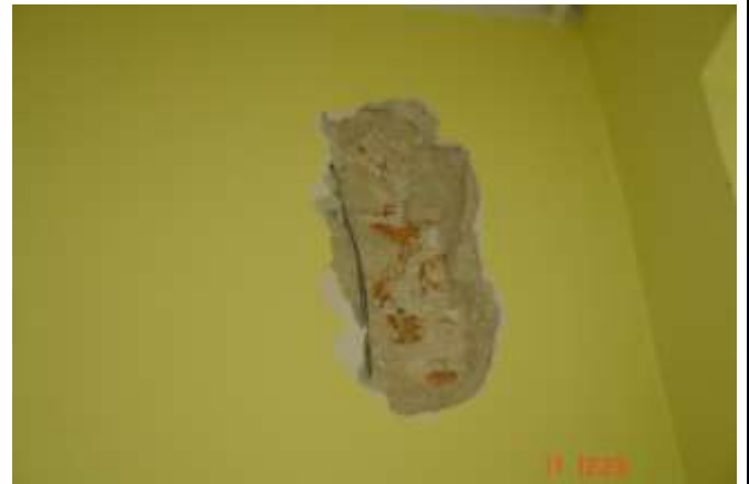
84. Odkrywka wątku muru w miejscu rysy powstałej wskutek zbyt płytkiego ułożenia kabla instalacji elektrycznej
