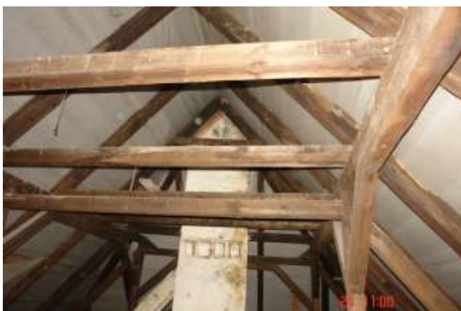
190. Widok położenia wyczystek komina spalinowego. Stan elementów konstrukcji dachu dobry. Z prawej, pod płatwią, widoczne elementy siodła. Stan techniczny dobry.
