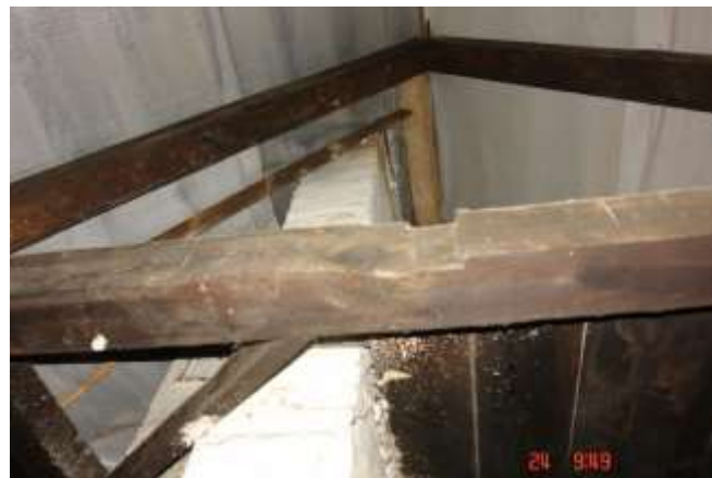
113. Jak fot.112 oraz ubytki w jętcie.
