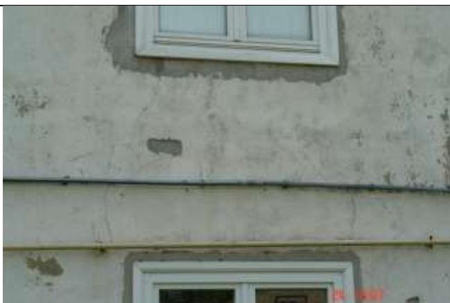
449. Rysy łączące otwory okienne parteru i piętra. Sugerują wpływ nierównomiernego osiadania fundamentów budynku.
