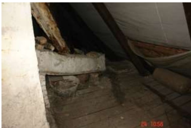
212. Jak fot 209. Wadliwy montaż membrany.
