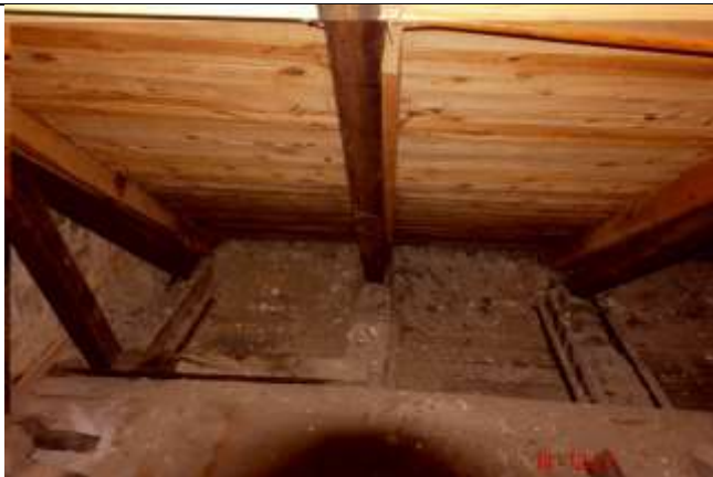
312. W strefie oparcia krokwi i belek drewno lekko zawilgocone. Stwierdzono pleśń.
