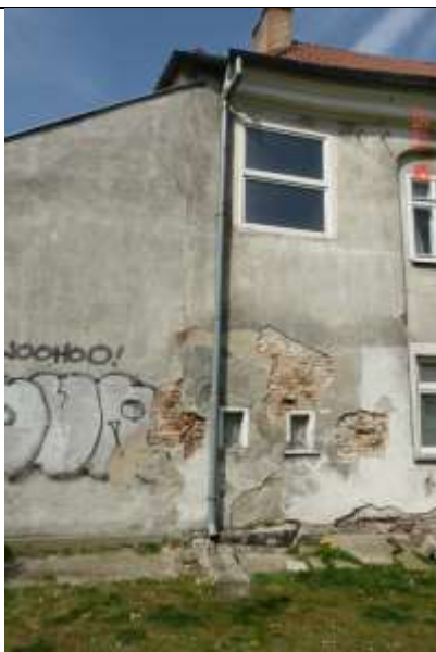
498. Szczelina pionowa pomiędzy częścią dobudowaną do korpusu budynku w innym okresie. Wysokie podciąganie wody gruntowej w murze, liczne złuszczenia tynku i lica cegieł.
