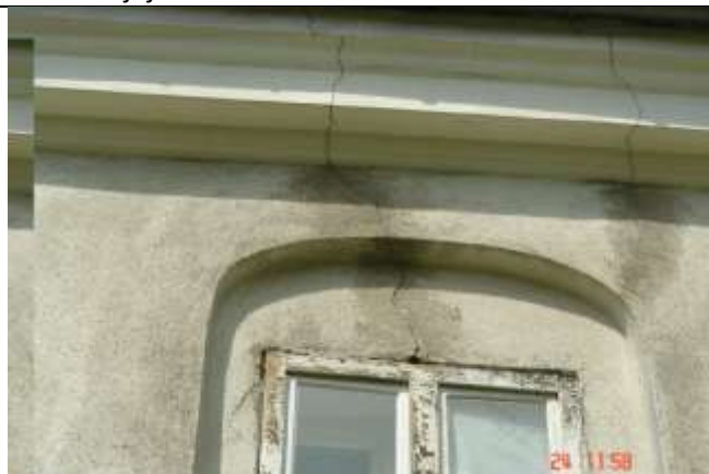
489. Pionowe szczeliny biegnące od okna poprzez nadproże i gzyms oraz krawędzi nadproża, rozszerzające się ku górze
