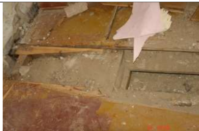
397. Odkryta konstrukcja stropu ślepego pułapu
