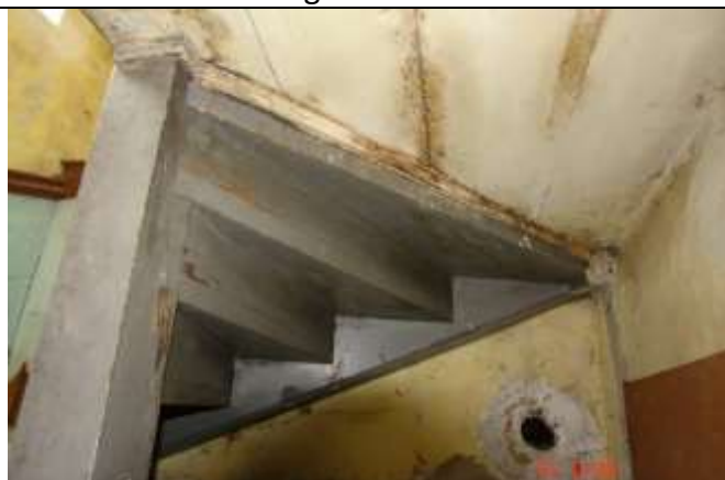
317. Widok schodów od spodu. W sttykach ślady zawilgocenia i zagrzybienia fragmentu stopnicy.
