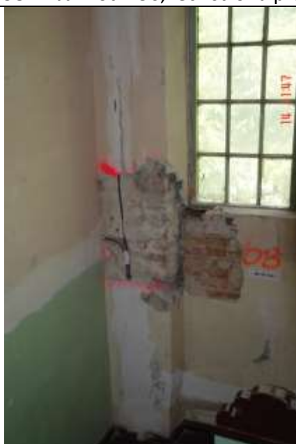
260. Odkrywka styku pierwotnego filara międzyokiennego i wypełnienia pomiędzy filarami. Brak przewiązania cegieł wypełnienia z filarem.
