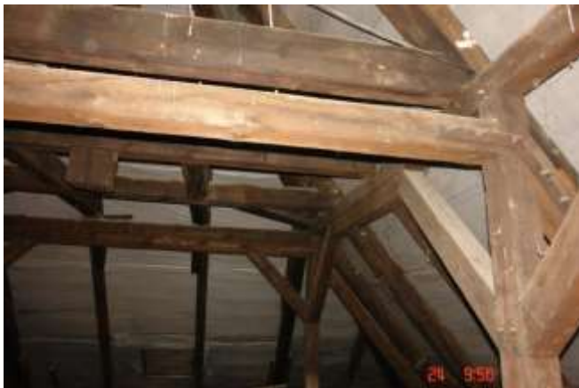
130. Nieznaczne podcięcia jętek w miejscu oparcia na płatwi. Siodło spiętoz płatwią dwiema kotwami.
