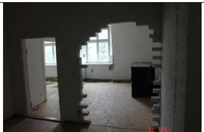
359. Częściowo rozebrana podłużna ściana pełniąca również funkcję usztywniającej. W kierunku podłużnym.
