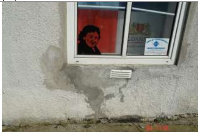
502. Szczelina ukośna pod oknem trefie przyziemnej.
