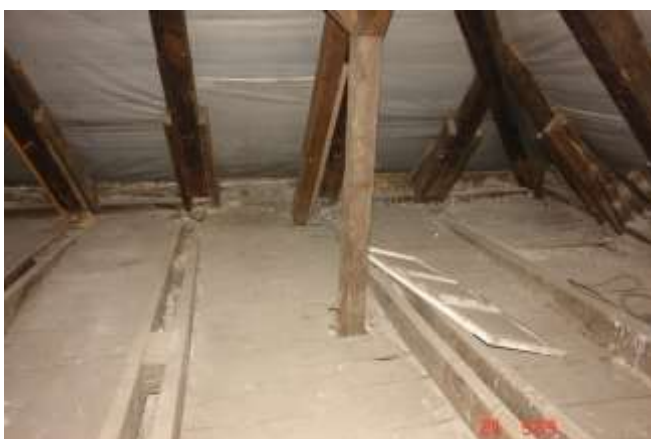
142. Uasytuowanie krokwi głównych i dźwigarów stropu.
