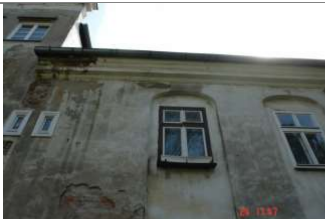
524. Zalewanie wodą z rynny o wadliwym spadku
