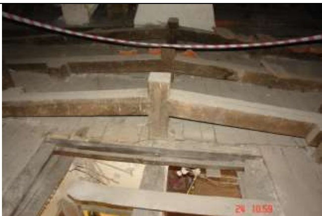
222. Odkrywka nr usytuowana pomiędzy dźwigarami dachowymi. Połączenie konstrukcji dźwigara ze stropem. Dolny pas składa się z dwóch belek obustronnie skręconych z wieszakiem śrubą
