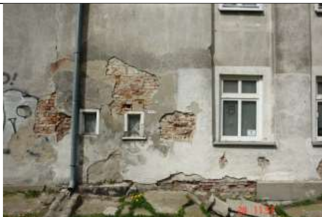
494. Pionowa szczelina w styku murów z różnych okresów wznoszenia. Wysokie kapilarne podciąganie wody jak i zalewanie okresowe elewacji wodą opadową z rury spustowej rynny
