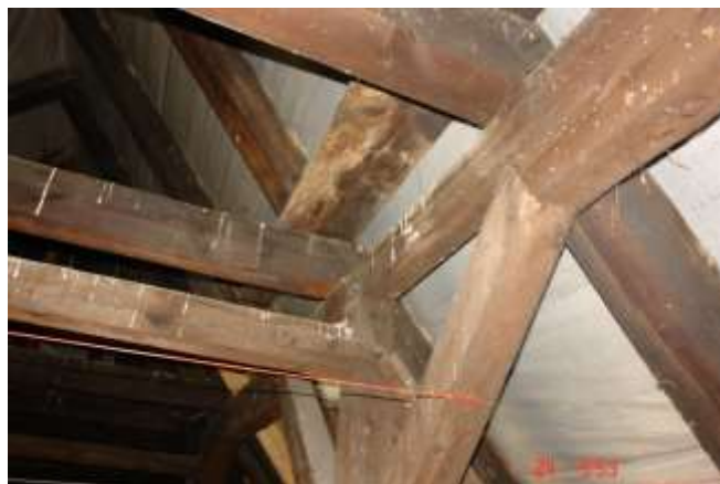
121. Widok połączenia rozpory z zastrzałem kutym płaskownikiem o szerokości \sim 50-60 mm grubości \sim 5 mm. Trzcienie \phi 16 . Również widoczne jest połączenia belki siodła z mieczem.
