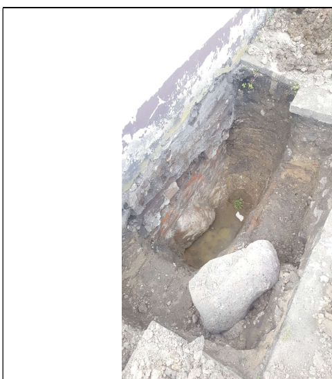
Fot. Odkrywka fundamentu w PN-W narożniku dobudówki kuchennej
