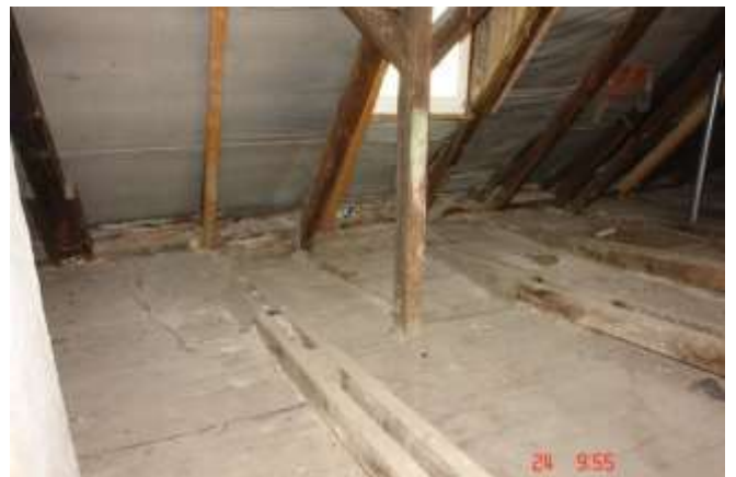
127. Liczne powierzchniowe uszkodzenia elementów konstrukcji dźwigarów stropowych w szczególności ich pasa górnego. Znaczne zniszczenie desek podłogowych. Na znacznych powierzchniach występują ślady zacieków
