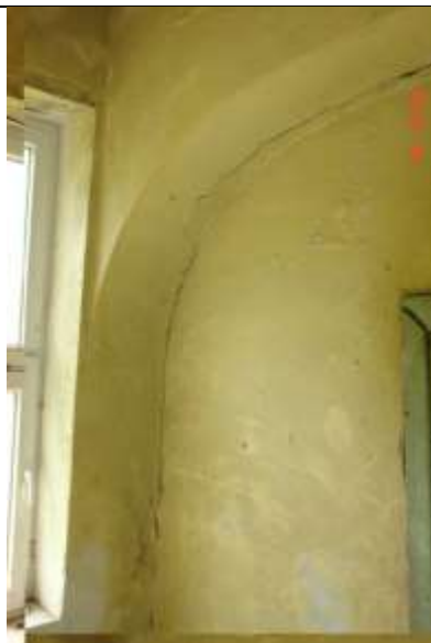
308. Brak przewiązania pomiędzy wypełnieniem przestrzeni podsklepiennej a sklepieniem liczne
