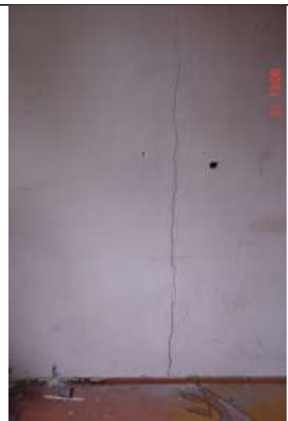
391. Szczelina pionowa zwężająca się ku górze. Rysa powstała wskutek ugięcia się ławy fundamentowej wraz z tarczą ścian.
