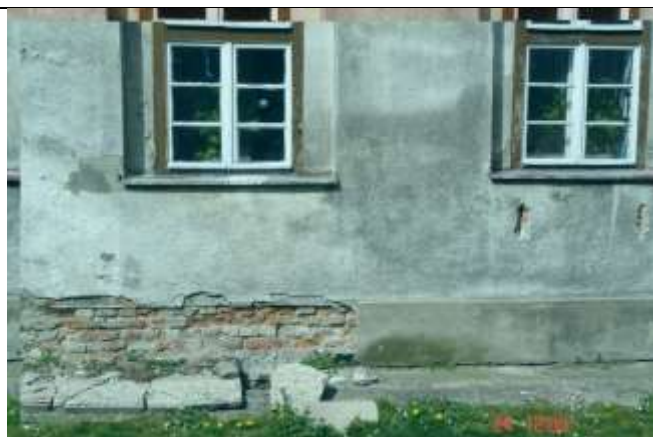
483. Zniszczona okładzina cokołu muru wskutek zamarzania wody znajdującej się pod nią a podciąganej kapilarnie w murze i ograniczonej możliwości jej odparowania. Cokół wykonano z zaprawy z dodatkiem cementu. Złuszczenie warstwy licowej muru. Widoczny jest odcinek warstwy hydroizolacyjnej odcinającej cokół od muru parteru.
