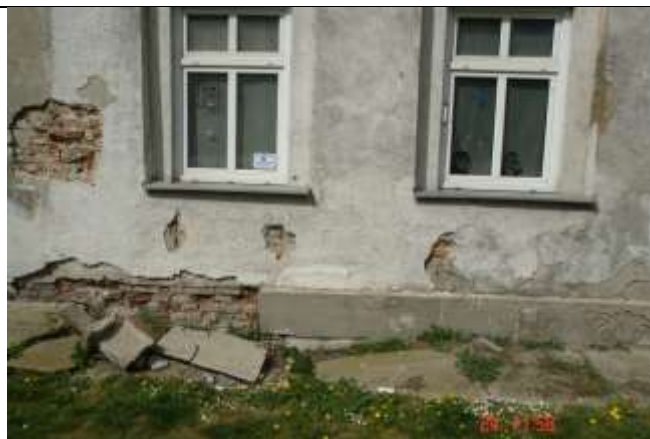
493. Brak przewiązania pomiędzy murem pierwotnym a wypełniającym, złuszczenia i głębokie ubytki wątku muru, zniszczenie okładziny cokołu poniżej warstwy hydroizolacyjnej jak również podciąganie kapilarne wody powyżej.
