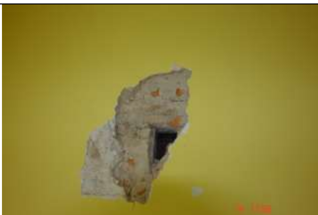
276. Odkrywka w miejscu rysy. Brak przewiązania cegieł w murze
