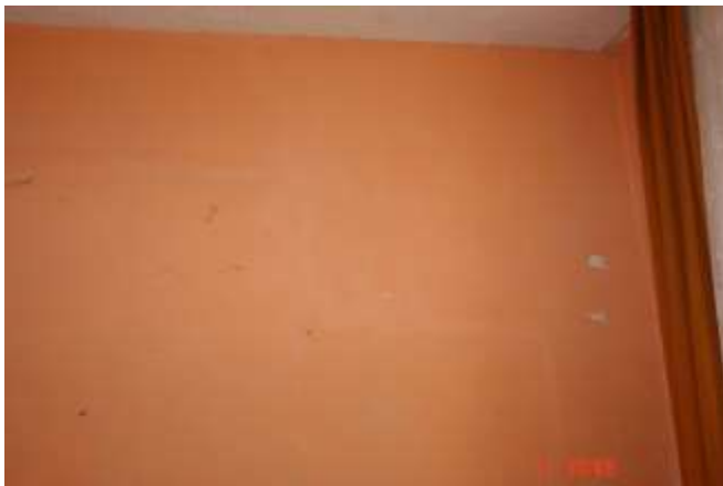
23. Rysa ukosna ściany konstrukcyjnej biegnąca od styku ze stropem ku podłodze.
