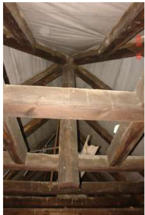
139. Stolec z fot.138 lokalnie porażony owadami.
