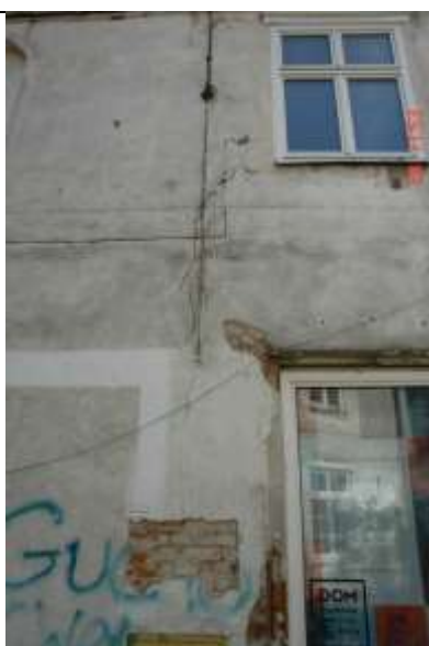
513. Pionowa szczelina biegnąca od krawędzi nadproża sklepiennego okna nad parterem do dolnego naroża okna na piętrze.
