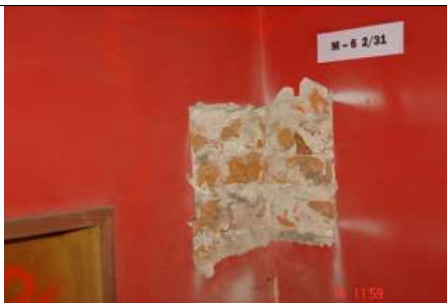
282. Odkrywka wątku muru wzdłuż krawędzi otworu drzwiowego. Stan dobry
