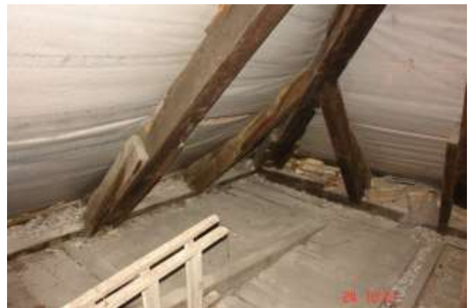
165. Wadliwy styk brytów membrany dachowej. Brak wymaganego zakładu.
