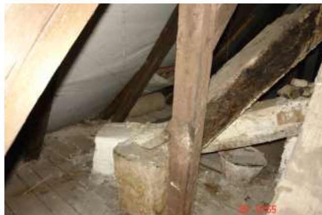
209. Spękany czopuch z licznymi wysiękami skroplonej pary wodnej świadczące o jego nieszczelności
