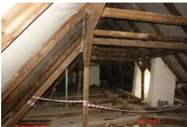
220. Widok wystających ponad powierzchnię podłogi krokwi dźwigarów stropowych.
