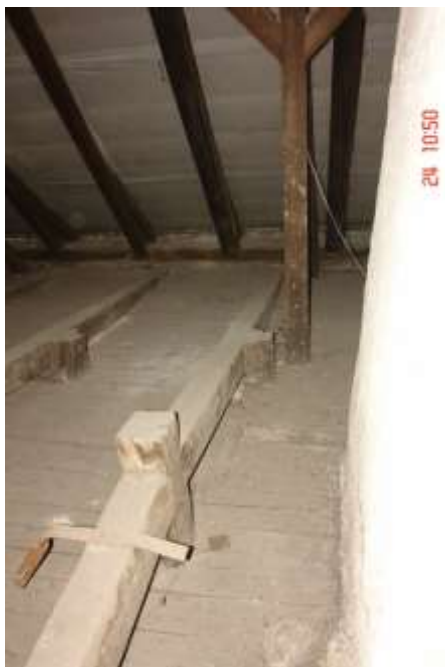
180. Widok usytuowania dźwigara stropu w stosunku do wieszaka
