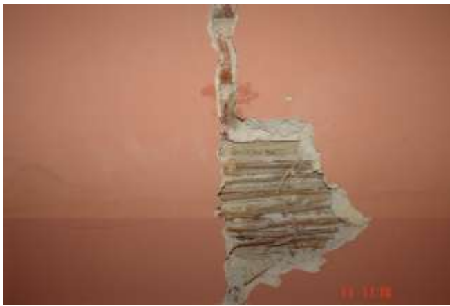
55. Odkrywka ściany działowej. Konstrukcja jak fot. 54
