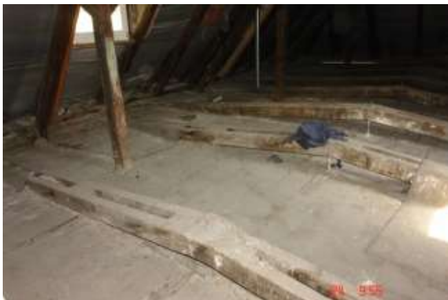
126. Widok górnych pasów dźwigara stropu z rozsunięciem jego elementów i przekładkami z bali drewnianych.
