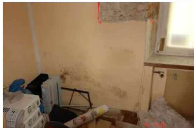
247. Podciągnięcie w murze wilgoci do wysokości ~1 m powyżej podłogi. Wykwity pleśni na wilgotnym tynku
