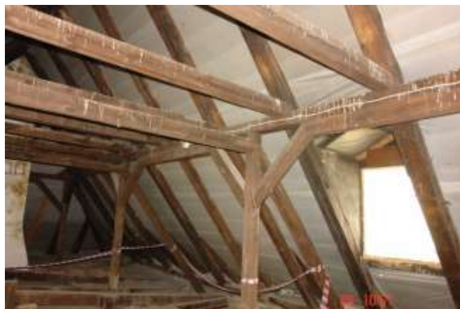
195. Wiodpok fragmentu więzby z siodłami w przęsłach wewnętrznych i w skrajnym przy połaci szczytu w przeciwieństwie do przęsła od strony klatkischodowej, gdzie na całej długości przęsła zastosowano siodło z płatwią dwudzielną od wieszaka do wieszaka. Stan techniczny dość dobry.
