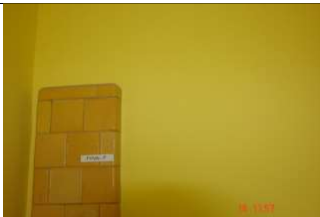
280. Rysa ukośna biegnąca od połowy wysokości pieca w kierunku sufitu
