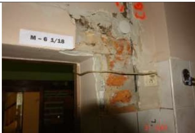
354. Drewniane nadproże z bala o gr ~4 cm w dobrym stanie technicznym.
