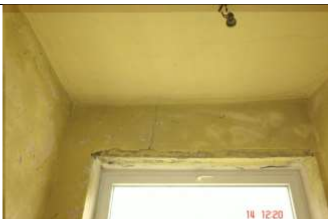
307. Drewniane nadproże nad oknem. Pionowe rysy nad nadprożem i liczne rysy na styku sufitu ze ścianami powstałe w wyniku ugięć drewnianej konstrukcji stropu jak i skutków nierównomiernego osiadania fundamentów
