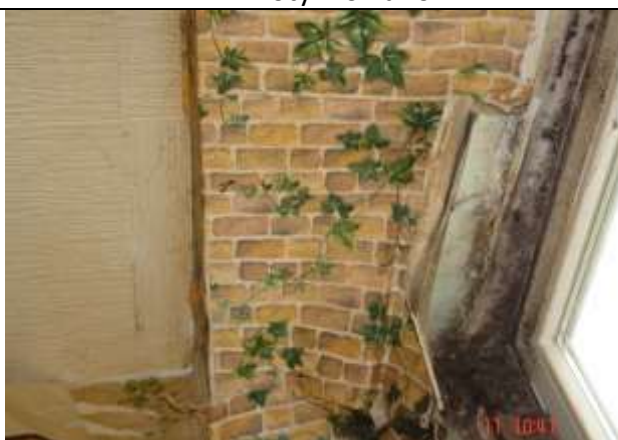
11. Nadproże ceramiczne, odcinkowe. Na szerokości węgaraka nadproże z bala drewnianego gr. ~5 cm. Część drewniana otynkowana, z wykwitami pleśni.
