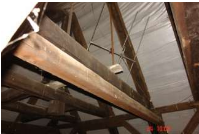
158. Osadzenie stolca w szczycie dachu przy naczółku
