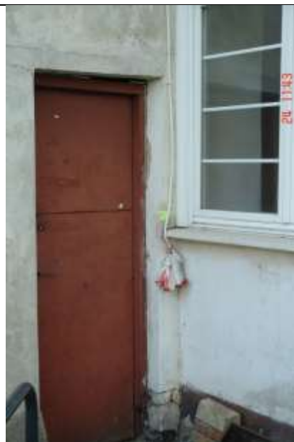
542. Rysa pozioma wzdłuż drewnianego nadproża.
