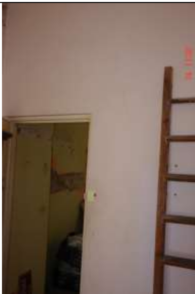
242. Rysa pionowa ściany działowej biegnącej ~ 0,5 m obok otworu drzwiowego. Rysa rozszerza się wraz z jej wysokością.
