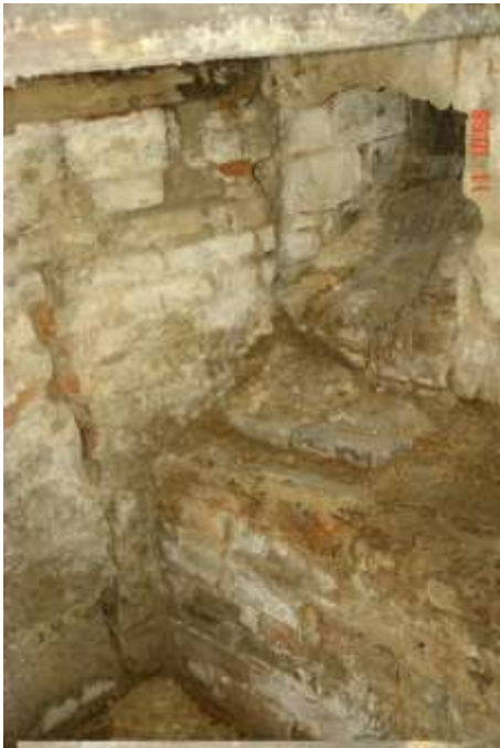
37. Styk ściany poprzecznej z fot.32 i 35 lecz w poziomie piwniczki pod pomieszczeniem nr 8/7. Szczelina na jej styku ze ścianą zewnętrzną, podłużną. Brak należytego przewiązania pomiędzy ścianami. Silnie zawilgocoe mury.
