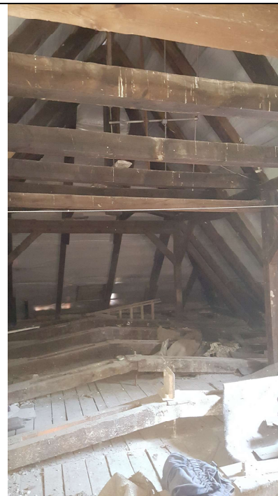
Fot. Belki ustroju wieszakowo -zastrzałowego na poddaszu strefa wschodnia
