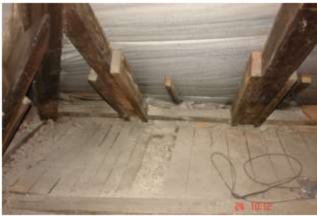
162. Dodatkowe elementy podpierające łąty w płaszczyźnie przypustnicy. Elementy podpierające wsunięto pod łąty.
