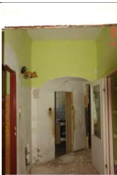
290. Rysy pionowe przecinające sklepienie i biegnące ku górze n całej jego szerokości. Łącząco, z rysą z fot.289
