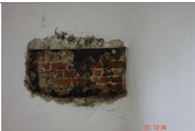
340. Pod okładziną muru z płyt wiórowo-cementowych atwierdzono mokry mur okryty pleśnią.
