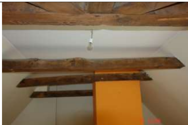
429. Konstrukcja porażona przez owady, głównie kornika.
