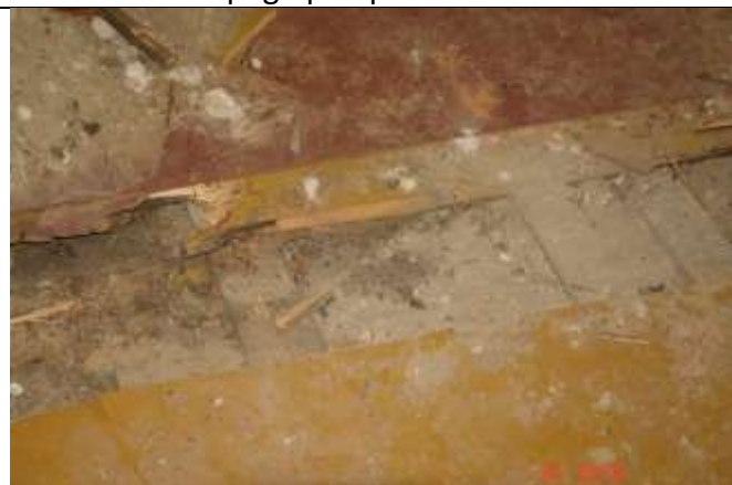
399. Dość dobry stan belek stropowych w odkrywce
