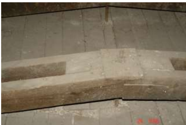
132. Szczyt dźwigara stropowego z wieszakiem stalowym wykonanym z kotwy \phi 22 . Wieszak silnie skorodowany. Wielkość ubytku do 0,5 mm
