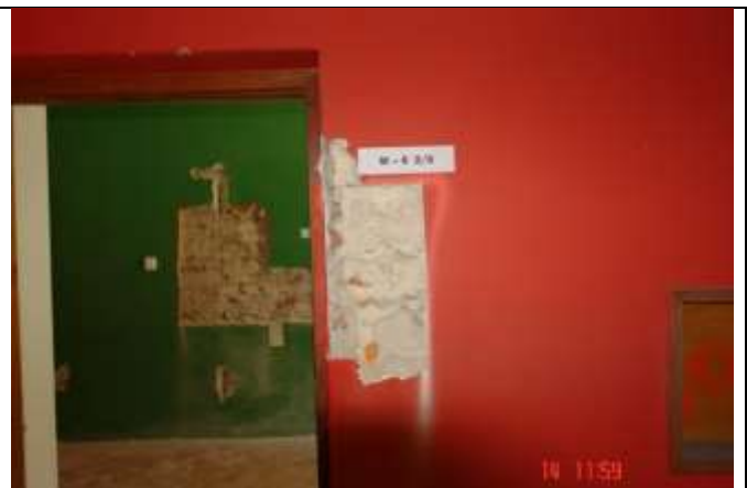
281. Odkrywka ścianki działowej na krawędzi otworu drzwiowego. Dobry stan techniczny
