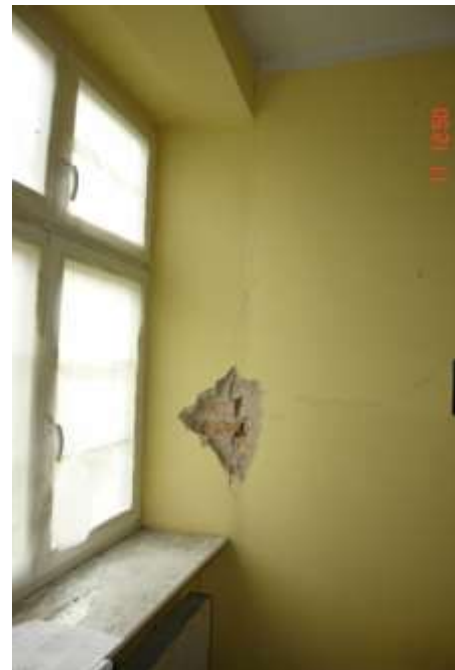
94. Brak należytego przewiązania ściny poprzecznej z podłużną. Pionowa ysa o rozwartości do 5 mm
