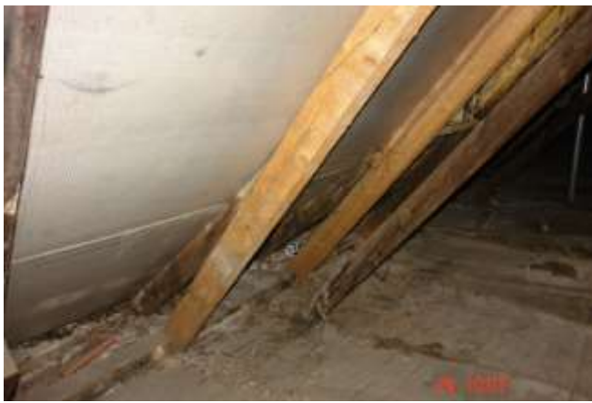
156. Liczne ślady zacieków na drewnianej konstrukcji więźby sprzed jej remontu
