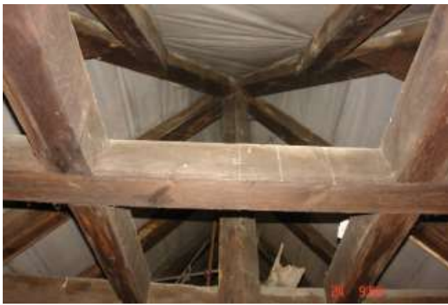
138. Podparcie szczytu połączenia naczółkowej w kalenicy stolcem opartym na jętce.
