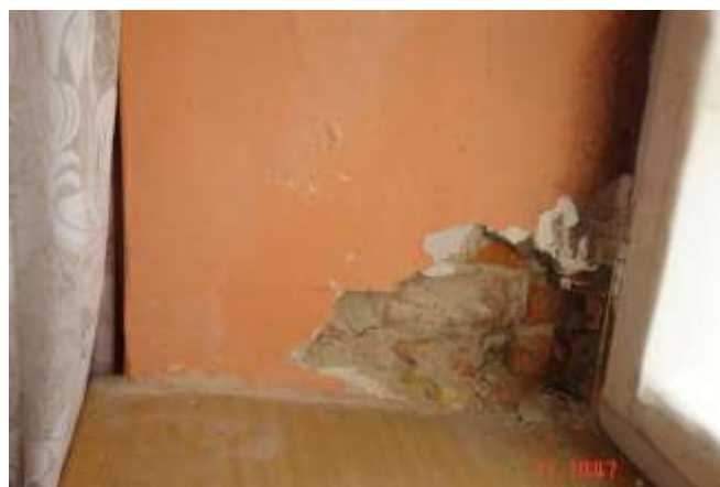
24. Brak należytego przewiązania cegieł w strefie przyparapetowej ościeża. Silne zawilgocenie muru.
