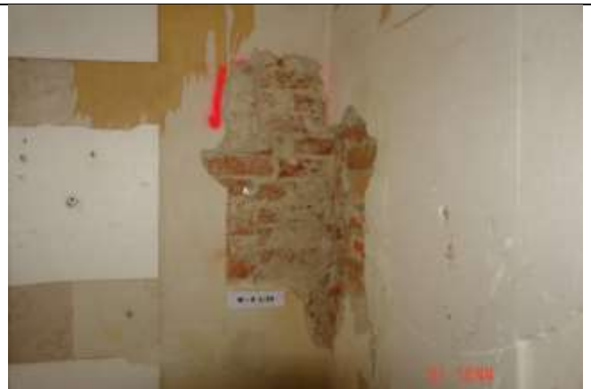
351. Wadliwe murowanie , bez przewiązania poszczególnych warstw jak i ścian
