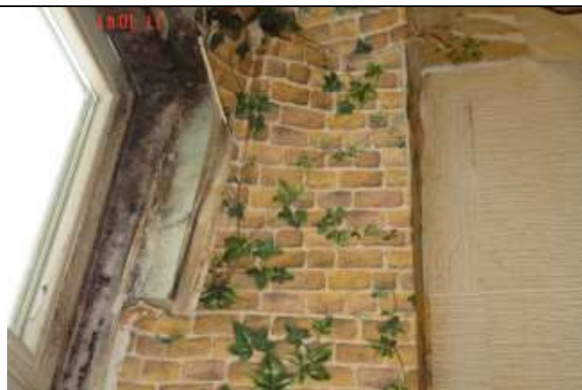
10. Naroże okna z licznymi obszarami występowania pleśni zarówno na drewnianych elementach stolarki okiennej jak i pod tapetą na tynku.
