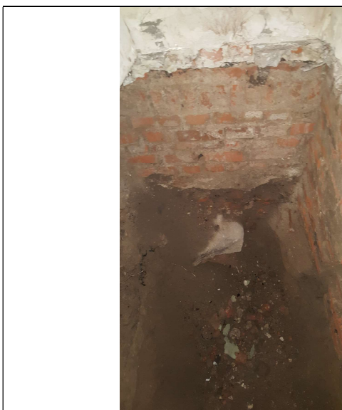
Fot. Odkrywka fundamentu ściany wewnętrznej z ścianą prostopadłą wew.
