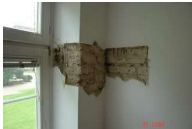
435. Ślady próby wadliwego wycięcia próbki ściany osłabiającego krawędź otworu okiennego w ścianie podłużnej przy braku jej przewiązania ze ścianą działową prostopadłą. Taka próba jest niedopuszczalna. Stwarza zagrożenie dla nośności i stateczności odcinka ściany międzyokiennej
