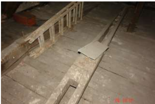
164. Powyginane i w znacznym stopniu skorodowane deski podłogi poddasza. Deski na znacznej powierzchni stykają się z wypełnieniem ślepego pułapu z gruzu, piasku, resztek zaprawy, ścinków rewna.
