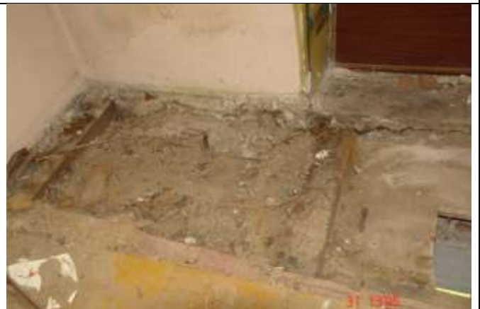
387. Niszczenie końcówki belki stropowej przez grzyba, zgorzel brunatną.
