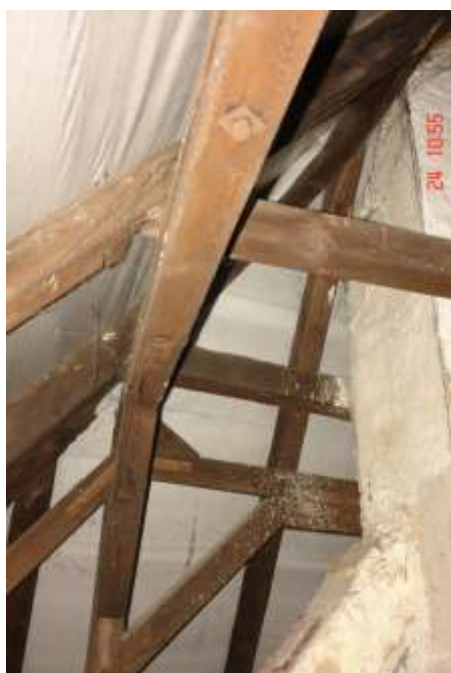
206. Widok trzcieniem łączących płatow z siodłem.
