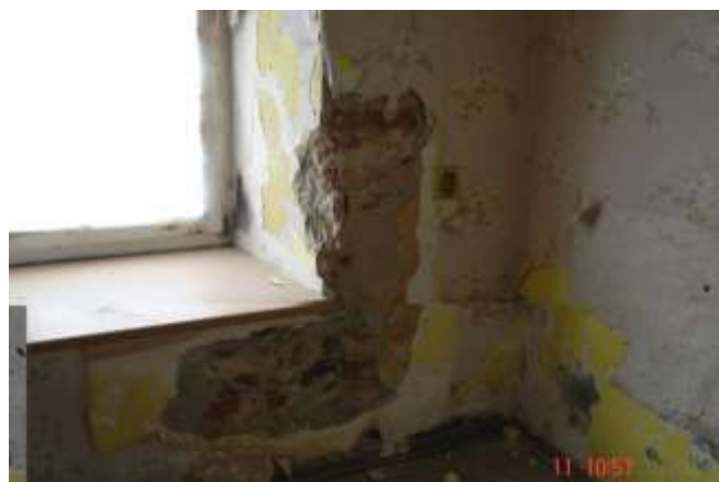
36. Wysokie ( \sim 0,8-0,9 m), powyżej podłogi podciąganie kapilarne wody w murze. Wykwity pleśni w strefie przypodłogowej. Głębokie ubytki muru wyrównywanego grubą warstwą tynku wapiennego na oścież otworu okiennego.
