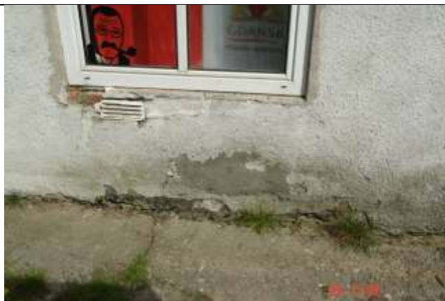
503. Rysa pionowa i ukośna muru podokiennego
