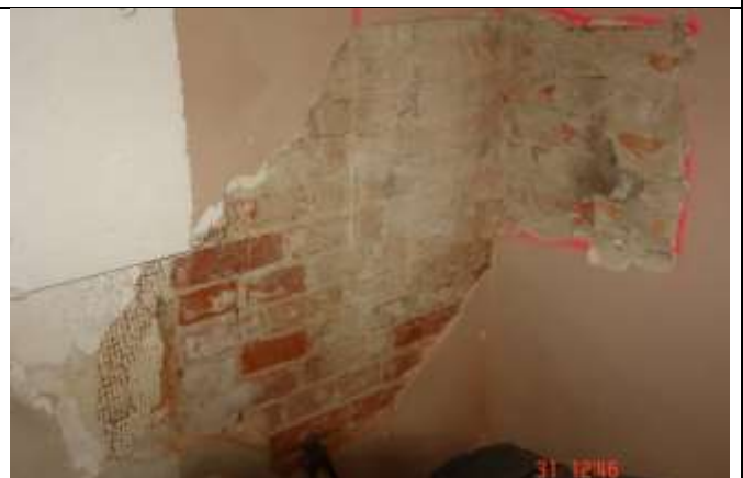
353. Brak przewiązania fragmentów ścian. Pleśnie i zawilgoicenie muru.
