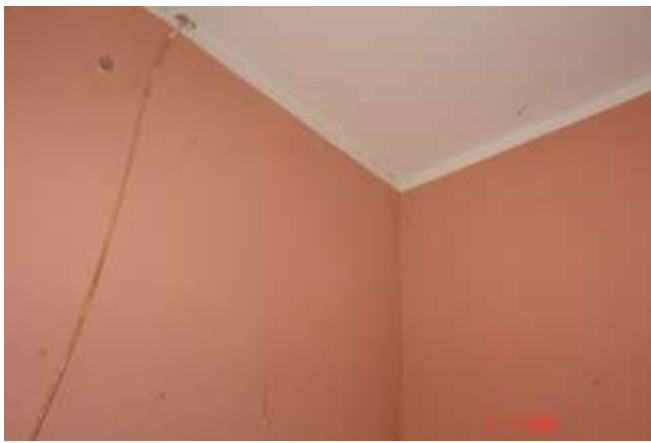
47. Jak fot 46 oraz wadliwy styk płyt w narożu ścian.
