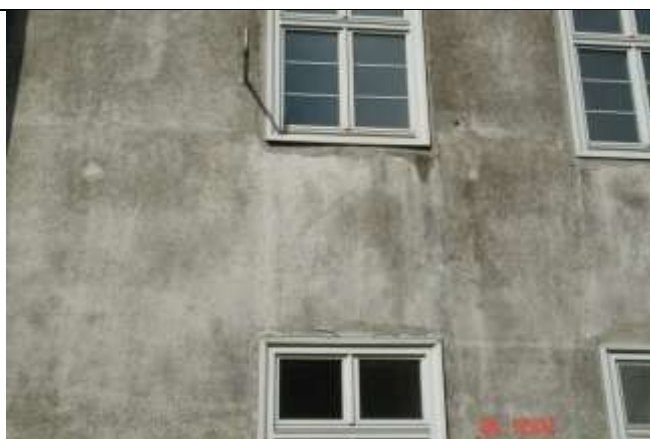
467. Rysy pionowe i ukośne muru międzyokiennego.
