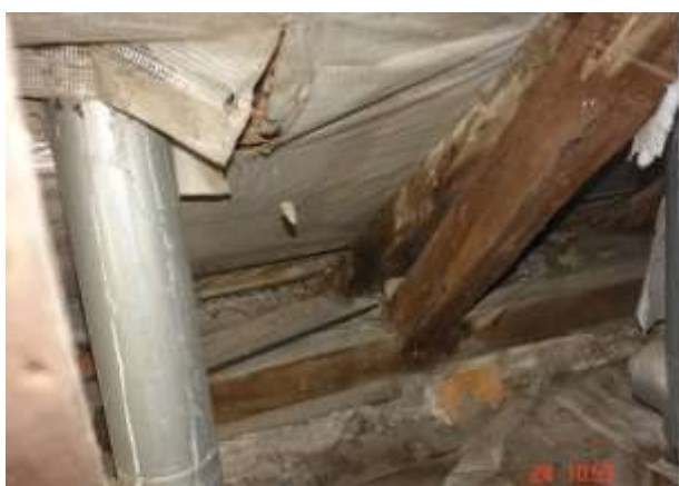
200. Jak fot 199. Wadliwie wykonano przejście kanałem went przez dach. Brak wymianu podpierającego łąty pod dachówki. Rozerwanie membrany p.wiatrowej.
