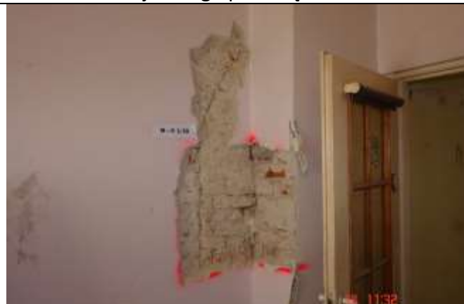
241. Szczelina po obrysie pierwotnego przejścia do części parterowej lub wejścia do budynku sprzed wzniesienia przybudówki. Szczelina na styku z kominem.
