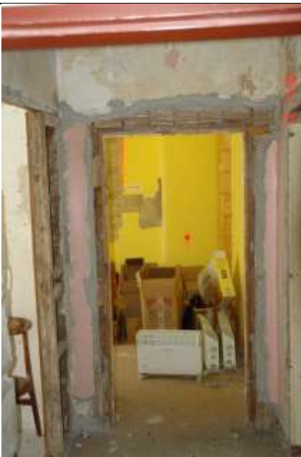
262. Pomieszczenie w trakcie remontu. Ostonięto szkieletowe, drewniane ściany działowe w korytarzu
