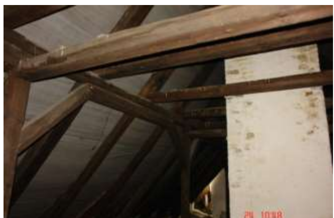
173. .Widok konstrukcji siodła.Jętką
