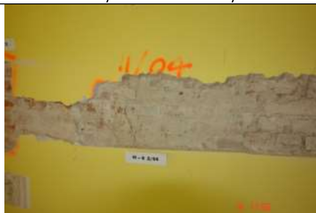
277. Odkrywka ściany szczytowej
