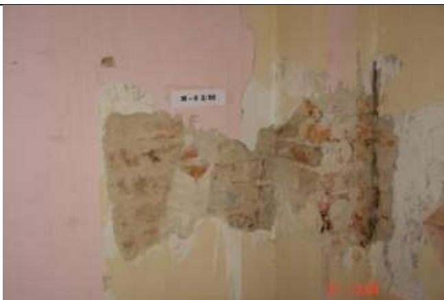
396. Brak przewiązania ścian
