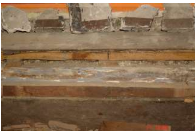
75. Szczegół warsw podłogowych w odkrywce z fot 72.
