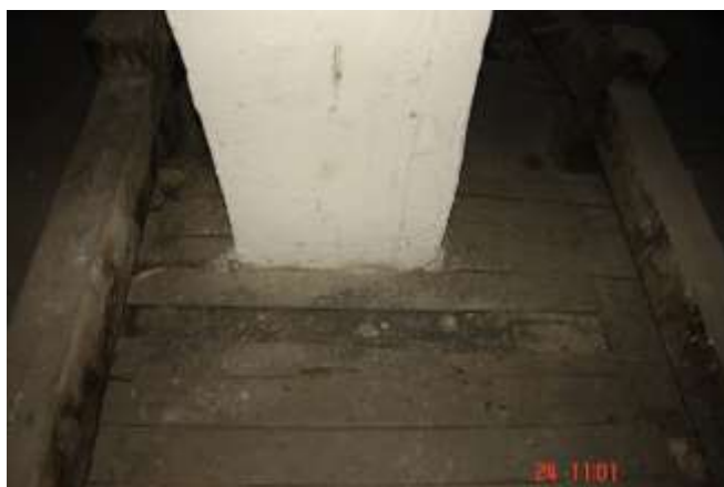
182. Brak wymianu w ślepym pułapie pod deskowanie ślepego pułapu i pomiędzy dźwigarami stropu.
