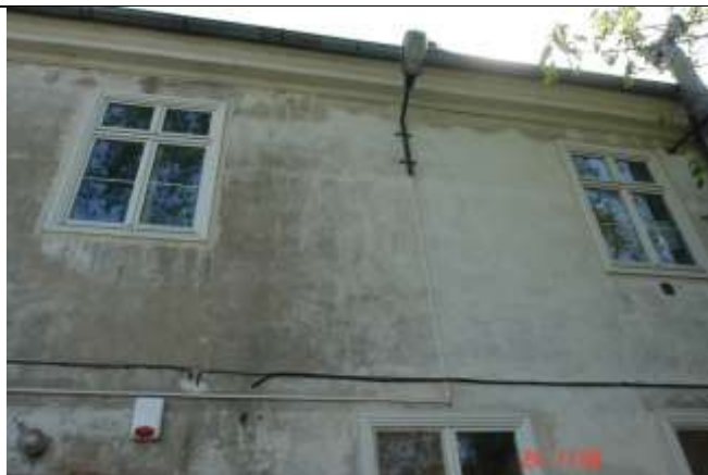
537. Rysy pionowe pomiędzy otworami okiennymi oraz ukośne nad otworami na piętrze
