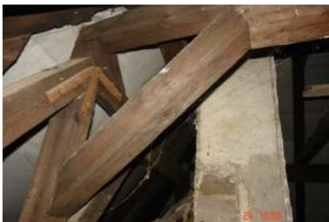
210. Zastrzał konstrukcji siodła łączony z wieszakiem na wpust i gwoździe i kołki o średnicy ~ 1,2 cm. Siodło szczytu dachu.
