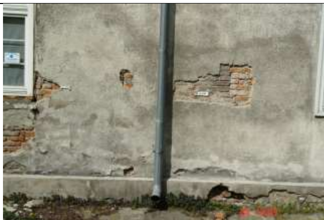
469. Wypełnienie otworu bez zasady zachowania przewiązania cegieł. Złuszczenia tynku i ubytki muru w przyziemiu. Zawilgocenie muru.
