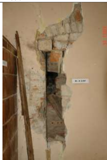
383. Zamurowany pierwotny owór w murze bez należytego przewiązania cegieł. Wskutek nierównomiernego osiadania fundamentów ściany cegły pod łukowym ceramicznym nadprożem wypadają. Nadproże z rysami prostopadłymi do obwodu.
