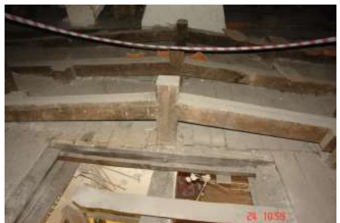
191. Konstrukcja nośna stropu poddasza typu wieszarowego Wieszak wykonany jest z bala o przekroju 18/16,5 cm, krokwie o przekroju 2x. Wieszak pośredni 2x 8/31 cm skręconych śrubami \phi 16 .
