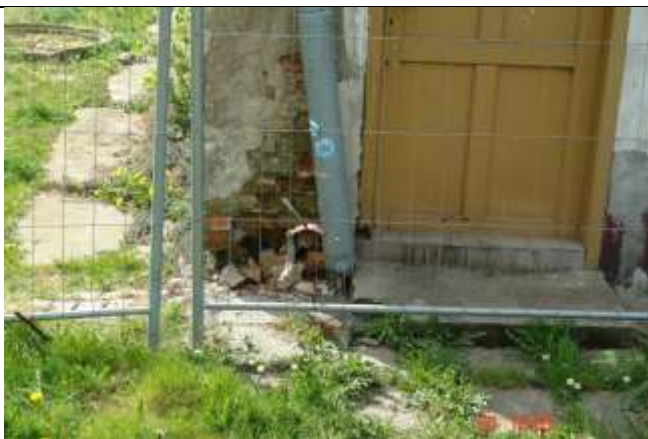
451. Ubytki lica muru przy wadliwym wylocie rury spustowej rynny dachowej.
