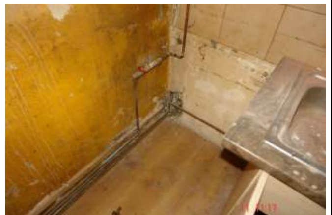
58. Silne zawilgocenie ściany w strefie przypodłogowej.
