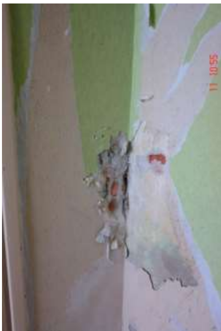
33. Brak należytego przewiązania pomiędzy murem ściany konstrukcyjnej a kominem.
