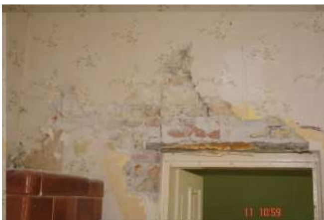
41. Nadproże nad drzwiami wewnętrznymi wykonano z bala o grubości ~5 cm. Chaotyczny wątek muru nad nadprożem. Brak należytego przewiązania muru nad nadprożem w strefie podparcia belki nosnej. Nad nadprożem szczelina ukośna muru mającego tendencję do wypadania
