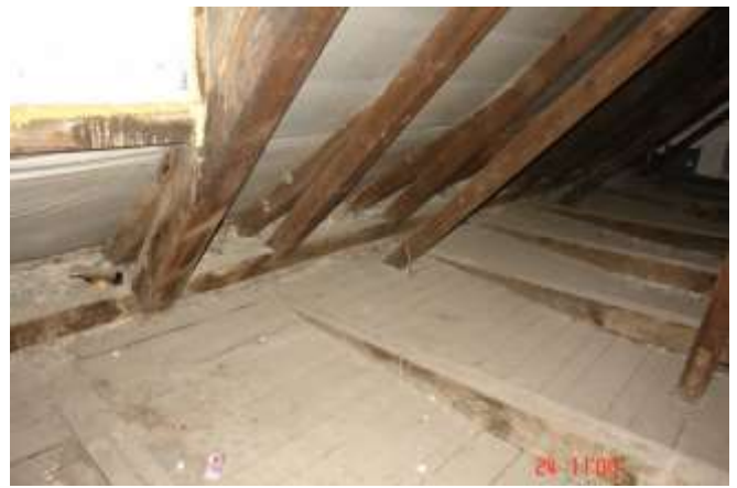
187. Ślady po zaciekach na elermerntach drewnianych pochodzące ze stanu sprzed remontu i wymiany pokrycia dachu. Lokalna korozja krokwi głównej przy oparciu na murbelce.
