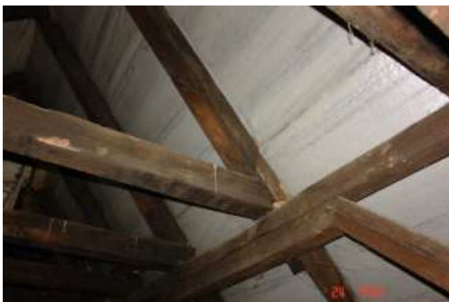
118. Złącze krokwi oparte na płatwi wykonane w przeszłości zapewne wskutek uszkodzenia krokwi np przeciekami dachu i czynnikiem biologicznym
