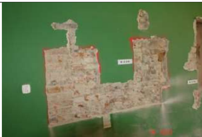
286. Wypełnienie otworu drzwiowego. Nadproże w dość dobrym stanie wykonano z bala drewnianego
