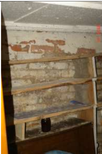
348. Wido fragmenyu piwnicy. Ścioany silnie zawilgocone. Pomieszczenie bez wentylacji grawitacyjnej.
