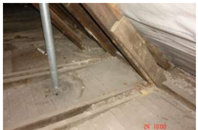
143. Kanał wentylacyjny z rury z blachy stalowej ocynkowanej, nieocieplony.
