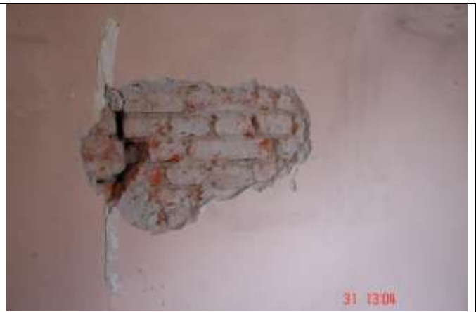
385. Brak przewiązania styku ścian
