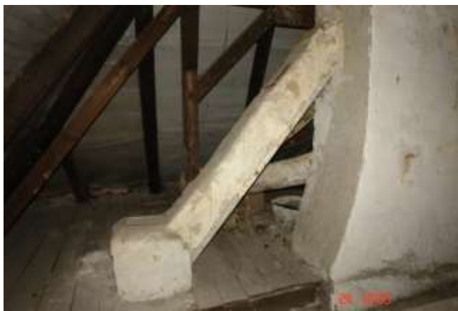
208. Widok czopuch kanału spalinowego
