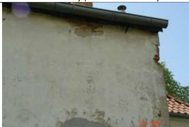
448. Odpadający tynk w koronie ściany szczytowej wskutek przeciekania wody opadowej przez nieuszczelnności obróbki blacharskiej okapu. Efekt naprężeń termicznych w postaci ukośnej rysy naroża muru.
