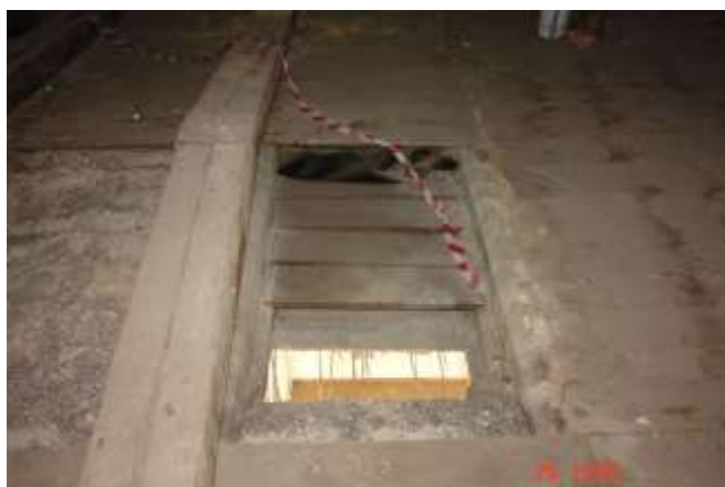
152. Odkrywka nr 2 pomiędzy dźwigarami stropu. Widoczna konstrukcja ślepego pułapu pomiędzy dźwigarami.
