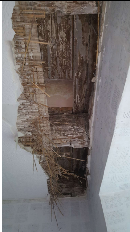
Fot. Widok gniazd głównych belek stropowych budynku Głównego od spodu
