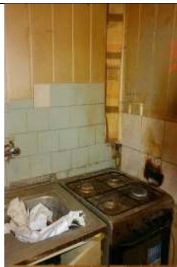
299. Silnie zawilgocona ściana w pomieszczeniu kuchennym, spoiny pokryte pleśnią, głuchy odgłos przy ostukiwaniu okładziny z glazury. Pleśnie w spoinach pomiędzy płytkami.
