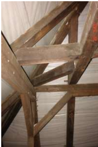
140. Zastrzał stężący pomiędzy podparciem krokwi naroże a rusztem podstolcowym
