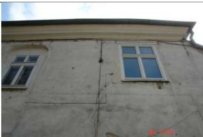
515. Rysa z fot.513 i 514 , je zakończenie w koronie muru
