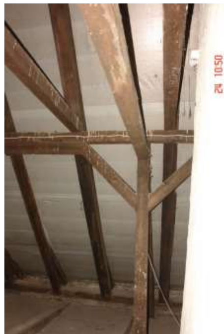
181. Zachowana ciągłość siodła w przęsłach płatwi. Elementy konstrukcji więzby w dobrym stanie technicznym.
