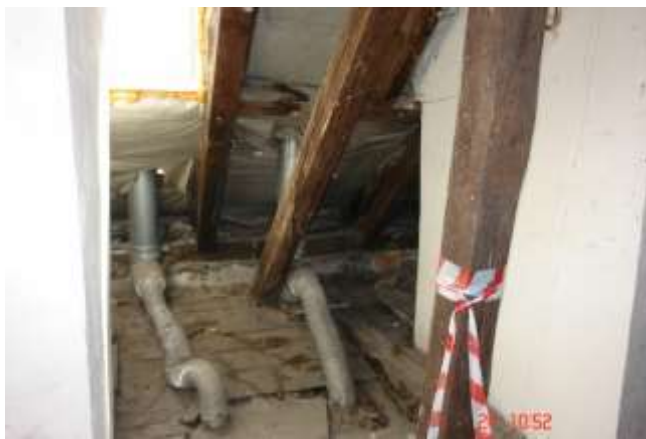
196. Jak fot. 193. Spłaszczenie przewodu spalinowego. Wadliwy materiał, z którego wykonano przewód. Ślady zacieków ze skroplin na przewodzie. Stan zagrożenia pożarowego więzby dachowej
