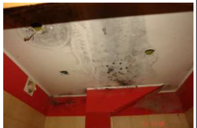
60. Wykwyty pleśni na płytach g-k pokrywających sufit.
