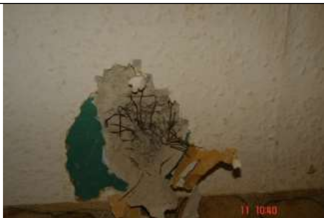
9. Ściana działowa wykonana z porowatych bloczków, prawdopodobnie, żużlobetonowych na zaprawie wapienno-cementowej. Ściankę obustronnie osiatkowano i otynkowano.
