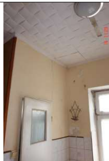
235. Pionowa rysa ściiany działowej biegnąca od naroża otworu drzwiowego ku górze
