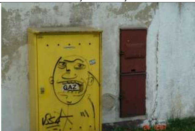
447. Odpadający tynk w strefie przyziemia wskutek silnego nawaniania muru i tynku. Szeroka rysa pionowa na styku ściany budynku i muru ogrodzenia.
