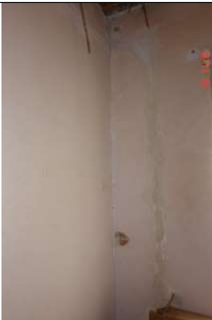
238. Rysa pionowa na styku ściany zewnętrznej i działowej.
