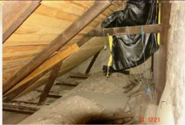
310. Widok konstrukcji więźby dachowej. Elementy drewniane w dość dobrym stanie
