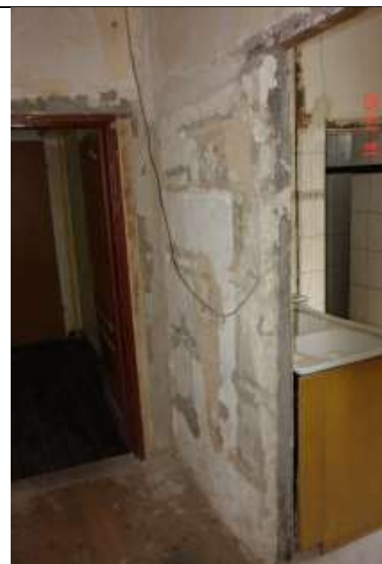
265. Widok ściany działowej wykonanej z bloczków gazobetonowych
