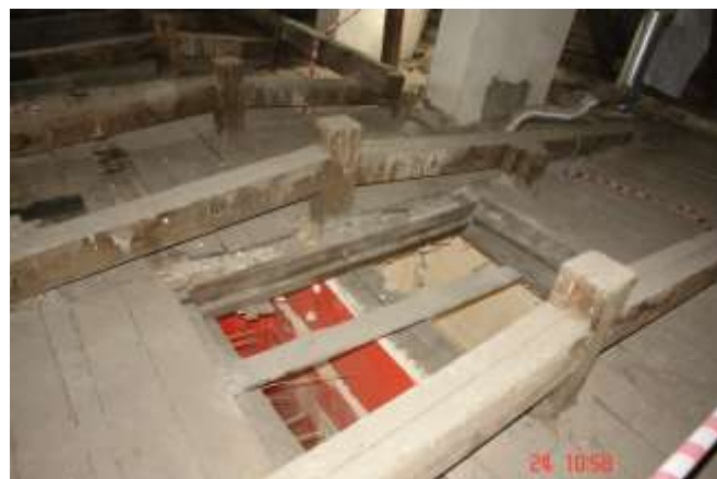
219. Odkrywka w połowie rozpiętości stropu usytuowana pomiędzy dźwigarami stropu poddasza. Dolny pas dźwigara wykonano z bala o przekroju poprzecznym ~28/34 cm
