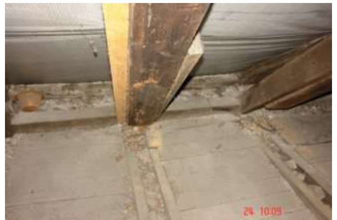
159. Wysypująca się spomiędzy nakładek na krokiew a krokwią lignina świadcząca o aktywności owadów
