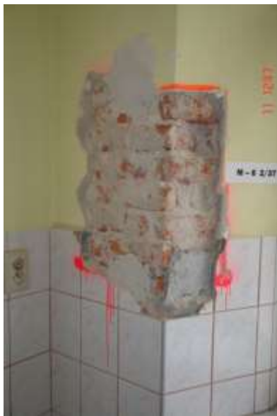
87. Odkrywka naroża ościeża otworu okiennego w pom. 11/2. Bardzo dobry stan techniczny muru.
