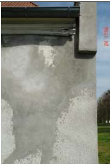
501. Zatynkowane ukośne i pionowe szczeliny muru zachodniego.
