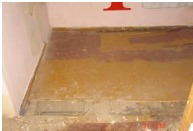
392. Deski podłogowe pokryto płytami pilśniowymi, twardymi, pod którymi widać z grzyb. Wierzch belek stropowych również porażony grzybem.
