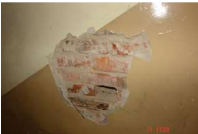
63. Odkrywka muru. Pod tynkiem fragment drewnianej konstrukcji szachulcowej ściany parteru. Odkrywka na styku ściany parteru i piętra. Ściana piętra z cegły pełnej ceramicznej na zaprawie wapiennej
