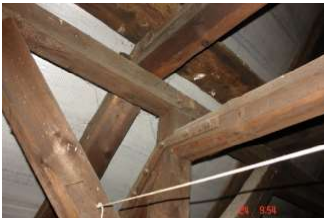
124. Złącze jak na fot 121 i widok oparcia płatwii, rozpory i zastrzału na wieszaku.
