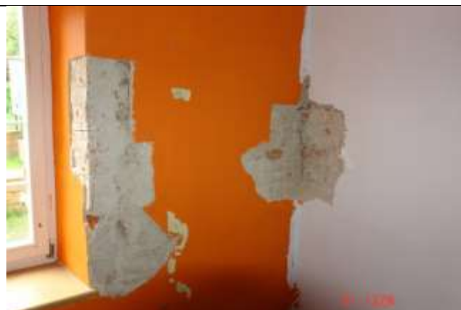
415. Brak należytego przewiązania muru przy węgarku oraz w styku ścian.
