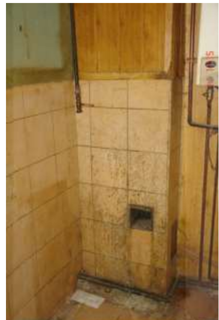
56. Pokryty pleśniami i zanieczyszczeniami narożnik pomieszczenia kuchennego. Na posadzce duże zawilgocenia.
