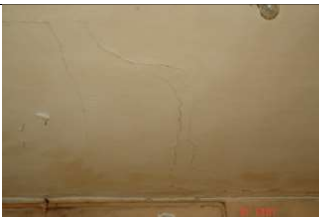
382. Rysy tynku sufitu powstałe wskutek jego ugięcia
