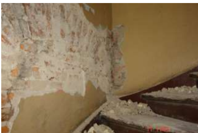
45. Brak prawidłowego przewiązania ścian
