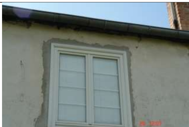
450. Rysa –pionowa i ukośna nad oknem I piętra. Brak nadproża o odpowiedniej długości oparcia, które by przeniosło siły poziome. Brak również wieńca ściany zamykającego sztywną pionową tarczę ściany parteru. Brak wieńca uwrażliwia ścianę na skutki nierównomiernego osiadania fundamentów.
