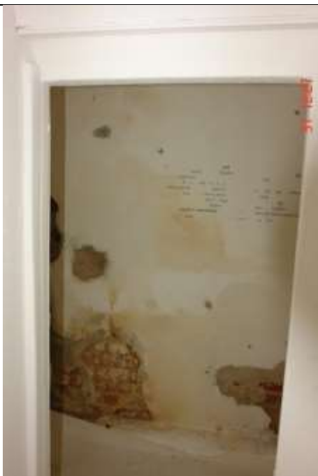
326. Wikwity wilgoci na ścianie w pomieszczeniu pozbawionym wentylacji. Od-padający tynk
