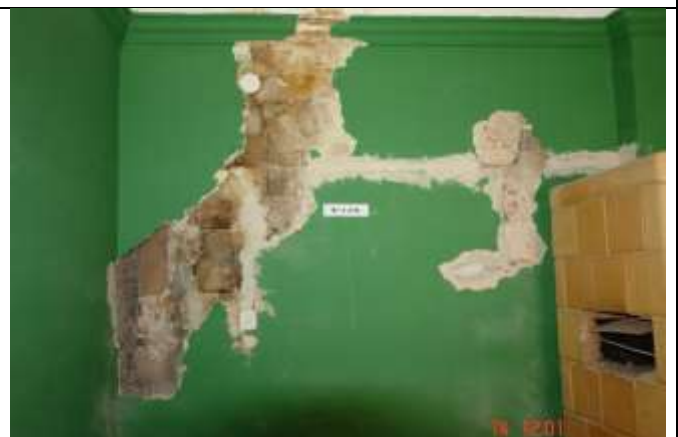
285. Zamjurowany owtwór drzwiowy z widocznym sklepieniem wypełnienia bez należytego przewiązania. Z lewej materiał ściany zróżnicowany bez przewiązania.
