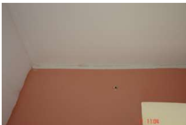
46. Szczelina pomiędzy sufitem a ścianą na styku okładzin z płyt g-k. Niepoprawnie wykonany styk.
