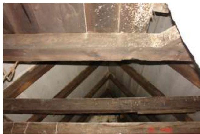
115. Ubytki w postaci wcięć w jętcie.
