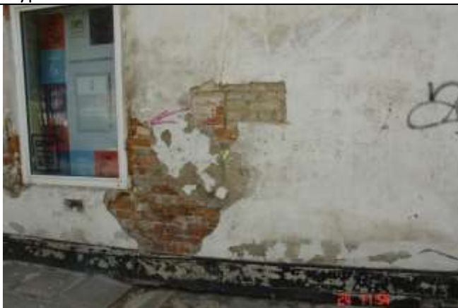
511. Brak przewiązania pomiędzy wypełnieniem otworu w murze a murem pierwotnym
