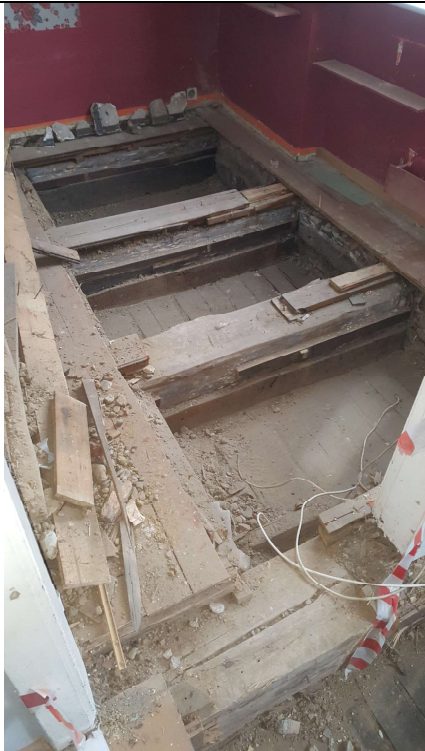
Fot. Widok gniazd głównych belek stropowych budynku Głównego w strefie dawnej sieni
