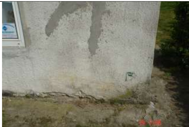
501a. Rysa pionowa w narożu muru zachodniego przybudówki.
