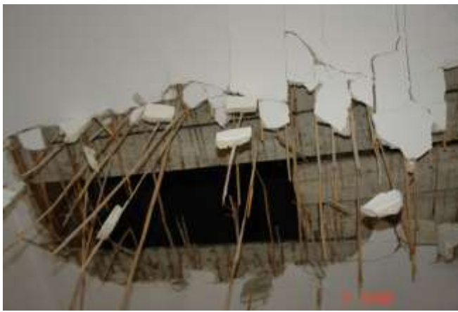
91. Odkrywka sufitu. Strop poddasza wykonano jako „ślepy pułap”. Od spodu warstwa tynku narzuconego na matę z trzciny mocowanej do desek przybitych do belek konstrukcji stropu poddasza.
