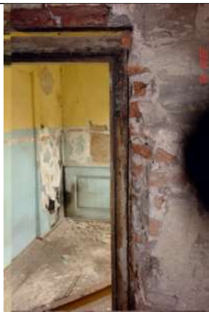
315. Zniszczona drewniana fytryna drzwi. Ubytki w ościeżu otworu drzwiowego.
