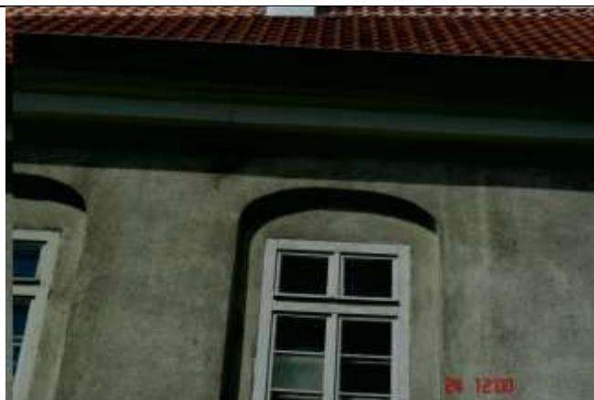
480. Rysa pionowa gzymsu i sklepienia nadokiennego
