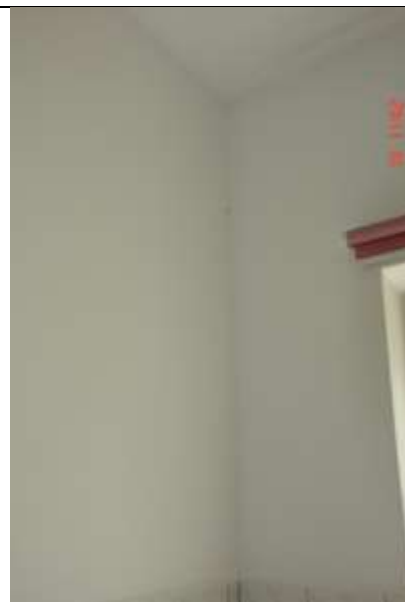
253. Rysa pionowa w styku ścian, ściany zewnętrznej podłużnej i działowej.
