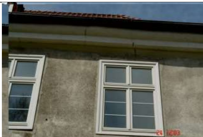
465. Rysy pionowe biegnące przez gzyms do krawędzi otworu okiennego.
