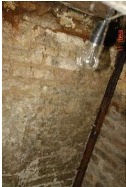
40. Silnie zawilgocony mur piwnicy.
