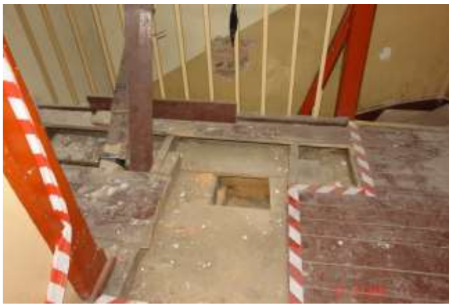
65. Odkrywka stropu nad parterem przy schodach klatki schodowej. Strop wykonano jako „ślepy pułap”
