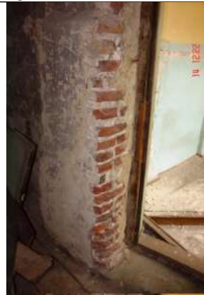
313. Niestarannie wzniesiony mur. Zbyt grube spoiny i ubytku lica ościeża otworu drzwiowego.
