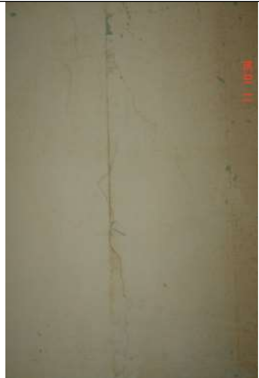
8. Rysy reologiczne na tynku
