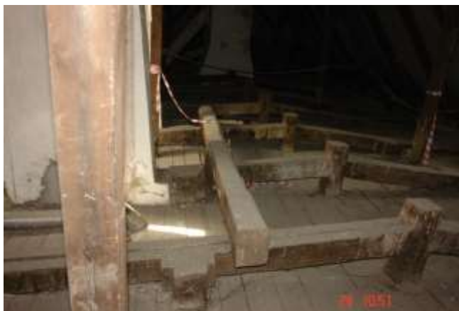
194. Podparcie dźwigara stropu poddasza na belce wymianu. Belka o przekroju 24/32 cm swobodnie oparta na dźwiraach skrajnych i spieta wieszakioem z pasem górnym i dolnym skrócenego dźwigara.
