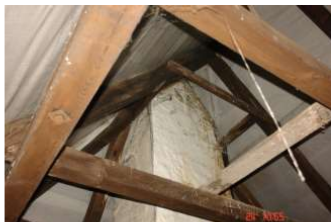
207. Zbyt mała odległość elementów drewnianej konstrukcji od komina
