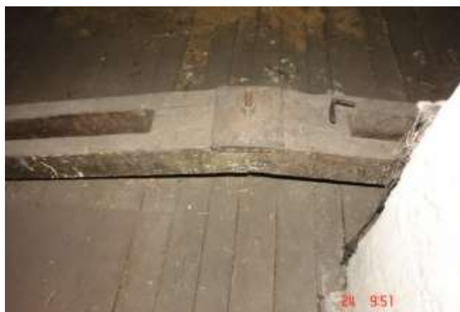
117. Zwornik dźwigara stropowego, wieszarowego wykonanego z bala drewnianego jak dolnego pasa o przekroju \sim 10/24 . Wieszak wykonano z obustronnie nagwintowanego trzcienia stalowego o średnicy \sim 22 mm docisnięty nakrętką M20 poprzez podkładkę gr. \sim 6 mm.
