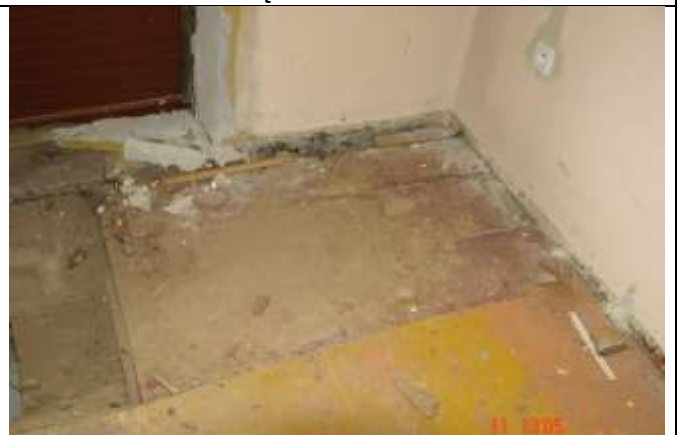
389. Pionierotnie ułożone deski podłogowe pokryte płytą pilśniową twardą.
