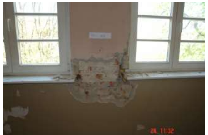
99. Odkrywka styku filara m/okiennego z murem podokiennym. Zmniejszono światło otworów okiennych poprzez domurowanie warstwy cegły na stojąco bez przewiązania z filarem. Cenia filara.Sam filar jak i mur w dobrym stanie technicznym.
