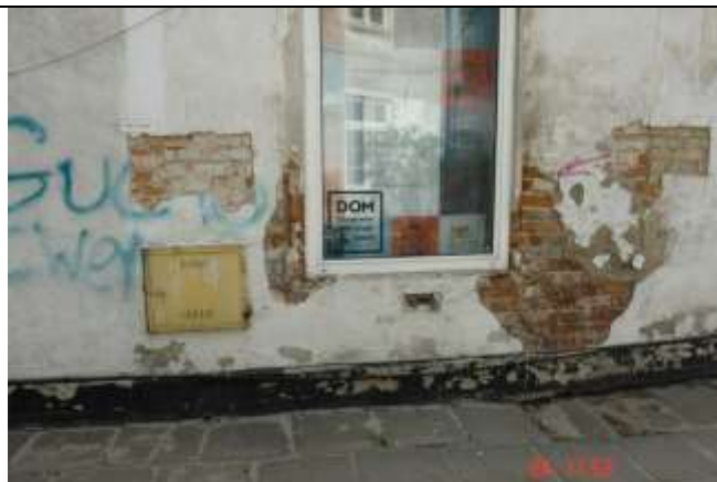
512. Pomniejszenie szerokości otworu okiennego poprzez domurowanie warstwy cegieł gr. ¼ c.. Brak przewiązania cegieł.
