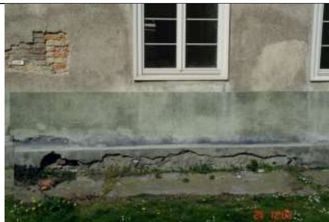
466. Styk dylatacyjny pomiędzy częściami budynku wzniesionymi w różnych okresach. Pod oknem pionowa rysa od poziomu terenu do krawędzi okna. Zniszczony cokół okładziny ściany wskutek braku warstw hydroizolacyjnych
