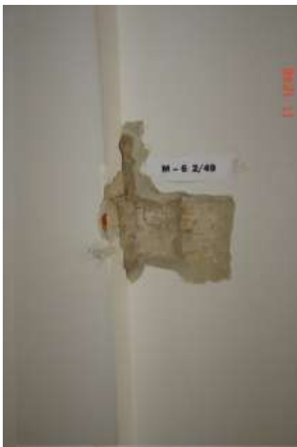
89. Odkrywka naroża ściany kominowej w pom. nr 11/6. Brak należytego przeiązania muru, użycie zróżnicowanych rodzajów cegieł. Cegły pełnej ceramicznej „gotyckiej” oraz „holenderki”. Obydwie cegły różnią się zasadniczo wymiarami. Cegła „gotycka” ~13x7x29 cm, cegła „holenderka” ~10x4,5x20 cm. Ślady próby naprawy ściany i zredukowania ilości występujących rys.
