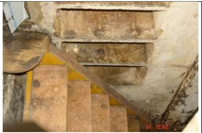
349. Zejsście schodami drabinistymi do piwnicy. Stan pótek taki sam jak i ścian. Pokryte pleśnią, wilgotne.
