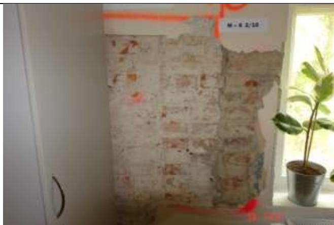
252. Widoczne zwężenie światła i otworu okiennego wykonane w dwóch fazach eksploatacji budynku. Obydwie wykonano wadliwie nie zachowując należytego [przewiązania cegieł.
