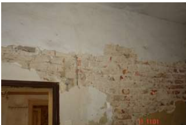
43. Nieprawidłowo ułożone cegły muru klatki schodowej. Brak poprawnego przewiązania poszczególnych warstw z wymaganym wzajemnym przesunięciem cegieł.
