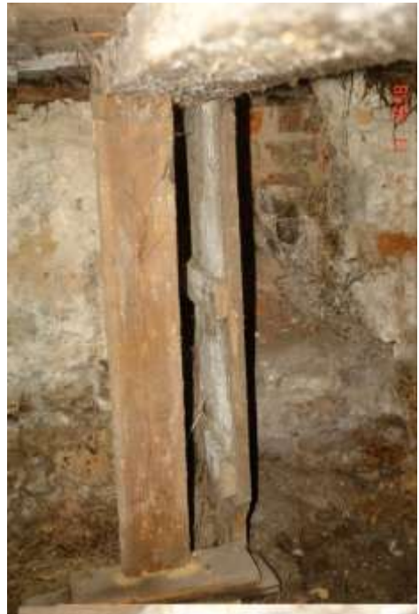
38. Dodatkowe, prowizoryczne podparcie belek stropu nad piwnicą. Bal podpory zaatakowany przez owady. Na desce podstawy wysypująca się lignina przetworzonego przez owady drewna.
