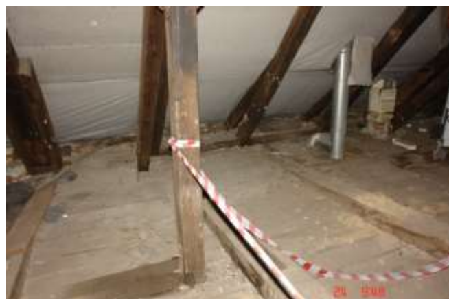
103. Przejście kanałem wentylacyjnym i spalinowym przez strop poddasza. Brak dostatecznej warstwy ocieplającej kanał. Na podłodze wokół kanału i po drugim popdartym bosym końcem z wyczystką, na deskach podłogi, zailgocenia od spływającej po ścianie wody z wykroplonej pary wodnej. Złącza pomiędzy belką wiązarową i jednocześnie stropową a wieszakiem wykonano z płaskownika o szerokości ~50 mm i grubości ~5 mm, skręcone trzpieniami \phi 16
