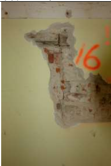
244. Szczelina na styku muru pierwotnego i wypełnienia otworu w murze brak niezbędnych strzępi. Deska nadprożowa składa się z dwóch elementów stykających się w miejscu styku wypełnienia z murem. Wypełnienie wykonano w innym okresie aniżeli wzniesienie ściany szczytowej ]. Jest wykonane z innej cegły aniżeli mur.
