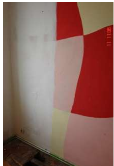
50. Rysy ukośne na ścianie poprzecznej. Odpajanie się powłoki szpachlowej od podłoża pod wpływem przemieszczania się części ściany.
