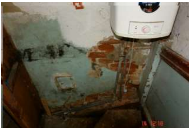
304. Wskutek działania wilgoci powstającej wskutek kapilarnego podciągania wody gruntowej, przy braku hydroizolacji ścian. Cegła ulega złuszczeniu. Na ścianie liczne miejsca pokryte pleśnią.
