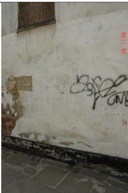
509. Pionowa szczelina wzdłuż nieprzewiązanego styku wypełnienia byłego otworu w murze. Brak przewiązania cegieł pomiędzy murem a jego wypełnieniem.
