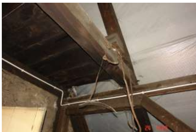
114. Widoczny wymian podpierający krokiew pośrednią kolidującą z kominem.
