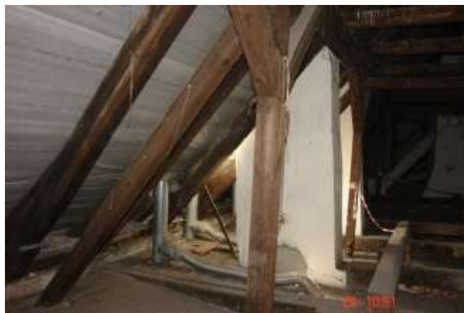
193. Kanał wentylacji grawitacyjnej z pomieszczeń sanitarnych wykonano z przewodu elastycznego ułożonego w części na podłodze i z zagięciami powyżej podłogi. w zdecydowanym stopniu utrudnia to zarówno odprowadzenie spalin z piecyków gazowych jak i wentylacji pomieszczeń. Poza tym wykraplająca się na kanale para wodna spływa na drewnianą podłogę.
