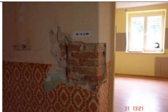
411. Brak przewiązania pomiędzy domurowanym filarem a murem ciągłym. Szeroka szczelina całkowicie oddzielająca filar
