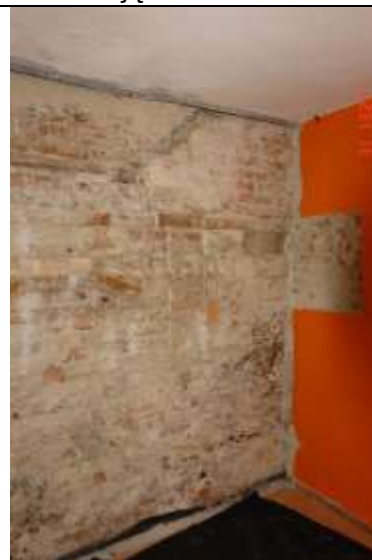
413. Jak fot.412. Fragment wypełnienia wykonano z cegłą na płask gr ¼ c. Rysy ukosne biegnące od krawędzi byłych otworów ku górze
