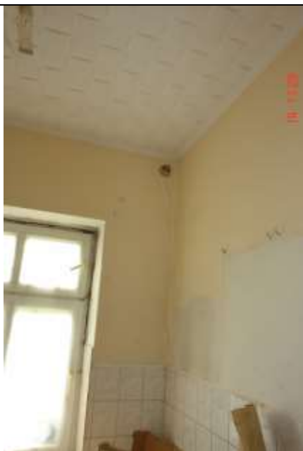
236. Rtysa pionowa wzdłuż styku ściany działowej i zewnętrznej
