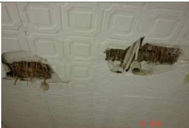
320. Konstrukcja stropu typu ślepy pułap z spodnim deskowaniem pokrytym czciną i tynkiem. Instalacja elektryczna bez wymaganej osłony NRO kabli.
