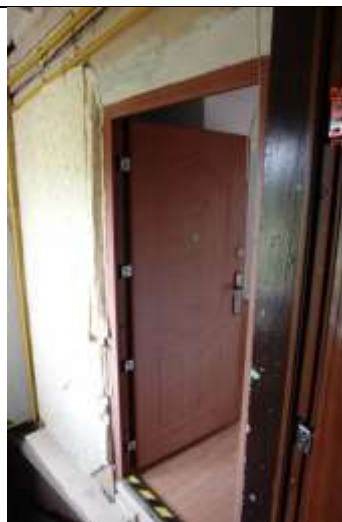
431. Nieprawidłowo usytuowane wejście do lokalu mieszkalnego. Brak spocznika przed drzwiami. Wyjście bezpośrednio na stępie schodów klatki schodowej.
