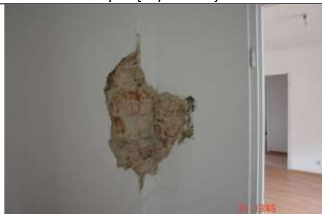
437. Brak przewiązania ścian
