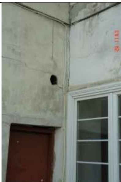
543. Pionowa szczelina pomiędzy dobudówką a głównym korpusem budynku. Szczelina pozioma przechodząca w ukośną
