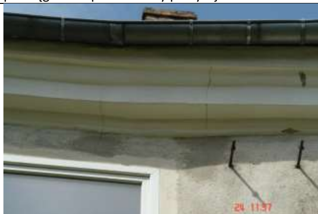
495. Rysy pionowe gzymsu i nadproża. Brak wieńca w koronie muru
