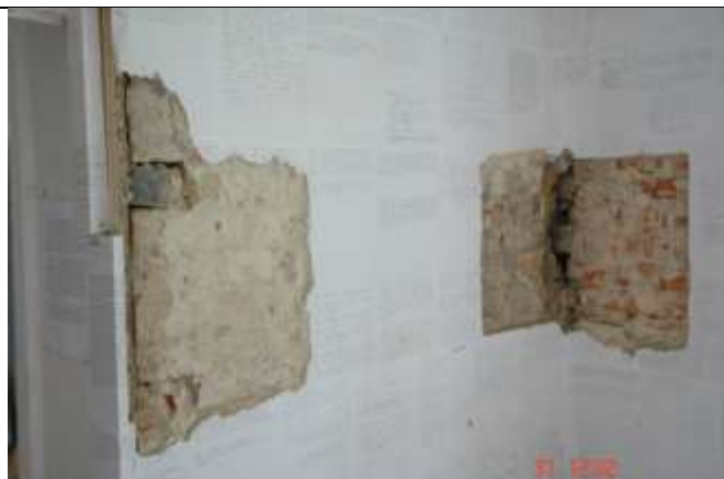
333. Duża szczelina i brak przewiązania pomiędzy ścianami
