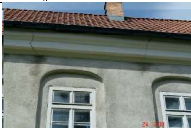
482. Rysy pionowe gzymsu i ściany świadczące o nierównomiernym osiadaniu pionowej tarczy ścian.
