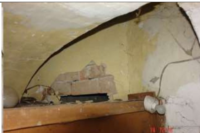
305. Zniszczenie ściany podsklepiennej wraz nadprożem.
