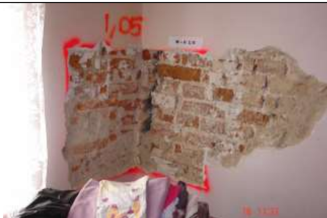
240. Szczelina o znacznej rozwarości w narożu ściany zewnętrznej podłużnej i szczytowej oddzielającej część wysoką budynku od dobudowanej części parterowej.
