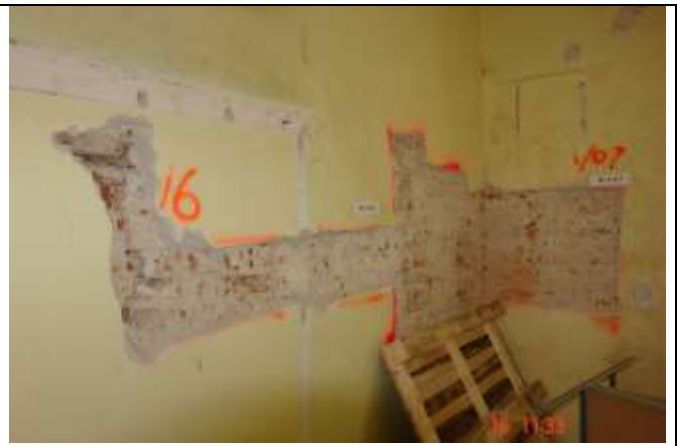
243. Odkrywką wążki ściany szczytowej wraz z narożem ściany zewnętrznej, podłużnej. Z lewej, drewniana deska nadprożowa zamurowanego otworu wejściowego.
