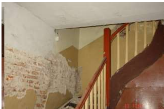
44. Wmurowane w wątek muru sklepienie odcinkowe odciążające lub nad byłym otworem
