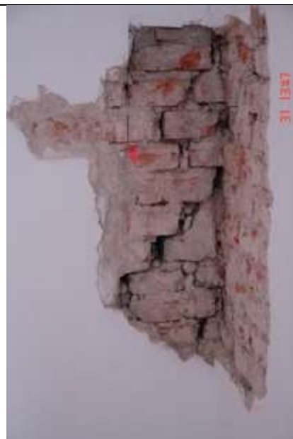
441. Zniszczenie styku nieprzewiązanych ścian wskutek ich wzajemnego zaklinowania w trakcie nierównomiernego osiadania.
