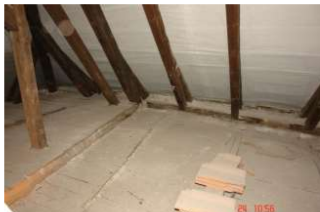
211. Zmiana poziomu podłogiznacze zużyciu desek podłogi. Oparcie desek bezpośrednio na wypełnieniu ślepego pułapu. Brak przestrzeni wentylacji pomiędzy deskami a wypełnieniem
