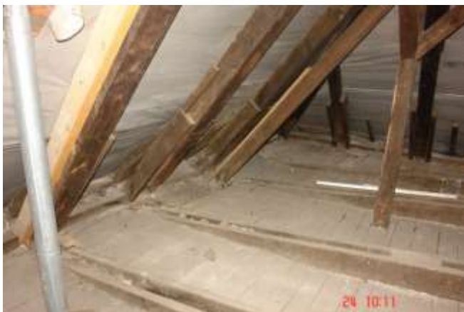
160. W linii styków nakład na krowie na odcinku okapowym widoczne ślady opadającej ligniny będącej wynikiem przerobu celulozy, zawartej w drewnie, przez owady
