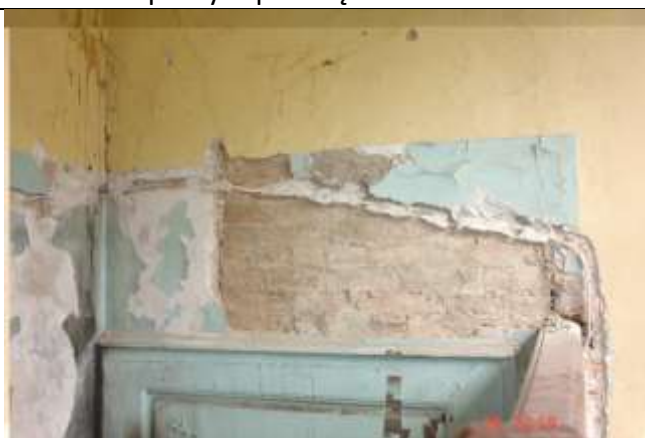
306. Zamurowany otwór drzwiowy bez przewiązania cegieł. Na styku wypełnienia, rysy o rozwarości >0,5 mm
