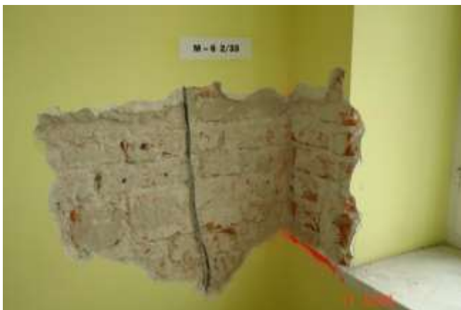
85. Odkrywka styku muru zewnętrznego z konstrukcyjnym murem poprzecznym . Ściany wzajemnie przewiązane i w dobrym stanie technicznym
