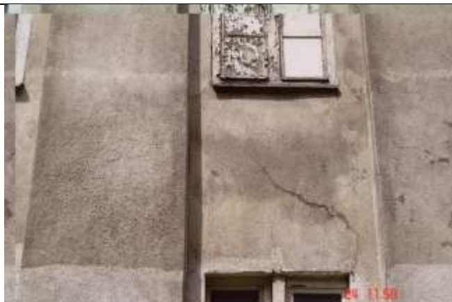
488. Ukośne szczeliny pomiędzy oknami pomiędzy pilastrami.
