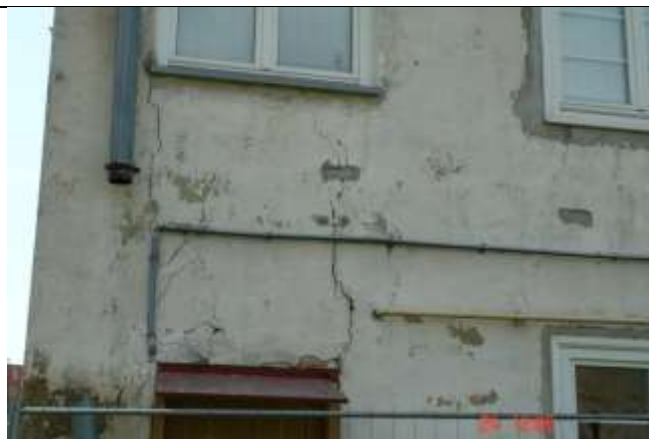
452. Rysy i szczeliny pionowe ściany międzyokiennej wywołane nieskoordynowanymi ruchami odcinków ściany wraz z jej narożnikami. Skutek braku wieńców i nierównomiernego osiadania fundamentów.
