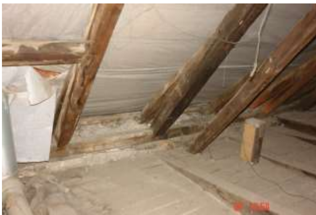
202. Wadliwy montaż membrany i jej zerwanie wokół przejścia kanałem spalinowym przez połąć dachu
