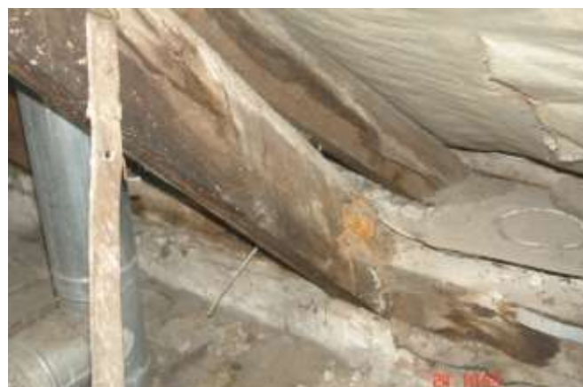
199. Lokalna strefa porażenia owadami i grzybnią konstrukcji więzby.
