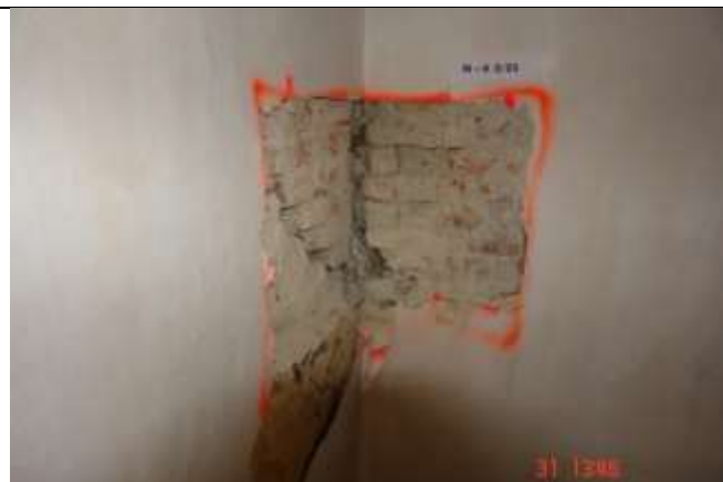
439. Brak przewiązania ścian. Dużą szczelina ukośna
