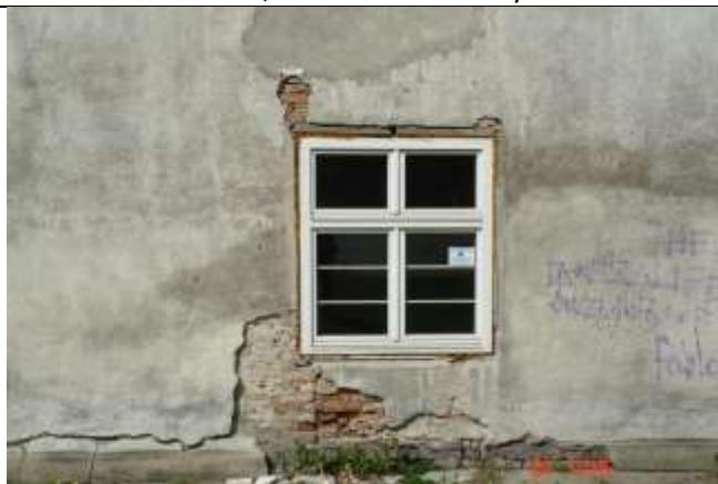
459. Brak nadproża nadokiennego. Otwór okienny powiększono w stosunku do szerokości pierwotnej otworu drzwiowego nie wymieniając belki nadprożowej na dostosowaną do rozpiętości otworu. Pierwotną belkę przepołowiono i wypełniono ją szczelinę pomiędzy ramą okienną a murem
