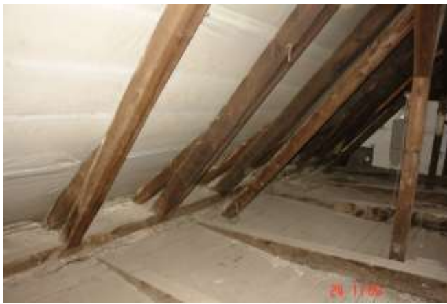
186. QWidok krokwi pośrednich i głównej z wieszakami. Stan techniczny dobry. Zastzrał spięty z belką więźby prętem ciesielskim. Lokalnie występują ślady przecieków pokrycia dachu sprzed jego remontu.
