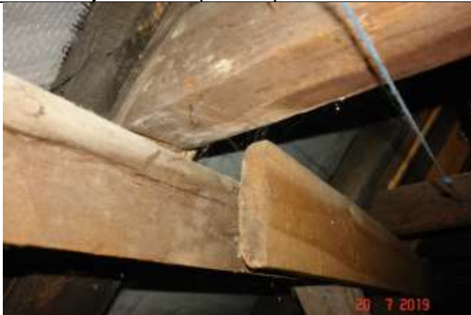
514. Oparcie krokwi na płatwi. Wadliwie wykonanie wzmocnienia płatwi niezgodne ze sztuką budowlaną
