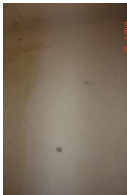
131 Pionowa rysa na ścianie rozszerzająca się ku górze. Rysa powstała wskutek osiadania
