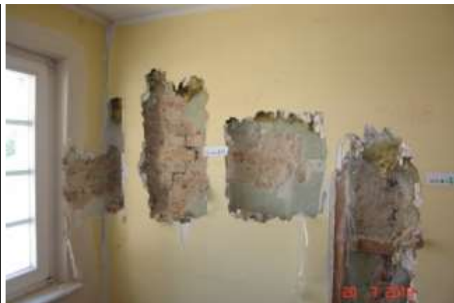
382 Pęknięcia w ścianie zewnętrznej w wyniku nierównomiernego osiadania. Ściana murowana obłożona płytą g-k na ruszcie drewnianym
