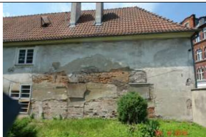
35. Widok skali ubytków lica wątku muru .Wypełnienia byłych otworów bez przewiązania cegieł.
