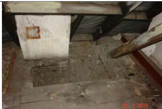
526. Odkrywka przy kominach w stropie nad piętem. Widoczny wymian drewniany komina w konstrukcji dachu
