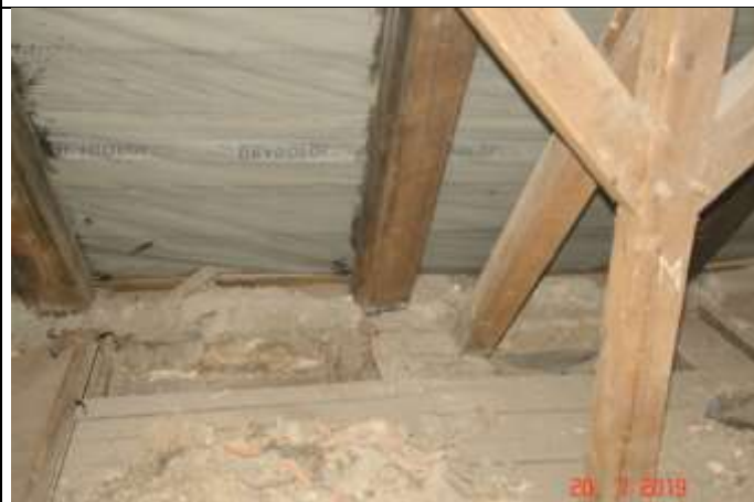
562. Odkrywka w stropie nad piętrem. Widoczna obustronna nadbitka na krokwiach
