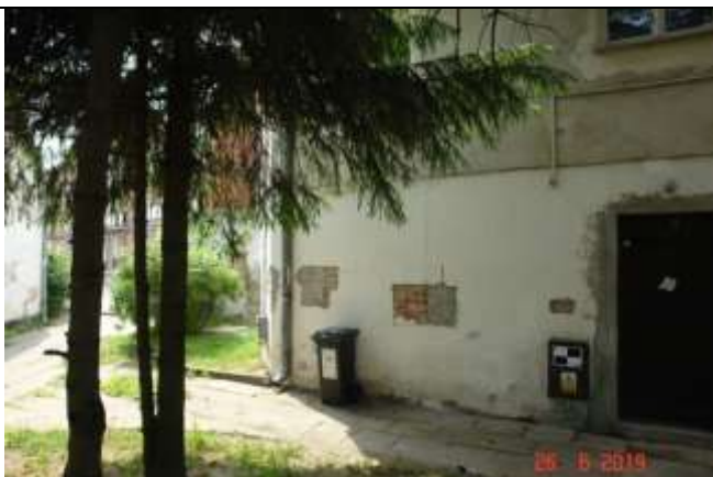
50. Szczelina pionowa w styku wypełnienia otworu drzwiowego z murem pierwotnym. Rysy ukośne muru nad nadprożem otworu drzwiowego.
