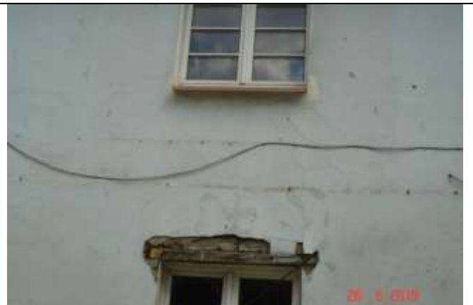
69. Drewniane nadproże o niedostatecznej głębokości oparcia. Równoległe rysy ukośne w murze pomiędzy otworami okiennymi i drzwiowymi.
