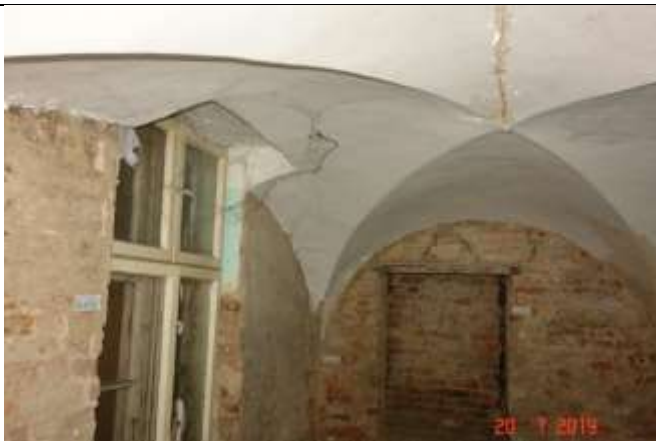
164 Sklepienie ceglane. Widoczny fragment zamurowanego otworu w kolejnej fazie eksploatacji
