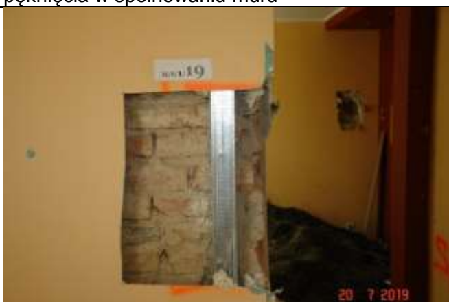
152 Niestarannie wykonany mur. Miejscami brak przewiązania cegieł w murze. Brak poziomu w ułożeniu kolejnych warstw. Zbyt grube spoiny.
