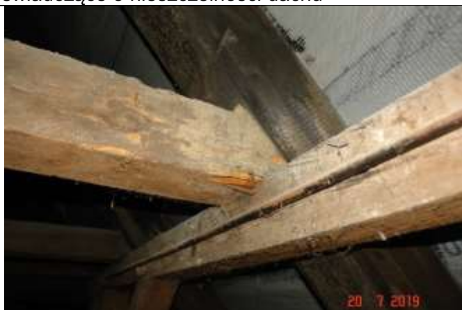
578. Oparcie krokwi na płatwi. Połączenie jętki z krokwią
