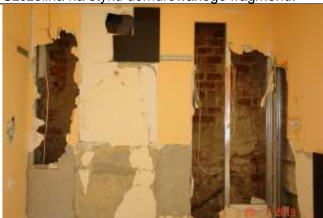
150 Ściany murowane obłożone płytą g-k na ruszcie. Liczne i głębokie ubytki zaprawy. Lokalne pęknięcia w spoinowaniu muru
