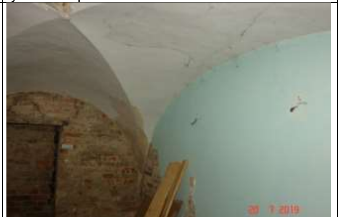
165 j.w. Widoczne rysy ukośne w wyniku nadmiernego zginania nadproża, biegnące od miejsca oparcia w kierunku sklepienia.
