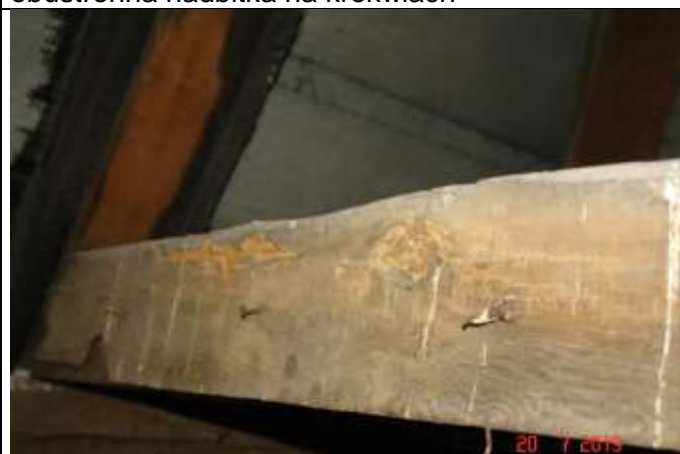
558. Odkrywka w stropie nad piętem. Widoczna obustronna nadbitka na krokwiach
