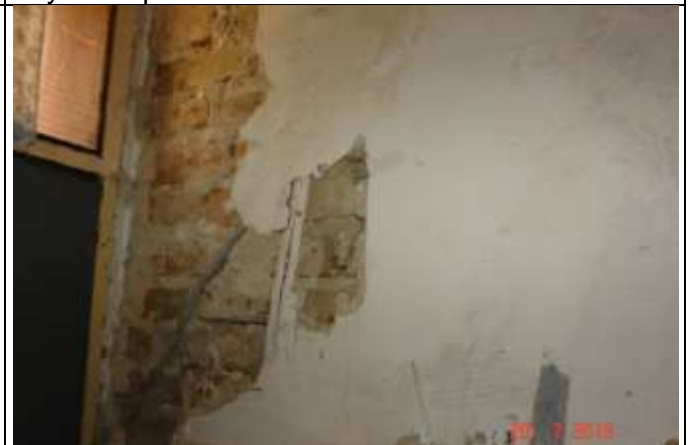
163. Ubytki w spoinowaniu ściany murowanej. Pęknięcia elementów murowanych. Widoczne rysy w wyniku wyczerpania właściwości materiałowych tynku oraz przekroczenia nośności muru.
