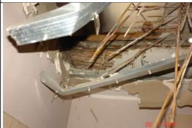
143 Odkrywka przez całą grubość drewnianego stropu nad parterem.
