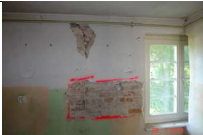
340319 Widoczna zmiana usytuowania otworu okiennego - wykonano w dwóch fazach eksploatacji budynku. Mur wzniesiony wadliwie nie zachowując należytego przewiązania cegieł
