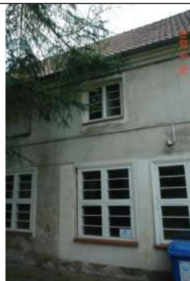
45. Liczne rysy ukośne równoległe pomiędzy nadprożem okna parteru a prawym dolnym narożem okna na piętrze
