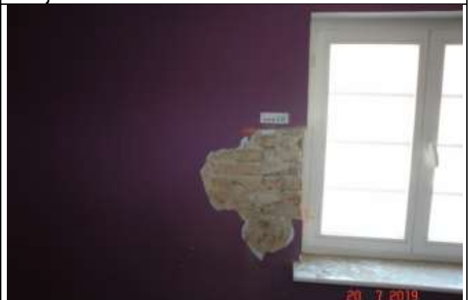
363 Widoczne zwężenie światła i otworu okiennego wykonane w dwóch fazach eksploatacji budynku. Widać szczelinę w miejscu wadliwego ułożenia cegieł bez przewiązania
