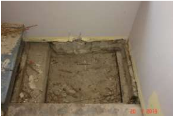
Okrywka w miejscu oparcia stropu drewnianego na murze.
