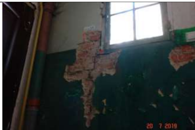
301. Rysa pionowa biegnąca od naroża otworu okiennego ku dołowi powstała na skutek naprężeń rozciągających w strefie podokiennej. Wynik zużycia materiałowego przy braku zabezpieczenia strefy podokiennej zbrojeniem w spoinach wspornych. Łuszczenie farby.
