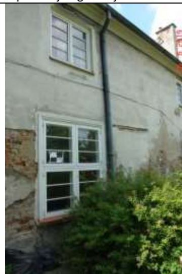
39. Rysy nad nadprożem wskutek jego stopniowej degradacji. Ubytki lica muru.
