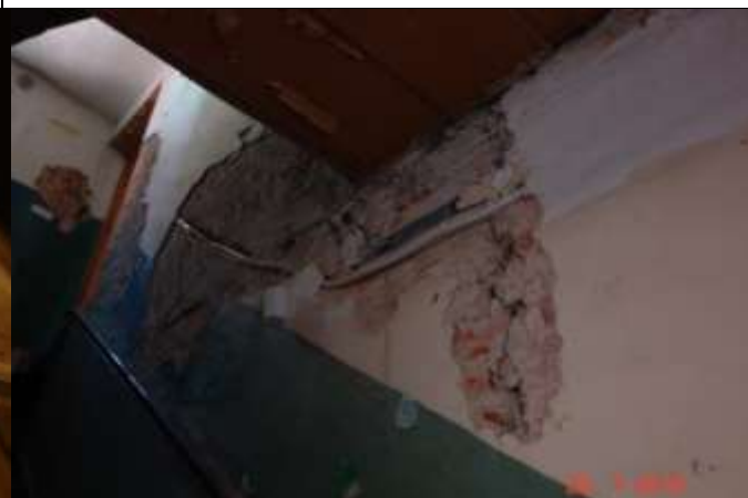
113. Pęknięcie pionowe ściany nośnej klatki
