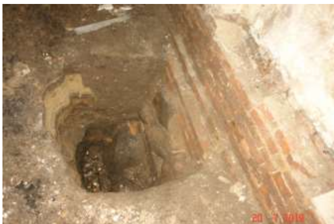
126. Odkrywka ław fundamentowych
