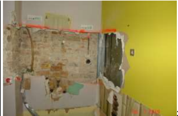
Ściana sanitariatu. Widoczne zacieki
