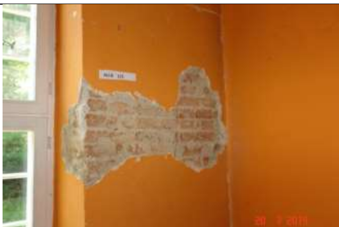
136 Odkrywka murowanej ściany zewnętrznej budynku. Mur w dobrym stanie techniczny
