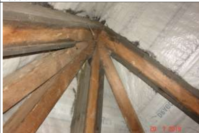
509. Połączenie krokwi w kalenicy. Widoczne nadbitki na krokwiach
