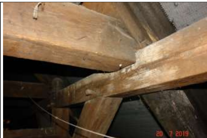
530. Oparcie krokwi na płatwii. Połączenie jętki na wrób
