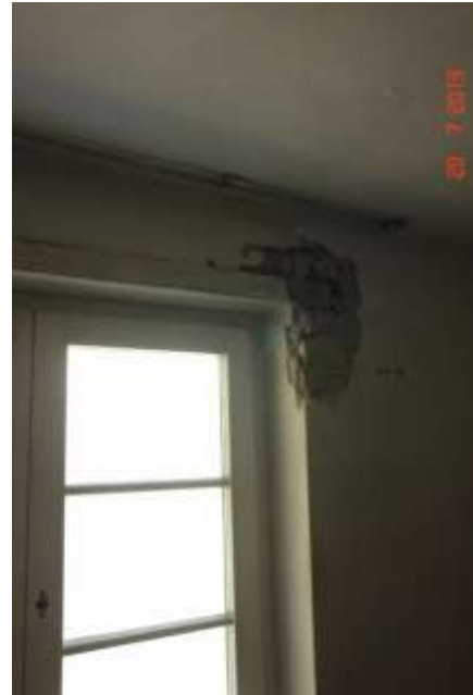
313. Pęknięcia w miejscu oparcia nadproża drewnianego na murze
