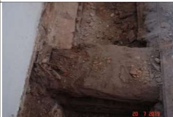
310. Belka na podporze - zgorzel brunatna na głębokość 1/3 górnej części belki
