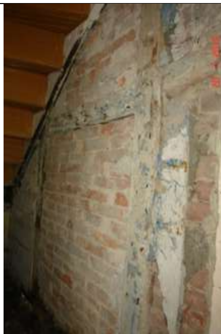
117 Ściana ryglowa klatki schodowej. Widoczna spora szczelina na styku rygla i wypełnienia z muru świadczy o osiadaniu ceglanego wypełnienia.
