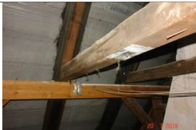
510. Połączenie krokwi z jętką. Oparcie krokwi n płatwi
