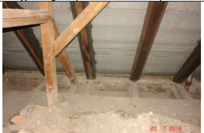
503. j.w. Sposób łączenia rozpórki ze stolcem i zastrzałem. Widoczne pęknięcie drewna wzdłuż rozpórki w linii blachy
