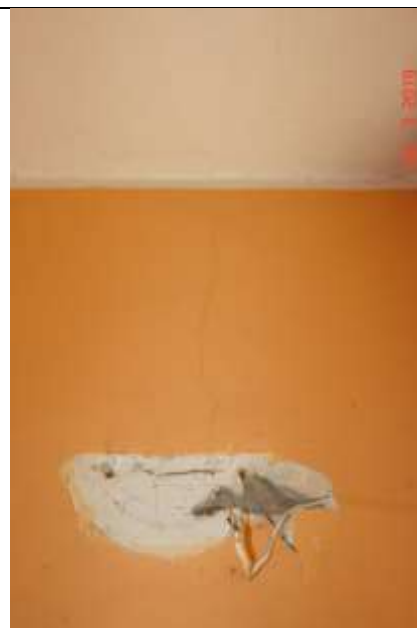
129. Widoczna rysa pionowa w miejscu wyjścia instalacji elektrycznej. Zły stan techniczny tynków
