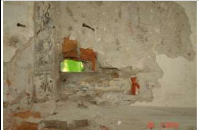
125. Ubytek „na wylot” w ścianie zewnętrznej.
