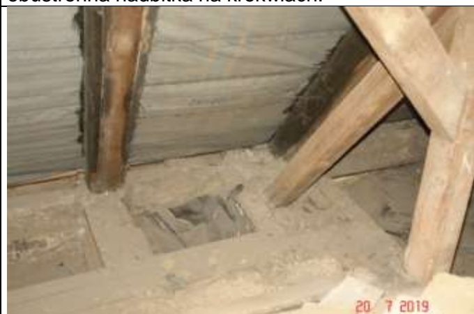
558. Odkrywka w stropie nad piętem. Widoczna obustronna nadbitka na krokwiach
