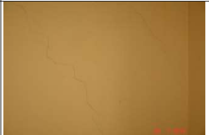
159 Widoczne znaczne rysy ukośne świadczące o nierównomiernym osiadaniu fundamentów.
