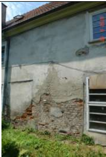
36. Jak fot.35. Bardzo głębokie ubytki wątku muru.
