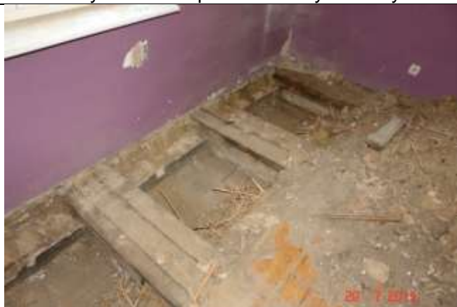
362 j.w. początki korozji krawędziowej belki drewnianej.
