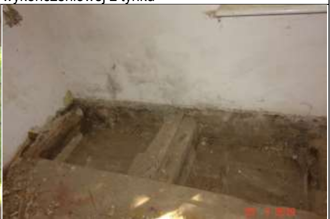
327 Odkrywka w miejscu oparcia belek drewnianych stropu na murze. Widoczna wilgoć - brak izolacji na połączeniu drewnianej konstrukcji z murem. Widoczna wsuwkową konstrukcja stropu nad parterem
