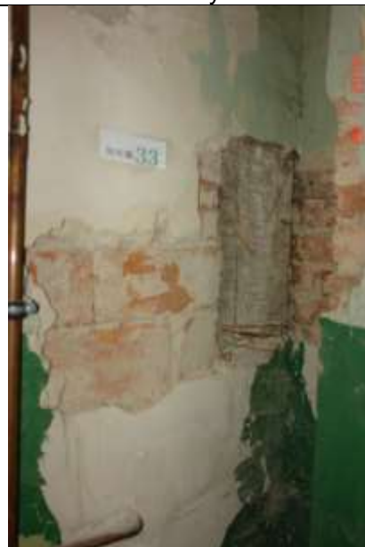
301. Rysa pionowa biegnąca od naroża otworu okiennego ku dołowi powstała na skutek naprężeń rozciągających w strefie podokiennej. Wynik zużycia materiałowego przy braku zabezpieczenia strefy podokiennej zbrojeniem w spoinach wspornych. Łuszczenie farby.
