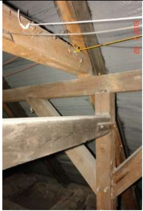
501. Widoczne miejsce oparcia układu krokwiowo-jętkowego na płatwi. Widoczna rozpórka
