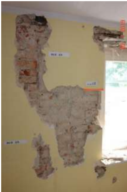
358 Widoczne zwężenie światła otworu okiennego wykonane w dwóch fazach eksploatacji budynku. Przemurowanie wadliwie bez zachowania należytego przewiązania cegieł. Liczne i głębokie ubytki w murze.
