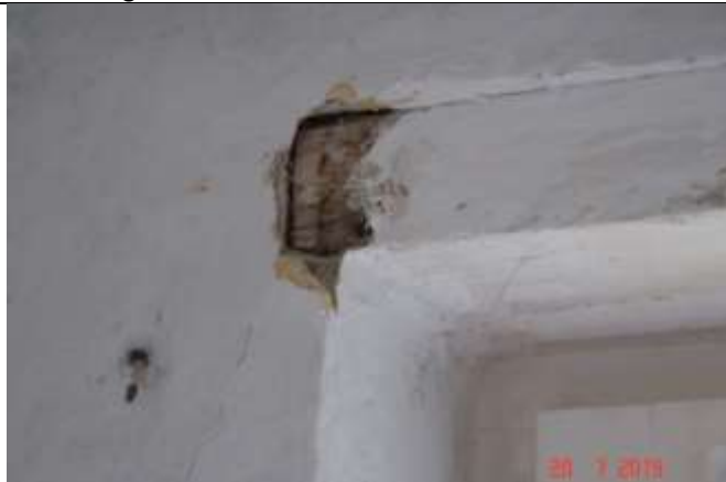
316 Rysa ukośna biegnąca od górnego naroża otworu okiennego powstała na skutek nieprawidłowego (zbyt małego) oparcia drewnianej belki na murze.
