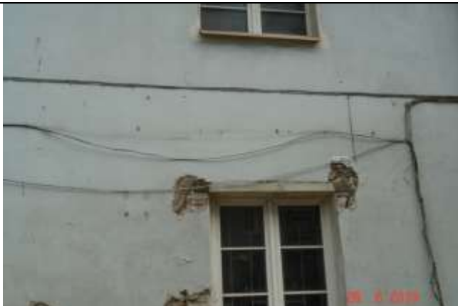
62. Drewniane nadproże w miejscu otworu okiennego wykonanego w ramach kolejnej przebudowy. po lewej fragment pierwotnego nadproża odcinkowego, ceramicznego. Pomiędzy wypełnieniem a otworem pozostawiono filarek bez przewiązania.
