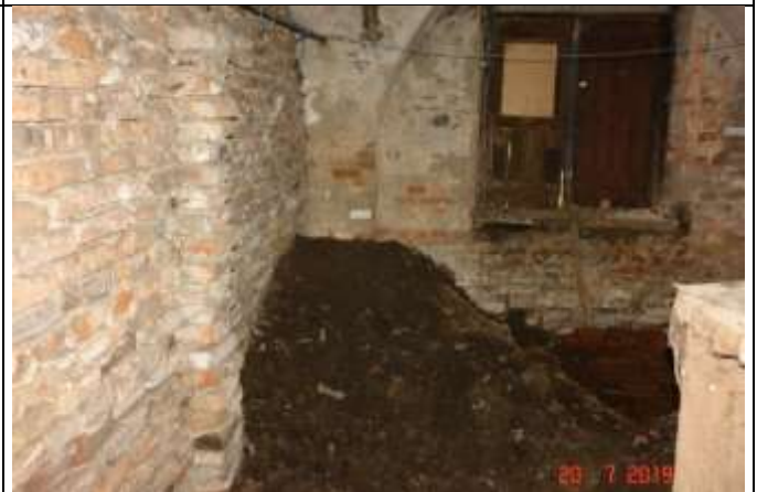
173 Nieprawidłowe wykonanie muru – brak zachowania pionowości i równego lica ściany. Liczne i głębokie ubytki w spoinowaniu i elementach murowanych
