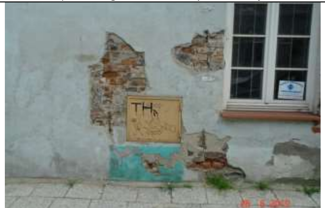
63. Jak fot.62. Brak przewiązania i liczne ubytki lica muru. Odpajający się tynk, wilgoć.
