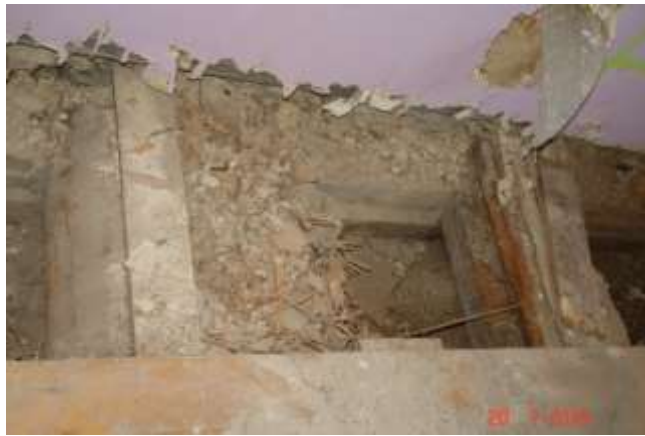
376 Odkrywka w stropie nad parterem w miejscu oparcia belek na murze. Widoczna zgorzel obejmująca lokalnie 1/3 wysokości przekroju belki
