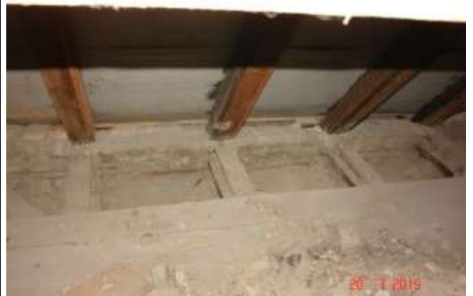
505. Odkrywka w stropie nad parterem. Widoczne wzmocnienie krokwi poprzez nadbítki z desek.
