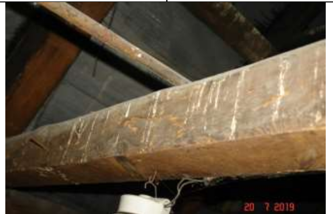
574. Widoczne zaatakowanie jętki przez spuszczel.
