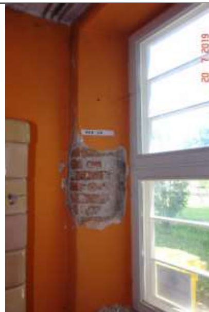
135 Niestarannie wykonany mur - grube spoiny niezgodne ze sztuką budowlaną.
