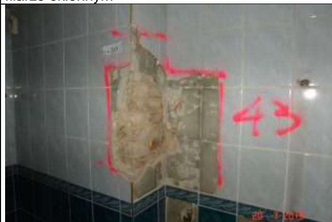
347 Odkrywka w ścianie murowanej kominowej. Mur w dobrym stanie technicznym.
