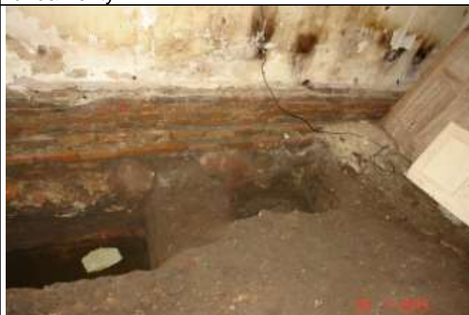
121. Odkrywka z pokazaniem ław fundamentowych. Widoczna stojąca woda gruntowa
