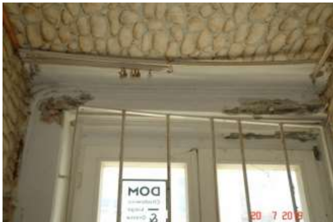
138 Nadproże drewniane. Widoczne ubytki muru w miejscu oparcia drewnianej belki na ścianie.
