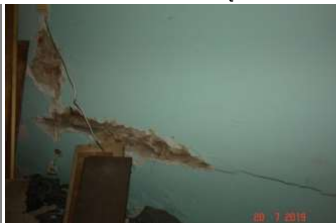
167 Widoczna głęboka rysa pozioma
