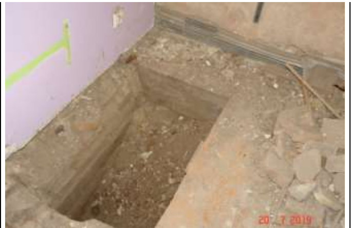
377 Odkrywka w stropie nad parterem w miejscu oparcia belek na murze.
