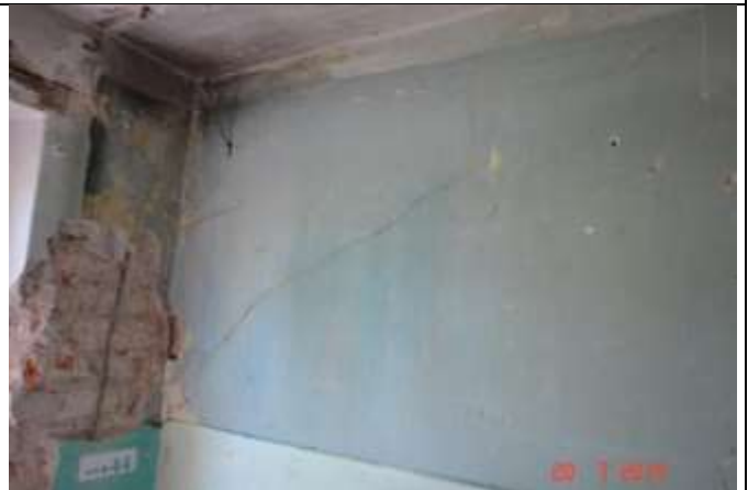
321 Pęknięcie ukośne powstałe na skutek zbyt dużego ugięcia stropu drewnianego poniżej. Łuszczenie farby
