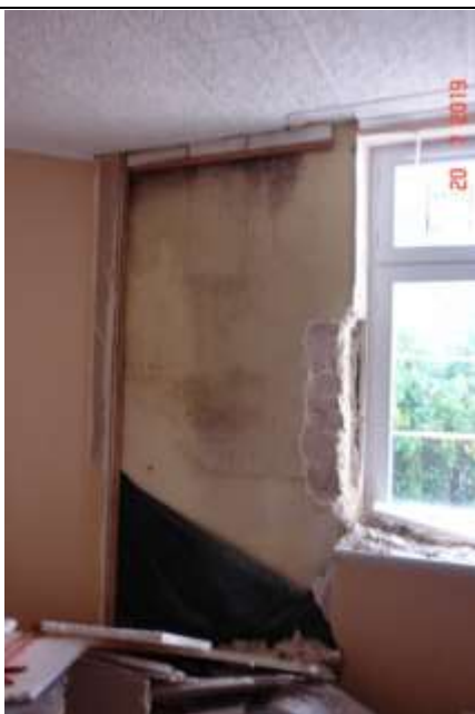
100. Odkrywka przy oknie. Widoczne zacieki od wysokości sufitu świadczące o możliwym zawilgoceniu konstrukcji drewnianej stropu powyżej.
