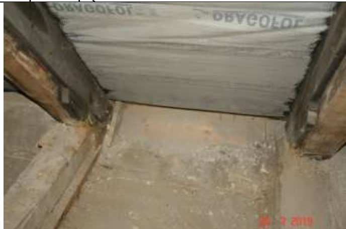
572. Podbitka krokwi od spodu. Kornik w krokwi
