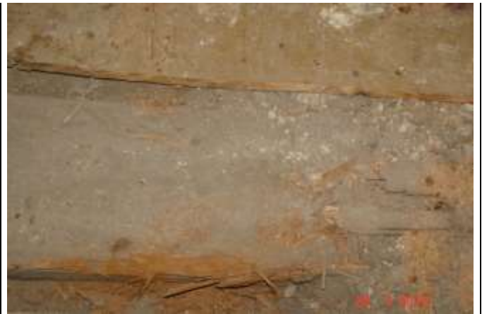
337 Widoczna korozja belki stropowej
