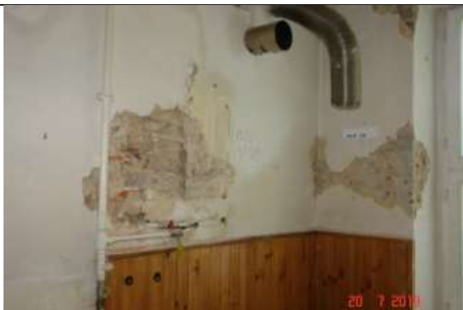
132 Widoczny po lewej brak przewiązania cegieł z domurowanym fragmentem ściany. Po prawej mur w dość dobrym stanie technicznym.
