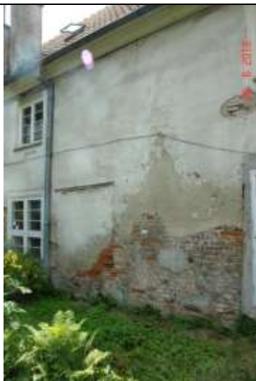
38. Liczne ubytki lica muru o głębokości do 8 cm. Mur silnie nawodniony
