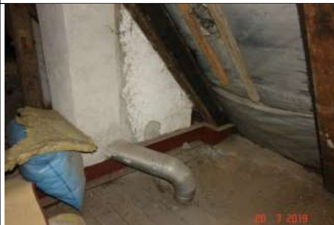
535. Podłączenie przewodów do komina. Brak ciągłości izolacji z folii
