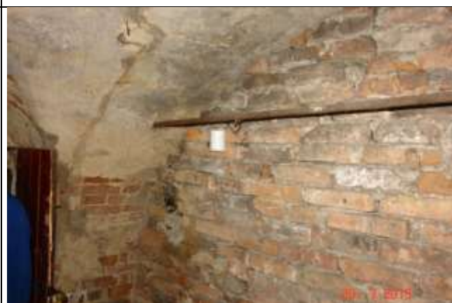
179 j.w. Widoczna lokalnie pleśń
