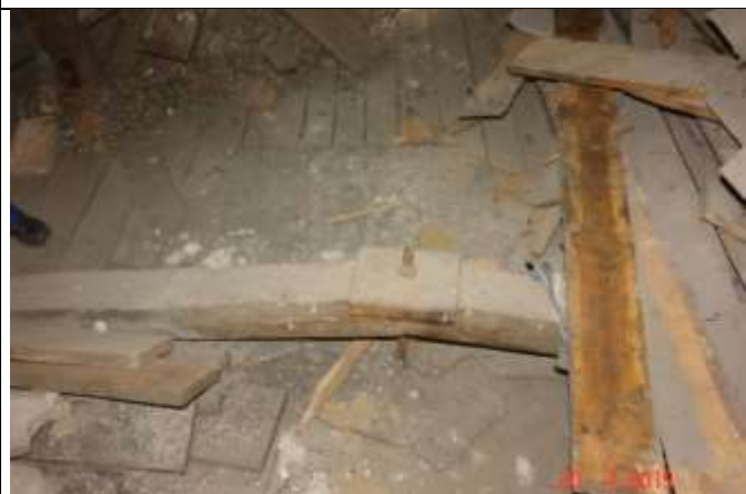
521. Dźwigar drewniany głównego układu nośnego
