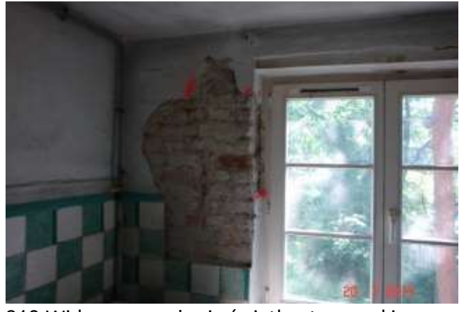
319 Widoczne zwężenie światła otworu okiennego wykonane w dwóch fazach eksploatacji budynku. Wykonano wadliwie nie zachowując należytego przewiązania cegieł.
