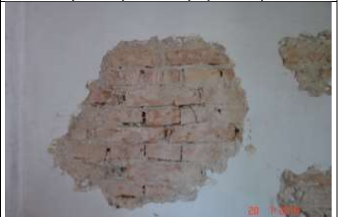
317 Niestaranne wykonany mur. brak poziomu w kolejnych warstwach muru. Liczne i głębokie ubytki w spoinowaniu. Uszkodzenia elementów murowych.
