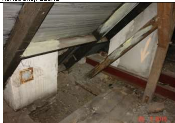
528. Zacieki na kominie świadczące o nieszczelności obróbki przy kominie
