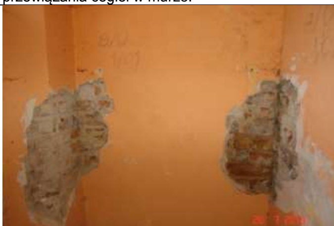
130. Widoczne odkrywki w murze. Brak odpowiedniego przewiązania z ceglami domurowanymi w kolejnej fazie eksploatacji.
