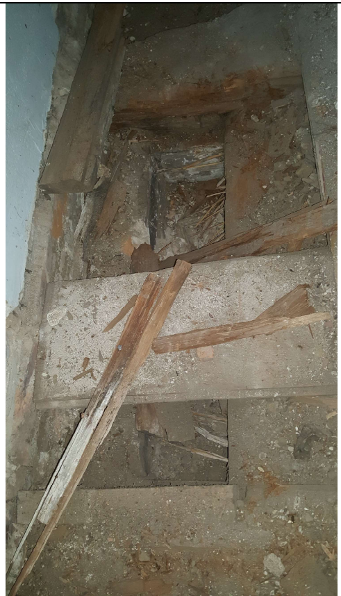
Fot. Widok gniazd głównych belek stropowych budynku Boczego z felcem wsuwkowym
