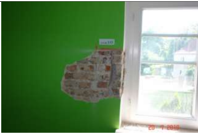
366 Widoczne zwężenie światła otworu okiennego wykonane w dwóch fazach eksploatacji budynku. Wykonano wadliwie nie zachowując należytego przewiązania cegieł.
