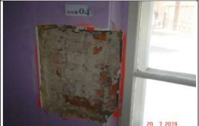
373 Widoczne zwężenie światła otworu okiennego wykonane w dwóch fazach eksploatacji budynku. Wykonano wadliwie nie zachowując należytego przewiązania cegieł.
