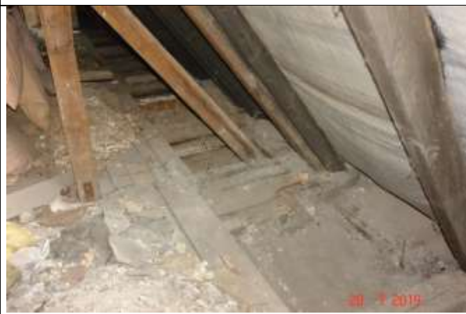
541. Widoczna zgorzel krokwi oraz zastrzału wraz z belką w miejscu połączenia. Sposób oparcia stolca na stropie
