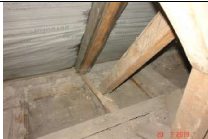
519. Widoczny zastrzał głównego układu nośnego.
