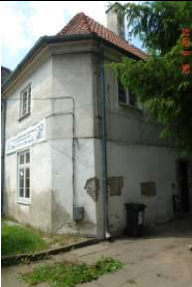
52. Brak przewiązania na styku wypełnienia i pierwotnego muru. Rysy ukośne na ściętym narożu ścian.
