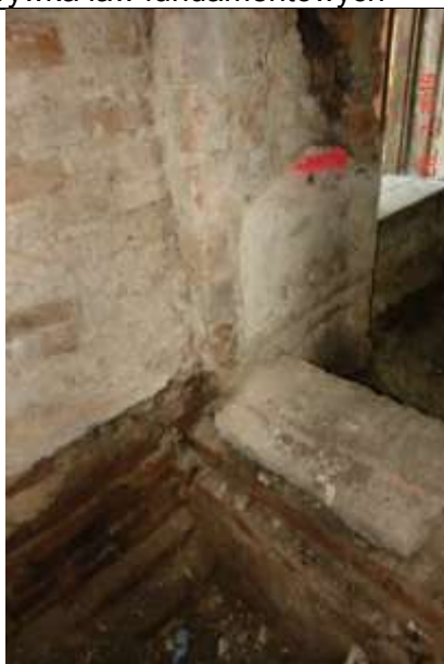
128. Wadliwe wykonane w dwóch fazach eksploatacji budynku ławy fundamentowe. Brak przewiązania cegieł w murze.
