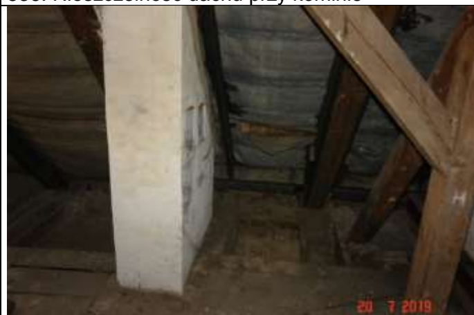
538. Nieszczelność dachu przy kominie - rozdarcie folii. Widoczna odkrywka w stropie nad piętrem. pęknięcie w drewnianym mieczu na skutek zmiany wilgotności
