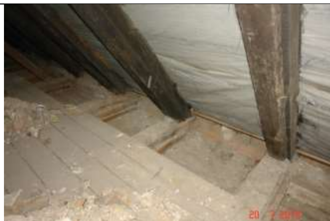
579. Odkrywka w stropie nad piętrem
