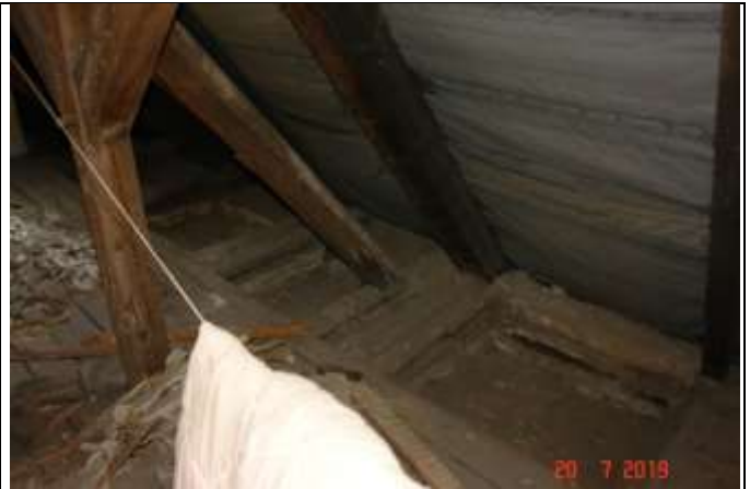
543. Widoczne wysolenia na zastrzale i stolcu.
