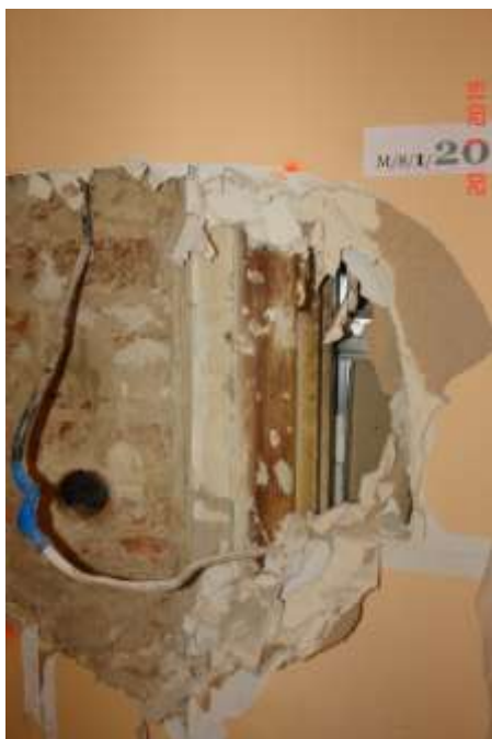
144 Odkrywka w ścianie na styku ściany murowanej i wykonanej z płyt g-k na ruszcie,
