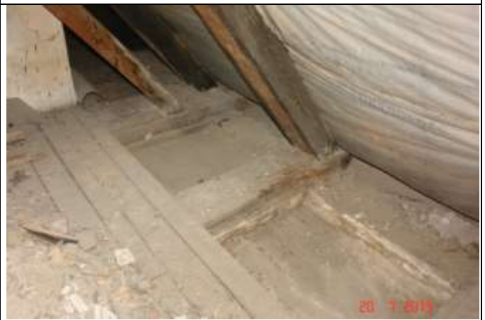
547. Widoczna zgorzel belki obejmująca znaczną część przekroju. Widoczne wykwity soli oraz zacieki na zastrzale. Ognisko korozji w miejscu oparcia krokwi na murze
