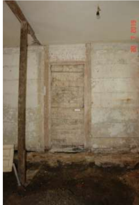
123 Zamurowany otwór w ścianie.
