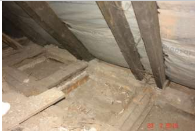
542. Odkrywka w miejscu oparcia krokwi na murze
