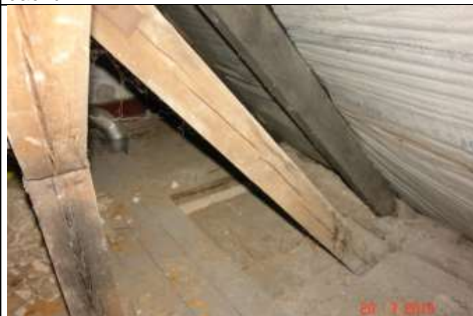
534. Odkrywka w stropie nad parterem. Połączenie zastrzału z belką
