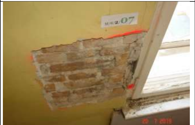
369 Zmniejszenie światła otworu poprzez domurowanie warstwy cegieł bez należytego przewiązania.
