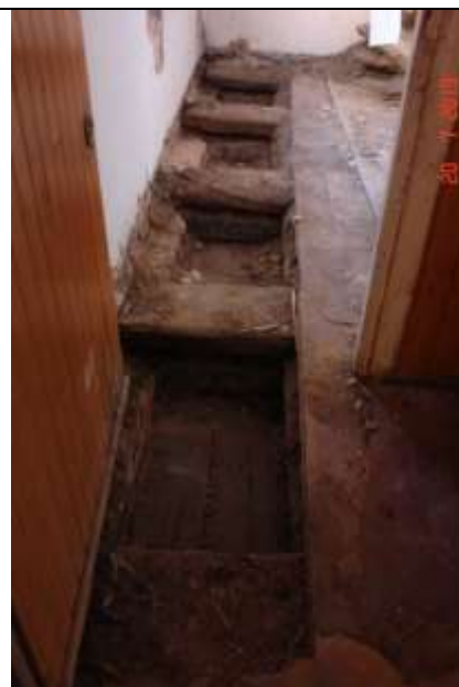
309. Widok na odkrywki w stropie nad parterem
