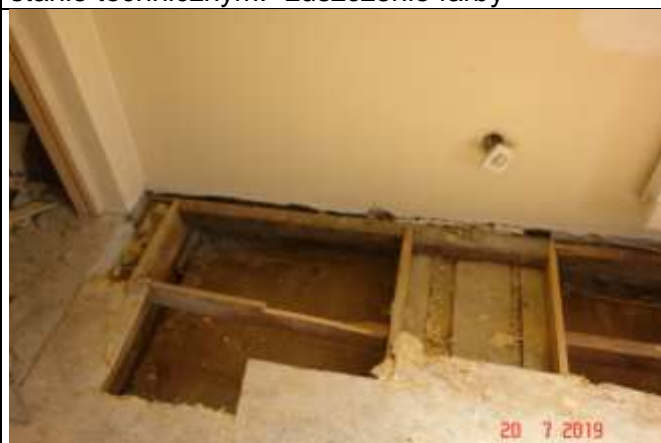
304. Odkrywka w stropie drewnianym.
