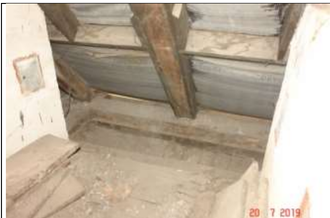
548. Widoczne zacieki na krokwi. Odkrywka w stropie nad piętrem. Nieszczelność dachu - przerwanie w izolacji. Wymian drewniany komina
