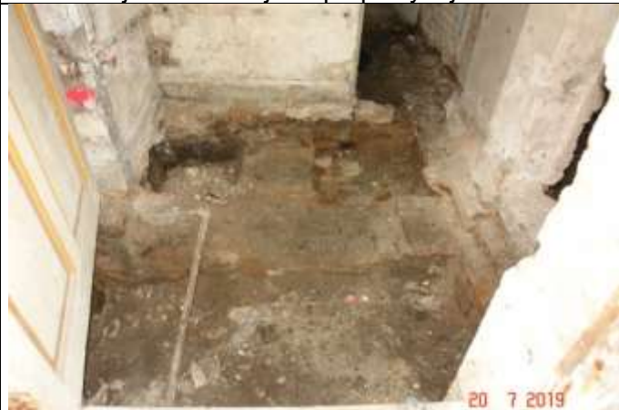
114 Widoczna odkrywka ław fundamentowych. Lokalnie brak przesunięcia cegieł w kolejnych warstwach muru.
