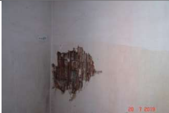
314 Odkrywka ściany z desek z okładziną z tynku ułożonego na trzcinie.
