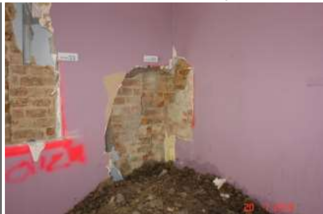
149 j.w. Brak przewiązania ścian w narożu – nieprawidłowe ułożenie cegieł.
