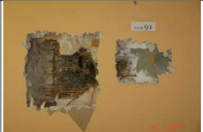
157 Widoczna trzcina pod wykończenie tynkiem.
