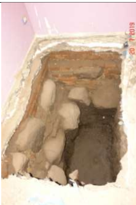
146 Odkrywka fundamentów. Widoczne zastoisko wody gruntowej.
