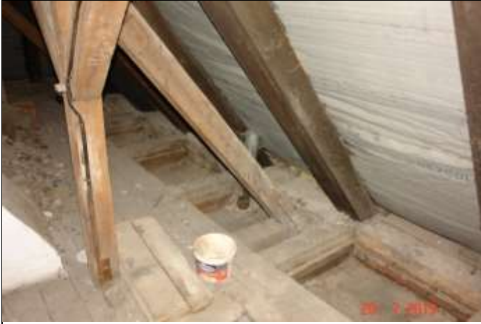
500. Odkrywka w stropie nad parterem. Widoczny stolec z mieczami oraz zastrzał .
