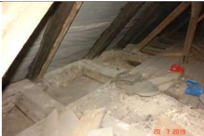
518. Odkrywka w stropie nad parterem. Widoczne wzmocnienie krokwi przez nadbitki.
