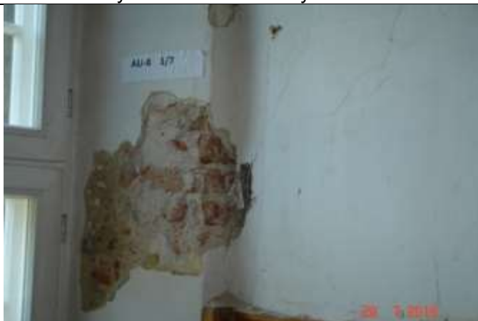
134. Widoczne lokalne przemurowania w filarze . Liczne głębokie rysy ukośne na styku filara ze ścianą działową świadczą o nierównomiernym osiadaniu fundamentów.
