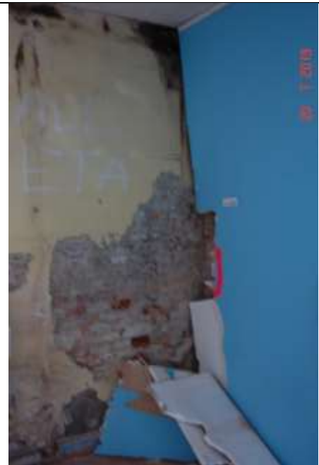
107. Odkrywka w miejscu przewiązania konstrukcyjnych ścian zewnętrznych murowanych. Widoczne rysy świadczące o zużyciu elementów konstrukcyjnych i wyczerpaniu nośności muru.
