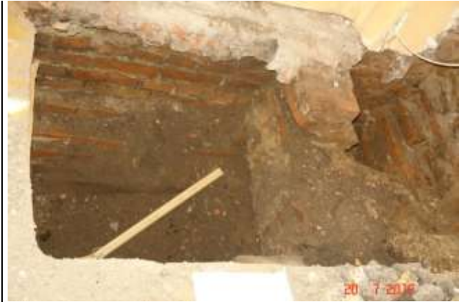
155 Odkrywka fundamentu. Miejscami widoczne niestaranne ułożenie cegieł w murze. W prawym górnym rogu widoczny brak przewiązania cegieł.
