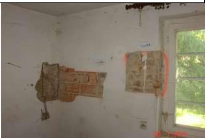
326 Miejsce styku ściany działowej deskowej na szkieletie drewnianym ze ścianą zewnętrzną z wypełnionym otworem od wewnątrz warstwą cegły ceramicznej na romb.
