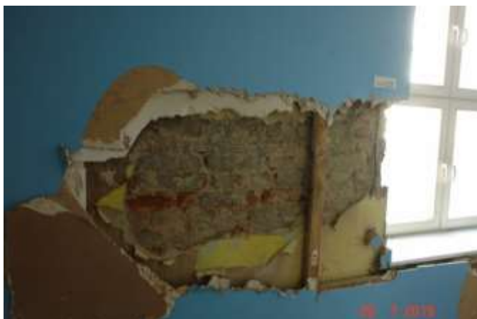
108. Odkrywka w ścianie zewnętrznej murowanej. Widoczne liczne i głębokie ubytki zaprawy. Miejscami nieprawidłowe ułożenie cegieł w murze - brak odpowiedniego przesunięcia cegieł kolejnych warstw.
