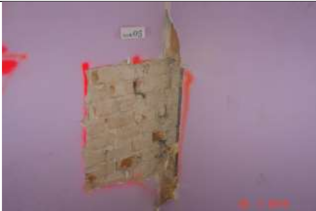
372 Połączenie ściany zewnętrznej i wewnętrznej nośnej. Widoczne pęknięcie w spoinie muru.
