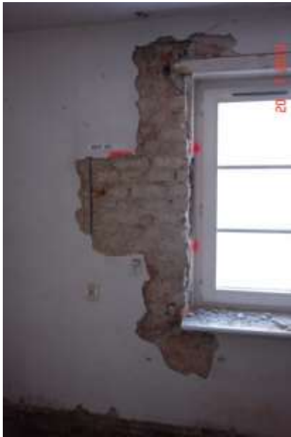
312. Niestaranne ułożenie cegieł w murze. Pęknięcia w strefie oparcia nadproża drewnianego oraz w strefie podokiennej.
