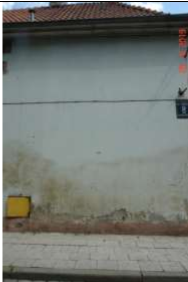
56. Rysy ukośne w dolnej części muru. Wysokie podciąganie kapilarne wody
