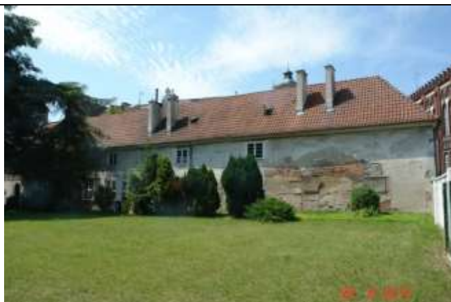
34. Widok fragmentu elewacji wschodniej. Wyraźne skutki kapilarnego podciągania wody
