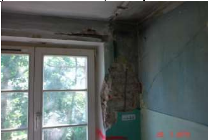
320 Głębokie rysy ukośne biegnące od miejsca połączenia ściany działowej z ze ścianą zewnętrzną konstrukcyjną.
