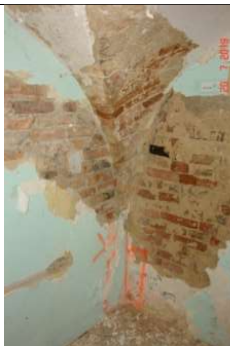
169 Ubytki w spoinach muru oraz elementach murowanych. Lokalnie brak przesunięcia cegieł w kolejnych warstwach muru.
