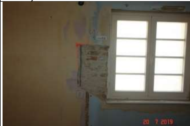
332 Odkrywka muru w ścianie murowanej zewnętrznej. Mur w dobrym stanie technicznym. Widoczne znaczące ugięcie drewnianego nadproża okiennego, łuszczenie fary na drewnianej belce.
