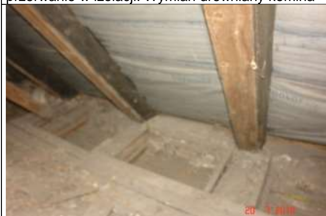
550. Odkrywka w stropie nad piętrem. Widoczne wzmocnienie krokwi poprzez wykonanie obustronnej nadbitki
