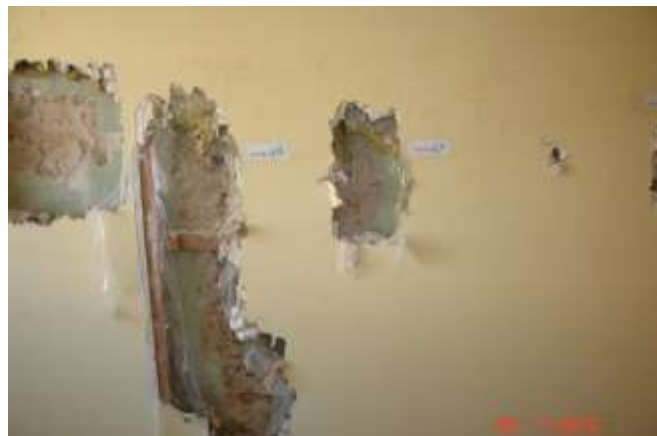
383 Pęknięcia pionowe w wyniku zużycia materiałowego i utraty nośności muru.
