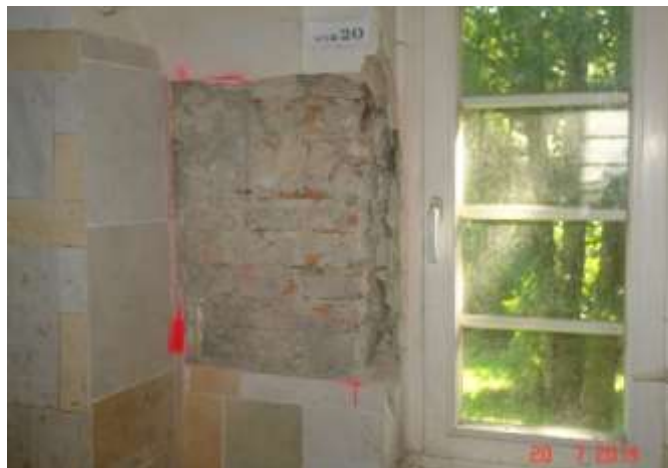
324 Odkrywka w ścianie zewnętrznej budynku. Mur w dość dobrym stanie technicznym
