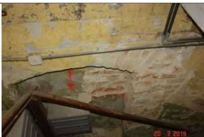
140 Widoczne sklepienie ceglane. Otwór zamurowany w kolejnej fazie eksploatacji budynku
