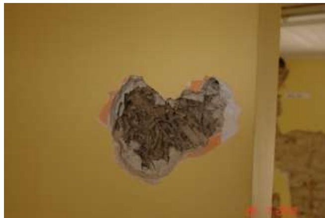
355 Odkrywka ściany działowej wykonanej z supremy
