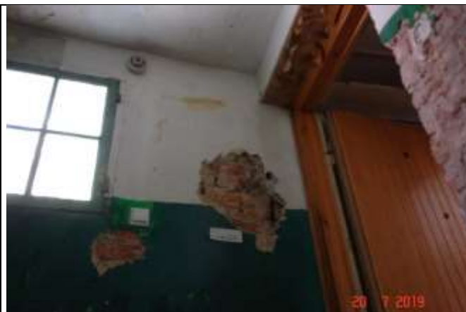
300. Odkrywka w ścianie murowanej. Widoczny obrys po zamurowanym otworze istniejącym w pierwszej fazie eksploatacji. Głęboka szczelina jako następstwo braku przewiązania cegieł w murze. Ubytki w spoinowaniu muru. Łuszcząca się farba na nadprożu drzwiowym
