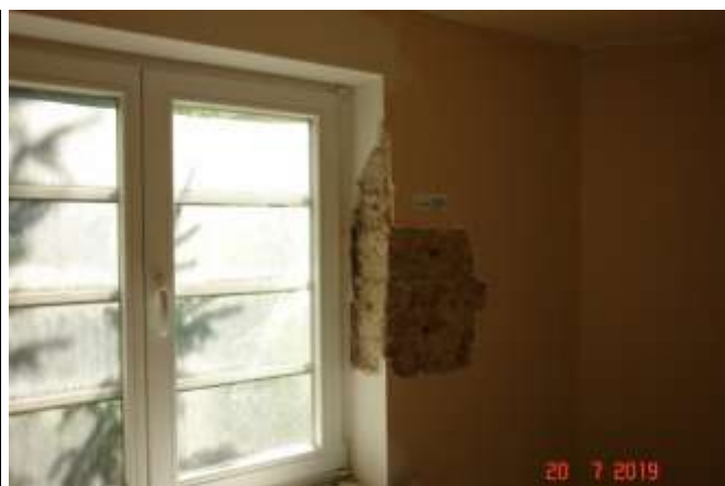
306. Odkrywka w ścianie zewnętrznej murowanej. Widoczne ubytki w spoinowaniu
