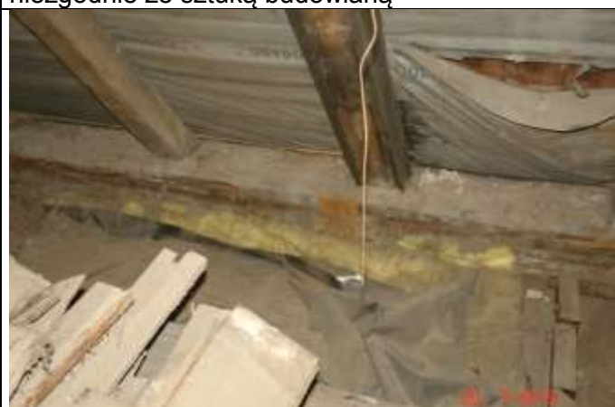
556. Odkrywka w stropie nad piętem. Nieszczelność dachu - przerwanie warstwy izolacji z folii. Widoczna obustronna nadbitka na krokwiach.
