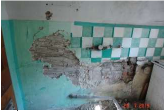
318 Ściana wzniesiona niezgodnie ze sztuką budowlaną - wykonana z różnych materiałów: bloczek gazobetonowy, cegła. Nieprawidłowe ułożenie cegieł w murze - miejscami cegły postawione na sztorc. Głębokie ubytki w murze
