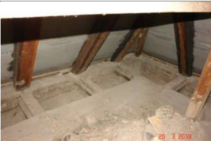
504. Odkrywka w stropie nad parterem. Widoczne wzmocnienie krokwi poprzez nadbítki z desek.
