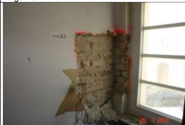
345 Połączenie ściany ryglowej z zewnętrzną ścianą murowaną. Widoczne uszkodzenia drewnianego rygla. Ubytki w murze zewnętrznym uzupełnione pianką wysokoprężną. Spękania w filarze okiennym
