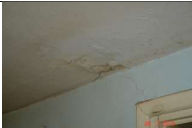
338 Zacieki na suficie połączone z łuszczeniem się tynku. Rysa kośna od górnej krawędzi otworu drzwiowego biegnąca pod stro
