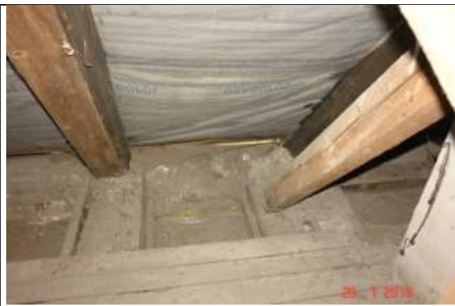
549. Odkrywka w stropie nad piętrem. Nieszczelność dachu -przerwanie w izolacji.
