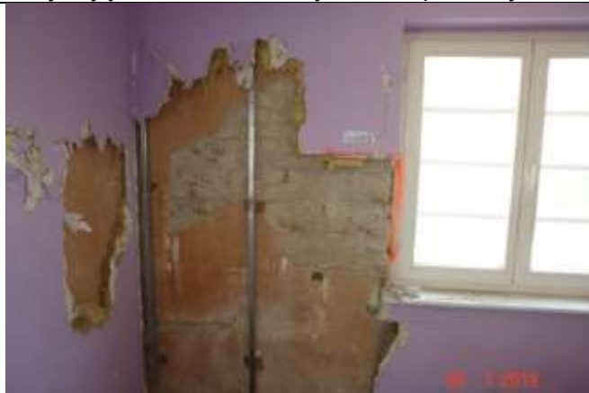
378 Widoczne nieprawidłowe wykonanie zwężenia otworu - brak przewiązania cegieł - odspojenie fragmentu domurowanego w późniejszej fazie eksploatacji. Połączenie murowanych zewnętrznych ścian narożnych obłożonych płytą g-k na ruszcie
