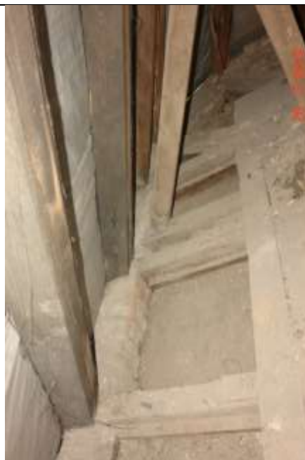
511. Odkrywka w stropie nad parterem. Widoczne wzmocnienie krokwi poprzez nadbitki z desek. oraz zacieki w miejscu połączenia zastrzału z belką .
