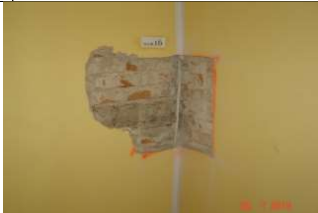
350 Połączenie dwóch ścian konstrukcyjnych Widoczny drewniany rygiel ściany wewnętrznej
