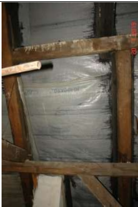
576. Widoczny wymian komina. Zacieki na belce świadczące o nieszczelności dachu
