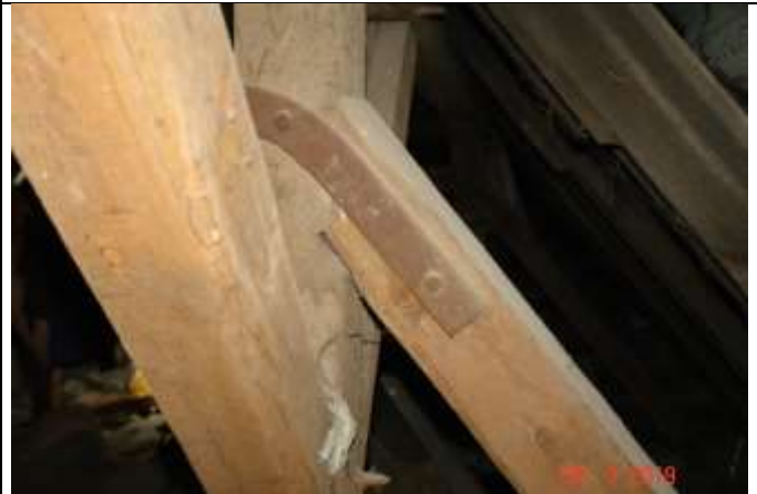
566. Odkrywka w stropie nad piętrem. Widoczna obustronna nadbitka na krokwiach
