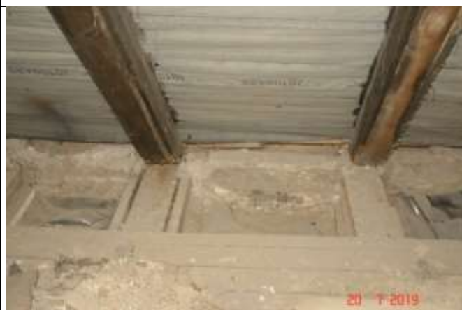
559. Odkrywka w stropie nad piętem. Widoczna obustronna nadbitka na krokwiach
