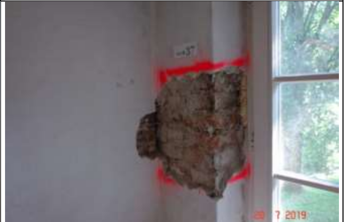
315 Szczelina na styku ściany zewnętrznej murowanej i ściany działowej wykonanej z desek
