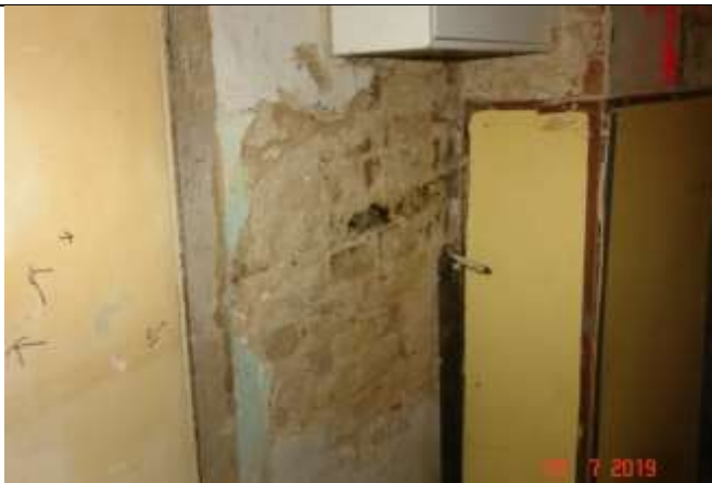
162 Widoczne zawilgocenie ściany, miejscami pleśń spowodowana podciąganiem kapilarnym wody przez brak hydroizolacji ścian i fundamentów.
