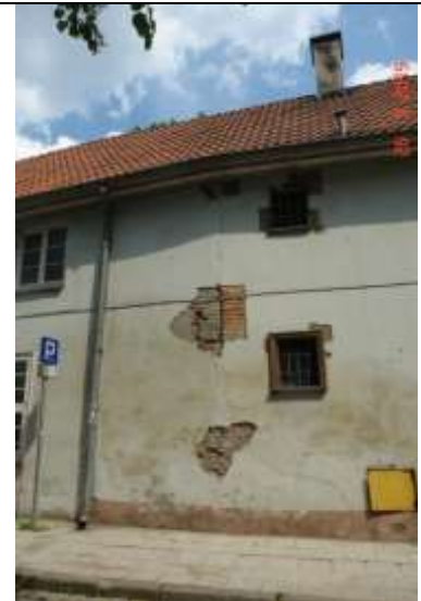
57. Rysy ukośne i pionowa szczelina na styku fragmentów muru wybudowanym w różnym okresie.
