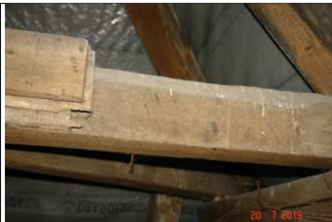
554. Wadliwie wykonana nadbitka płatwi - niezgodnie ze sztuką budowlaną
