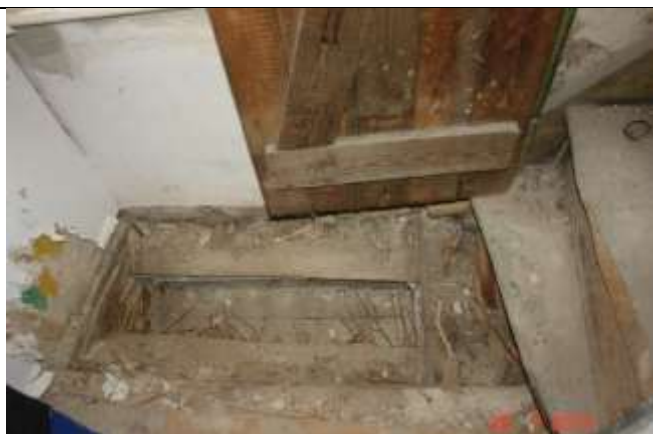
344 Odkrywka drewnianego stropu
