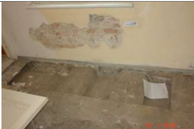
333 Odkrywka stropu w miejscu oparcia belek drewnianych na murze
