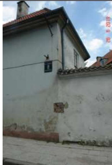
55. . Wyraźnie zaznaczona szczelina powstała wskutek niezależnego osiadania muru i budynku
