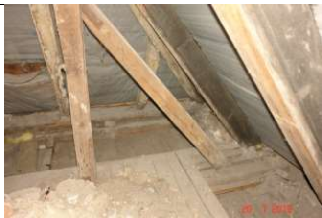
551. Widoczne mocne zacieki na skrajnych krokwiach. Liczne wysolenia. Korozja belek w miejscu oparcia na murze
