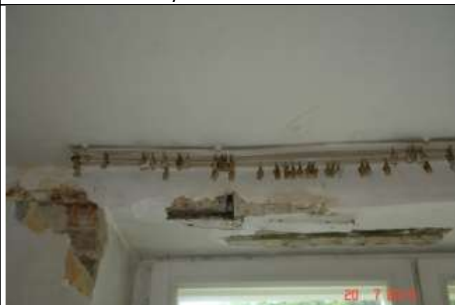
133 Nadproże drewniane. Widoczne wykwity wilgoci. Brak płaszczyzny poziomej belki nadproża.
