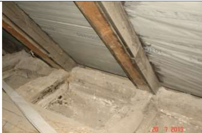
570. Oparcie krokwi na murze. Zgorzel w belce stropu nad piętrem. Widoczne nadbitki w krokwi
