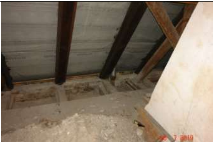
502. Odkrywka w stropie nad parterem. Widoczne wzmocnienie krokwi poprzez nadbítki z desek.
