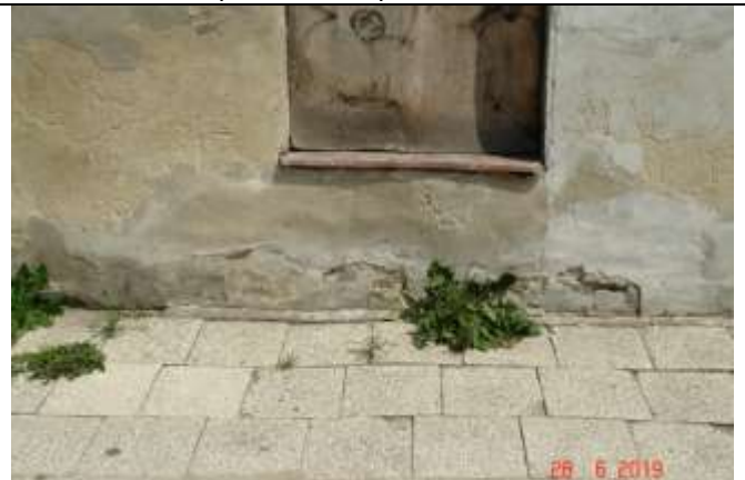
71. Skarbonatyzowana zaprawa, ukośne rysy biegnące od
