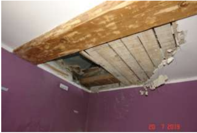
364 Odkrywka na wylot w stropie nad pierwszym piętrzem. Na ścianie widoczne zacieki. Pojawiające się ognisko korozji w miejscu oparcia belki na murze
