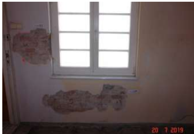
331 Odkrywka w zewnętrznej ścianie murowanej. Mur wzniesiony niestarannie - brak zachowania płaszczyzn przy ułożeniu cegieł w murze. Ubytki w spoinowaniu
