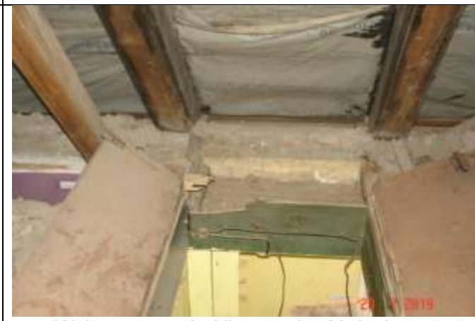
563. Wyłaz na strych. Nieszczelność dachu - przerwana izolacja z folii
