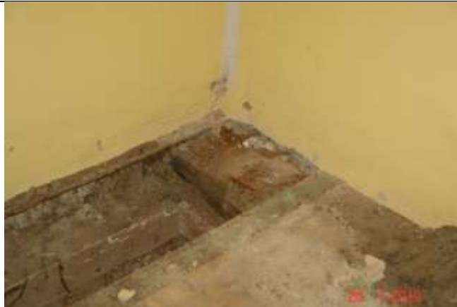
352 Odkrywka belki krawędziowej stropu - widoczna zgorzel obejmująca do połowy wysokości przekroju
