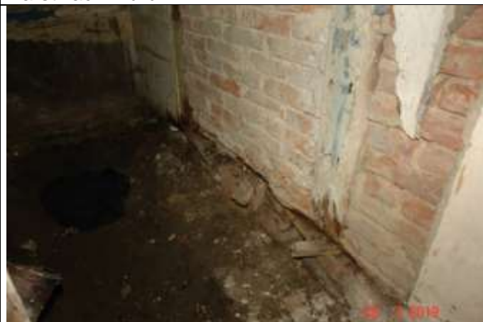
116 Ściana ryglowa. Całkowicie skorodowana drewniana belka podwalinowa. Brak oparcia ściany.
