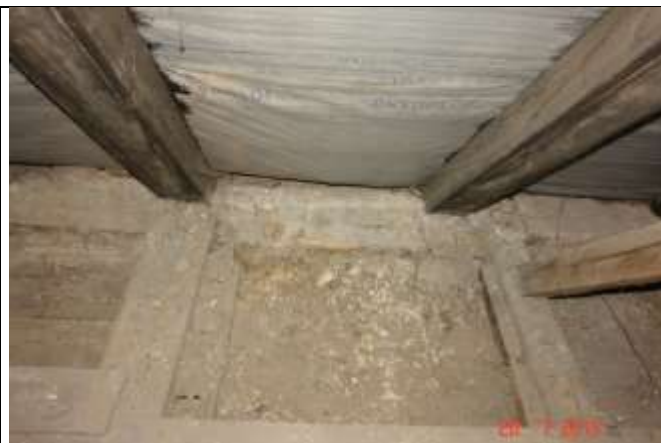
531. Odkrywka w stropie nad parterem. Połączenie zastrzału z belką
