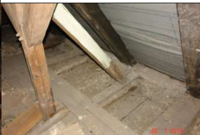
529. Odkrywka w stropie nad parterem. Połączenie zastrzału z belką
