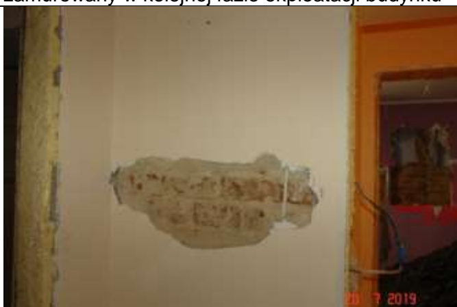
142 Odkrywka muru w dość dobrym stanie techniczny,
