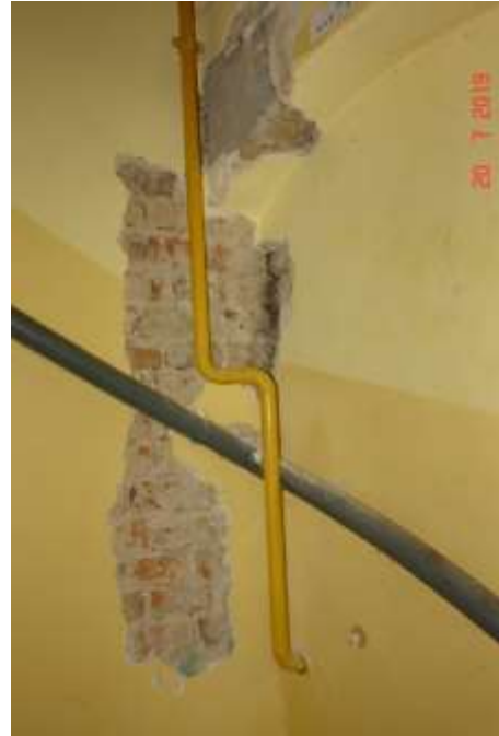
161 Odkrywka ściany murowanej. Widoczne liczne ubytki w spoinowaniu.
