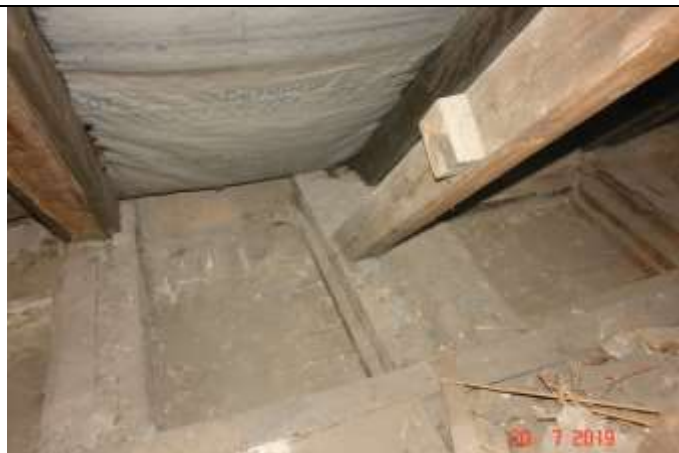
546. Sposób łączenie zastrzału z belką . Widoczna zgorzel belki
