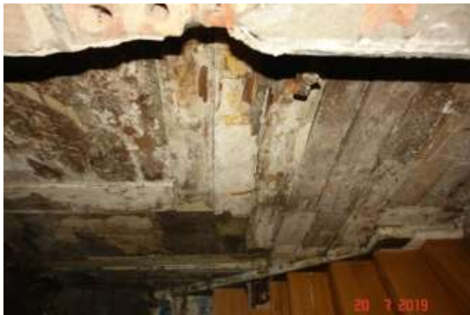
118 Pleśń konstrukcji drewnianej ściany klatki schodowej
