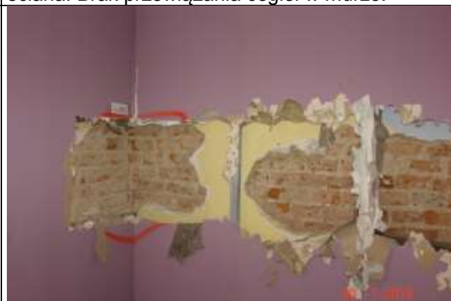
147 Odkrywka ściany murowanej obłożonej płytą g-k na ruszcie. Mur w dość dobrym stanie technicznym. Lokalnie zbyt grube spoiny.
