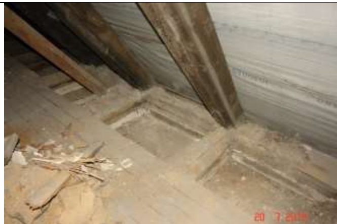
577. Odkrywka w stropie nad piętrem
