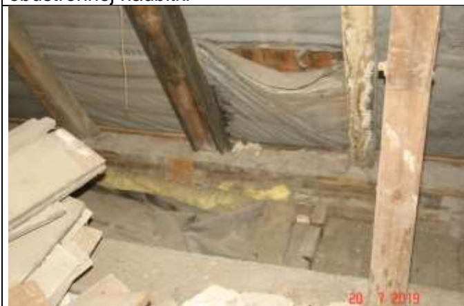
552. Odkrywka w stropie nad piętrem Nieszczelność dachu - przerwanie warstwy izolacji z folii. Widoczna obustronna nadbitka na krokwiach. Liczne zacieki na prawej krokwi - pojawił się grzyb
