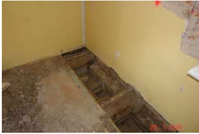
348 Odkrywka w miejscu oparcia stropu drewnianego na ścianie zewnętrznej murowanej. Widoczna wilgoć i korozja drewna rozpoczynająca się w górnej części belki. Brak izolacji w miejscu oparcia drewna na murze.
