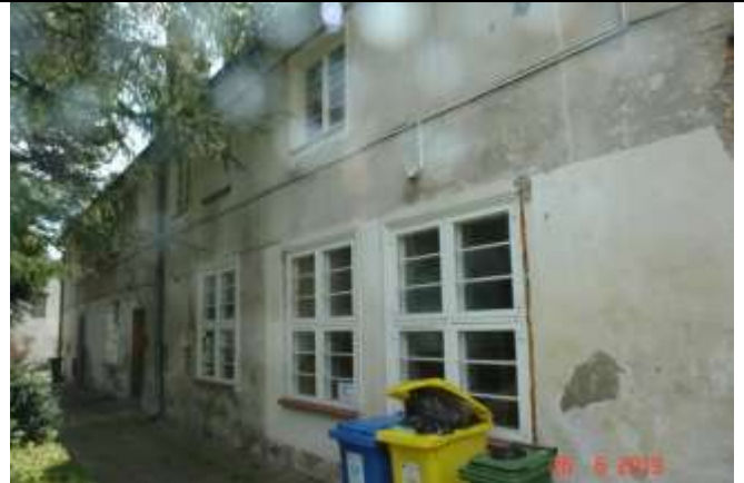
41. Rysy ukośne biegnące ku górze od naroża okna. Ślady podciągania kapilarnego wody w murze
