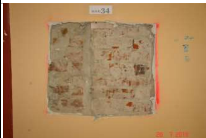
153 Miejsce po zamurowaniu otworu. Nieprawidłowe wykonanie muru - Brak przewiązania cegieł.
