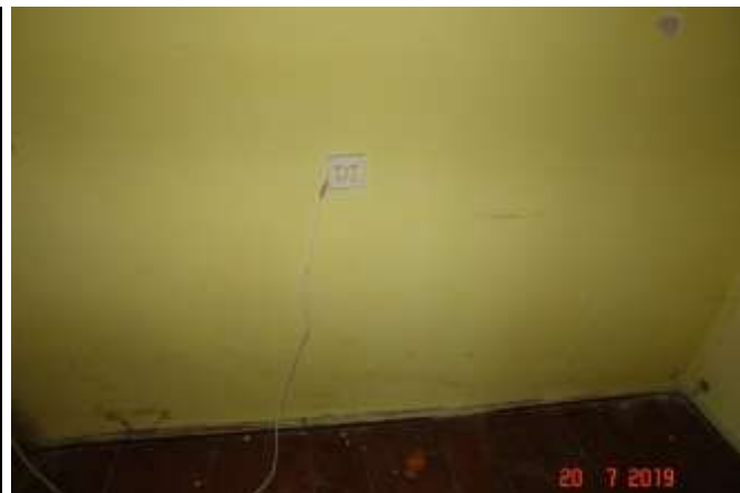
343 Rysa pionowa biegnąca od poziomu podłogi ku górze.
