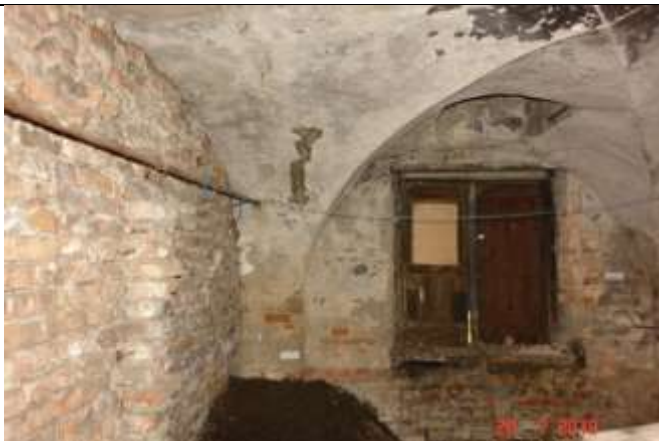
174 j.w. Niestaranne wykonanie muru. Widoczne niezgodne ze sztuką budowlaną zbyt grube spoiny.
