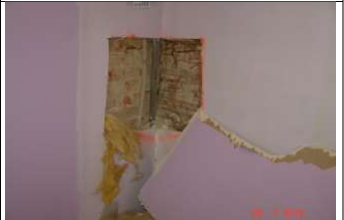
379 Połączenie ściany murowanej nośnej ze ścianą działową drewnianą.
