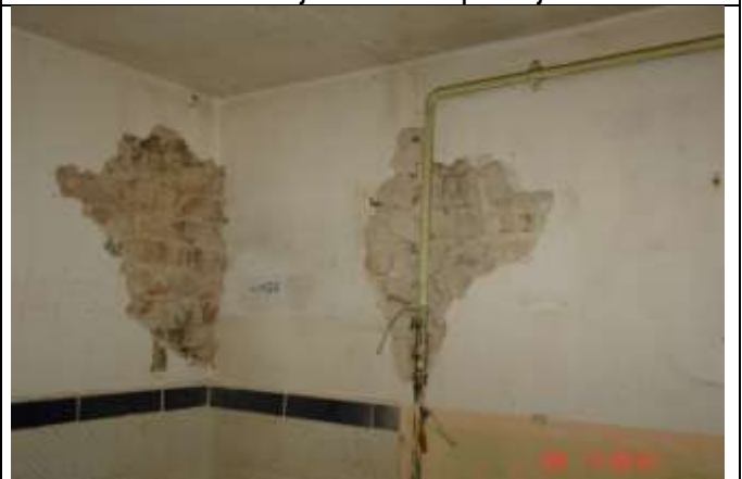
339 odkrywka w miejscu styku ścian nośnych murowanych. Mur w dostatecznym stanie technicznym.
