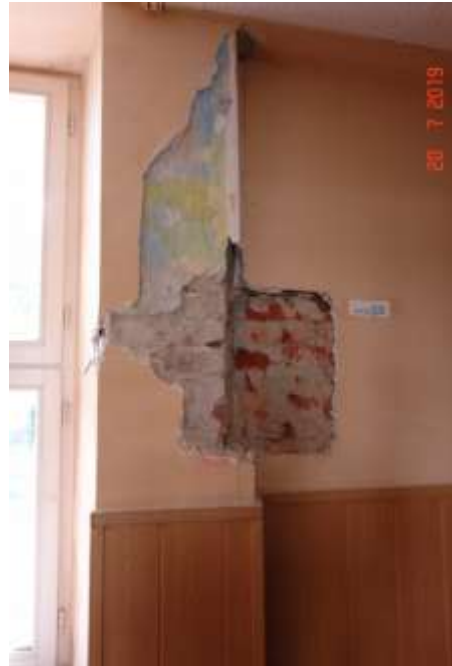
105. Widoczny brak przewiązania w murze w miejscu wypełnienia wnęki ściany nośnej.
