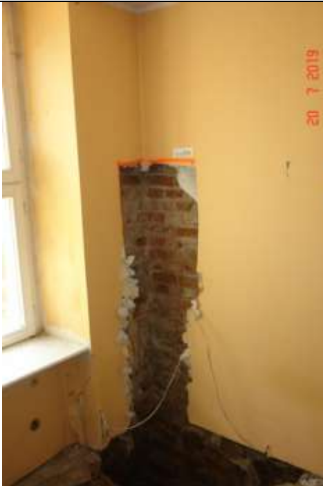
156 Odkrywka ściany murowanej. Mur w dostatecznym stanie technicznym.
