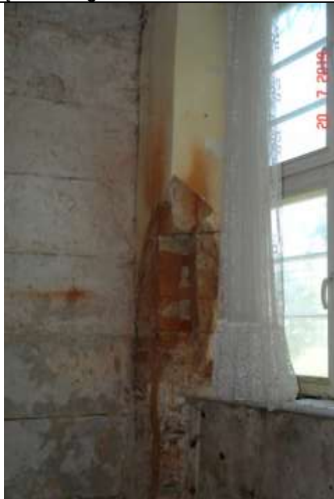
124. Odkrywka styku pierwotnego filara międzyokiennego i wypełnienia pomiędzy filarami oraz styk ściany z blozków gazobetonowych i filara. Brak przewiązania między filarem a wypełnieniem i ścianą prostopadłą.
