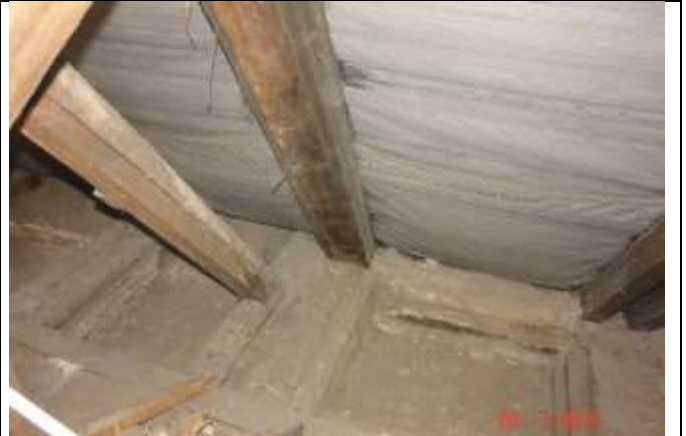
545. Widoczne pęknięcie biegnące wzdłuż elementu zastrzału
