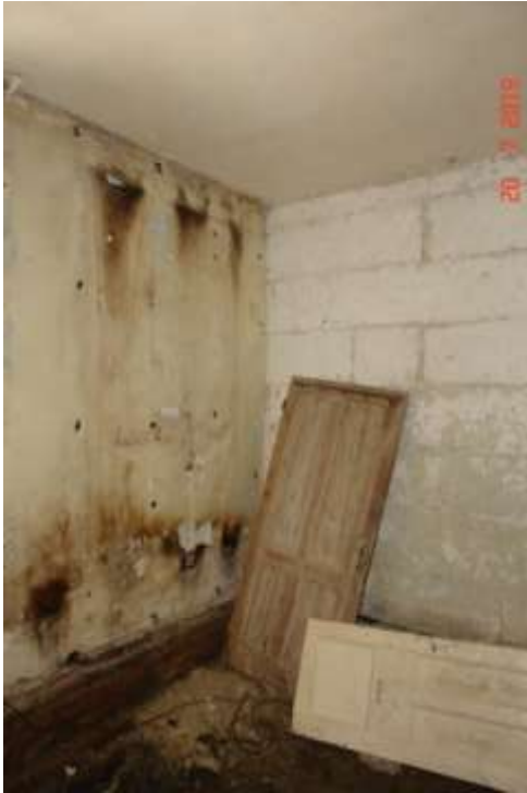
122. Na ścianie liczne miejsca pokryte pleśnią powstającą wskutek kapilarnego podciągania wody gruntowej, przy braku hydroizolacji ścian. Prostokątny obrys widoczny na ścianie może świadczyć obecności okna w pierwszej fazie eksploatacji oraz na brak odpowiedniego przewiązania cegieł w murze
