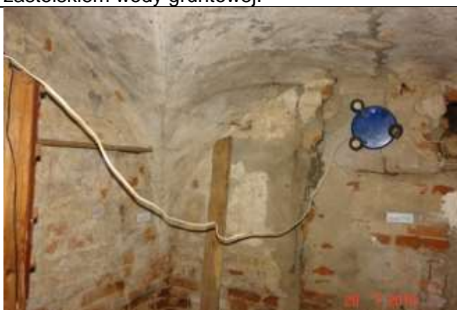
178 Widoczne głębokie pęknięcie w sklepieniu
