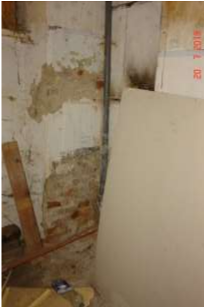
170 Łuszczenie tynku. Widoczne zawilgocenie ściany, miejscami pleśń spowodowana podciąganiem kapilarnym wody przez brak hydroizolacji ścian i fundamentów
