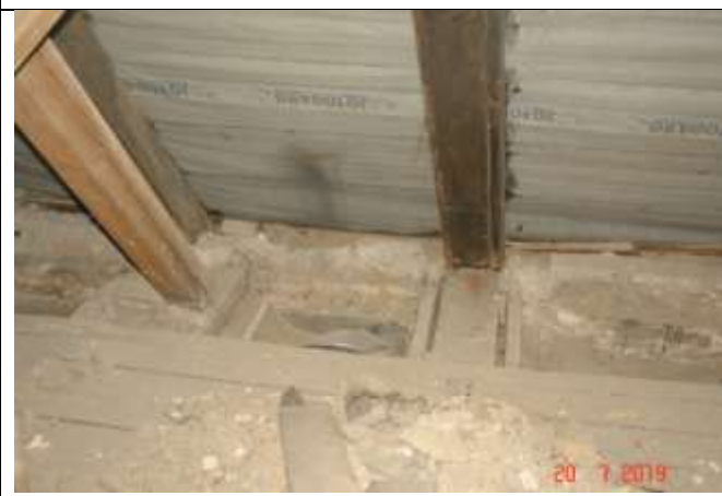
559. Odkrywka w stropie nad piętem. Widoczna obustronna nadbitka na krokwiach
