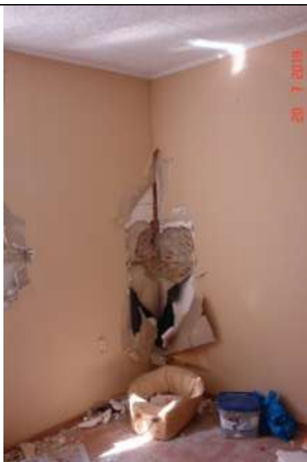
102. Widoczna szczelina na styku dwóch ścian konstrukcyjnych. Nieprawidłowe przewiązanie cegieł w murze.
