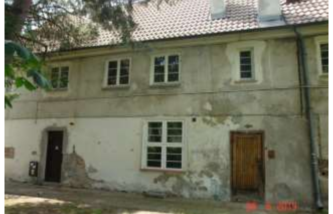
47. Szczelina pionowa podzielona na trzy równoległe odcinki biegnąca od ryzalitu do nadproża otworu drzwiowego na parterze. Szczelina u góry rozszerza się by u dołu ulec zamknięciu. Przełamanie budynku. Liczne rysy pionowe biegnące pomiędzy dolnym narożem okna na piętrze a narożem okna na parterze i dalej ku dołowi. Na górnym odcinku rysy szersze i zwężające się u dołu.
