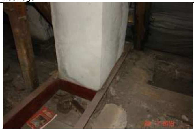
523. Konstrukcja stalowa wymianu ceownik C220
