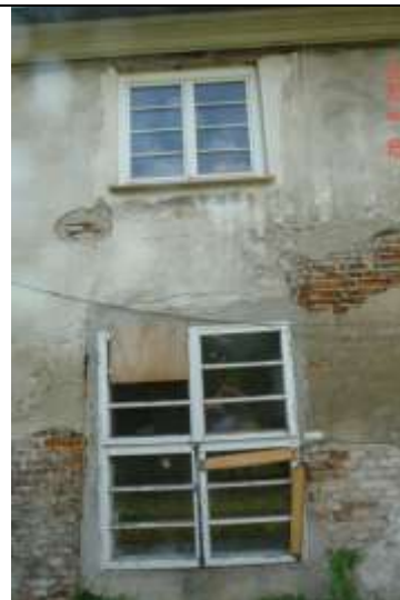
37. Wilgoć występująca w poziomie stropu I piętra, czym zagraża trwałości murbelki pod belkami stropowymi. Rysa pozioma powstała wskutek ugięcia drewnianego nadproża ulegającego stopniowej degradacji
