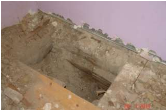
374 Odkrywka w stropie nad parterem w miejscu oparcia belek na murze. Widoczna zgorzel.
