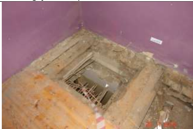
360 Odkrywka w stropie drewnianym na wylot
