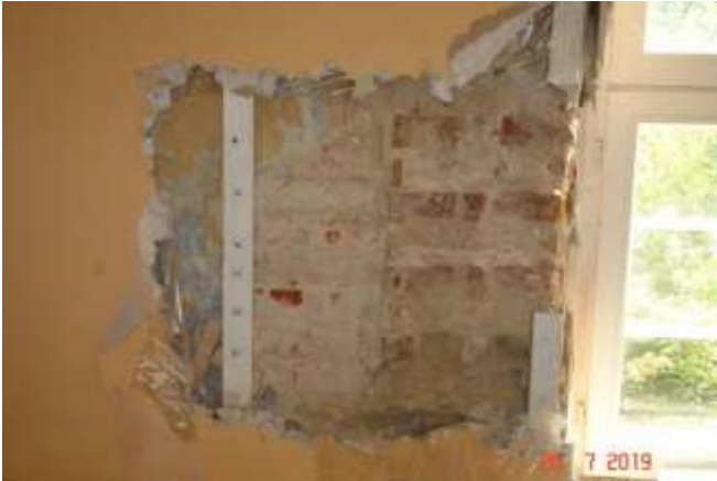
154 Widoczne zwężenie światła otworu okiennego wykonane w dwóch fazach eksploatacji budynku. Wykonano wadliwie nie zachowując należytego przewiązania cegieł w murze.
