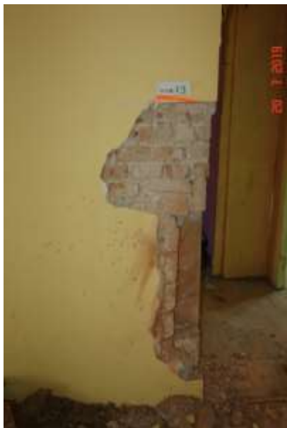
354 Odkrywka muru na krawędzi otworu drzwiowego w wewnętrznej ścianie nośnej/ Mur w dość dobrym stanie technicznym
