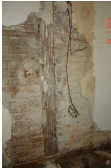
119 Głęboka korozja drewnianej belki podwalinowej w wyniku podciągania wody gruntowej przez niezaizolowane ściany i fundamenty.
