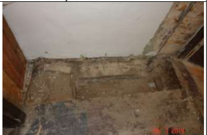
323 Odkrywką w miejscu oparcia belek stropowych na murze.
