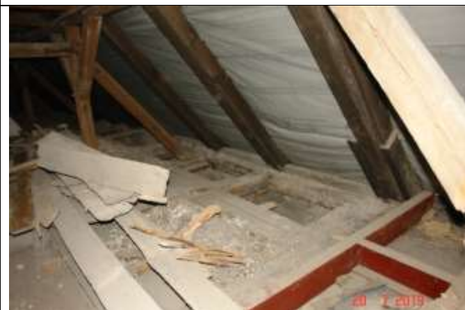
587. Odkrywki stropu nad piętnem. Stalowy wymian komina.
