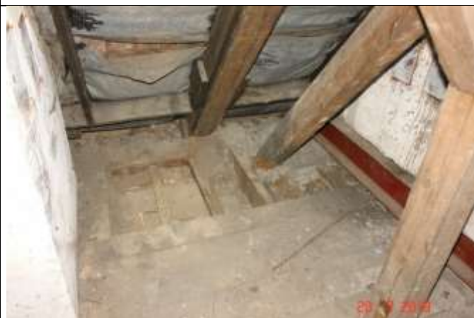
539. Nieszczelność dachu przy kominie - rozdarcie folii. Widoczna odkrywka w stropie nad piętrem. Korozja zastrzału w miejscu połączenia z belką. Widoczne zacieki oraz zgorzel.
