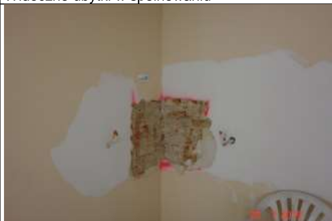
308. Odkrywka na połączeniu ścian murowanych. Niestaranne wykonanie muru. Głębokie ubytki w spoinowaniu
