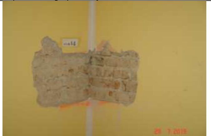
353 Styk ścian konstrukcyjnych - wewnętrznej i zewnętrznej. Mur w dość dobrym stanie technicznym
