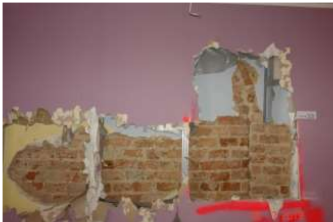
148 Widoczny brak przewiązania w murze wznoszonym w kolejnych fazach eksploatacji. Szczelina na styku domurowanego fragmentu.
