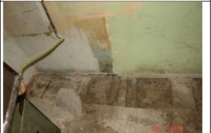
341 Odkrywka w miejscu oparcia belek drewnianych a ścianie zewnętrznej
