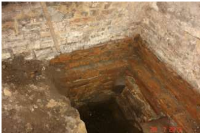
176 Odkrywka fundamentu z widocznym zastoiskiem wody gruntowej.
