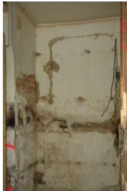
139 Widoczna wilgoć i pleśń na ścianach sanitariatu.
