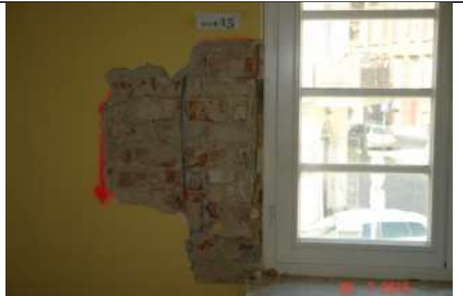
351 Nieprawidłowe ułożenie cegieł w murze - brak odpowiedniego przewiązania elementów.
