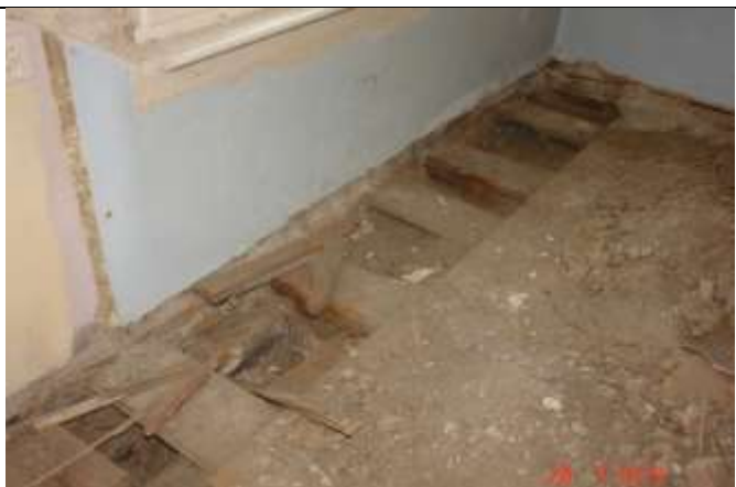
335 j.w. Widoczna zgorzel brunatna na 1/3 przekroju górnej części belki stropu wsuwkowego. Brak izolacji na styku drewno-mur
