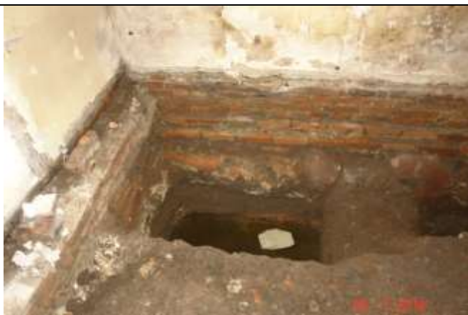
120. Odkrywka z pokazaniem ław fundamentowych. Widoczna stojąca woda gruntowa
