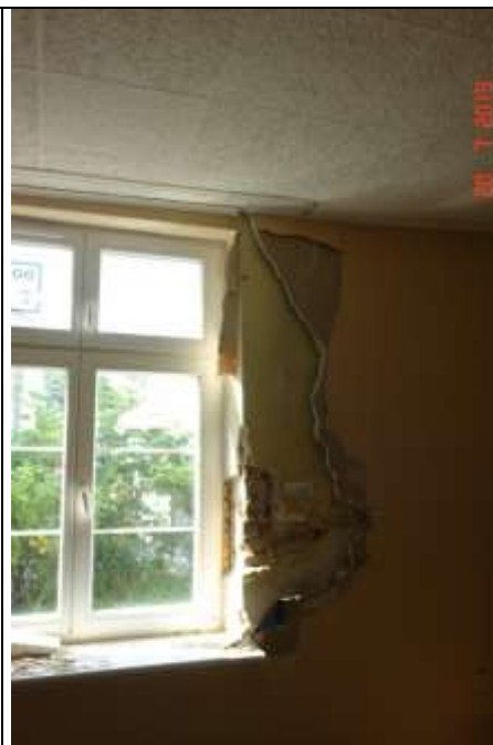
101. Widoczne zwężenie światła otworu okiennego wykonane w dwóch fazach eksploatacji budynku. Wykonano wadliwie nie zachowując należytego przewiązania cegieł w murze.
