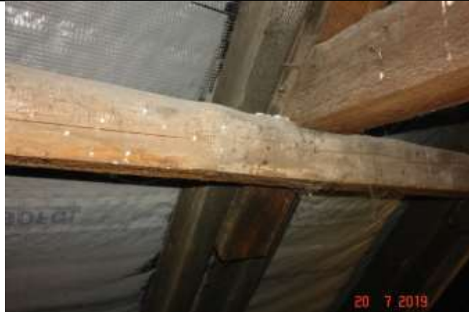
544. Oparcie krokwi na płatwi. Nadbitka płatwi. połączenie jętki z podwójną krokwią
