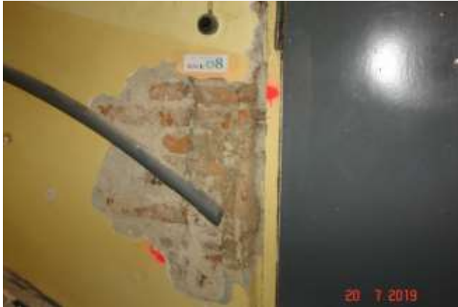
160 widoczne domurowanie fragmentu ściany w późniejszej fazie eksploatacji. Brak rozwiązania cegieł w murze
