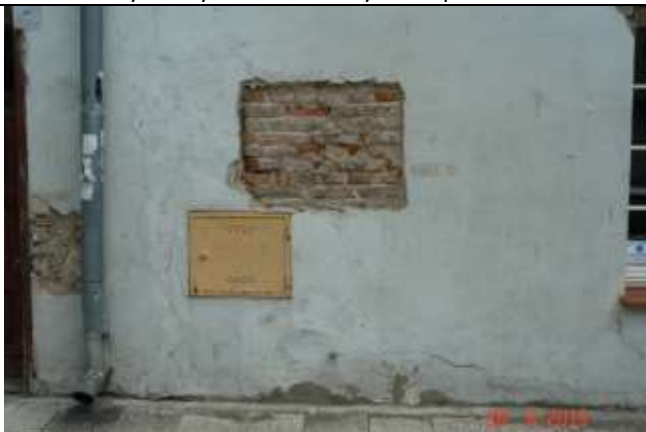
68. Ukośna szczelina odpajająca fragment do otworu drzwiowego od reszty ściany. Brak przewiązania muru na jego fragmencie
