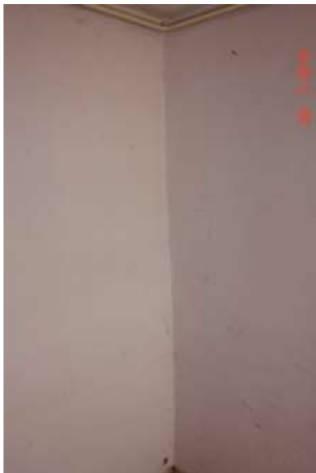
330 Rysa pionowa na styku dwóch ścian działowych
