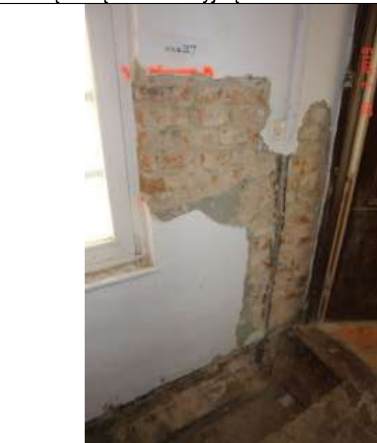
322 Odkrywką w murze ściany zewnętrznej ceglanej. Mur w dostatecznym stanie technicznym
