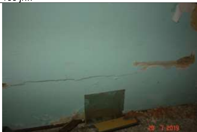
168 Rysa pozioma rozszerzająca się ku środkowej części ściany w wyniku nierównomiernego osiadania ściany względem ścian prostopadłych. Efekt zginania ścian, gdzie wypadkowa siła pionowa zgina ścianę na mimośrodku >t/4
