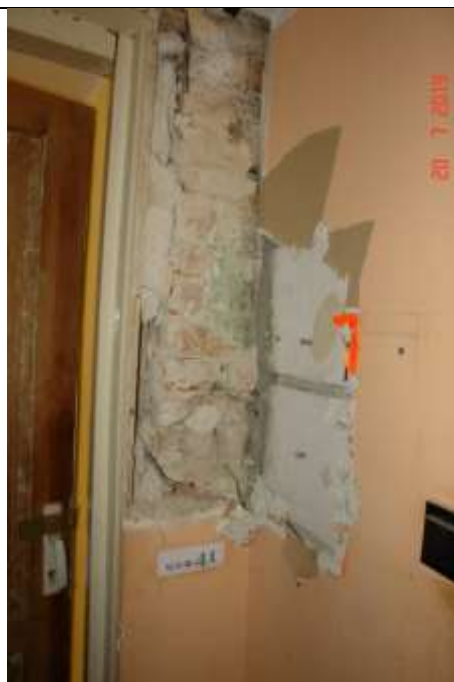
346 Połączenie ściany działowej z gazobetonu ze ścianą nośną - brak przewiązania w murze. Niestaranne ułożenie cegieł w murze. Spore ubytki w spoinowaniu i zaprawie.
