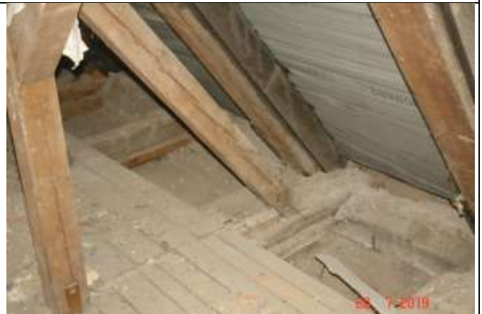
571. Połączenie zastrzału z belką
