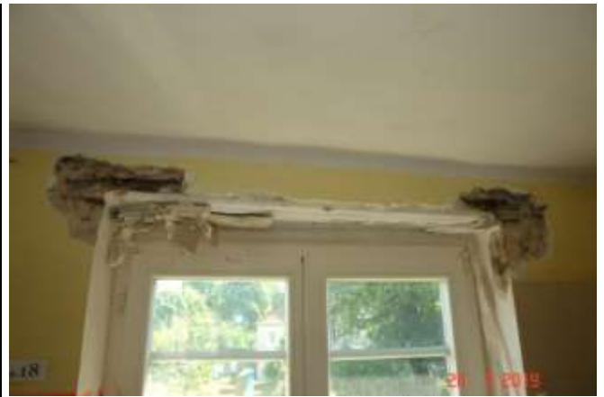
359 Rysy w miejscu oparcia drewnianego nadproża na murze. Korozja belki drewnianej nadproża. Łuszczenie warstwy wykończeniowej
