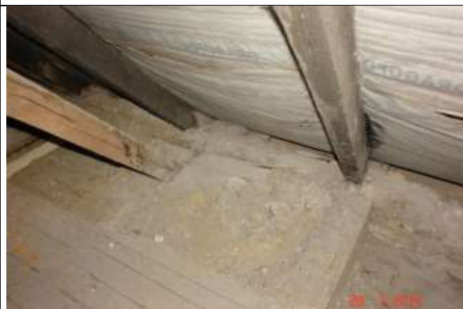
533. Odkrywka w stropie nad parterem. Połączenie zastrzału z belką
