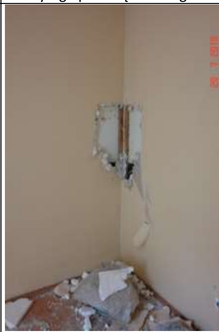
103. Odkrywka z widocznym rusztem pod g-k na ścianach nośnych murowanych
