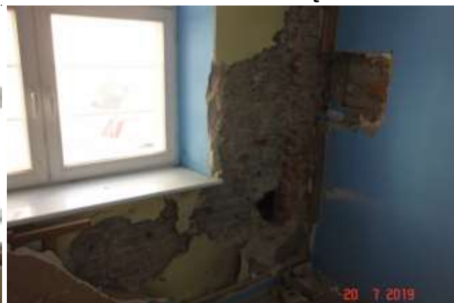
109. Odkrywka w miejscu łączenia ścian domurowanych w kolejnych fazach eksploatacji. Widoczny brak przewiązania elementów murowanych. Liczne ubytki w spoinowaniu muru. Lokalne odspojenie cegieł.w3e
