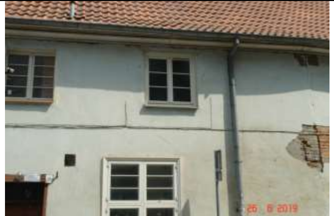
59. Rysy ukośne w narożach otworów okiennych
