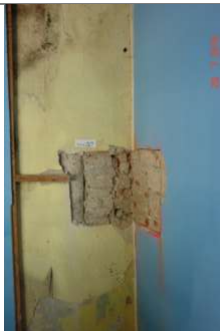
111. Nieprawidłowo wykonane muru. Brak współpracy między elementami murowanymi w różnych fazach eksploatacji. Cegły ułożone bez przewiązania,
