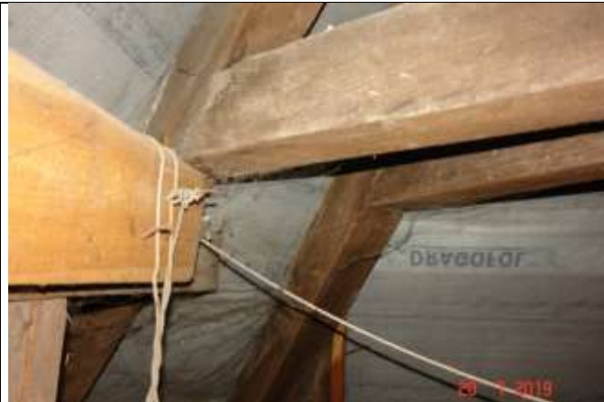
507. Wzmocnienie płatwi. j.w. poprzez wykonanie nadbitki
