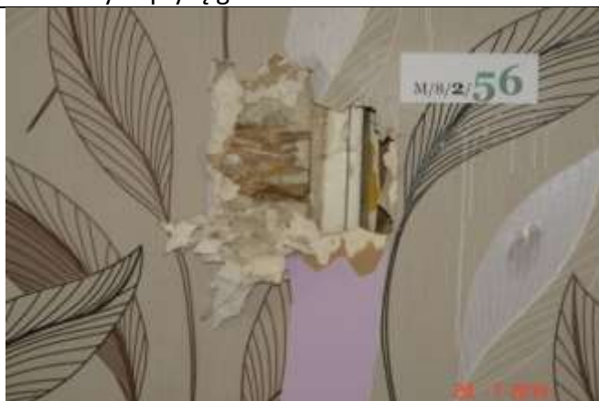
380 Odkrywka w ścianie działowej. Widoczna trzcina pod okładziną z tynku.
