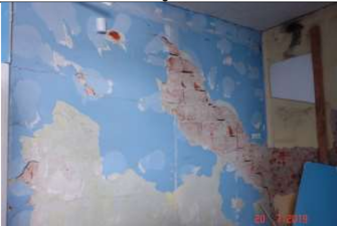
106. Widoczna rysa ukośna w ścianie działowej w wyniku wyczerpania nośności muru. Świadczy o naprężeniach wywołanych nierównomiernym osiadaniem fundamentów
