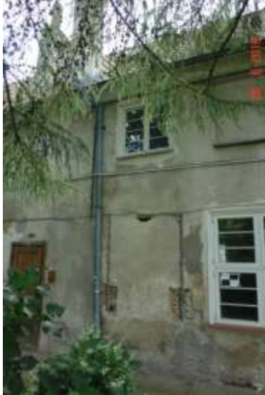
46. Liczne ślady przebudowy otworów okiennych i drzwiowych. Zamurowany otwór w poziomie parteru bez przewiązania cegieł z pozostawieniem drewnianej futryny w murze
