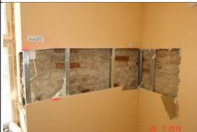
151 Ściany murowane w dość dobrym stanie technicznym obłożone płytą g-k na ruszcie.
