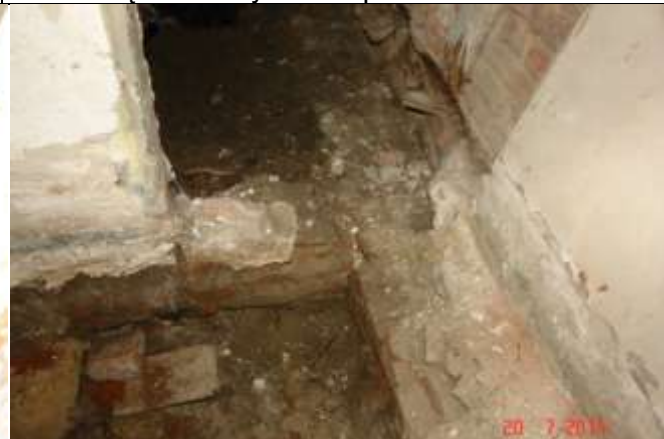
115 Widoczny brak przewiązania cegieł w ścianie fundamentowej ławy.
