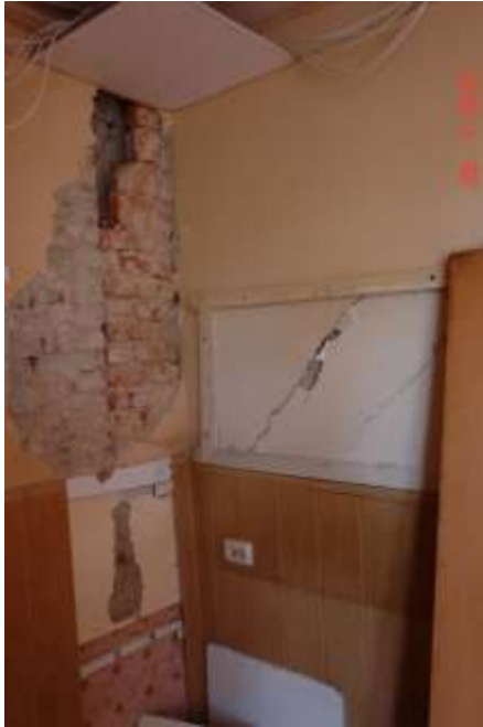
104. Nieprawidłowe wykonanie muru ułożone w dwóch fazach eksploatacji - brak przewiązania cegieł.
