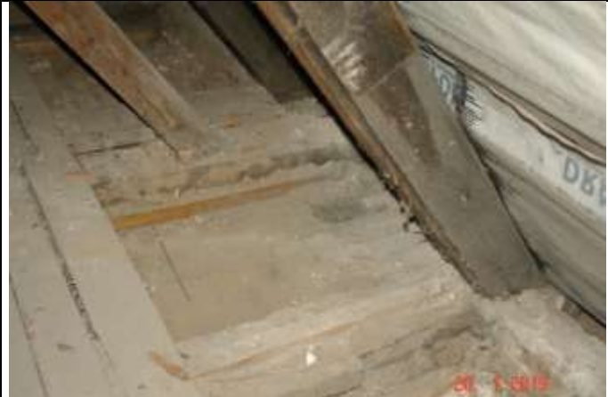
566. Odkrywka w stropie nad piętrem. Widoczna obustronna nadbitka na krokwiach
