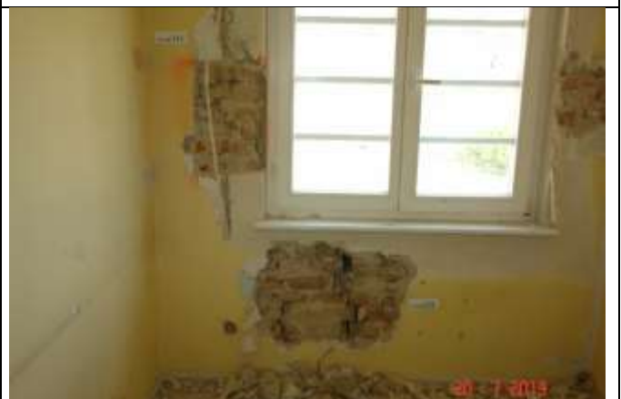
381 Pęknięcie muru w strefie podokiennej świadczące o wyczerpaniu nośności. Lokalne domurowanie krawędzi otworu bez zachowania zasad sztuki budowlanej - brak poziomu w ułożeniu warstw, za grube spoiny, brak odpowiedniego przesunięcia cegieł w kolejnych warstwach.
