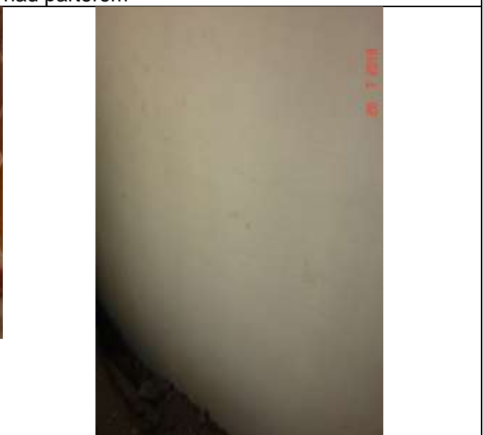
329 Rysa w dolnej części ściany biegnąca pionowo, przechodząca w zarysowanie poziome w połowie wysokości ściany.
