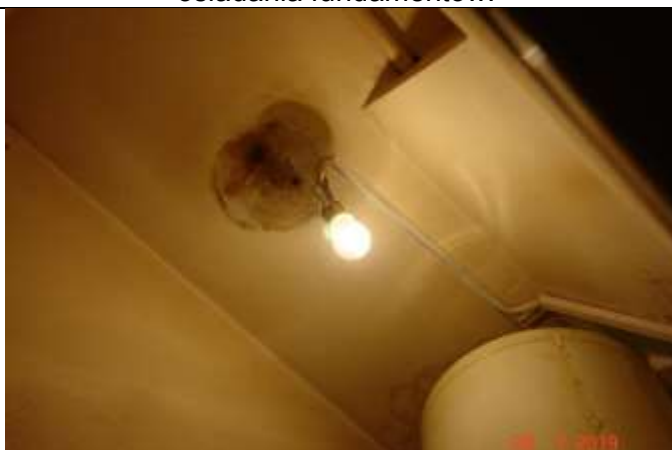
112. Zaciek w miejscu przejścia instalacji
