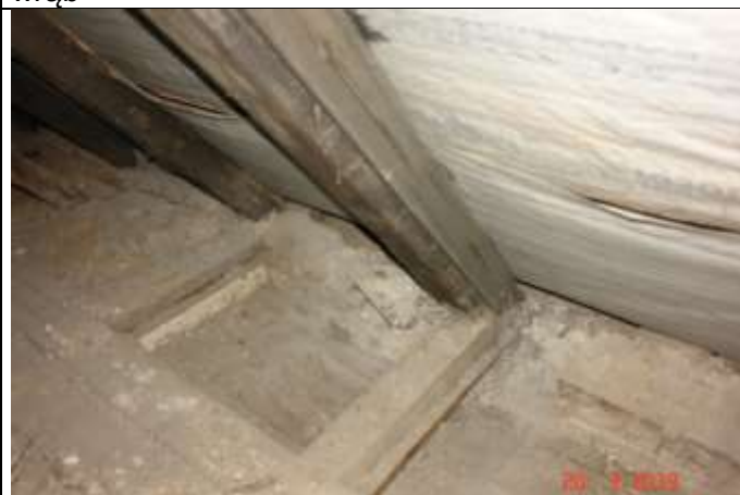
532. Odkrywka w stropie nad parterem. Wzmocnienie krokwi przez nadbitki. Nieszczelność w izolacji dachu
