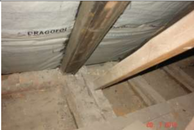
512. Odkrywka w stropie nad parterem
