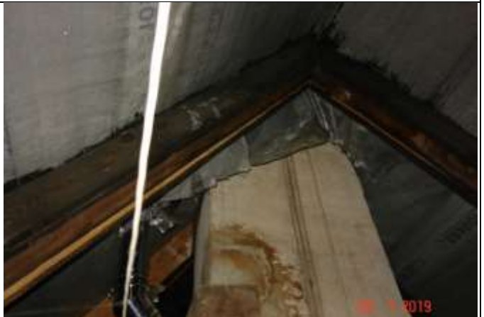
515. Szczyt komina w kalenicy. Wywinięcie izolacji pokrycia dachu
