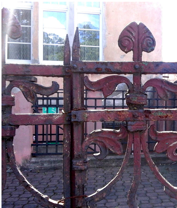
Fot.3 Łączenie skrzydeł bramy wjazdowej; braki elementu dekoracyjnego.
