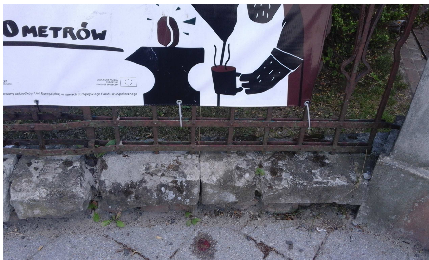
Fot.1 Widoczne obsunięcie podmurówki.
