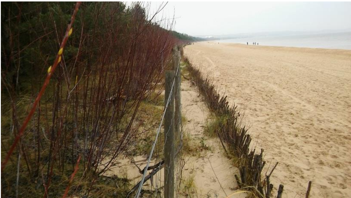
Fot. 3. Ścieżka wydeptana między ogrodzeniem a umocnieniem faszynowym (24.11.2017). Fot. K. Żółkoś.
