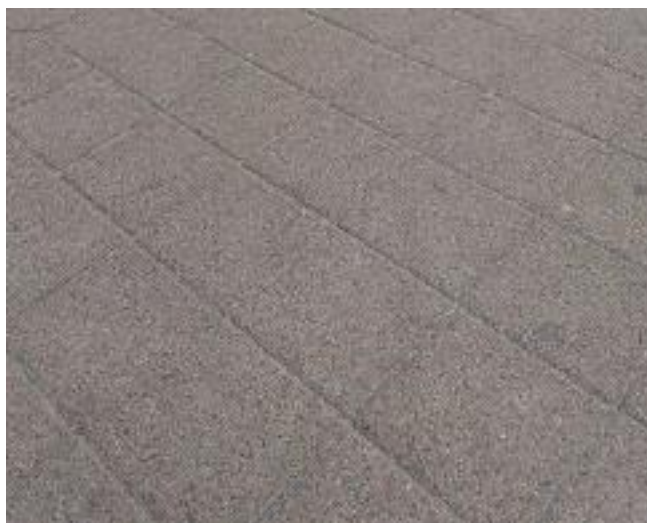
Fot. 12. Nawierzchnia z płytek betonowych o powierzchni płukanej koloru szarego i wymiarze 20x20 cm
