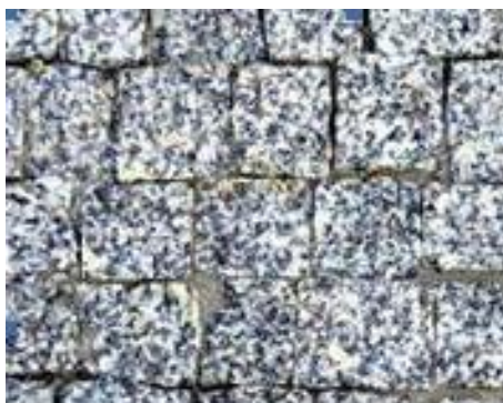
Fot. 11. Kostka granitowa o bokach i górze łupanej 4/6 cm
