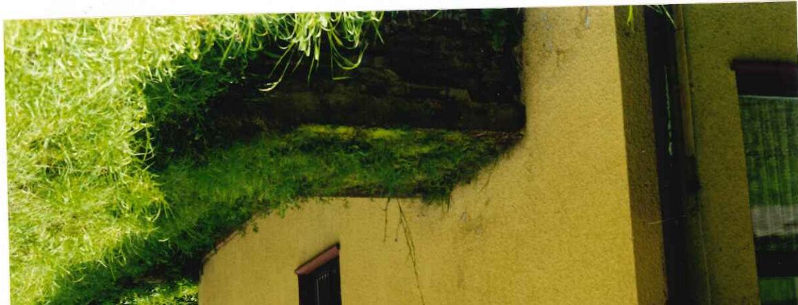
Fot. 4. Napływ wody opadowej ze skarpy, niekorzystny wpływ penetracji w podłoże gruntowe.
