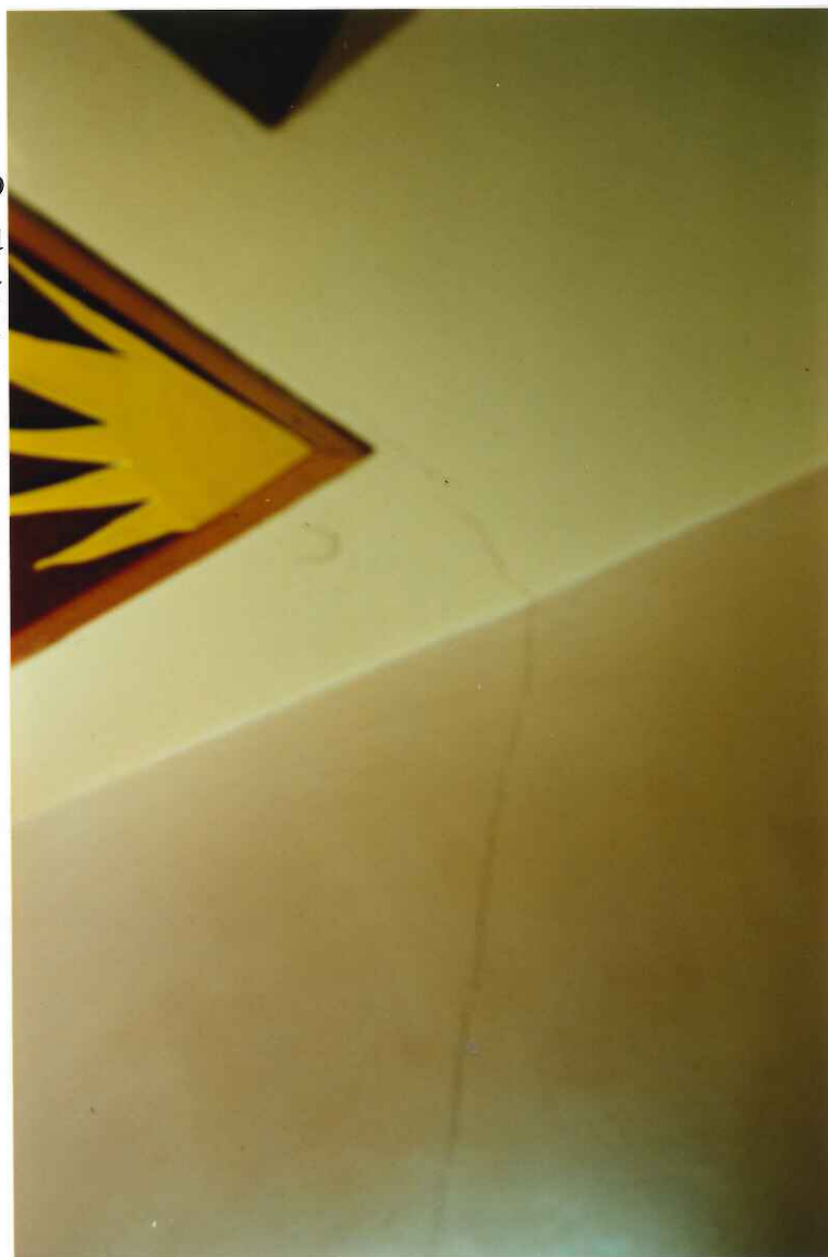
Fot.10. Zarysowanie ściany i sufitu przy trakcie środkowym w części dydaktycznej budynku.
