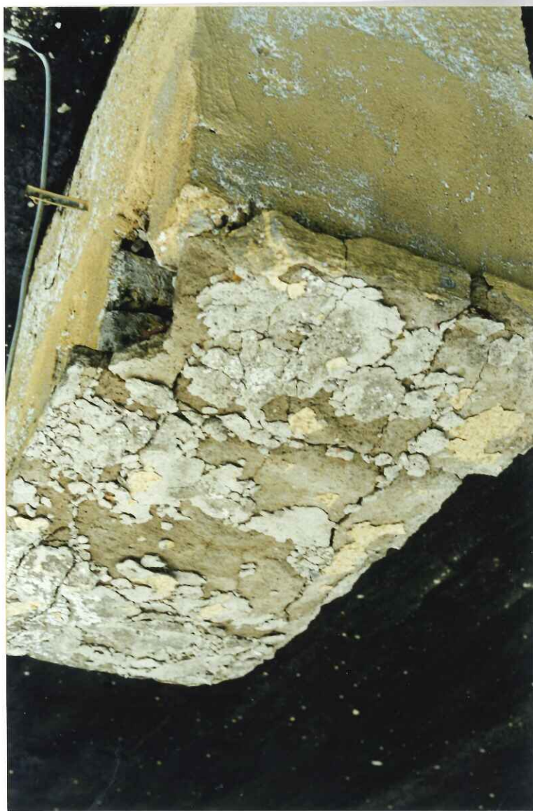
Fot. 17. Zdeastowana betonowa „czapka” komina, ułatwiająca penetrację wód opadowych.
