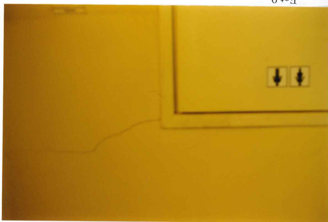
Fot.9. Pęknięcie ścianki działowej, w pobliżu wejścia do budynku.
