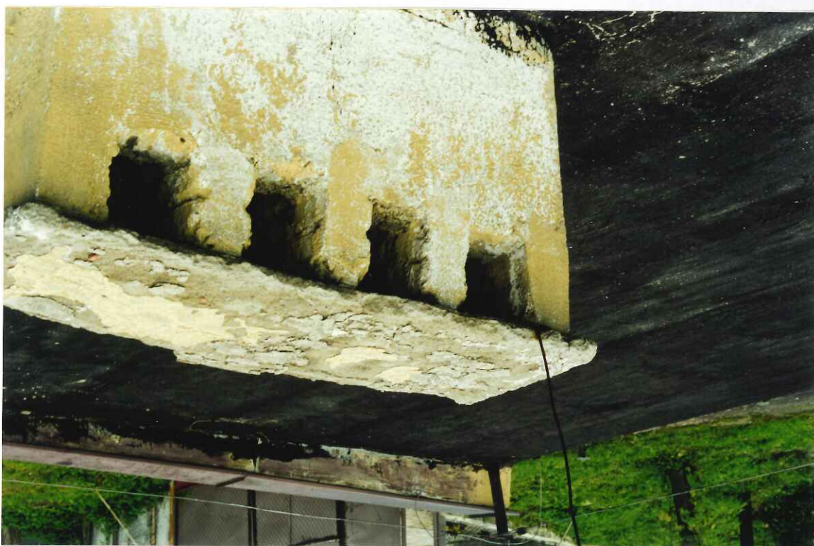
Fot.15. Brak opierzenia blachą ścianki-attyki, nad północną krawędzią dachu.
