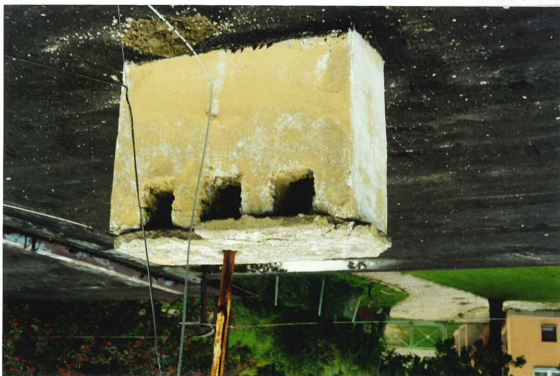
Fot.16. Brak opierzenia blachą podstawy trzonu komina wentylacyjnego. Uszkodzenia „czapki” komina.
