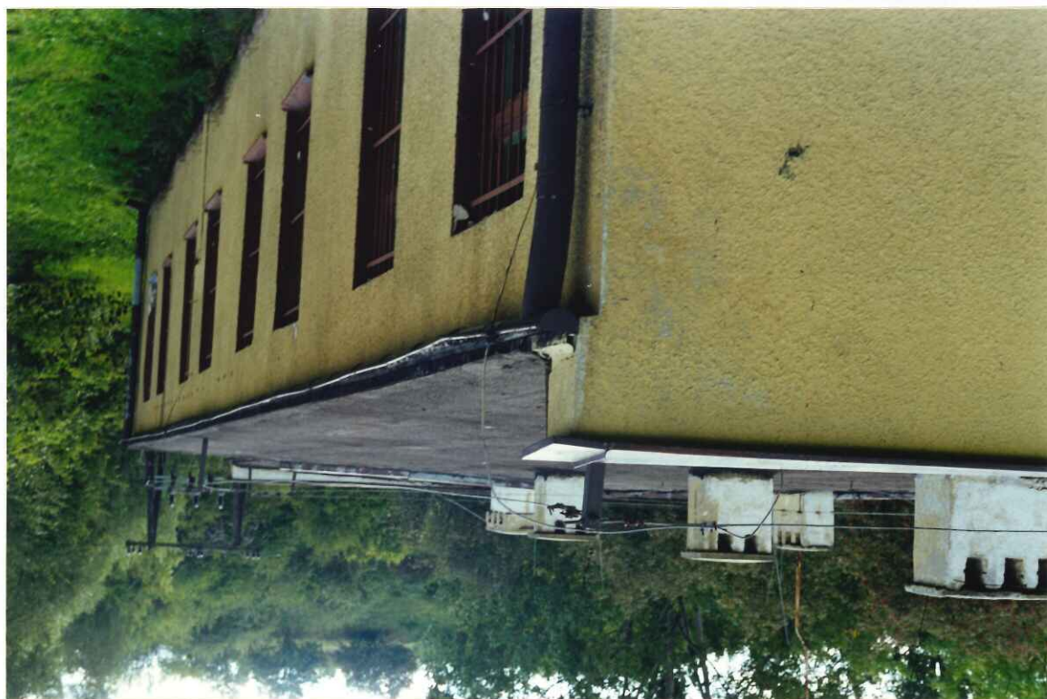
Fot.6. Uszkodzenia rynny, powodujące zacieki ścianę zachodniej.
