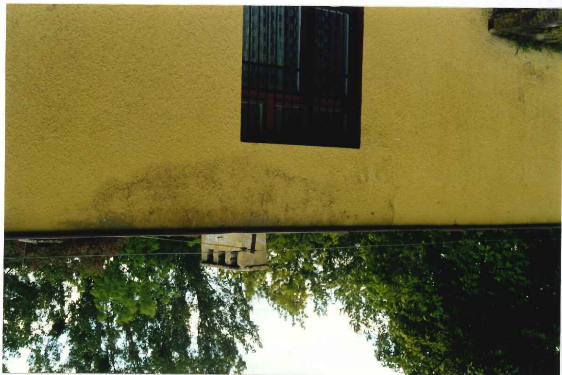
Fot.5. Zacieki elewacji, spowodowane wadliwym opierzeniem z blachy.
