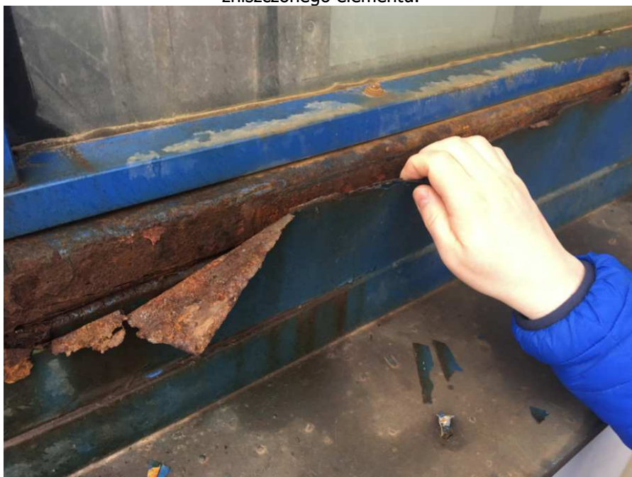
Fot. 5. Winda nr 1 - widok z tyłu. Ogniska korozji belek poziomych w miejscu połączenia z podszybiem windy. Elementy przewidziane do wzmocnienia poprzez dospawanie dodatkowego profilu powyżej zniszczonego elementu.
