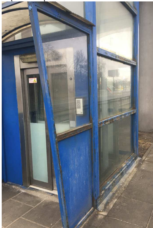
Fot. 9. Winda nr 2. Widok z przodu. Widoczna korozja elementów rygli poziomych oraz pionowych słupków. Profile stalowe należy oczyścić a następnie uzupełnić powłokę malarską.
