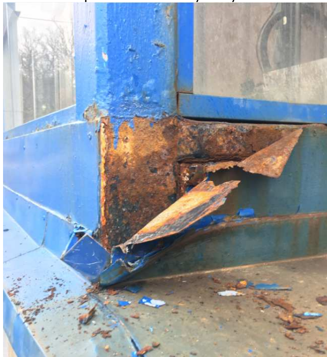
Fot. 3. Winda nr 1. Uszkodzona blacha opierzenia przewidziana do wymiany.
