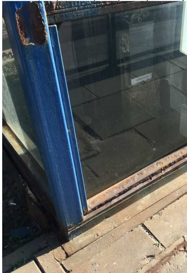
Fot. 12. Winda nr 3. Widoczne uszkodzenie słupka pionowego oraz miejscowa korozja. Powierzchnię zeszlifować, oczyścić i uzupełnić powłokę malarską.
