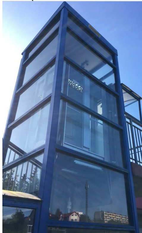
Fot. 3. Winda nr 1 - widok z boku. Ogniska korozji belek poziomych. Profile stalowe należy oczyścić a następnie uzupełnić powłokę malarską.
