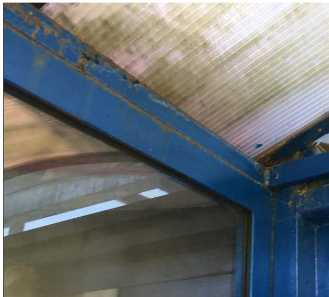
Fot. 3. Winda nr 1. Uszkodzona blacha opierzenia przewidziana do wymiany.
