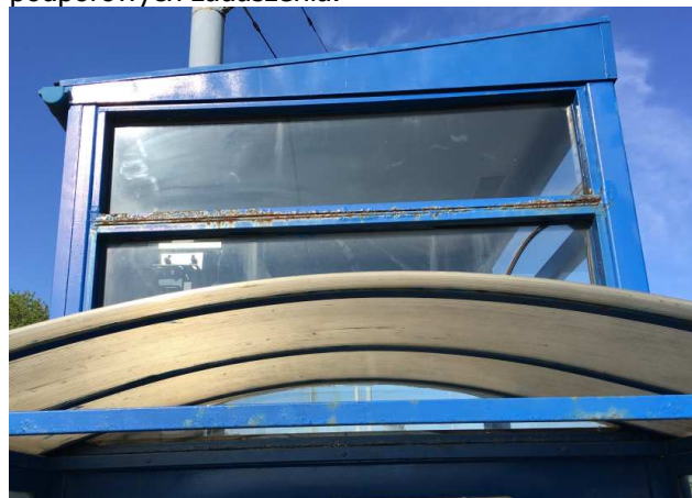
Fot. 20. Winda nr 4. Z boku. Korozja profili podporowych zadaszania.
