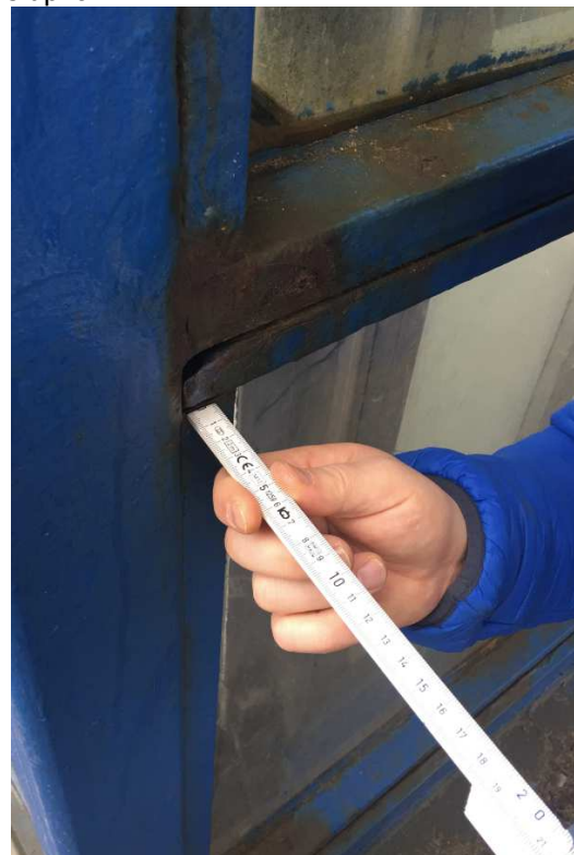
Fot. 8. Winda nr 2. Widok z przodu. Widoczna korozja powierzchniowa elementów rygli poziomych oraz pionowych słupków.
