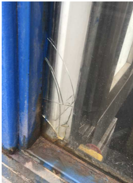
Fot. 13. Winda nr 2. Pęknięcie szyby.
