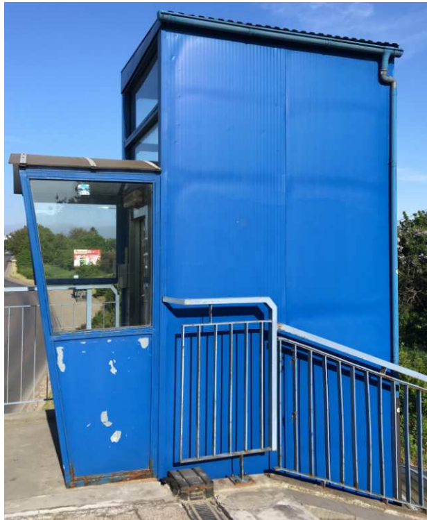
Fot. 5. Winda nr 1 - widok z tyłu. Ogniska korozji belek poziomych w miejscu połączenia z podszybiem windy. Elementy przewidziane do wzmocnienia poprzez dospawanie dodatkowego profilu powyżej zniszczonego elementu.
