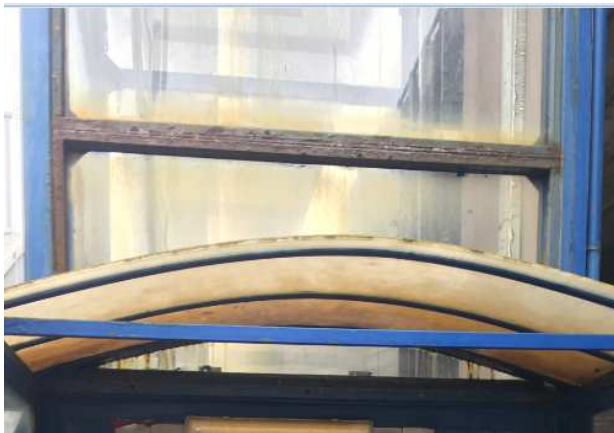
Fot. 22. Winda nr 4. Ogniska korozji rygli poziomych. Profile stalowe należy oczyścić a następnie uzupełnić powłokę malarską.
