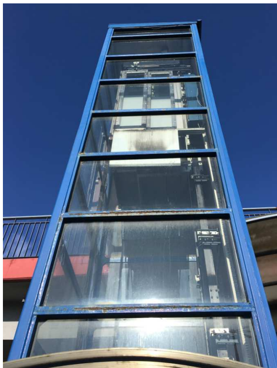
Fot. 15. Winda nr 3. Widok z tyłu. Widoczna korozja elementów poziomych rygli.
