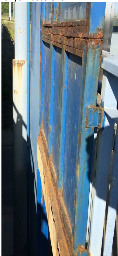
Fot. 19. Winda nr 4. Z boku. Korozja profili podporowych zadaszania.
