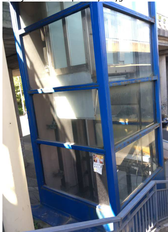
Fot. 19. Winda nr 4. Z boku. Korozja profili podporowych zadaszania.
