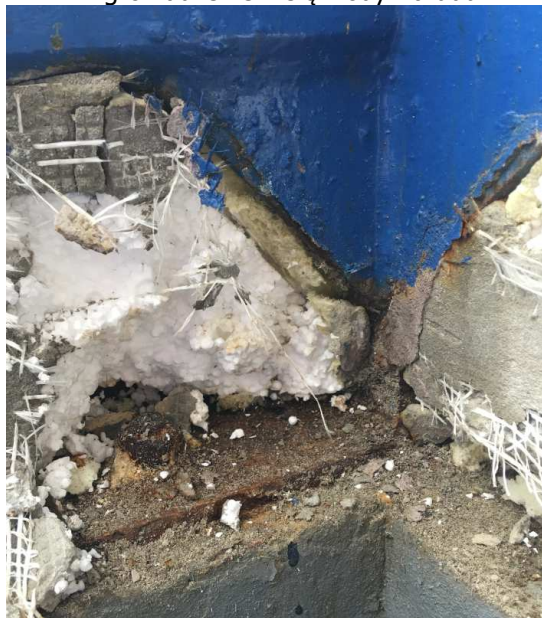
Fot. 21. Winda nr 3. Szczegół połączenia słupków z obudową żelbetową podszybia. Zabetonować przestrzeń w podstawach podpór – zabezpieczenie przed ponownym gromadzeniem się wody i brudu.
