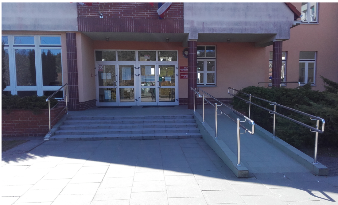
Zdjęcia nr 3,4. Wejście główne do budynku szkoły ( elewacja północna ). W zakresie opracowania remont nawierzchni chodnikowej wejścia do szkoły wraz z podbudową, remont izolacji ścian zewnętrznych w poziomie piwnic.
