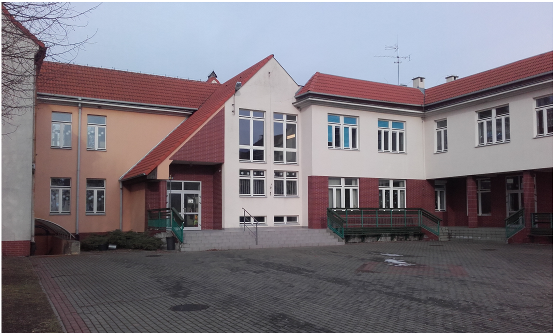
Zdjęcie nr 9, 10. Elewacja południowa, wejście od strony boisk. W zakresie opracowania remont nawierzchni chodnikowej wejścia wraz z podbudową, remont izolacji ścian zewnętrznych w poziomie piwnic.
