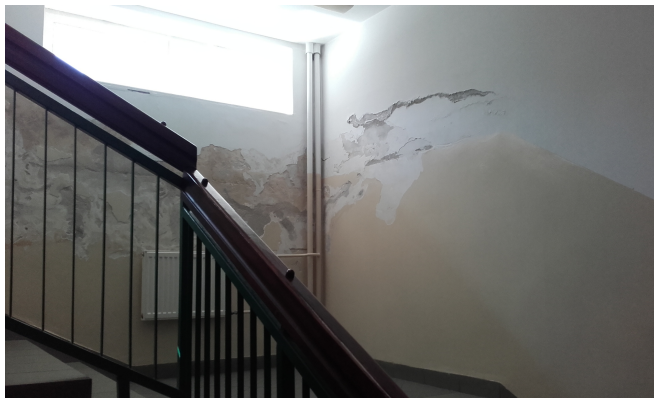
zawilgocona ściana – klatka schodowa główna.
