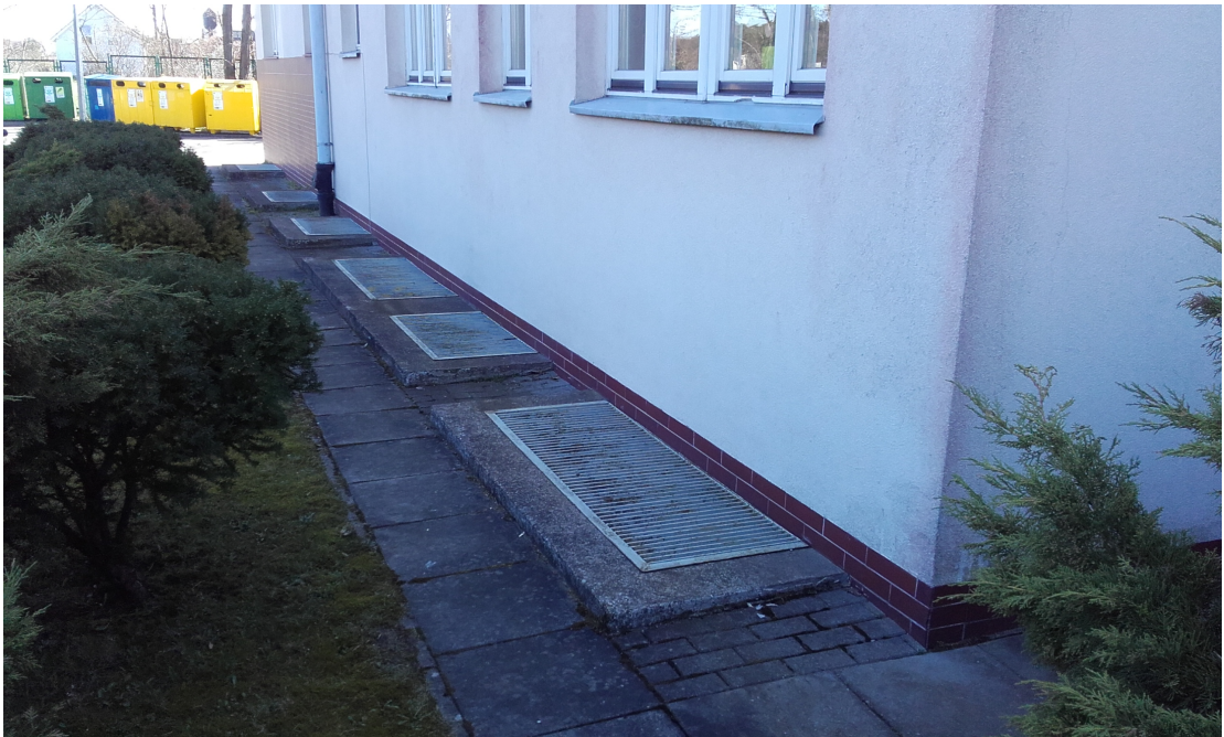
Zdjęcie nr 5, 6. Elewacja północna, studzienki okien piwnicznych. W zakresie opracowania remont izolacji ścian zewnętrznych w poziomie piwnic, remont studzienek okien piwnicznych, wykonanie nowej opaski.
