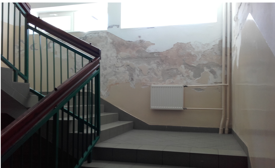
Zdjęcie nr 8. Zawilgocona ściana zewnętrzna klatki schodowej ( elewacja południowa ). W zakresie opracowania remont izolacji ścian zewnętrznych w poziomie piwnic.
