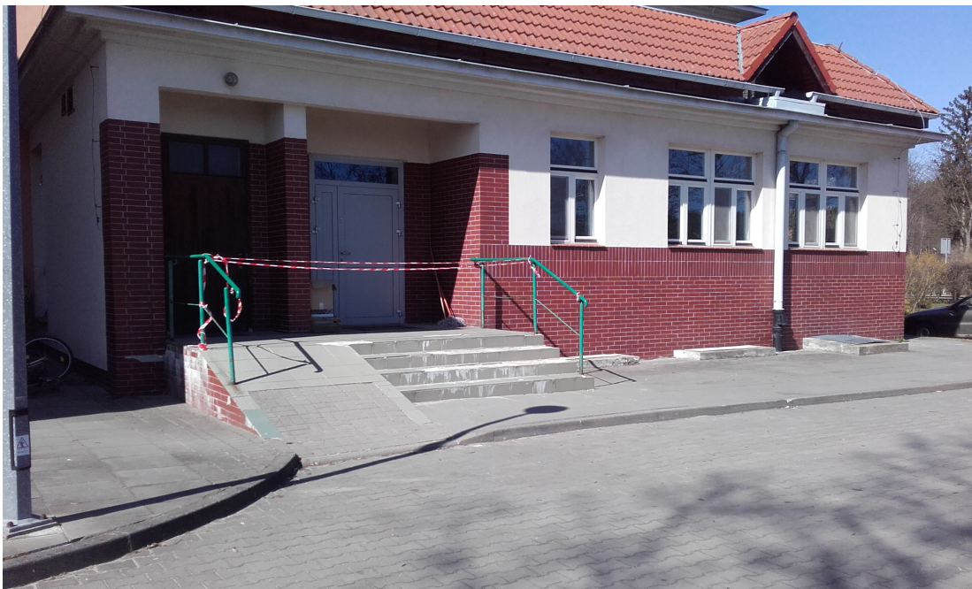
Zdjęcie nr 7. Elewacja wschodnia, wejście do zespołu żywieniowego. W zakresie opracowania remont nawierzchni chodnikowej wejścia wraz z podbudową, remont izolacji ścian zewnętrznych w poziomie piwnic.
