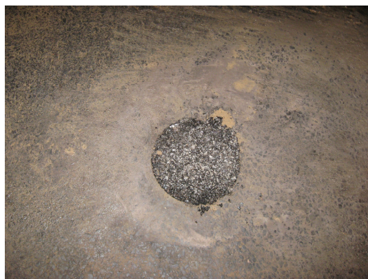
Fot. 4. Odtworzenie nawierzchni po zakończeniu badań
