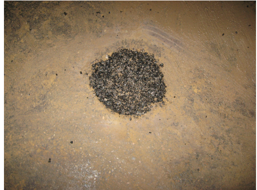
Fot. 10. Odtworzenie nawierzchni po zakończeniu badań
