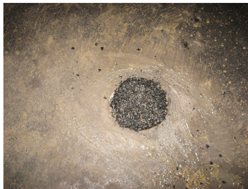
Fot. 6. Odtworzenie nawierzchni po zakończeniu badań
