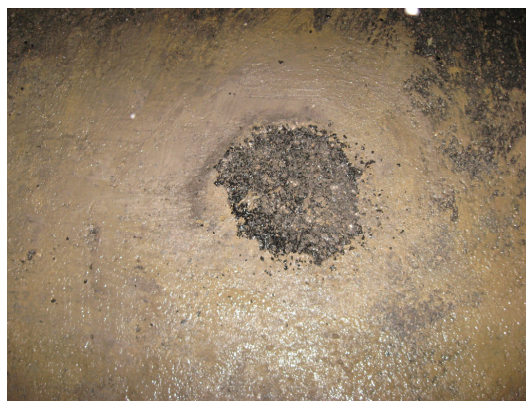
Fot. 2. Odtworzenie nawierzchni po zakończeniu badań
